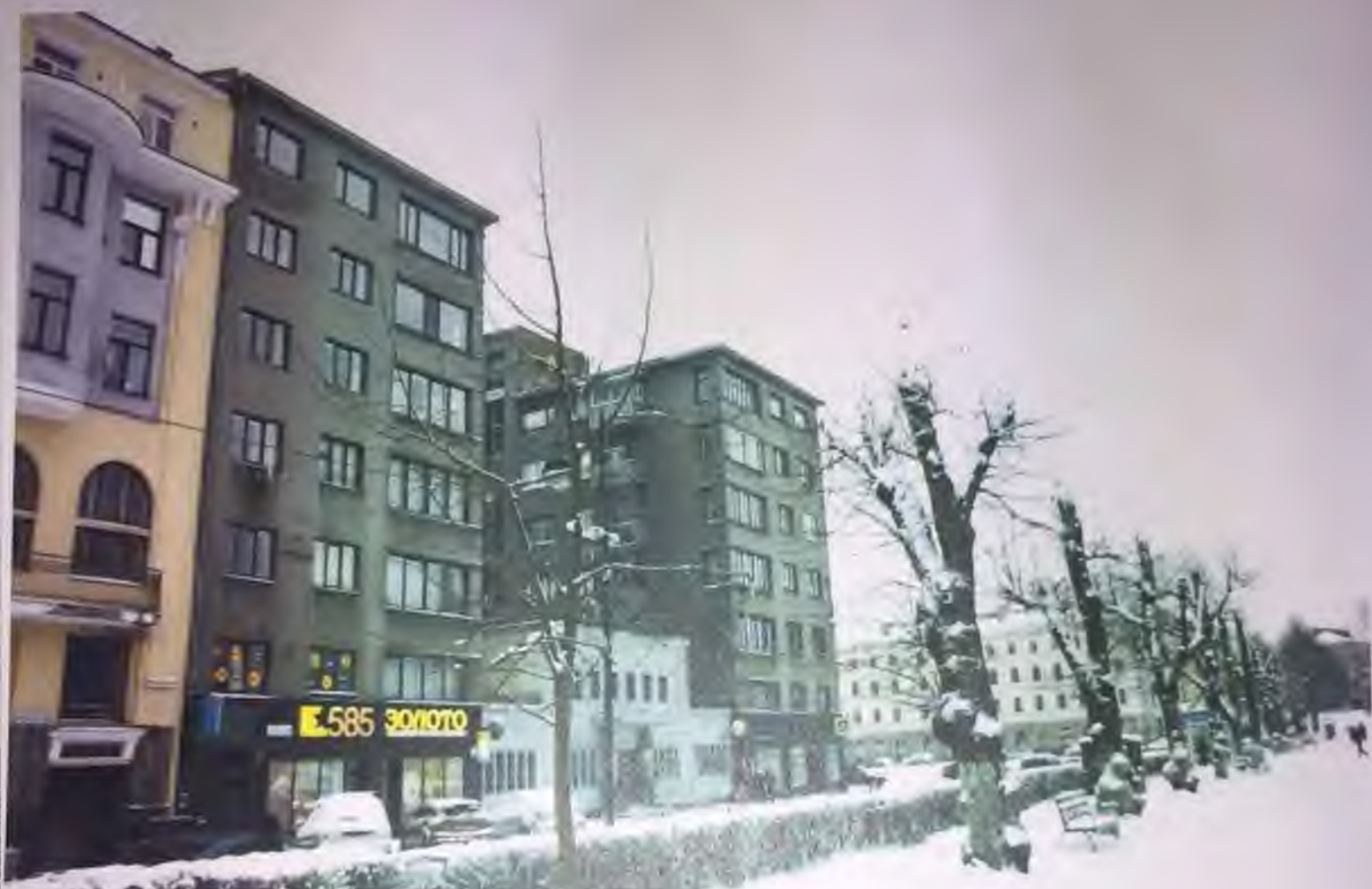
Фото 2. Общий вид здания со стороны пр. Ленина с северо-запада. Автор фото: Маланичева Г.И. 29.11.2016 г.
