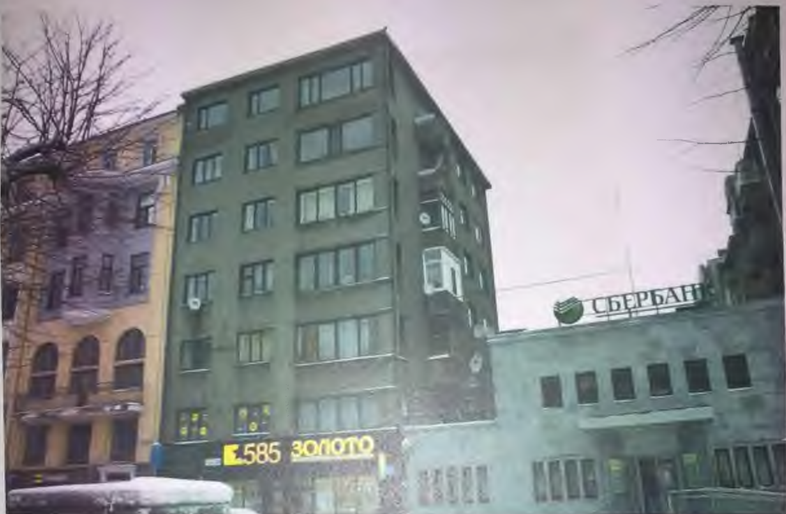
Фото 4. Южный и восточный фасады корпуса №2. Автор фото: Маланичева Г.И. 29.11.2016 г.
