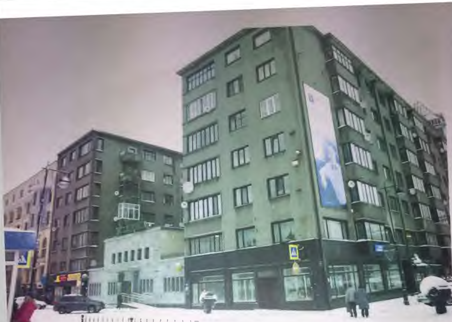
Фото 3. Общий вид здания со стороны пр. Ленина. Автор фото: Маланичева Г И 29.11.2016 г.
