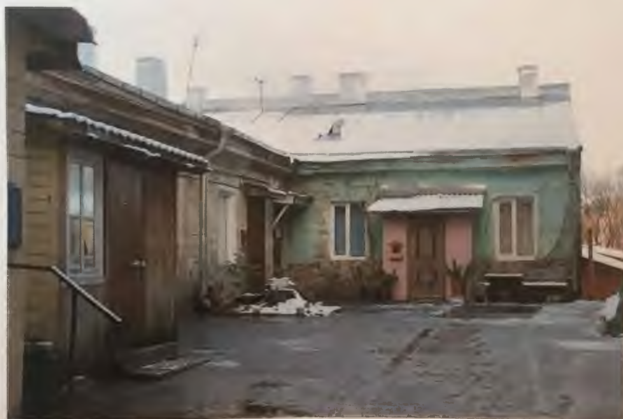
Фото 4.3. Восточный фасад здания. Фрагмент. Автор фото: Маланичева Г.И. 30.11.2016 г.
