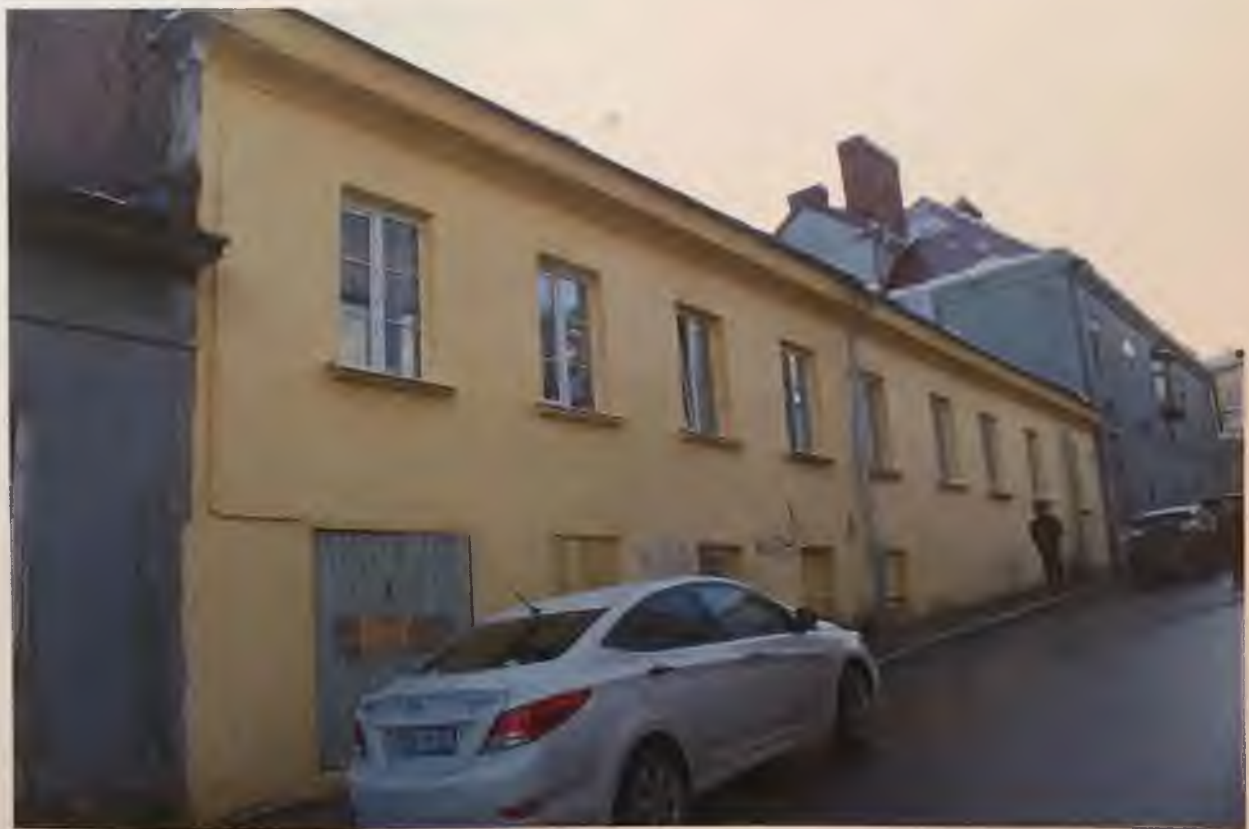
Фото 2. Западный фасад здания. Вид с севера. Автор фото: Маланичева Г.И. 30.11.2016 г.
