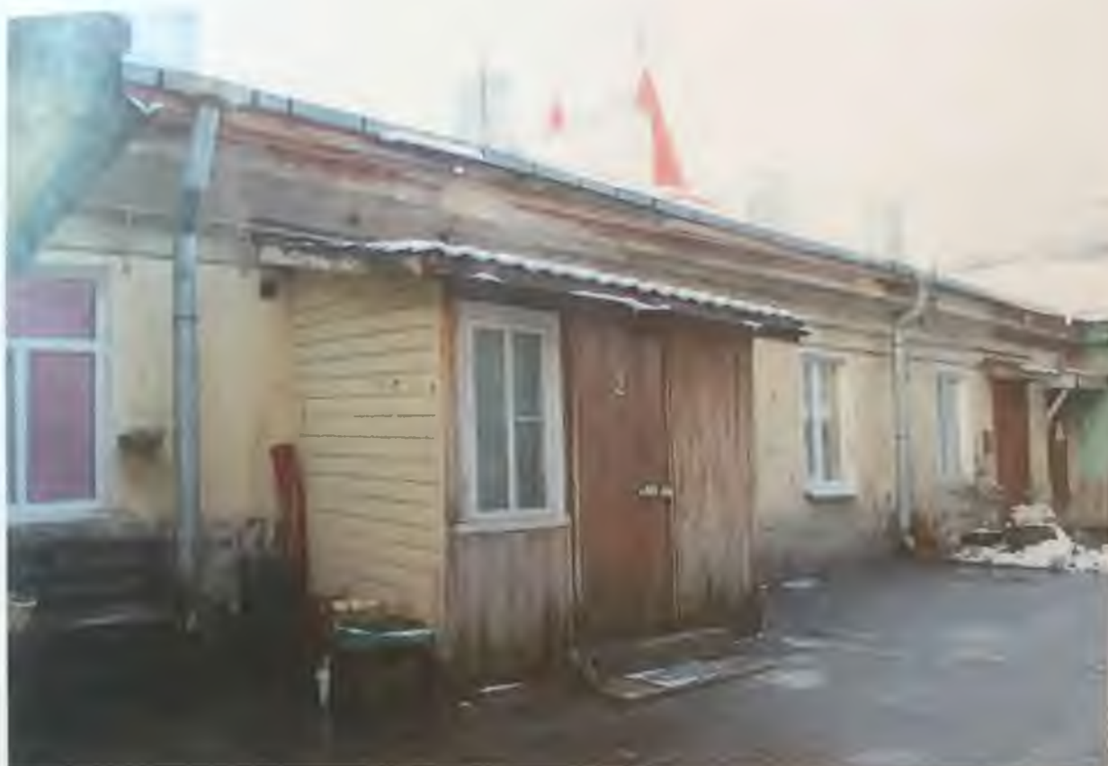
Фото 4.2. Восточный фасад здания. Фрагмент. Автор фото: Маланичева Г.И. 30.11.2016 г.
