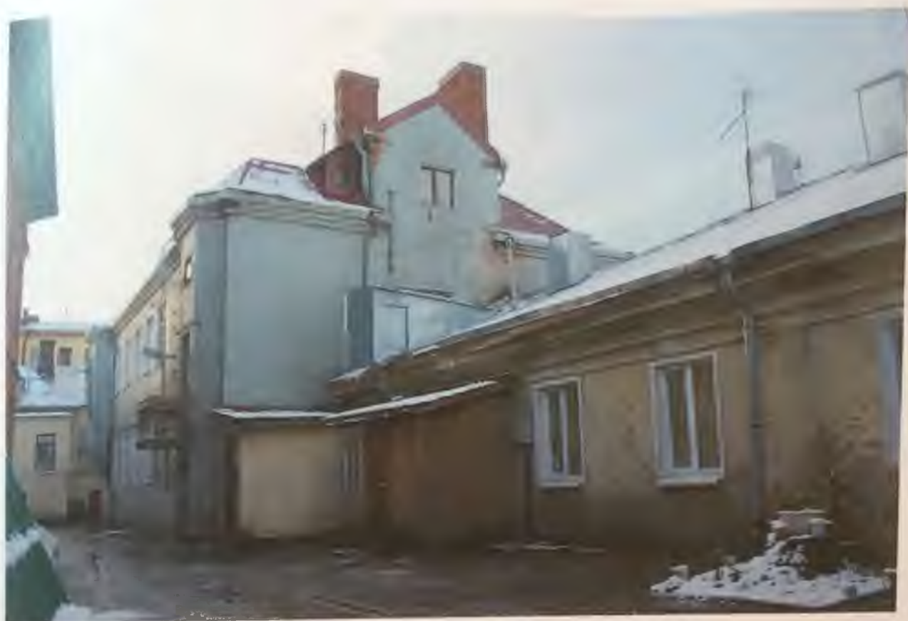
Фото 4. Восточный фасад здания. Фрагмент. Автор фото: Маланичева Г.И. 30.11.2016 г.
