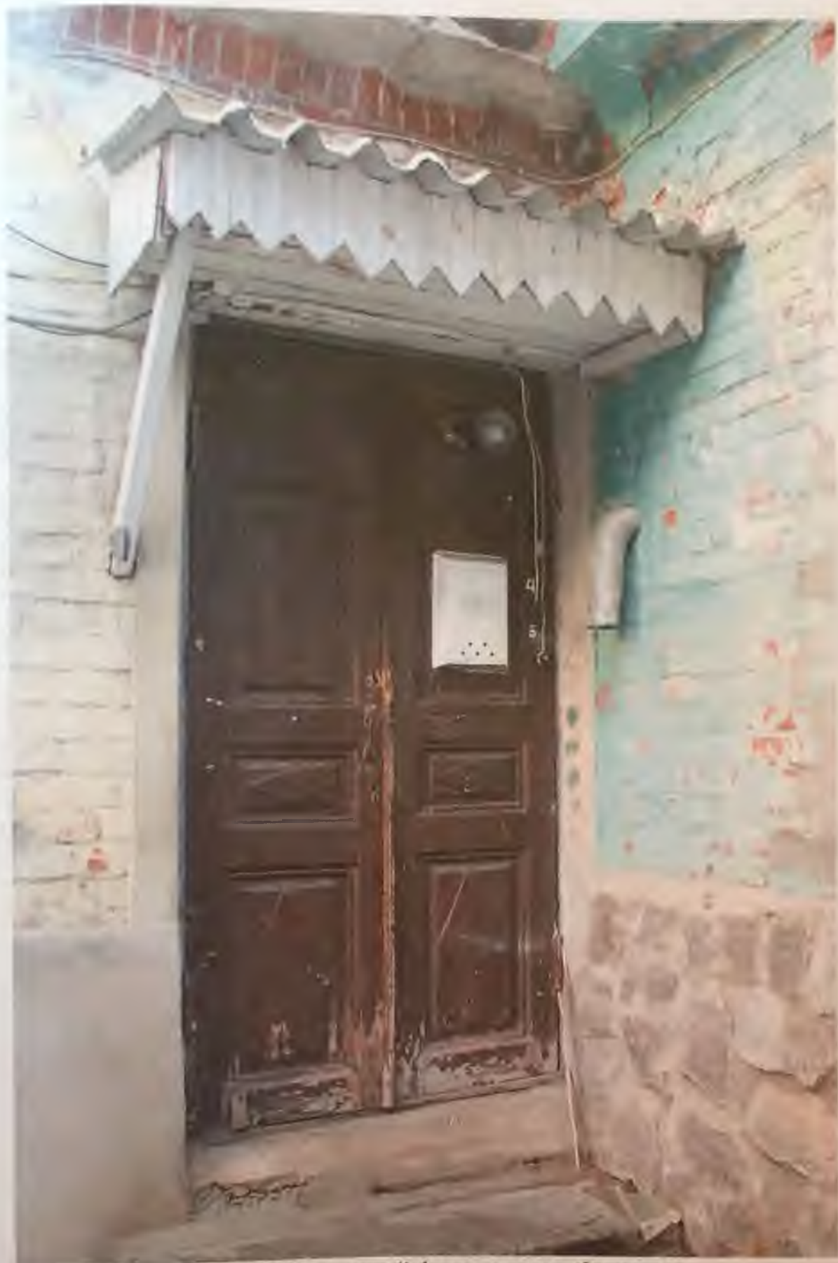
Фото 4.5. Восточный фасад здания. Фрагмент. Автор фото: Маланичева Г.И. 30.11.2016 г.
