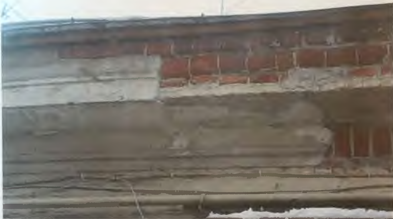
Фото 4.4. Восточный фасад здания. Фрагмент. Автор фото: Маланичева Г.И. 30.11.2016 г.
