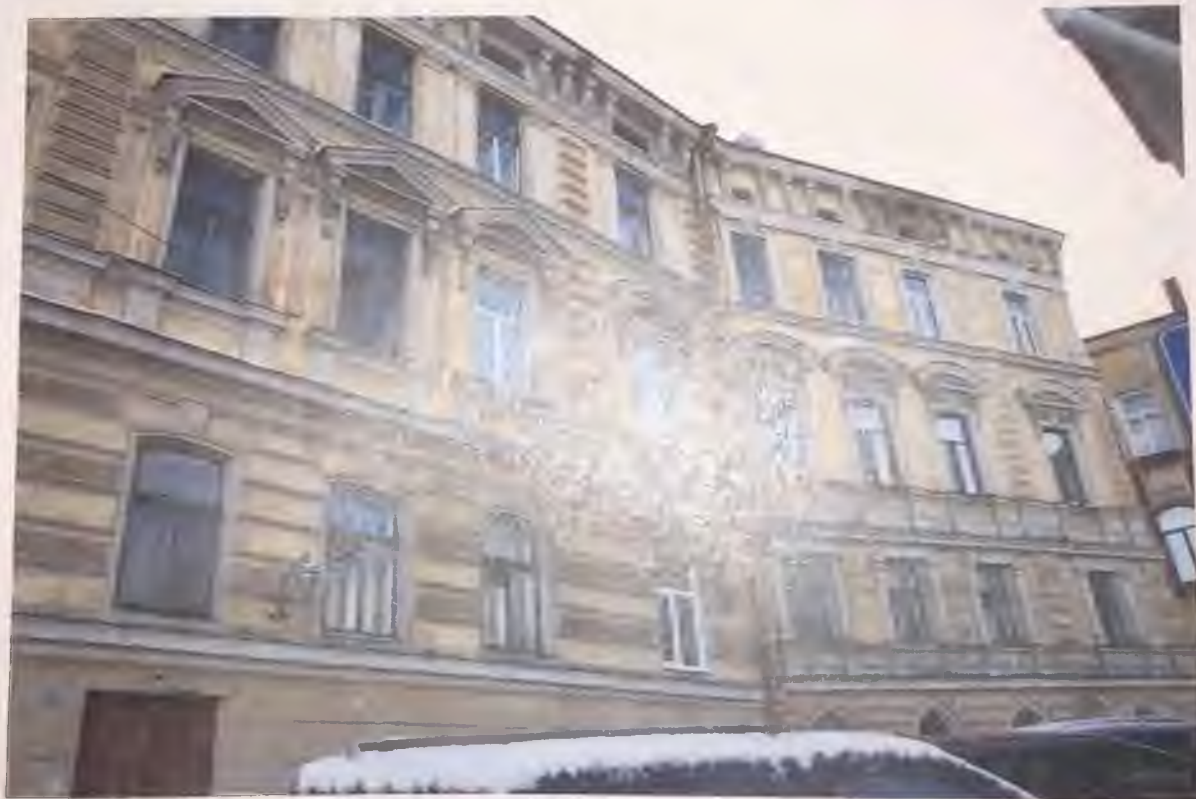
Фото 6. Западный фасад здания. Фрагмент. Автор фото: Маланичева Г.И. 30.11.2016 г.
