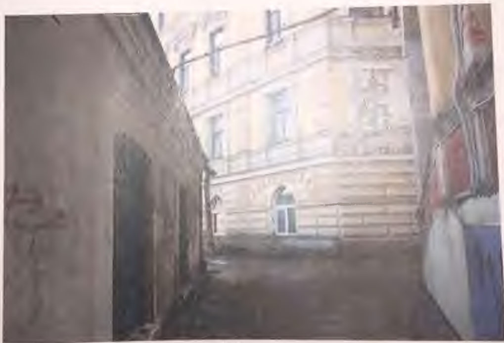
Фото 10. Западный фасад здания. Фрагмент. Автор фото: Маланичева Г.И. 30.11.2016 г.
