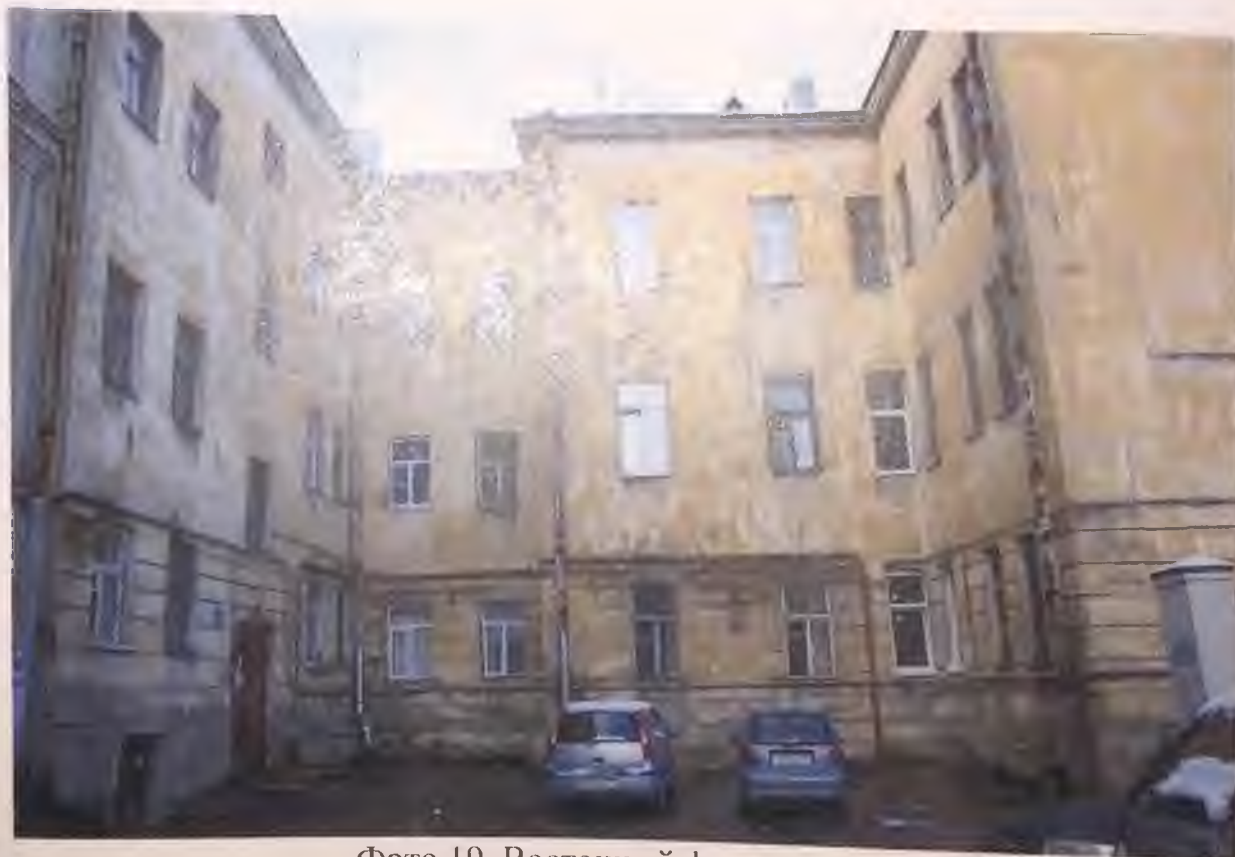
Фото 19. Восточный фасад здания. Автор фото: Маланичева Г.И. 30.11.2016 г.
