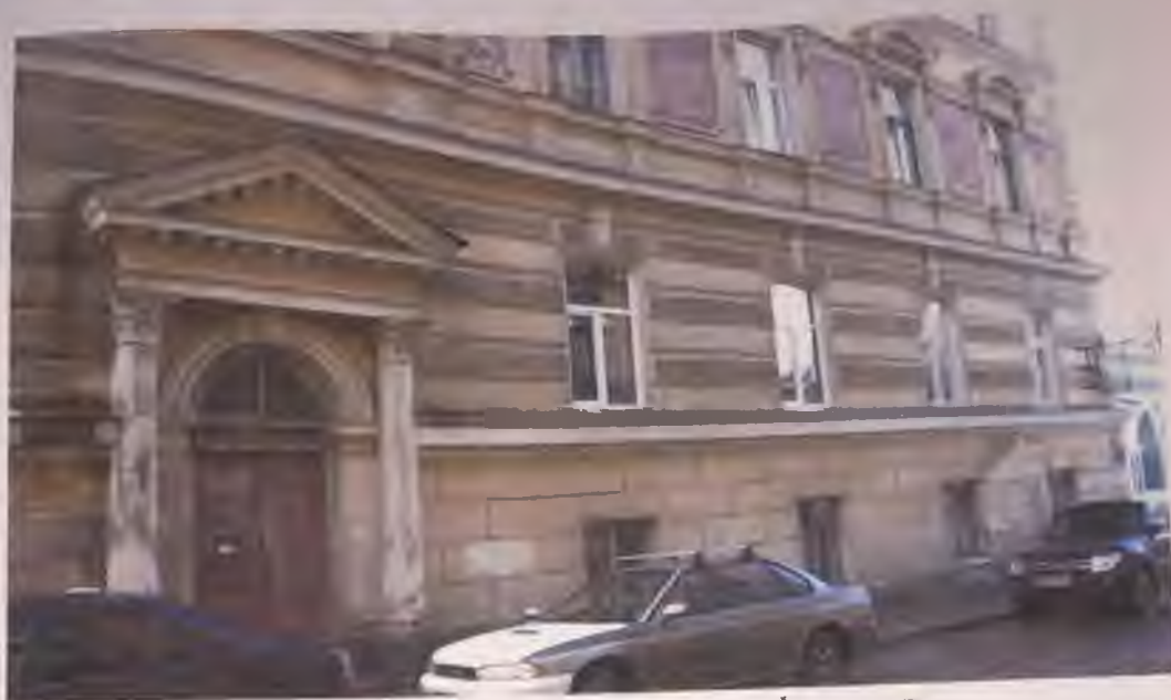
Фото 14. Северный фасад здания. Фрагмент. Автор фото: Маланичева Г.И. 30.11.2016 г.
