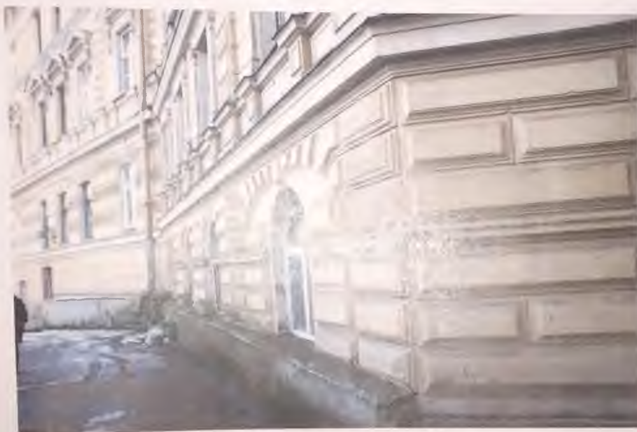
Фото 13.1. Западный фасад здания. Фрагмент. Автор фото: Маланичева Г.И. 30.11.2016 г.
