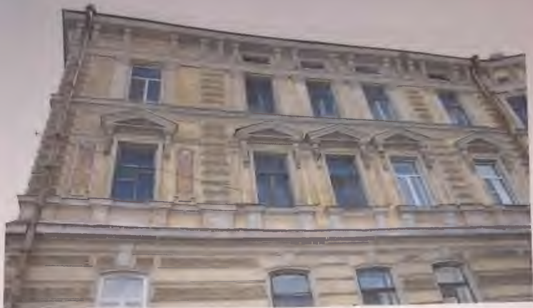
Фото 5. Западный фасад здания. Фрагмент. Автор фото: Маланичева Г.И. 30.11.2016 г.
