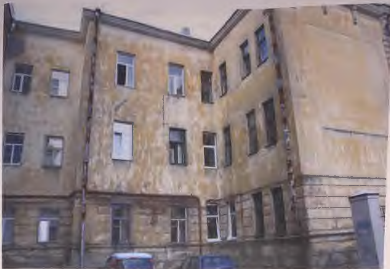
Фото 20. Восточный фасад здания. Автор фото: Маланичева Г.И. 30.11.2016 г.
