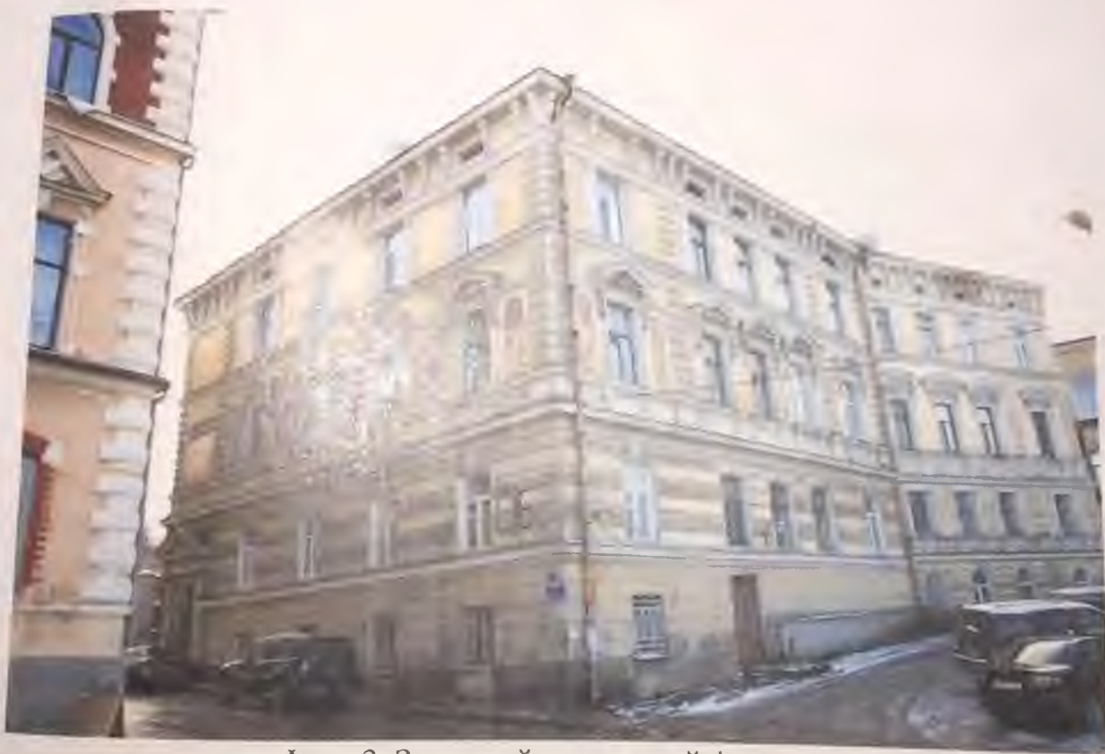
Фото 2. Западный и северный фасады. Автор фото: Маланичева Г.И. 30.11.2016 г.
