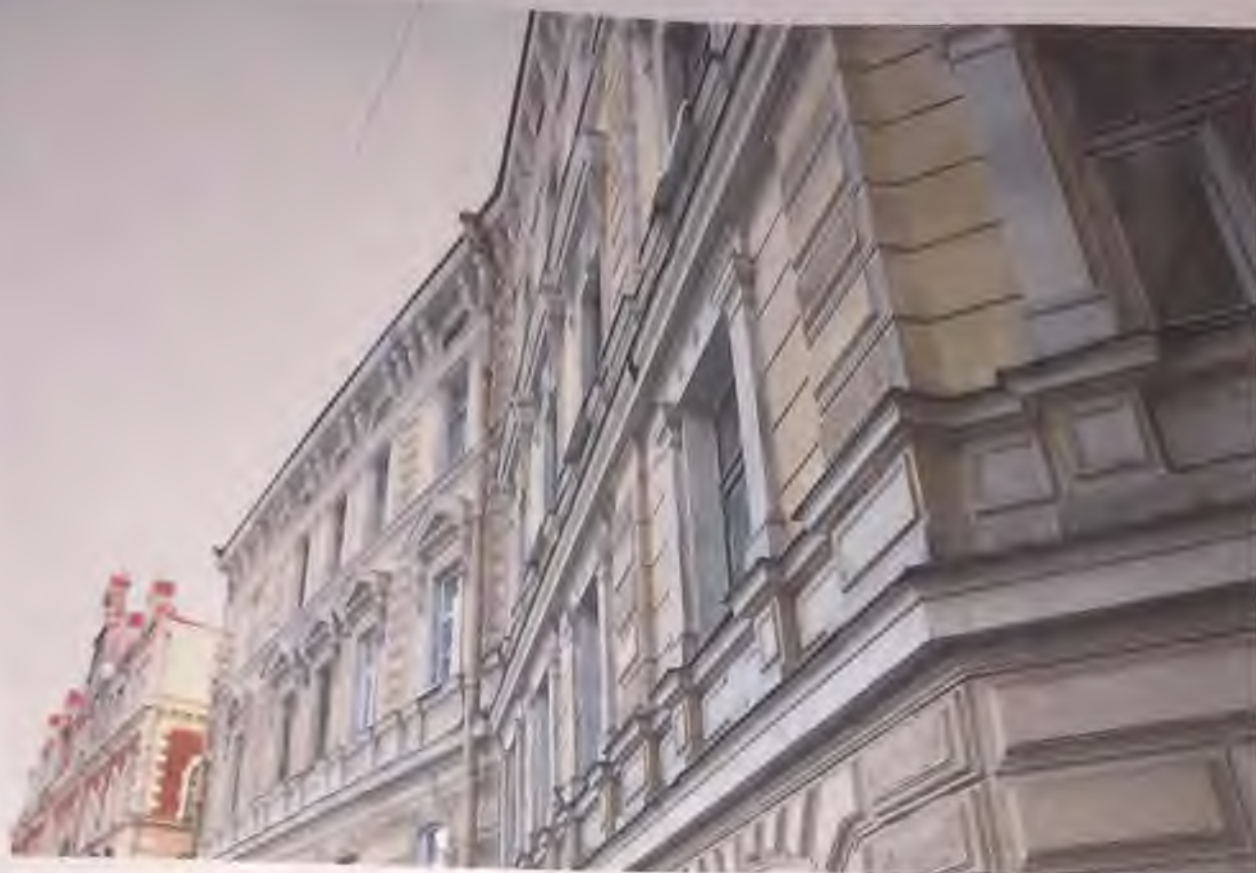
Фото 13. Западный фасад здания. Фрагмент. Автор фото: Маланичева Г.И. 30.11.2016 г.
