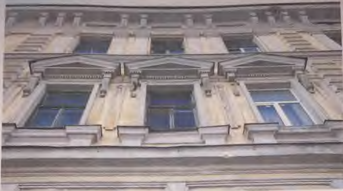
Фото 5.6. Западный фасад здания. Фрагмент. Автор фото: Маланичева Г.И. 30.11.2016 г.
