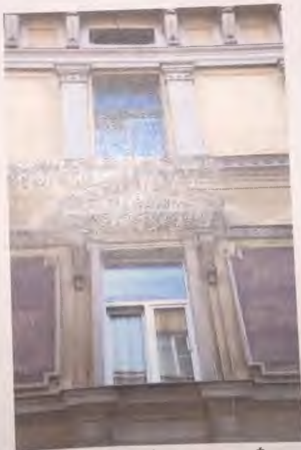
Фото 15.4. Северный фасад здания. Фрагмент. Автор фото: Маланичева Г.И. 30.11.2016 г.
