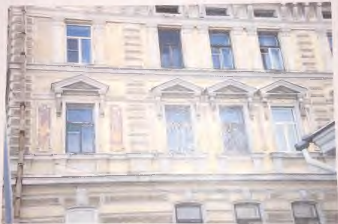
Фото 5.1. Западный фасад здания. Фрагмент. Автор фото: Маланичева Г.И. 30.11.2016 г.
