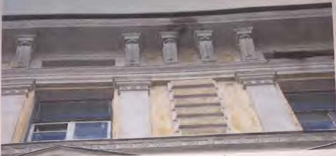
Фото 5.4. Западный фасад здания. Фрагмент. Автор фото: Маланичева Г.И. 30.11.2016 г.
