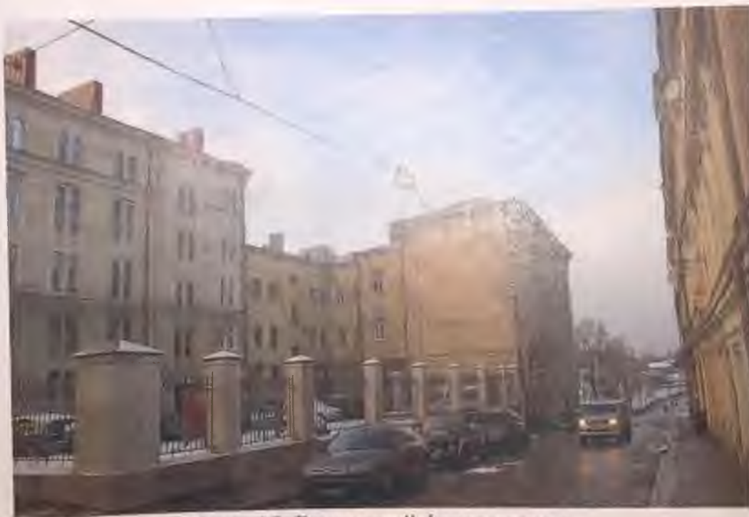
Фото 17. Восточный фасад здания. Автор фото: Маланичева Г.И. 30.11.2016 г.
