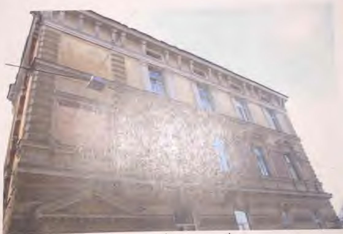
Фото 15. Северный фасад здания. Фрагмент Автор фото: Маланичева Г.И. 30.11.2016 г.
