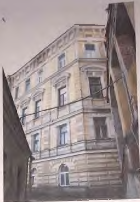
Фото 9. Западный фасад здания. Фрагмент. Автор фото: Маланичева Г.И. 30.11.2016 г.
