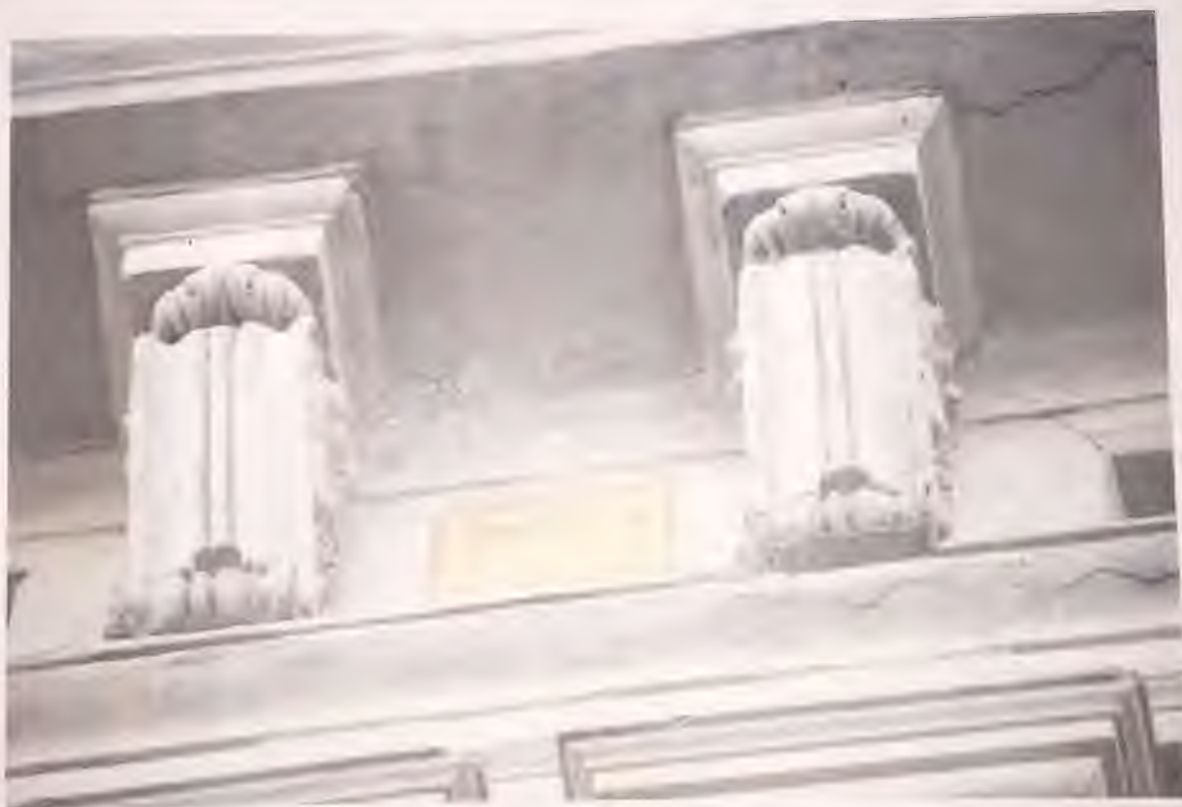
Фото 5.5. Западный фасад здания. Фрагмент. Автор фото: Маланичева Г.И. 30.11.2016 г.
