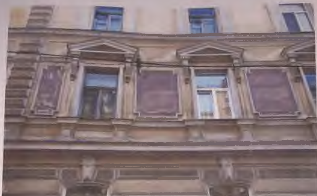
Фото 15.1. Северный фасад здания. Фрагмент. Автор фото: Маланичева Г.И. 30.11.2016 г.
