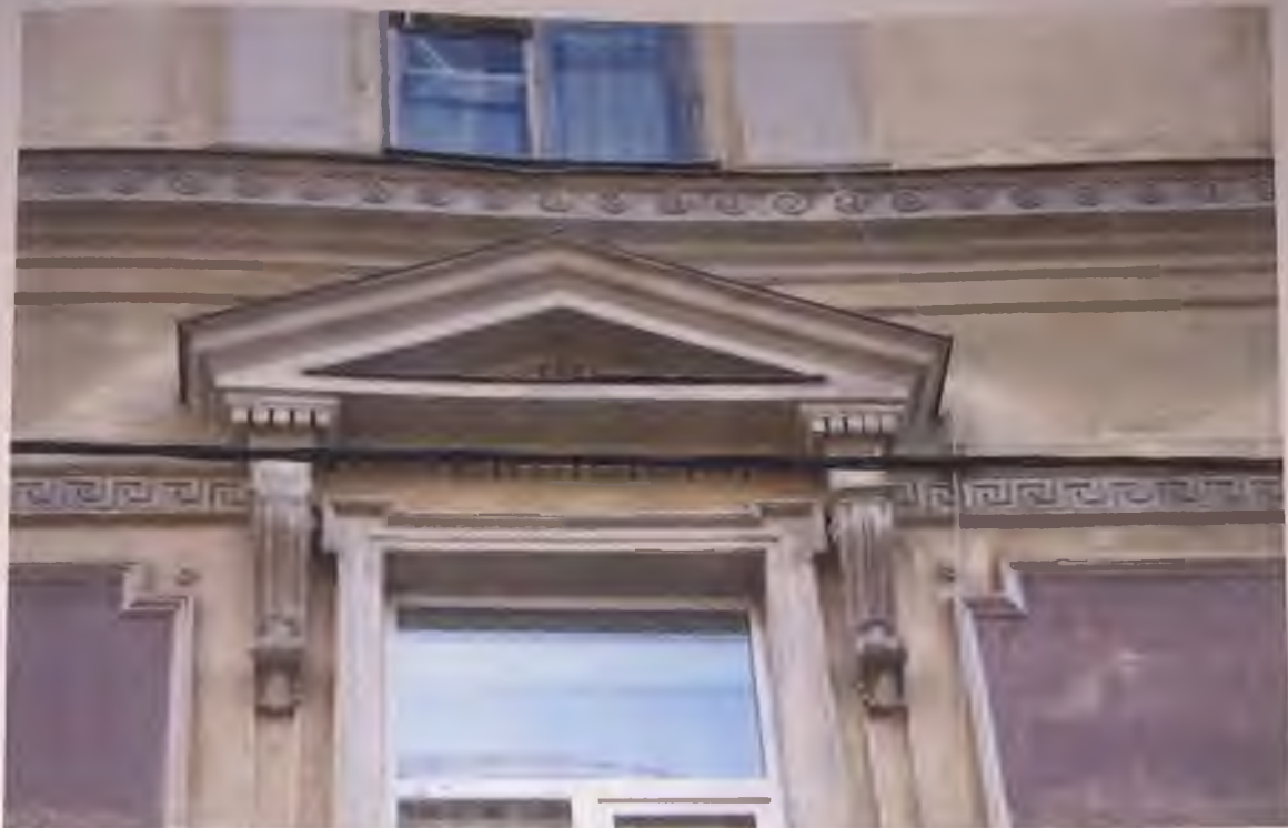
Фото 15.5. Северный фасад здания. Фрагмент. Автор фото: Маланичева Г.И. 30.11.2016 г.
