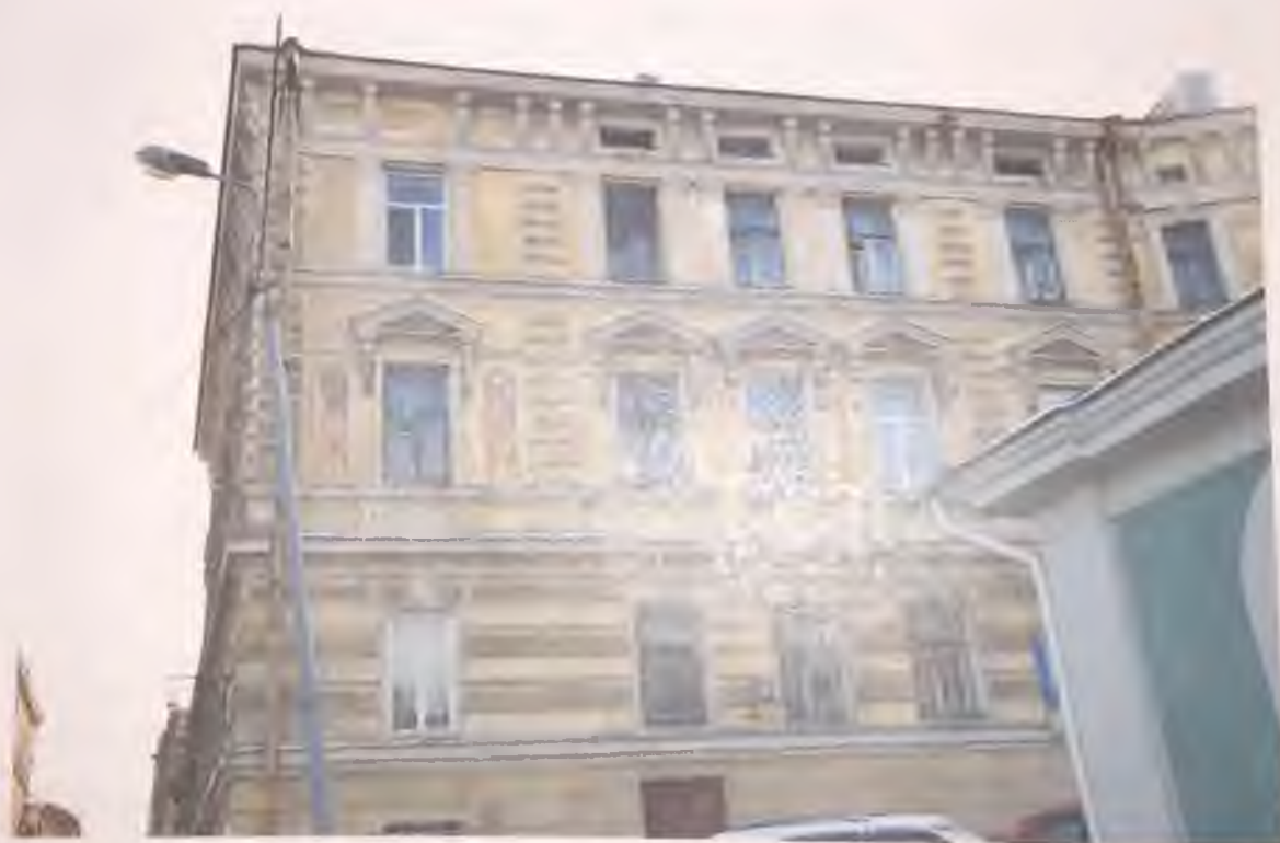
Фото 4. Западный фасад здания. Автор фото: Маланичева Г.И. 30.11.2016 г.
