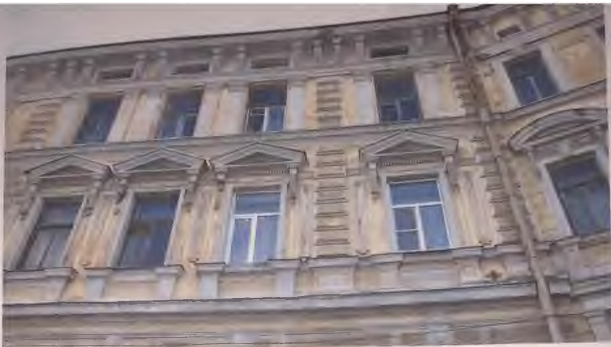
Фото 7. Западный фасад здания. Фрагмент. Автор фото: Маланичева Г.И. 30.11.2016 г.
