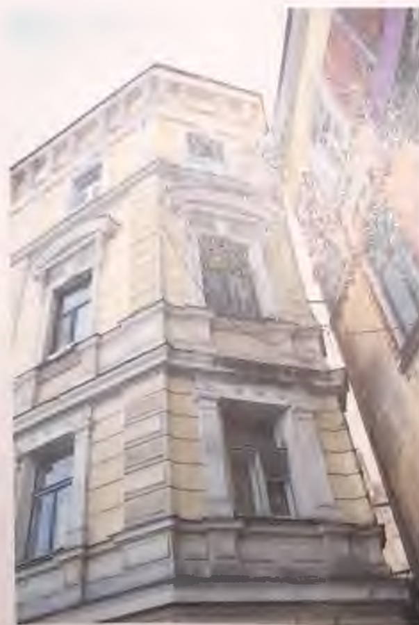
Фото 12. Юго-западный угол здания. Фрагмент. Автор фото: Маланичева Г.И. 30.11.2016 г.
