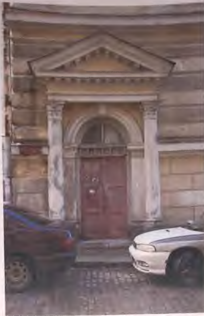
Фото 16. Северный фасад здания. Фрагмент. Автор фото: Маланичева Г.И. 30.11.2016 г.
