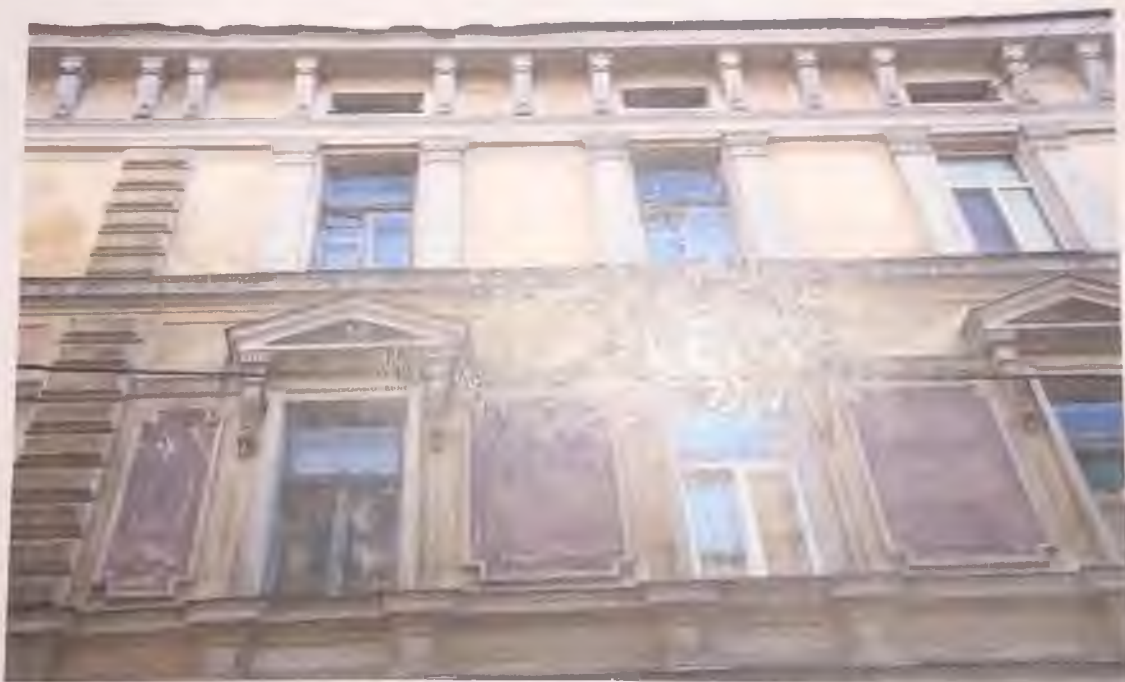
Фото 15.2. Северный фасад здания. Фрагмент. Автор фото: Маланичева Г.И. 30.11.2016 г.
