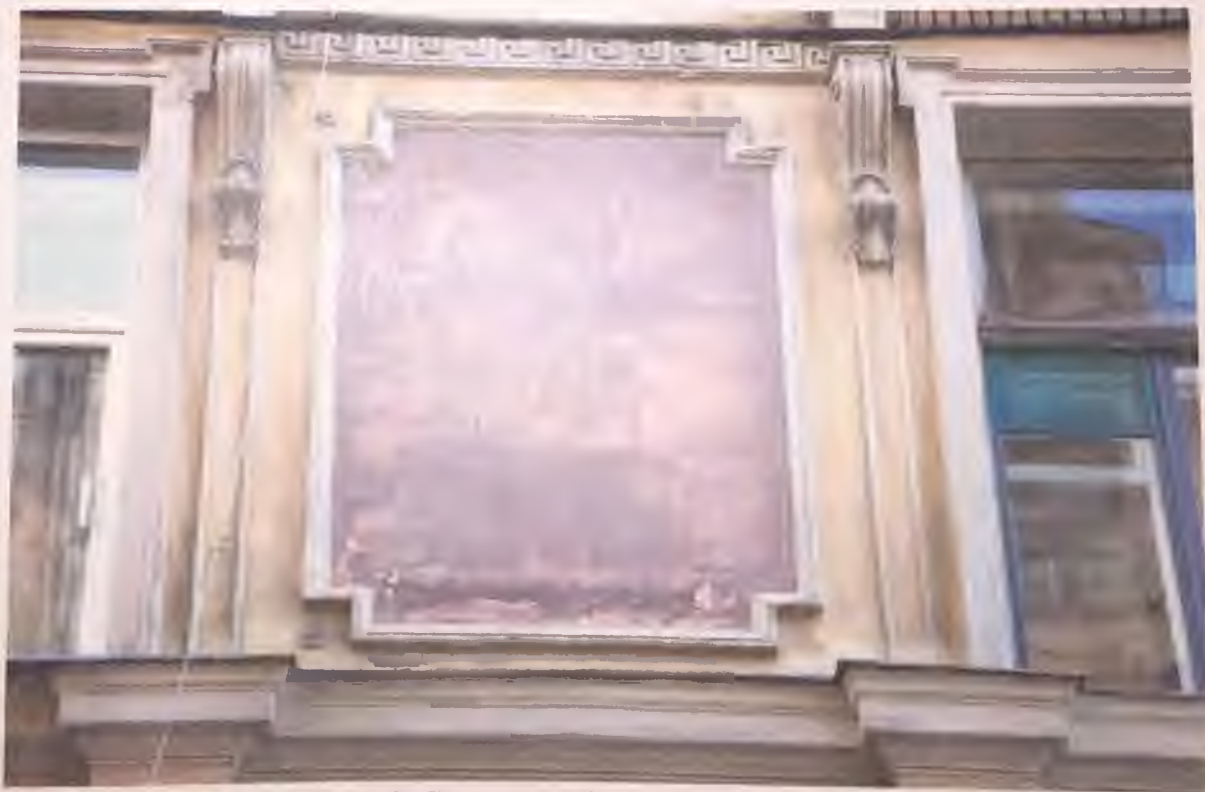
Фото 15.6. Северный фасад здания. Фрагмент. Автор фото: Маланичева Г.И. 30.11.2016 г.
