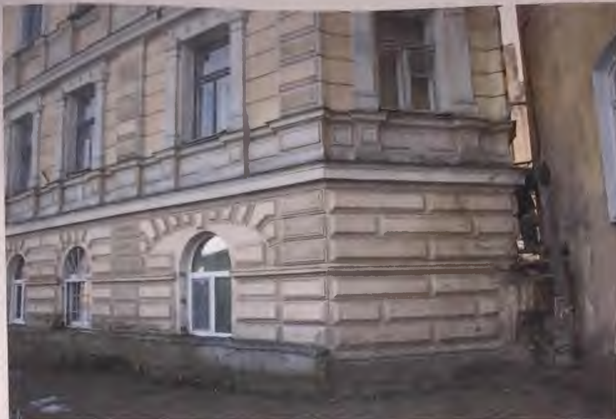
Фото 11. Западный фасад здания. Фрагмент. Автор фото: Маланичева Г.И. 30.11.2016 г.
