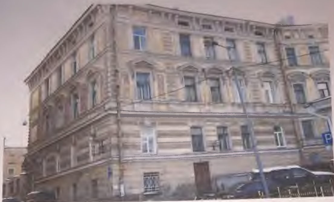
Фото 3. Западный и северный фасады. Автор фото: Маланичева Г.И. 30.11.2016 г.
