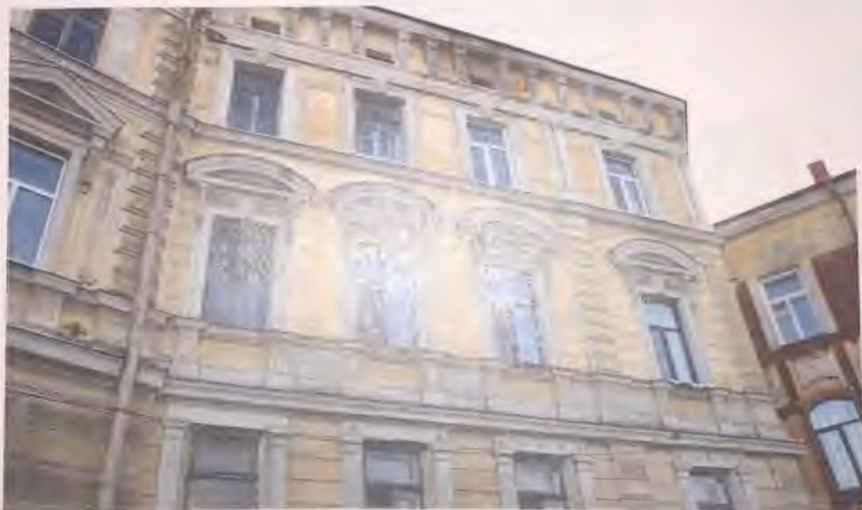
Фото 8. Западный фасад здания. Фрагмент. Автор фото: Маланичева Г.И. 30.11.2016 г.
