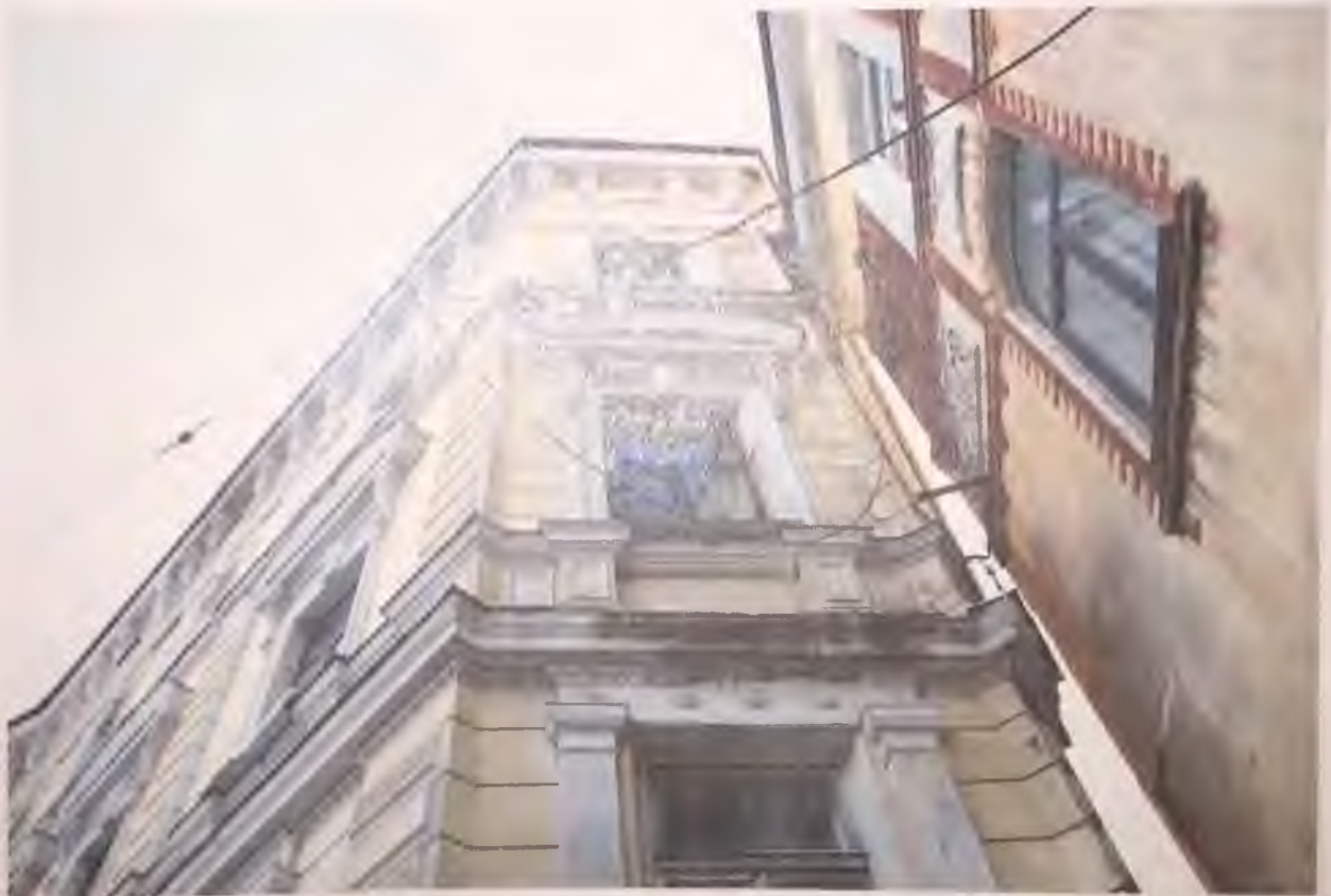
Фото 12.2. Юго-западный угол здания. Фрагмент. Автор фото: Маланичева Г.И. 30.11.2016 г.
