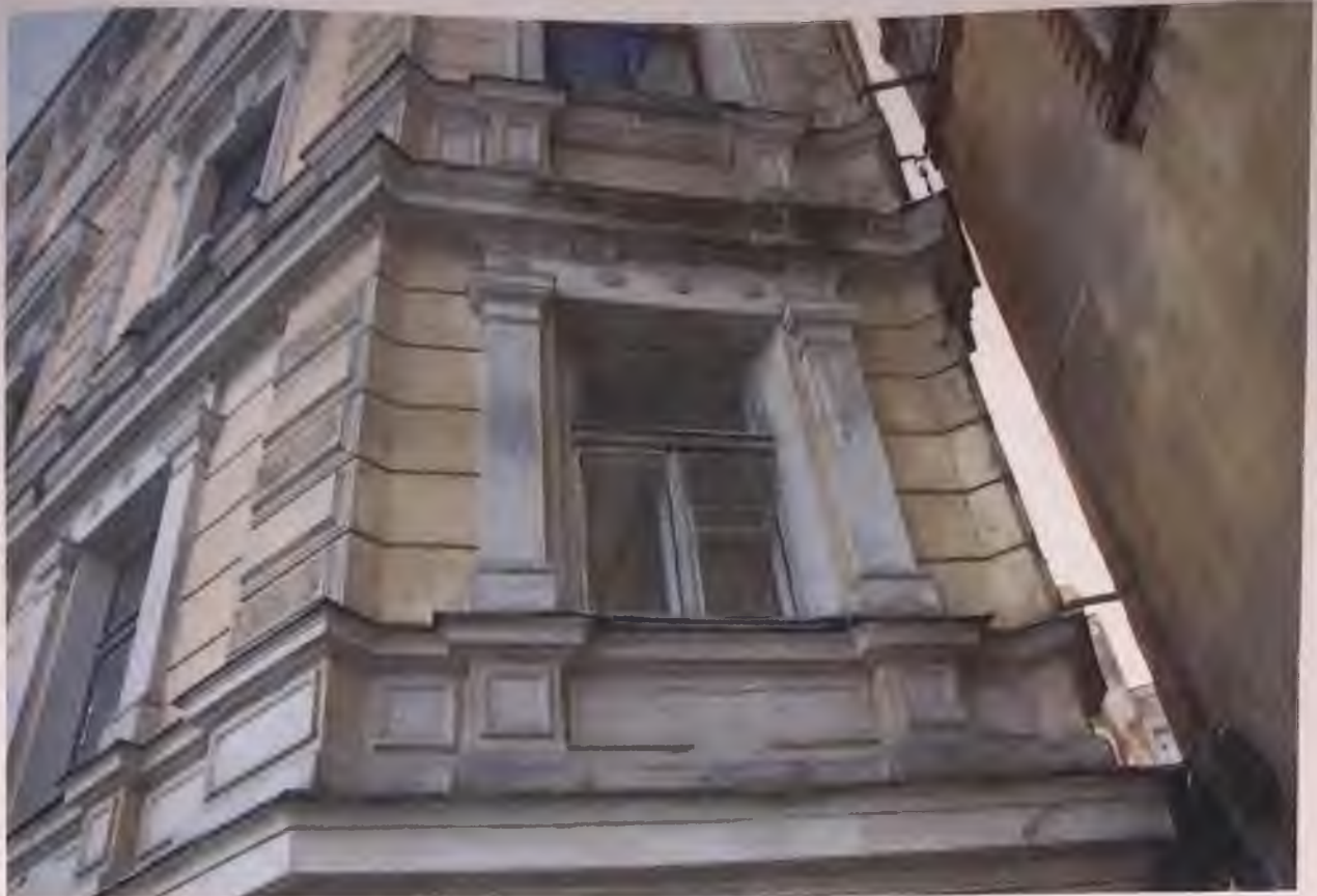
Фото 12.1. Юго-западный угол здания. Фрагмент. Автор фото: Маланичева Г.И. 30.11.2016 г.
