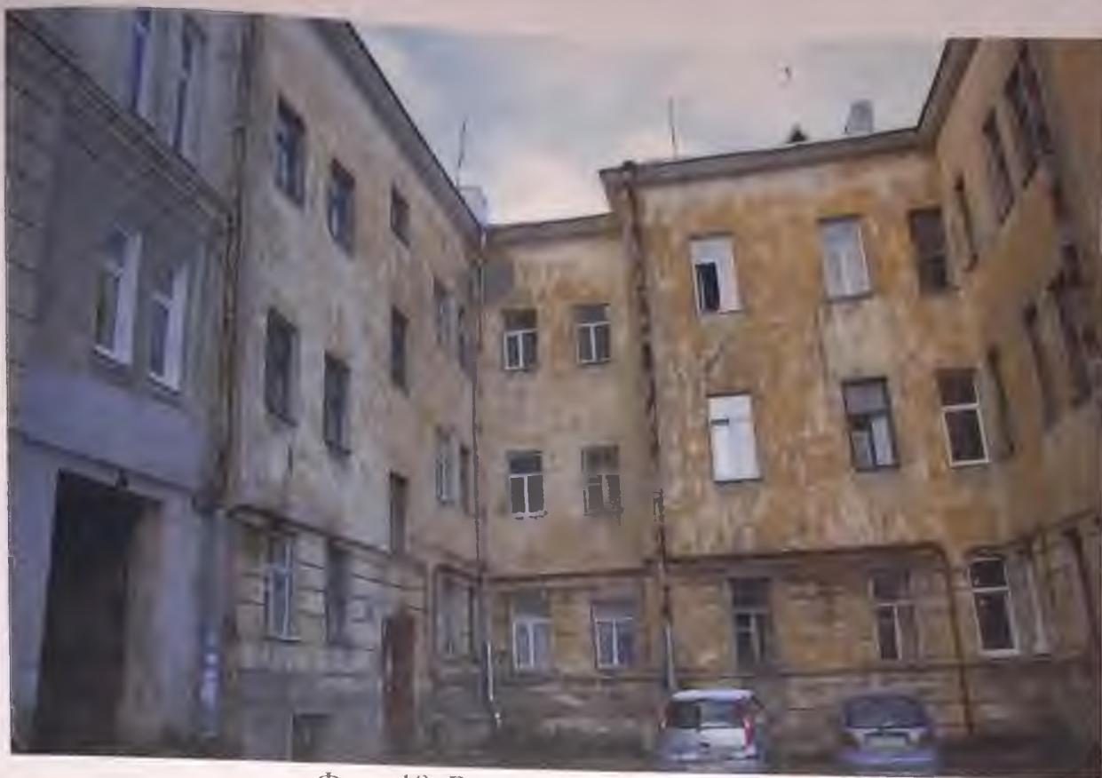
Фото 18. Восточный фасад здания. Автор фото: Маланичева Г.И. 30.11.2016 г.
