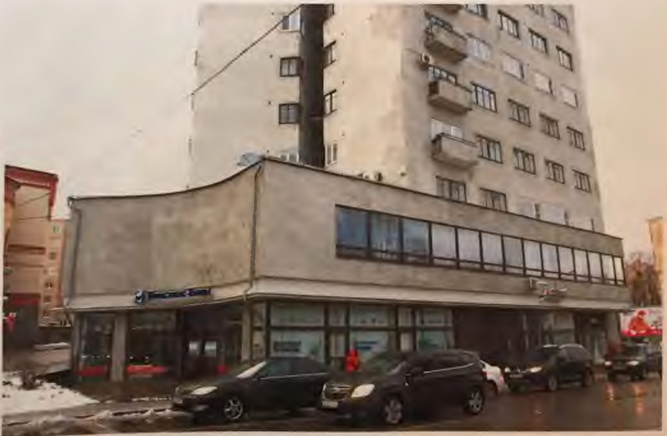
Фото 2. Северный фасад. Автор фото: Маланичева Г.И. 30.11.2016 г.
