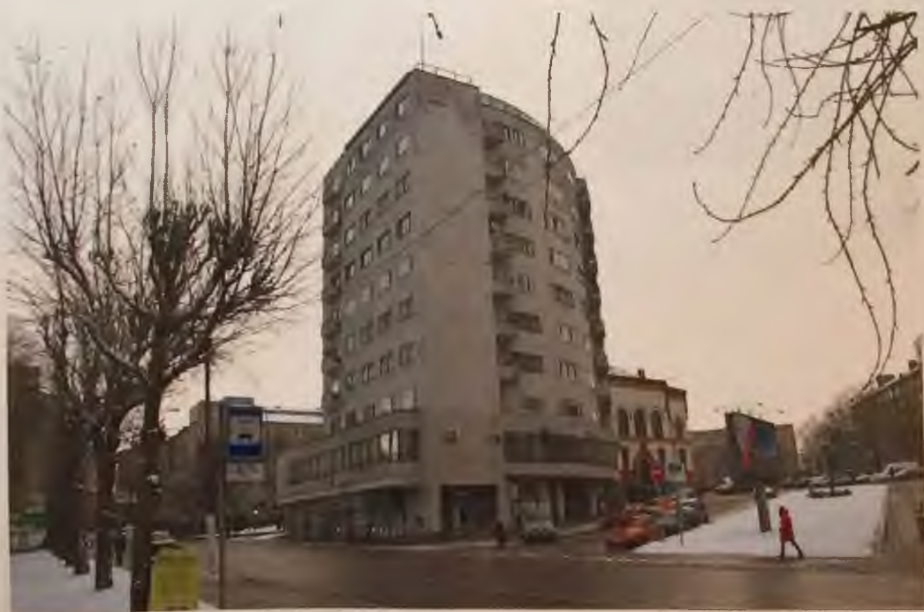
Фото 9. Общий вид на здание с северо-запада. Автор фото: Маланичева Г.И. 30.11.2016 г.
