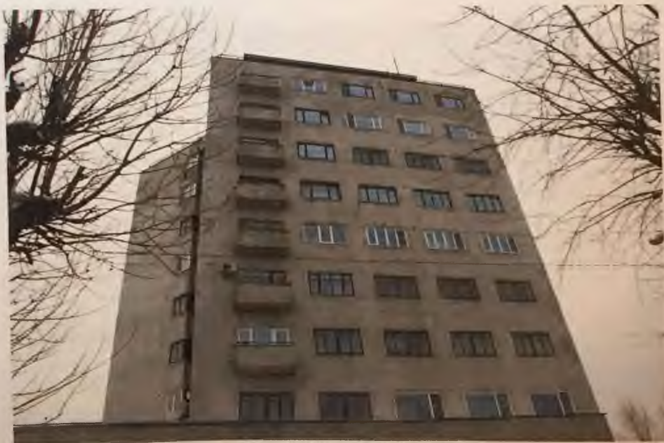
Фото 4. Северный фасад. Автор фото: Маланичева Г.И. 30.11.2016 г.
