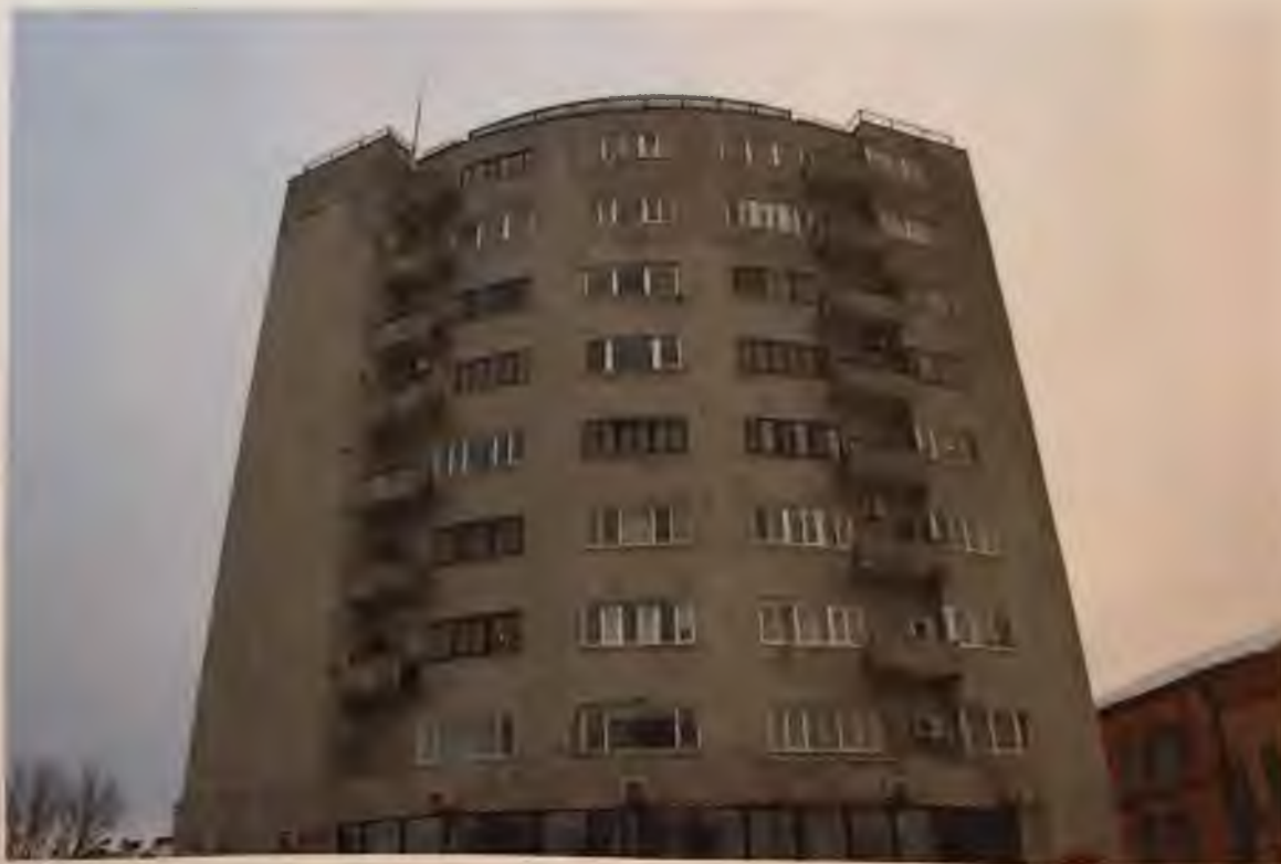
Фото 7.1. Юго-западный фасад здания. Автор фото: Маланичева Г.И. 30.11.2016 г.
