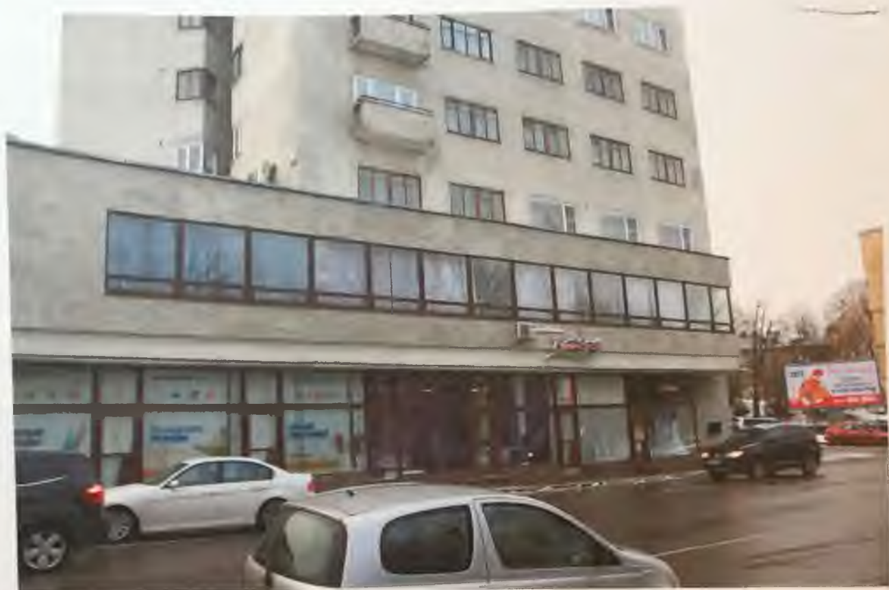
Фото 3. Северный фасад. Автор фото: Маланичева Г.И. 30.11.2016 г.
