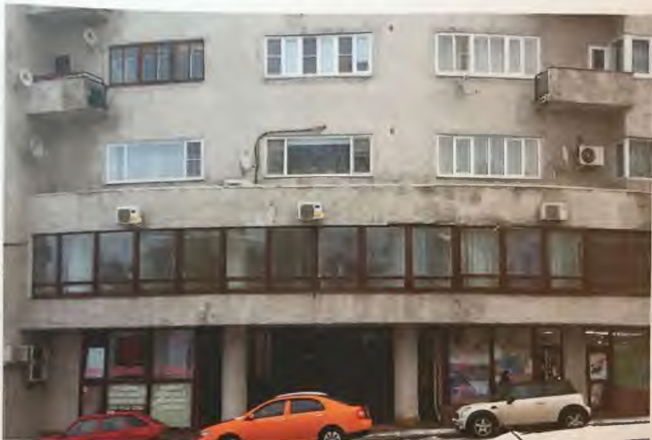
Фото 7.2. Юго-западный фасад здания. Автор фото: Маланичева Г.И. 30.11.2016 г.
