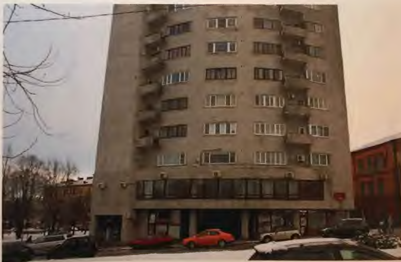
Фото 7.3. Юго-западный фасад здания. Автор фото: Маланичева Г.И. 30.11.2016 г.
