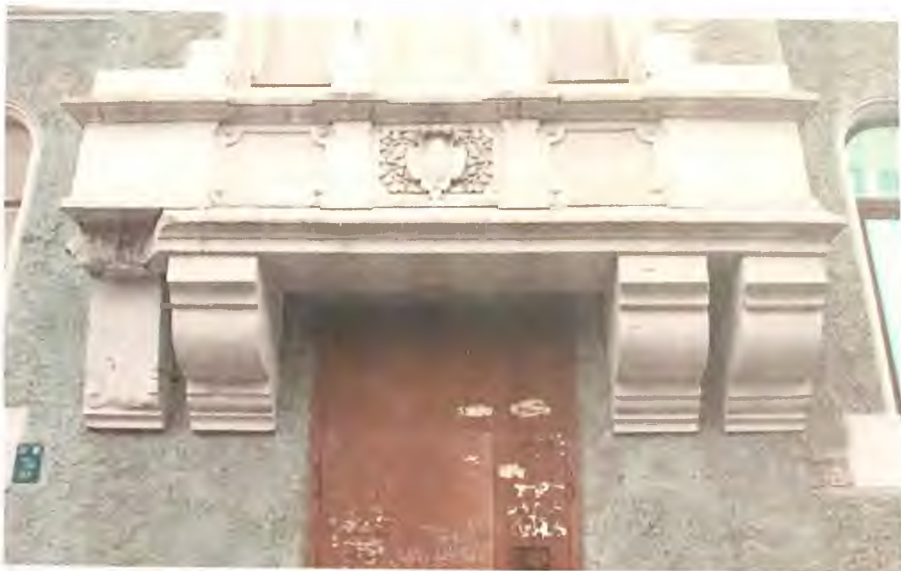
Фото 2.4. Восточный фасад здания. Фрагмент. Автор фото: Маланичева Г.И. 30.11.2016 г.
