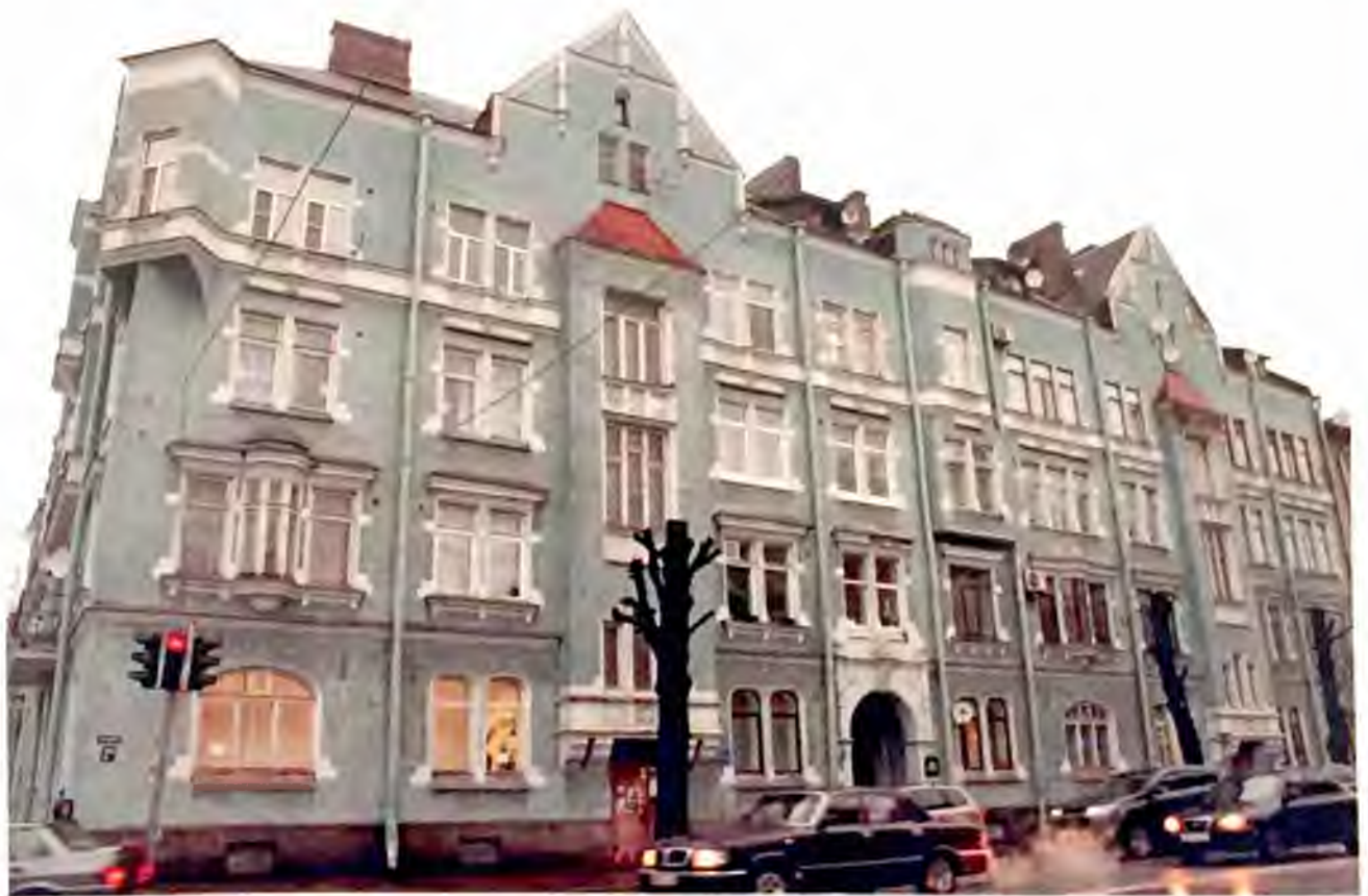
Фото 2. Восточный фасад здания. Автор фото: Маланничева Г.И. 30.11.2016 г.
