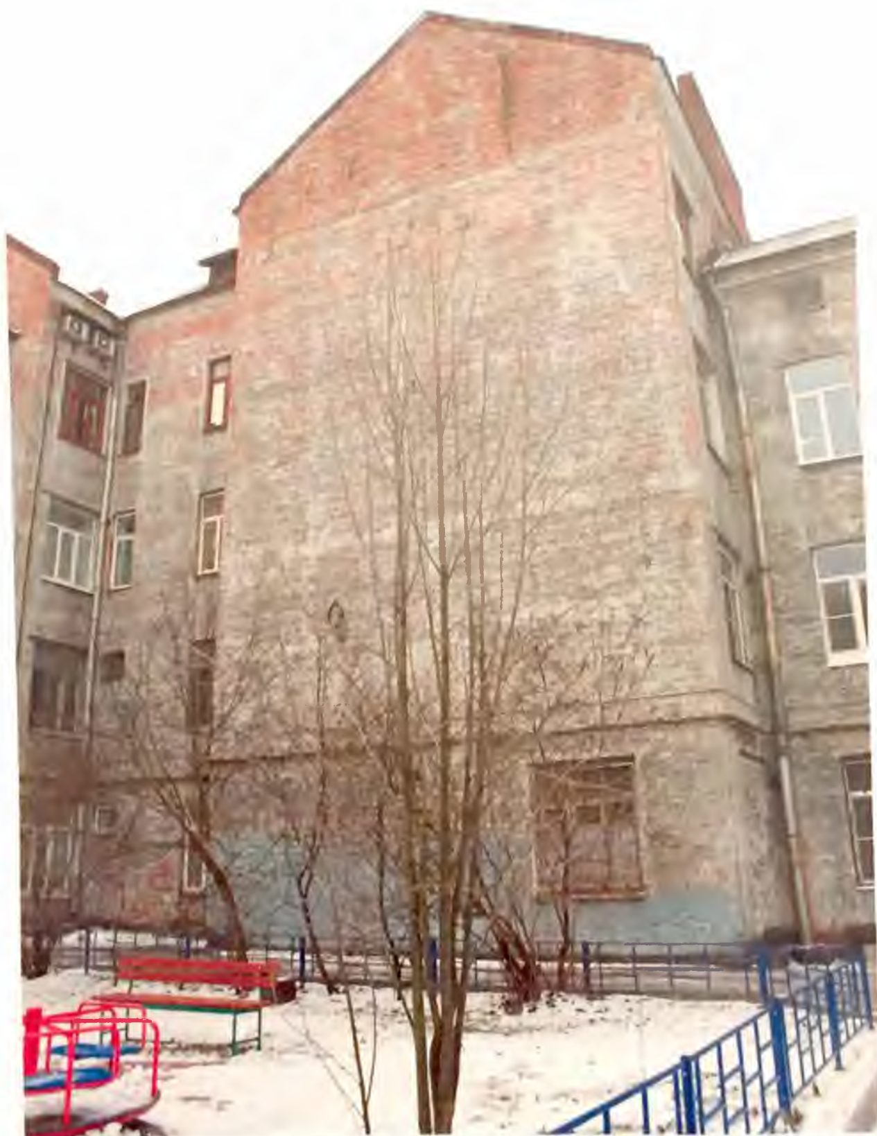
Фото 7.1. Северный фасад здания. Фрагмент. Автор фото: Маланничева Г.Н. 30.11.2016 г.
