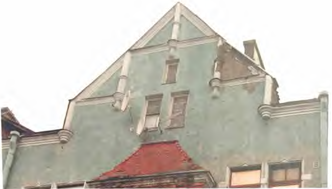
Фото 2.2. Восточный фасад здания. Фрагмент. Автор фото: Маланичева Г.И. 30.11.2016 г.
