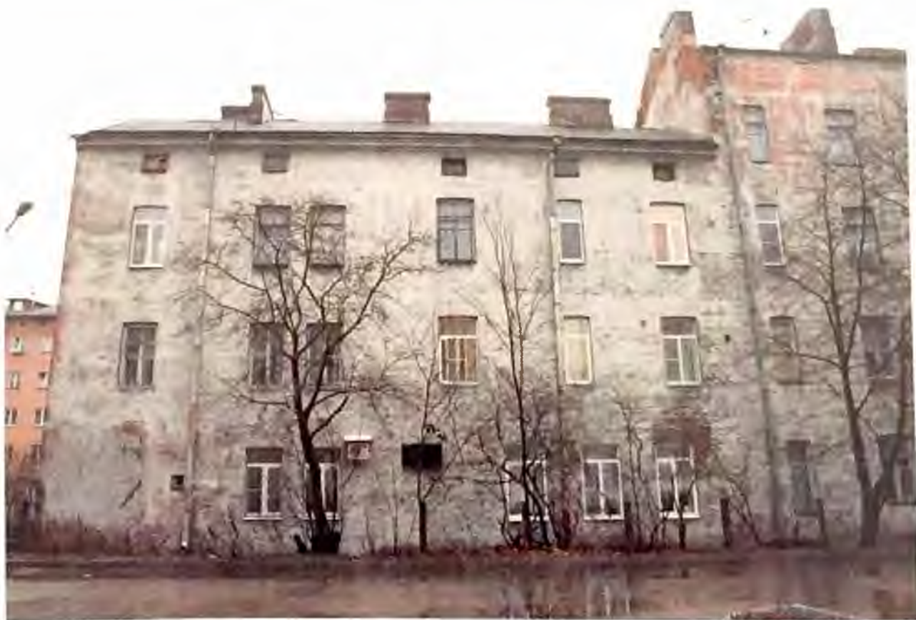
Фото 6.1. Западный фасад здания. Фрагмент. Автор фото: Маланничева Г.Н. 30.11.2016 г.
