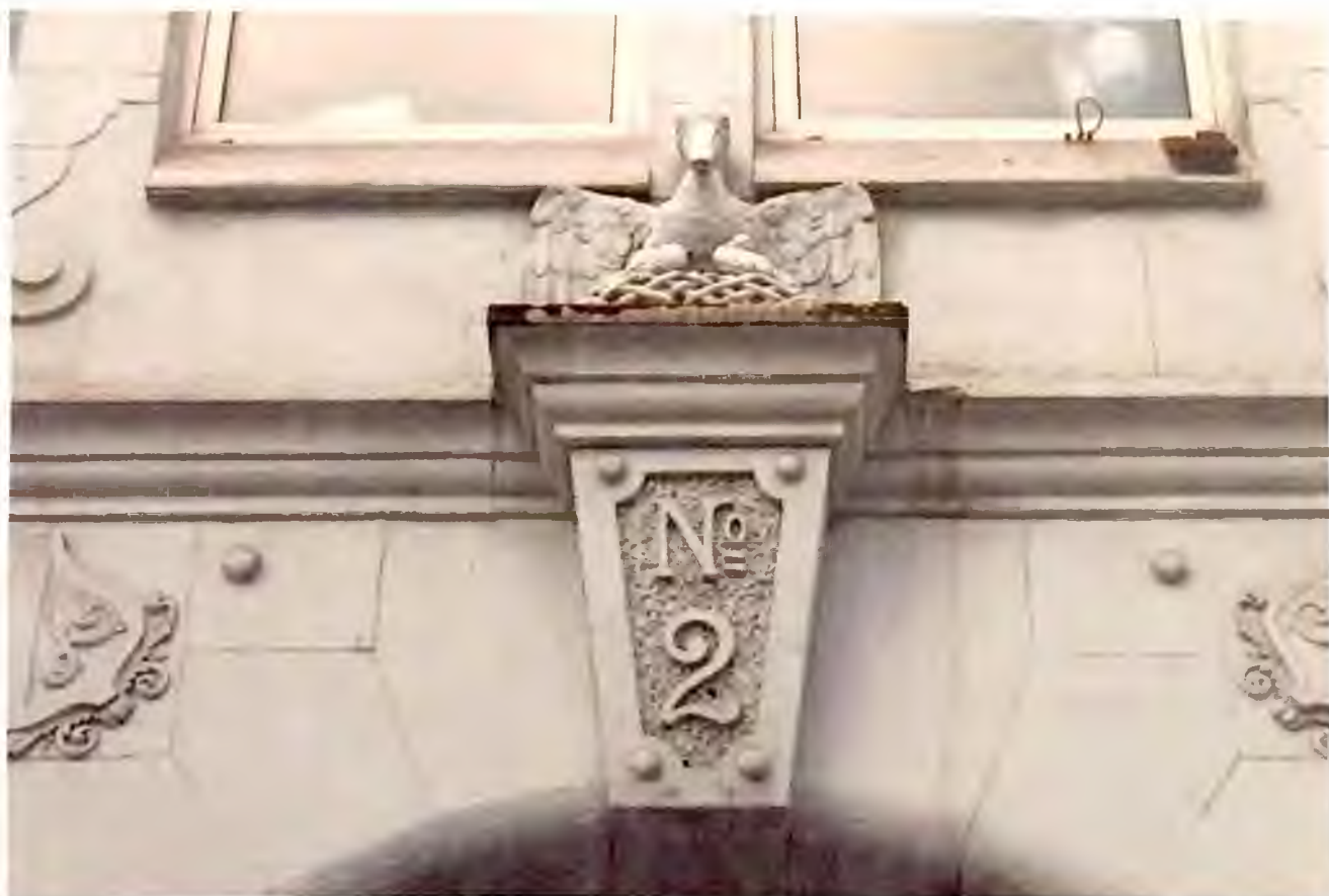
Фото 2.5. Восточный фасад здания. Фрагмент. Автор фото: Маланичева Г.И. 30.11.2016 г.
