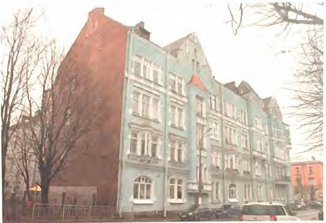
Фото 5. Южный фасад здания. Вид с запада. Автор фото: Маланичева Г.И. 30.11.2016 г.
