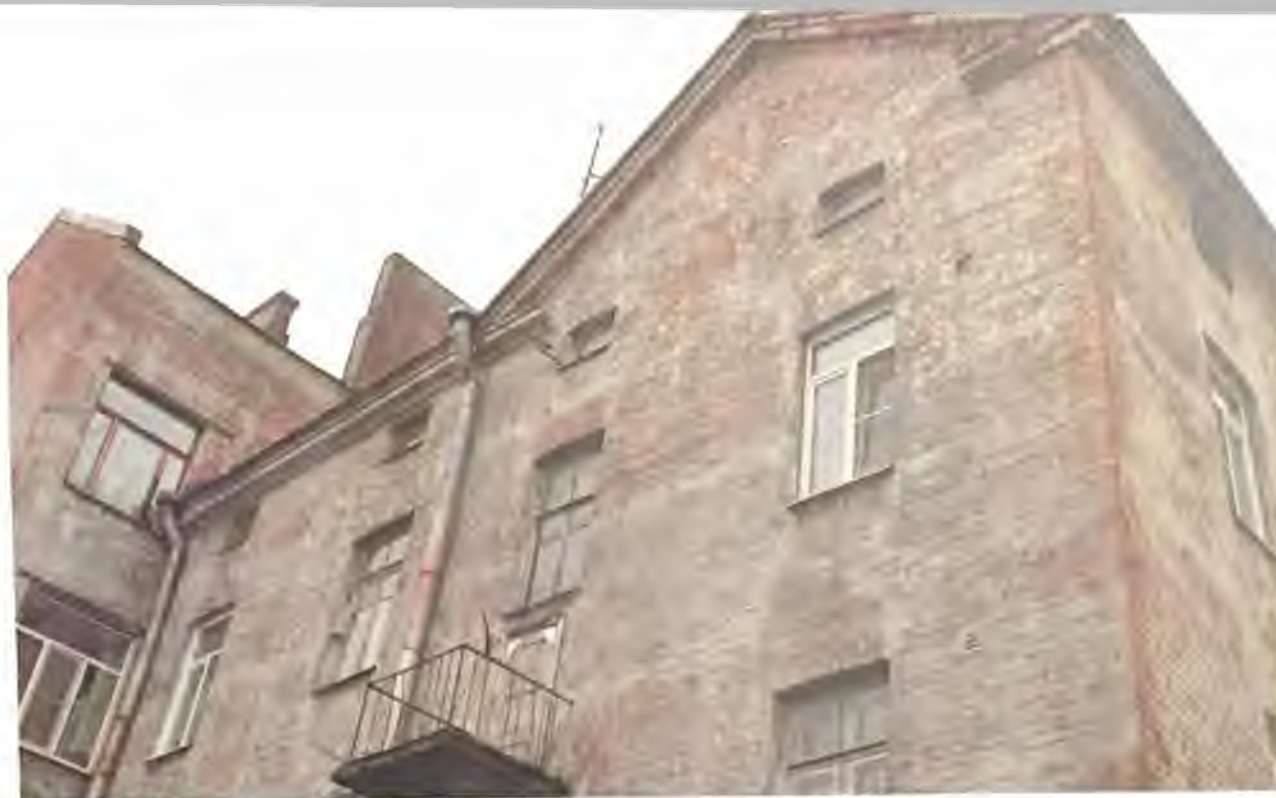
Фото 7.4. Северный фасад здания. Фрагмент. Автор фото: Маланичева Г.И. 30.11.2016 г.
