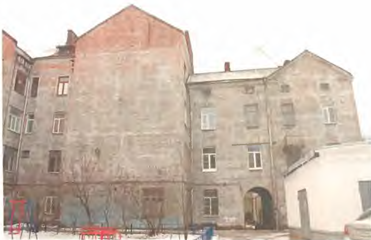
Фото 7. Северный фасад здания. Общий вид. Автор фото: Маланичева Г.И. 30.11.2016 г.
