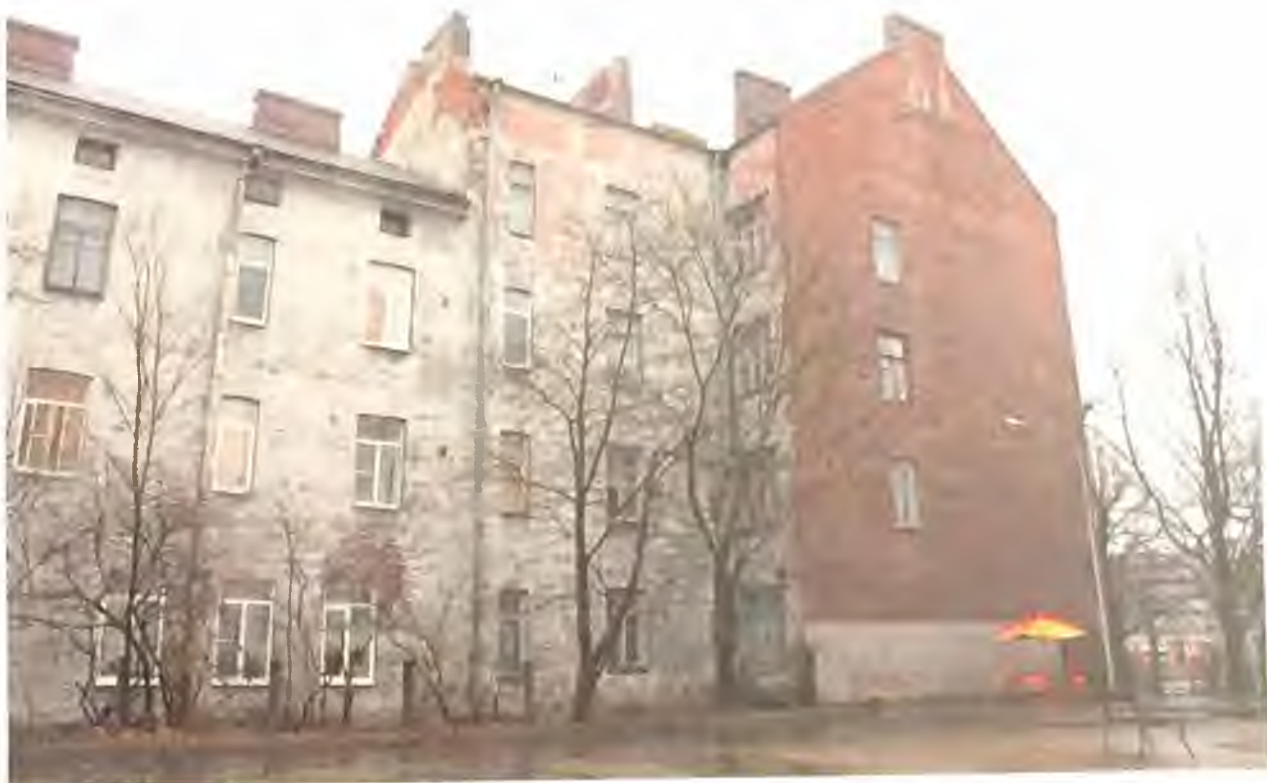
Фото 6. Западный фасад здания. Фрагмент. Автор фото: Маланничева Г.Н. 30.11.2016 г.
