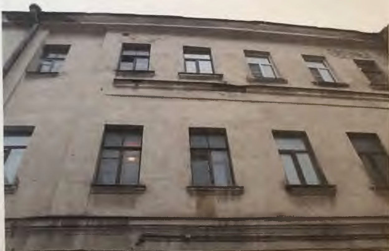
Фото 8.2. Западный фасад здания. Фрагмент. Автор фото: Маланичева Г.И. 30.11.2016 г.
