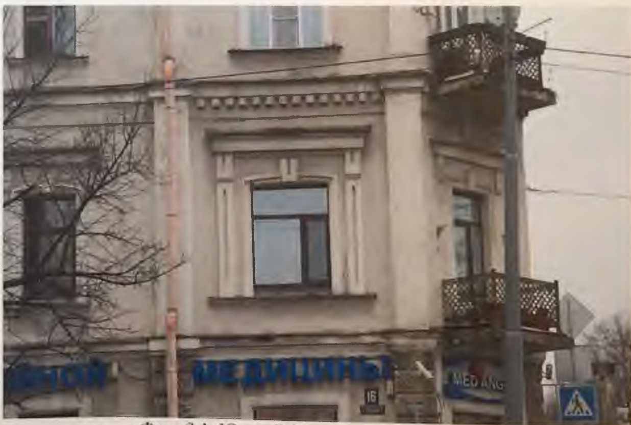
Фото 3.1. Южный фасад здания. Фрагмент. Автор фото: Маланичева Г.И. 30.11.2016 г.
