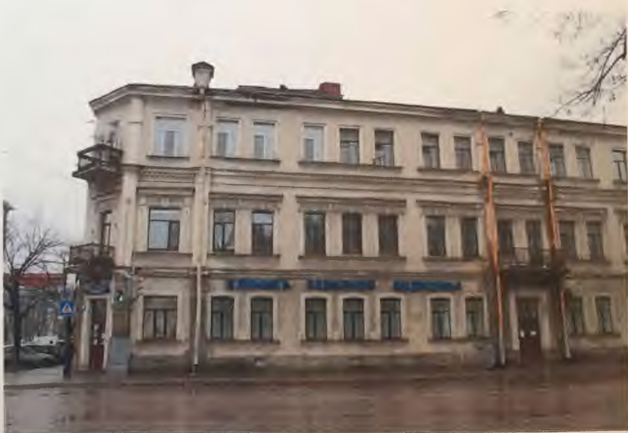
Фото 4.1. Восточный фасад здания. Фрагмент. Автор фото: Маланичева Г.И. 30.11.2016 г.
