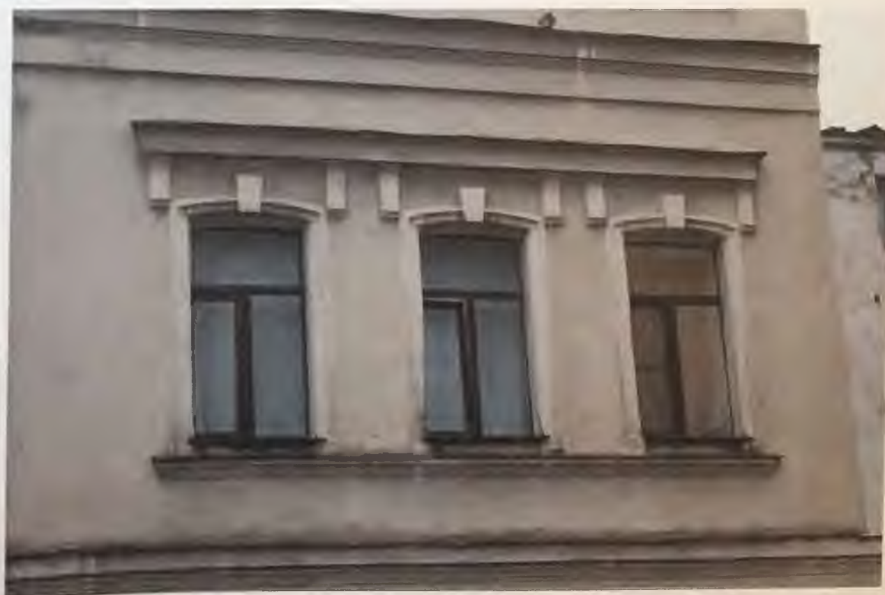
Фото 6.3. Северный фасад здания. Фрагмент. Автор фото: Маланичева Г.И. 30.11.2016 г.
