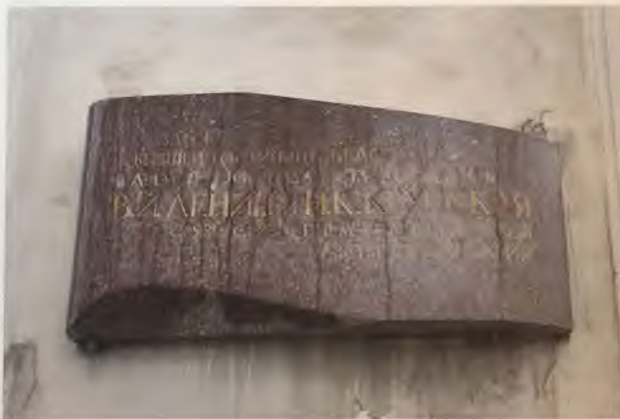
Фото 3.3. Южный фасад здания. Фрагмент. Автор фото: Маланичева Г.И. 30.11.2016 г.
