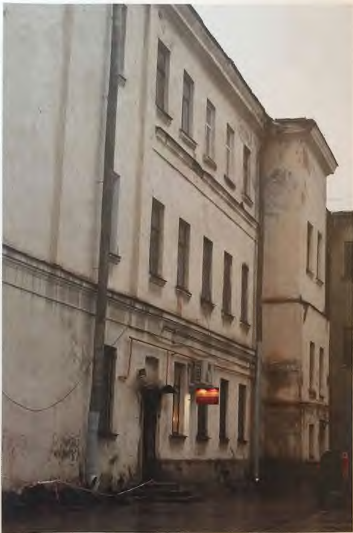
Фото 8. Западный фасад здания. Фрагмент. Автор фото: Маланичева Г.И. 30.11.2016 г.
