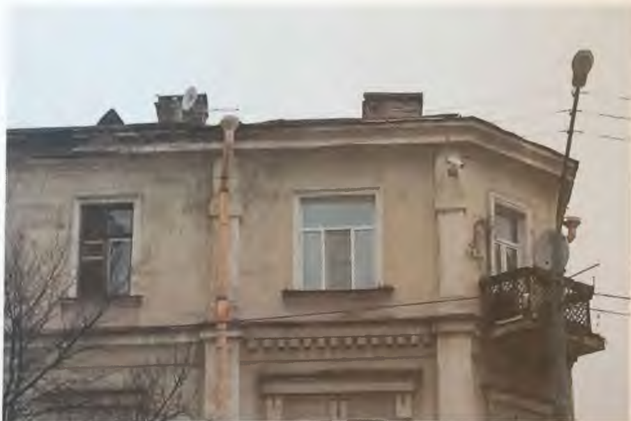
Фото 3.2. Южный фасад здания. Фрагмент. Автор фото: Маланичева Г.И. 30.11.2016 г.
