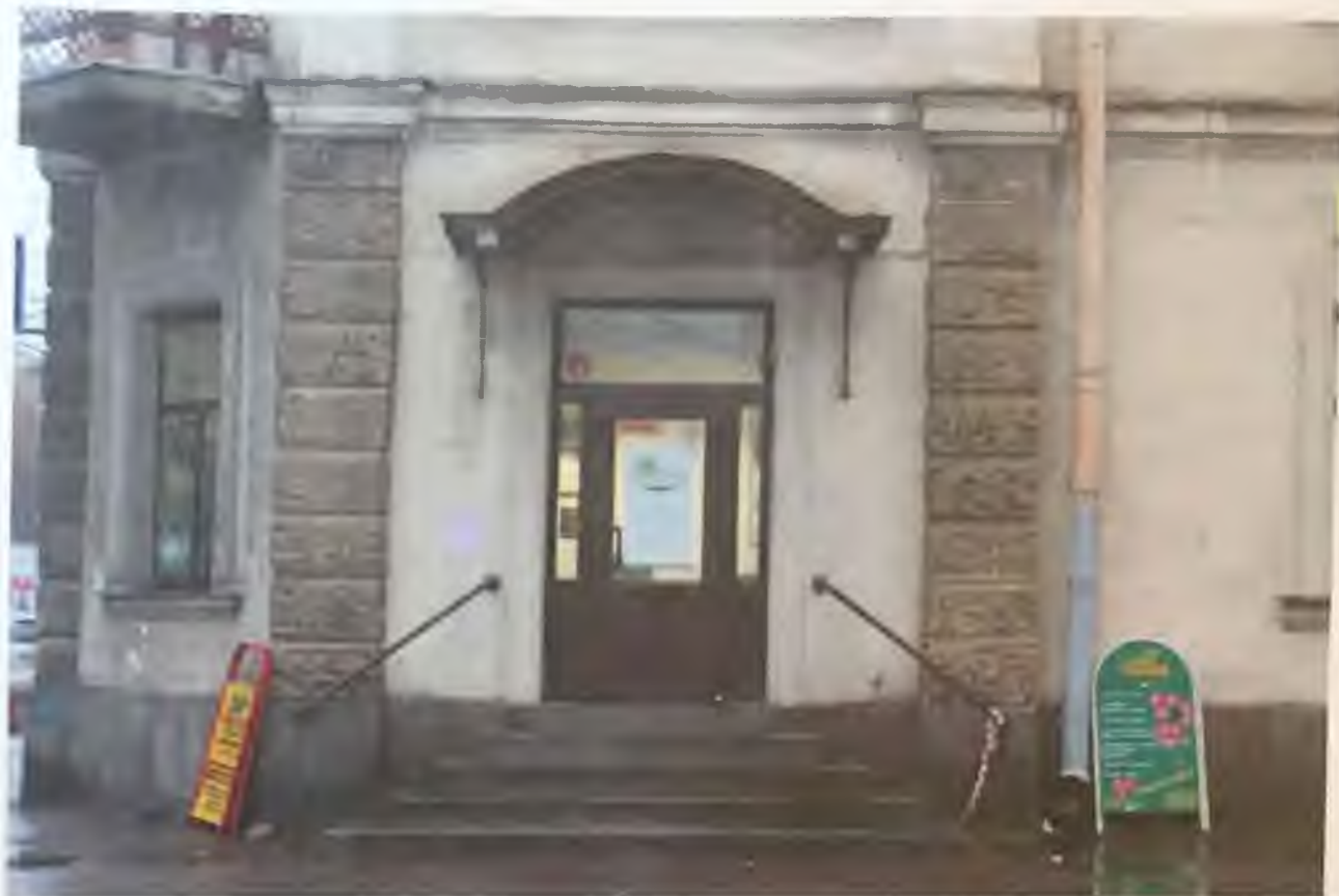
Фото 6.2. Северный фасад здания. Фрагмент. Автор фото: Маланичева Г.И. 30.11.2016 г.
