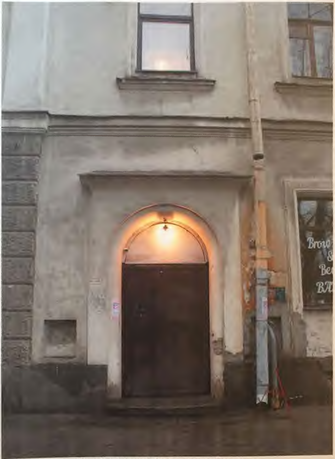
Фото 3.4. Южный фасад здания. Фрагмент. Автор фото: Маланичева Г.И. 30.11.2016 г.
