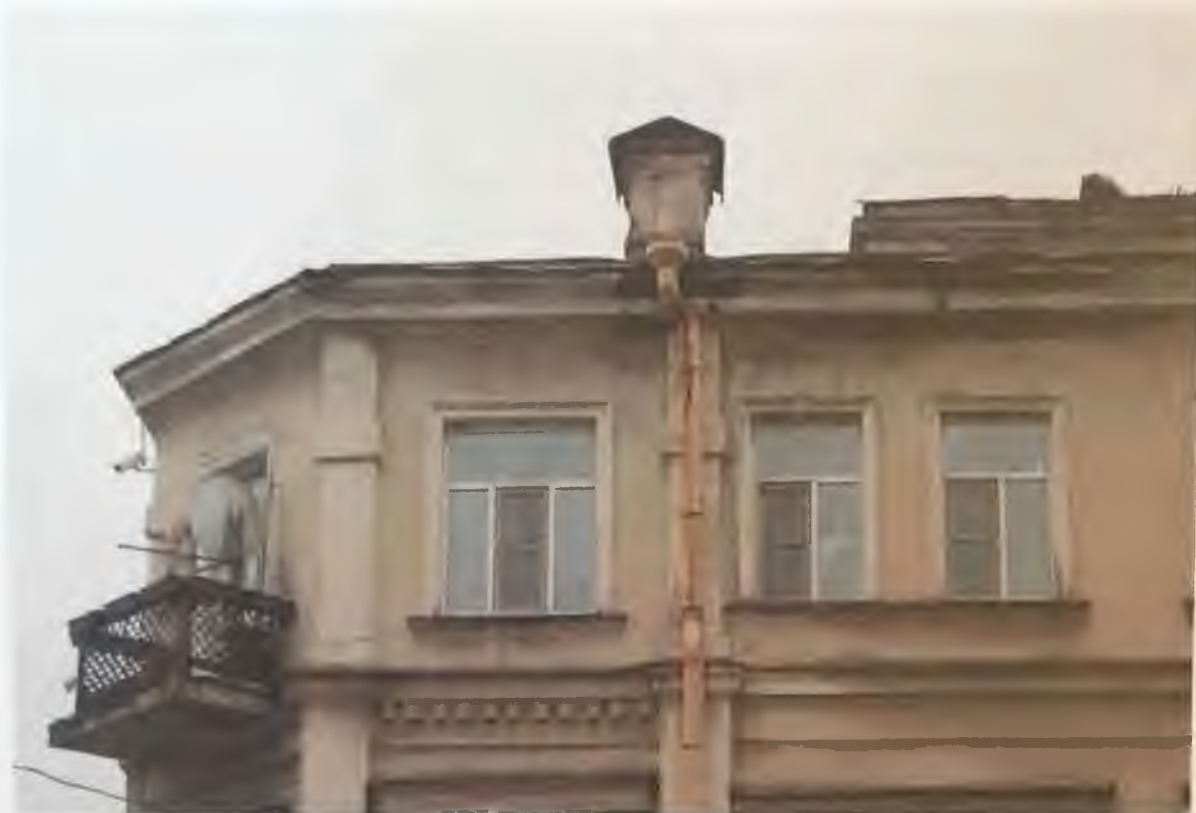
Фото 4.4. Восточный фасад здания. Фрагмент. Автор фото: Маланичева Г.И. 30.11.2016 г.
