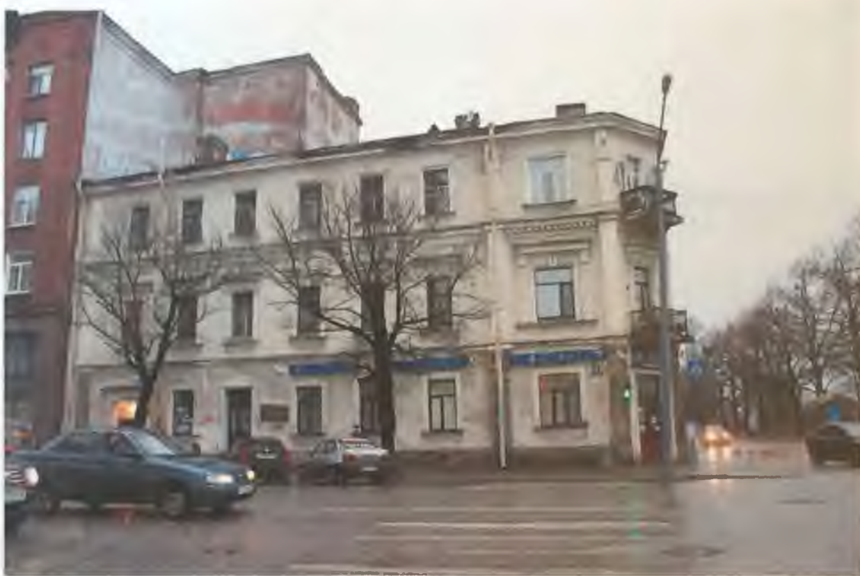
Фото 3. Южный фасад здания. Автор фото: Маланичева Г.И. 30.11.2016 г.
