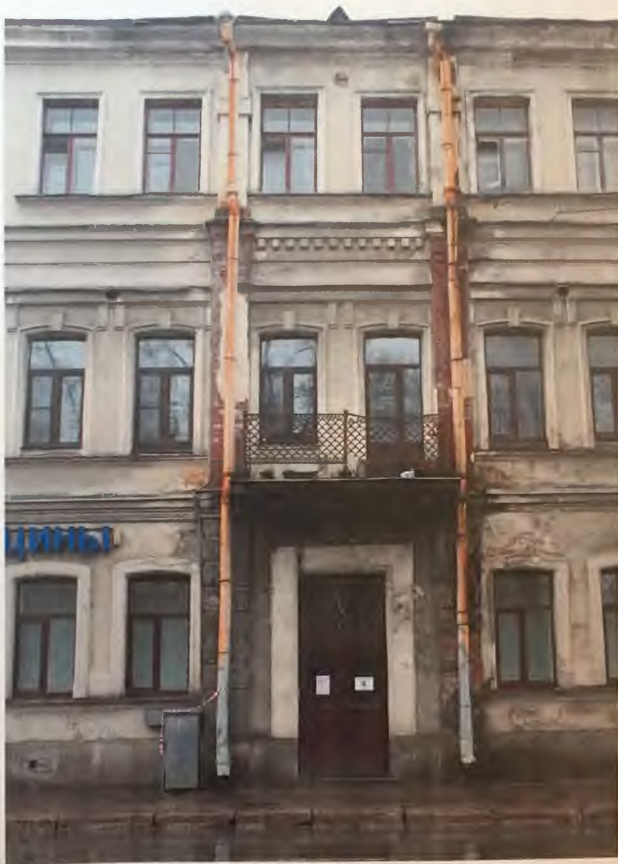
Фото 4.3. Восточный фасад здания. Фрагмент. Автор фото: Маланичева Г.И. 30.11.2016 г.
