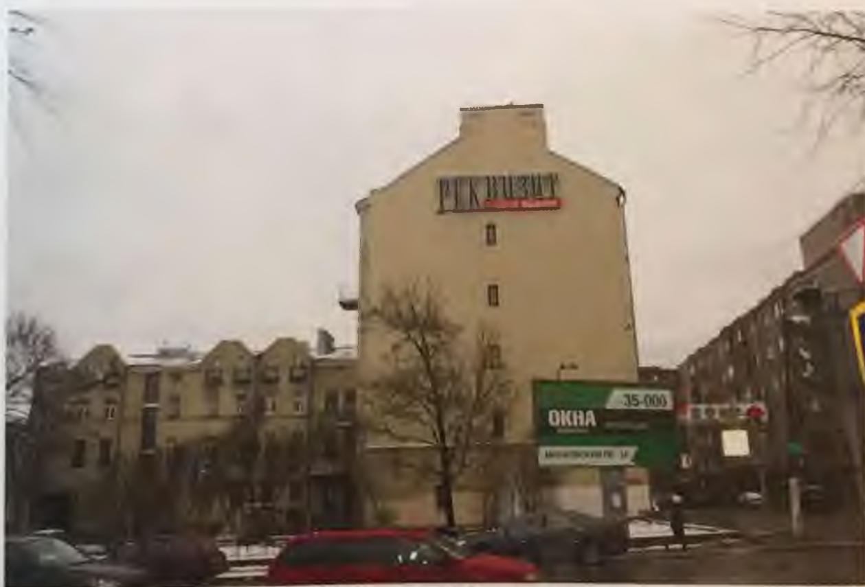
Фото 7. Западный фасад здания. Автор фото: Маланичева Г.И. 30.11.2016 г.
