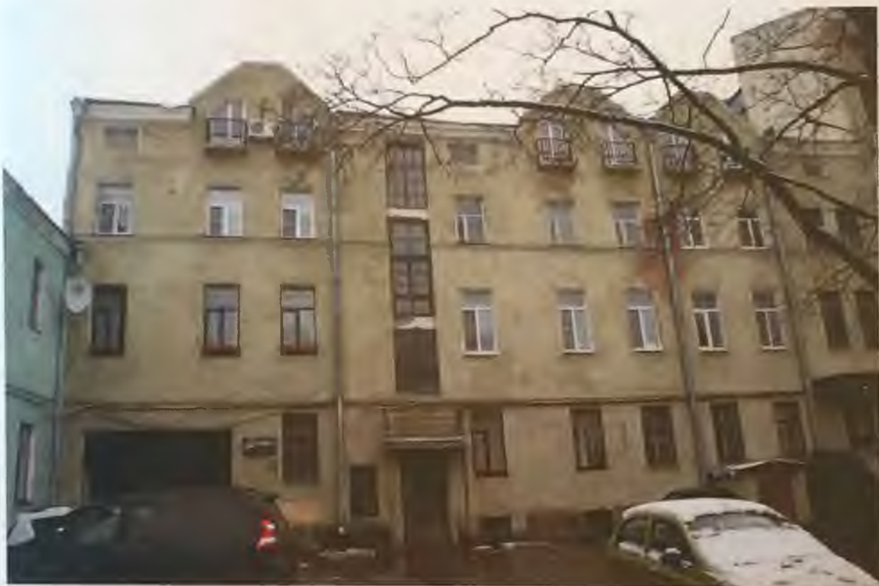
Фото 10. Западный фасад здания. Автор фото: Маланичева Г.И. 30.11.2016 г.
