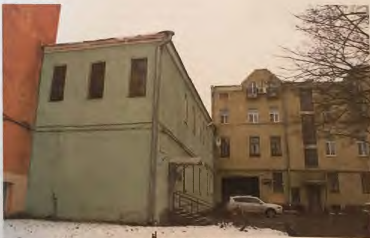
Фото 11. Западный фасад здания. Автор фото: Маланичева Г.И. 30.11.2016 г.
