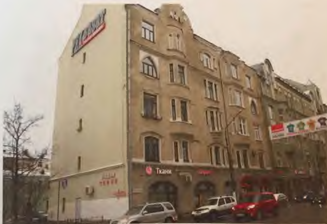
Фото 2. Южный и западный фасады здания. Автор фото: Маланичева Г.И. 30.11.2016 г.
