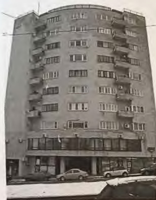
Фото 7. Юго-западный фасад здания. Автор фото: Маланичева Г.И. 30.11.2016 г.
