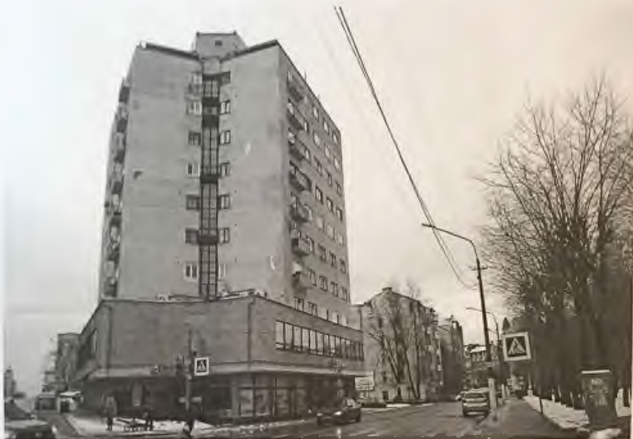
Фото 1. Общий вид здания с северо-востока. Автор фото: Маланичева Г.И. 30.11.2016 г.
