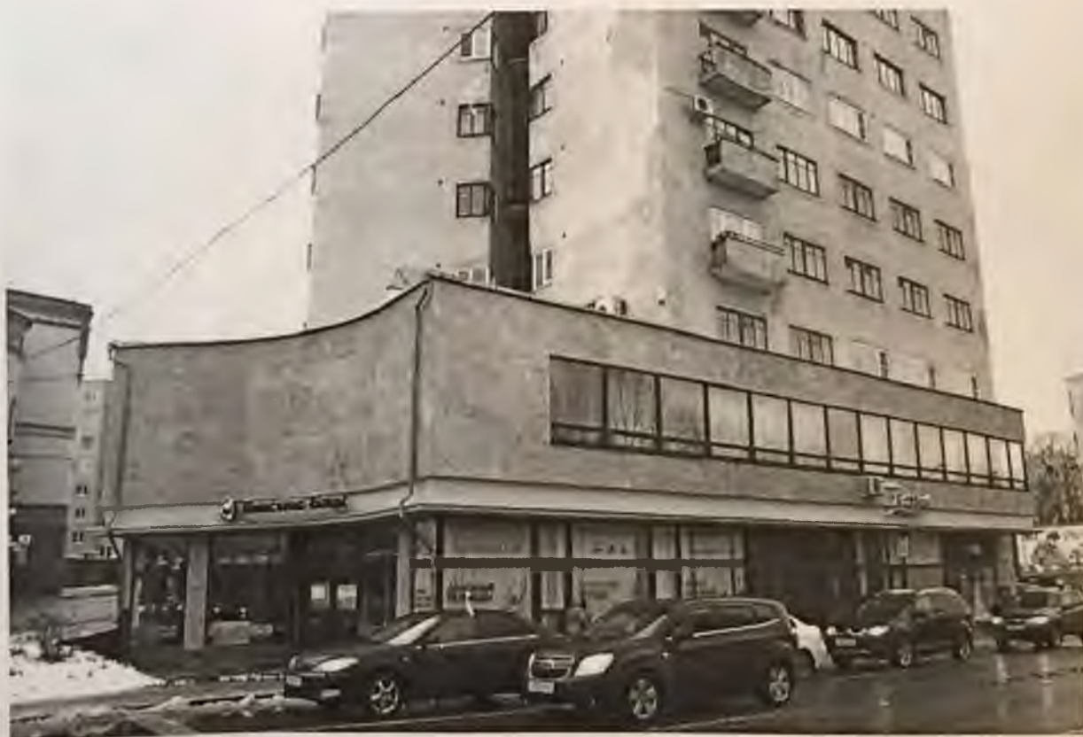
Фото 2. Северный фасад. Автор фото: Маланичева Г.И. 30.11.2016 г.
