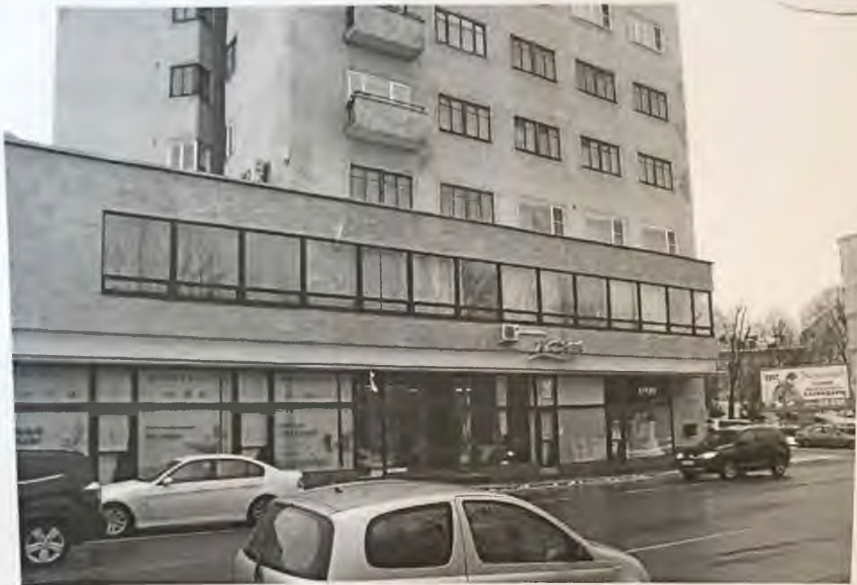
Фото 3. Северный фасад. Автор фото: Маланичева Г.И. 30.11.2016 г.
