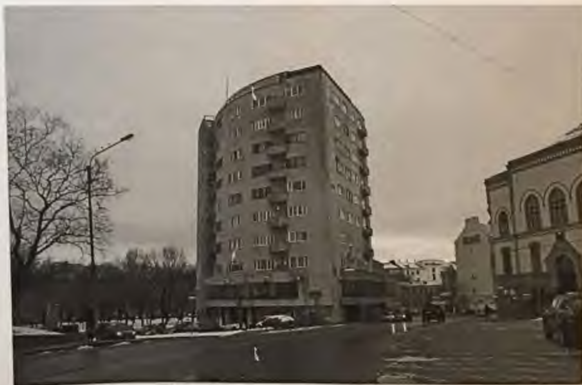
Фото 6. Вид на здание с юго-востока. Автор фото: Маланичева Г.И. 30.11.2016 г.
