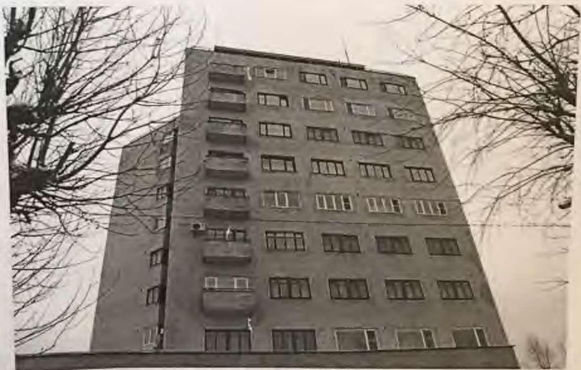
Фото 4. Северный фасад. Автор фото: Маланичева Г.И. 30.11.2016 г.
