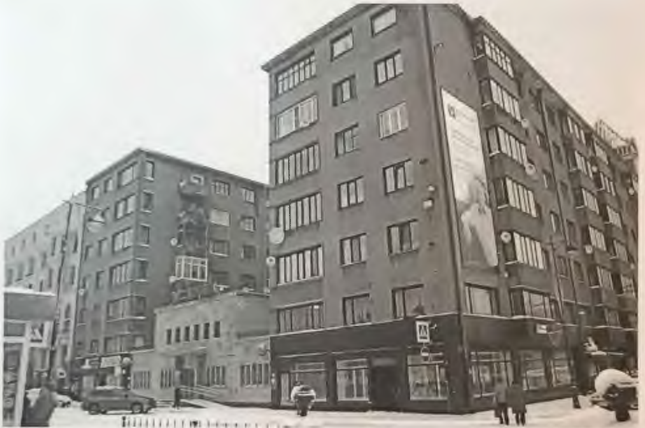
Фото 3. Общий вид здания со стороны пр. Ленина. Автор фото: Маланичева Г.И. 29.11.2016 г.
