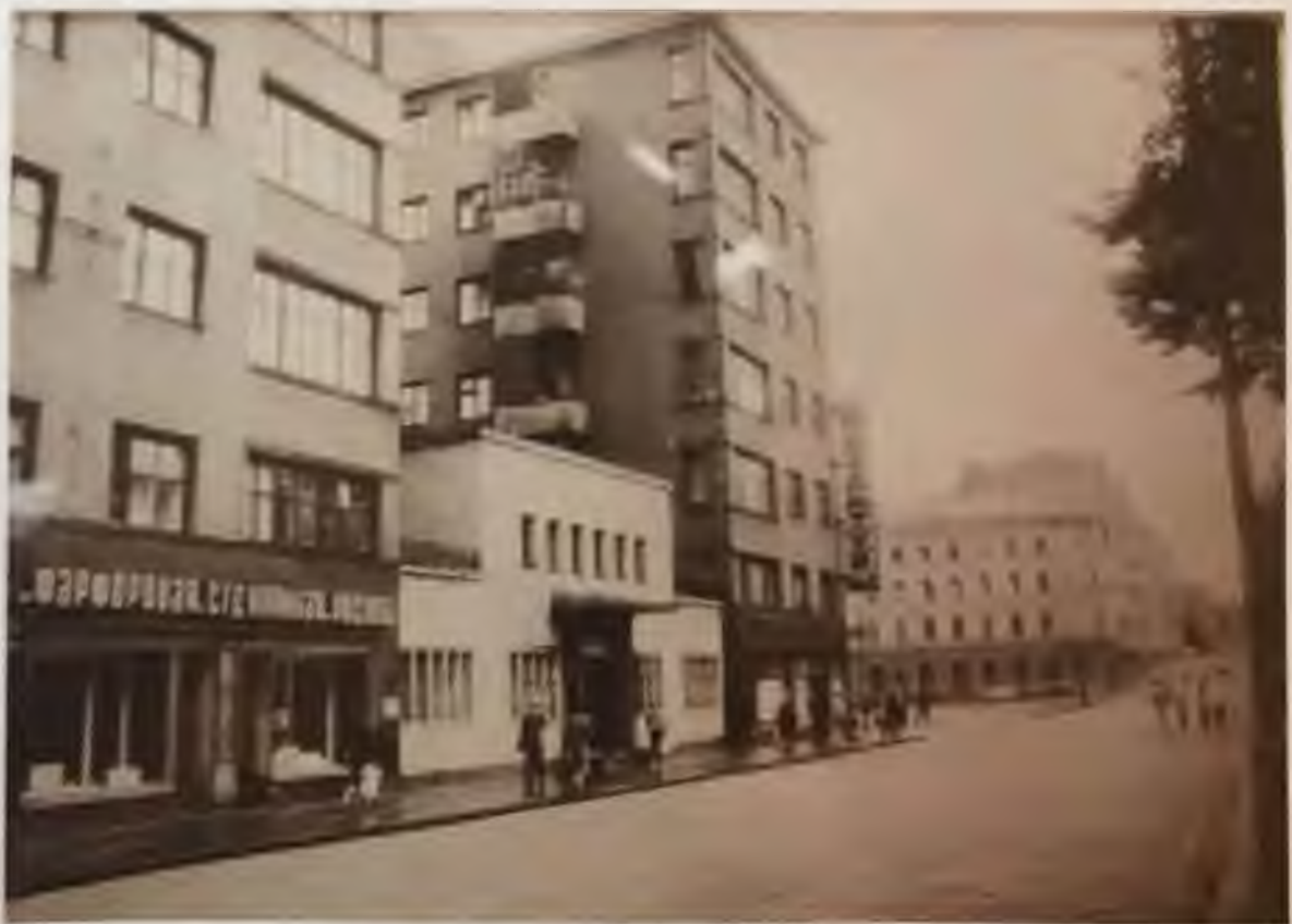
Илл. 13. Вид комплекса зданий а/о «Кулма» с пр. Ленина (ул. Торккеленкату). Фото 1991г.
