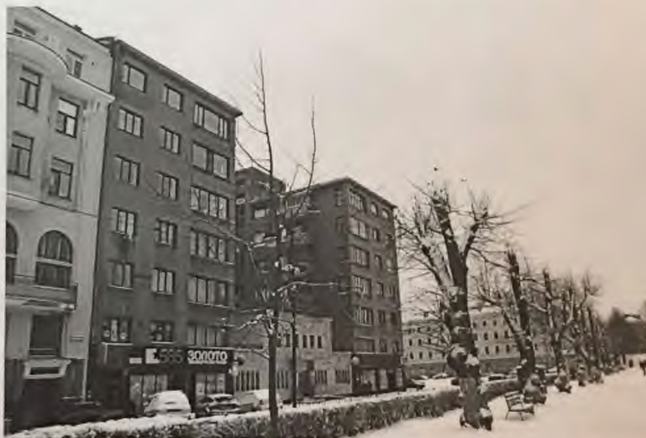
Фото 2. Общий вид здания со стороны пр. Ленина с северо-запада. Автор фото: Маланичева Г.И. 29.11.2016 г.
