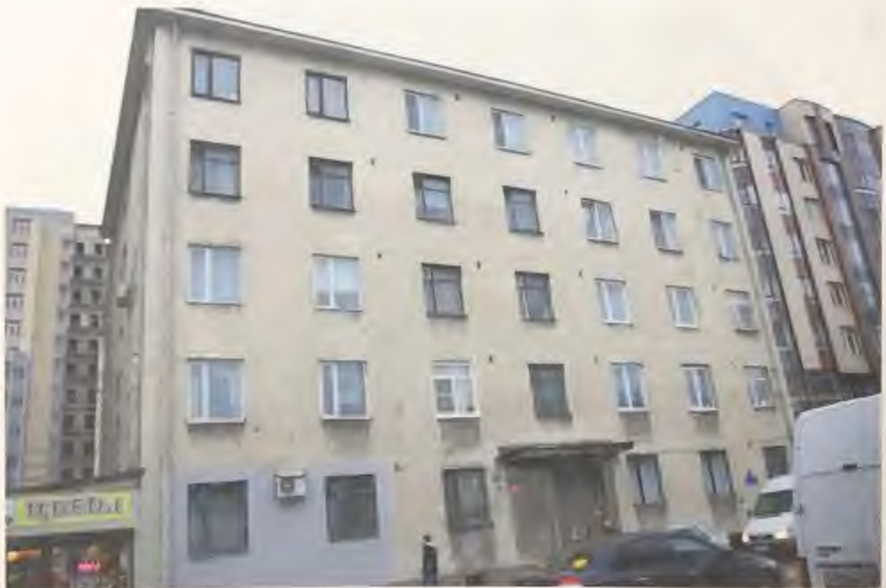
Фото 2. Северный фасад здания. Автор фото: Маланичева Г.И. 30.11.2016 г.
