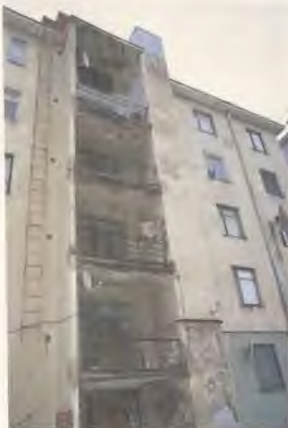
Фото 11. Южный фасад здания. Автор фото: Маланичева Г.И. 30.11.2016 г.
