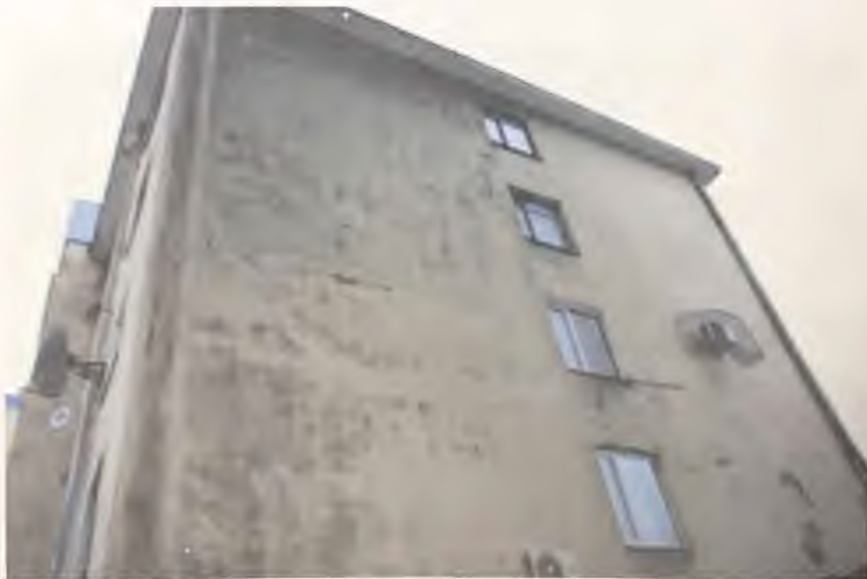
Фото 6. Западный фасад здания. Автор фото: Маланичева Г.И. 30.11.2016 г.
