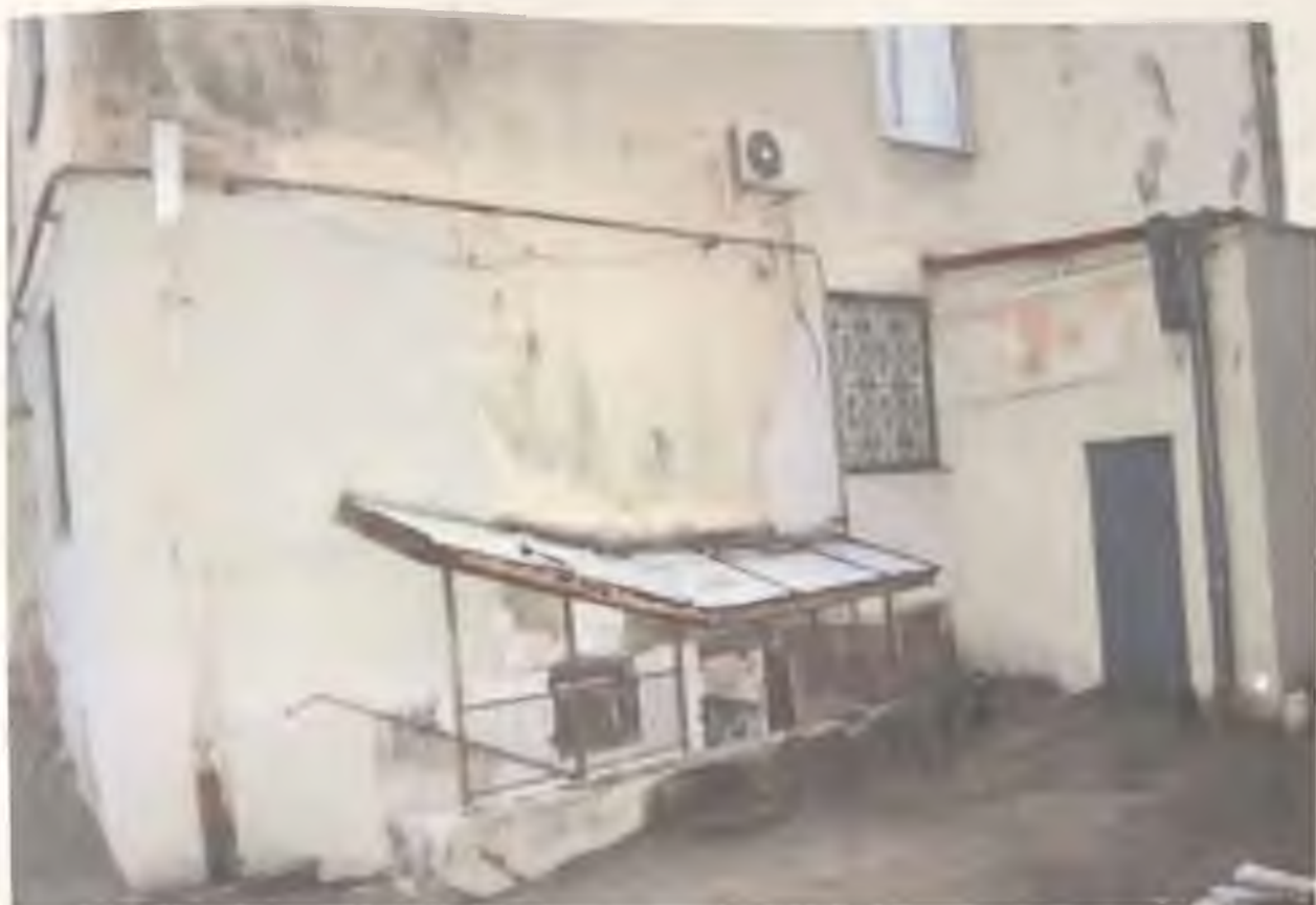
Фото 7. Западный фасад здания. Автор фото: Маланичева Г.И. 30.11.2016 г.
