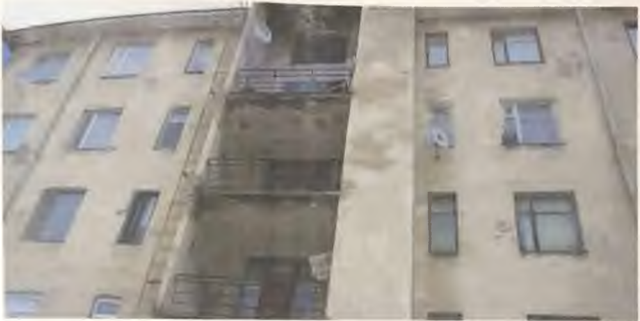
Фото 9. Южный фасад здания. Автор фото: Маланичева Г.И. 30.11.2016 г.
