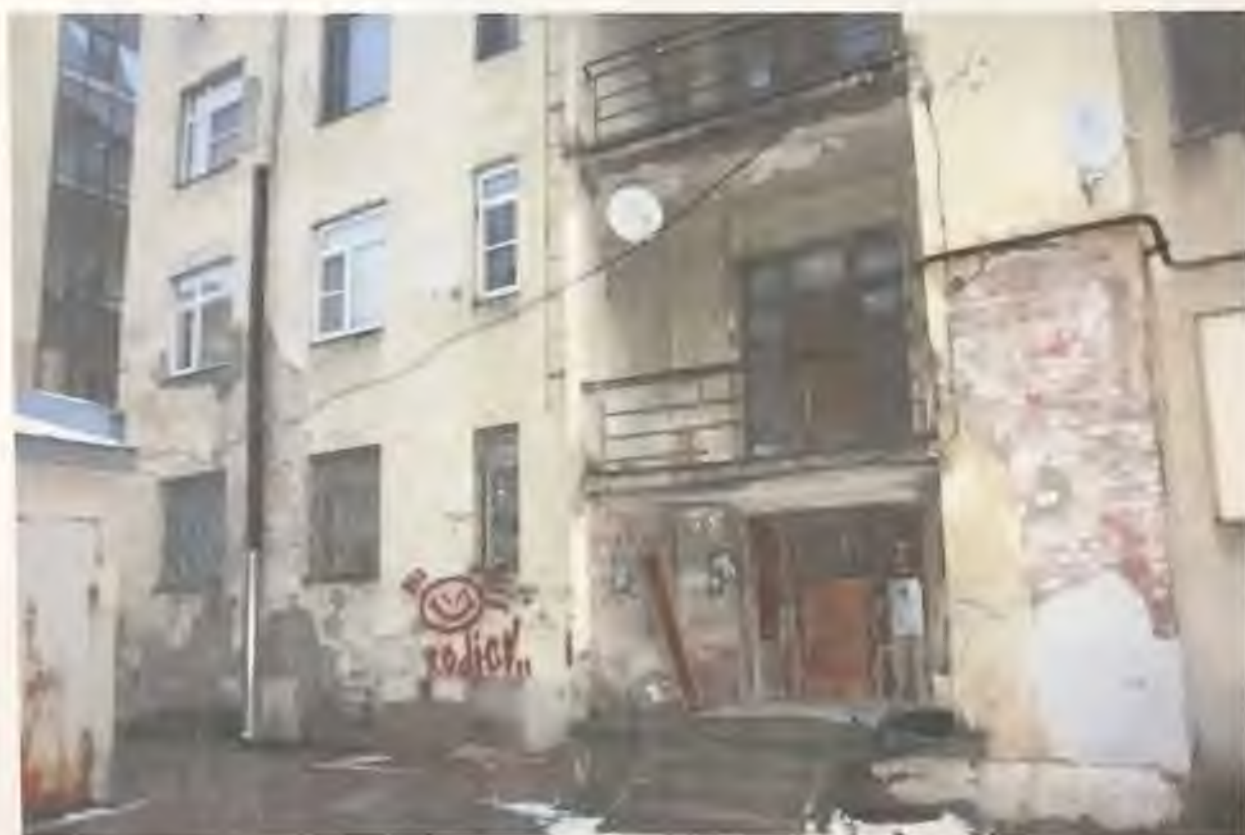
Фото 8. Южный фасад здания. Автор фото: Маланичева Г.И. 30.11.2016 г.
