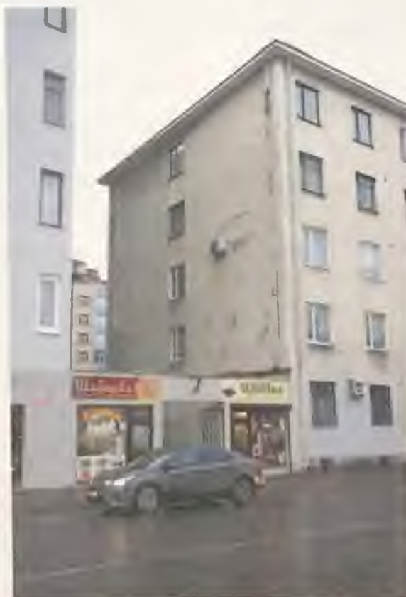
Фото 10. Восточный и южный фасады здания. Автор фото: Маланичева Г.И. 30.11.2016 г.
