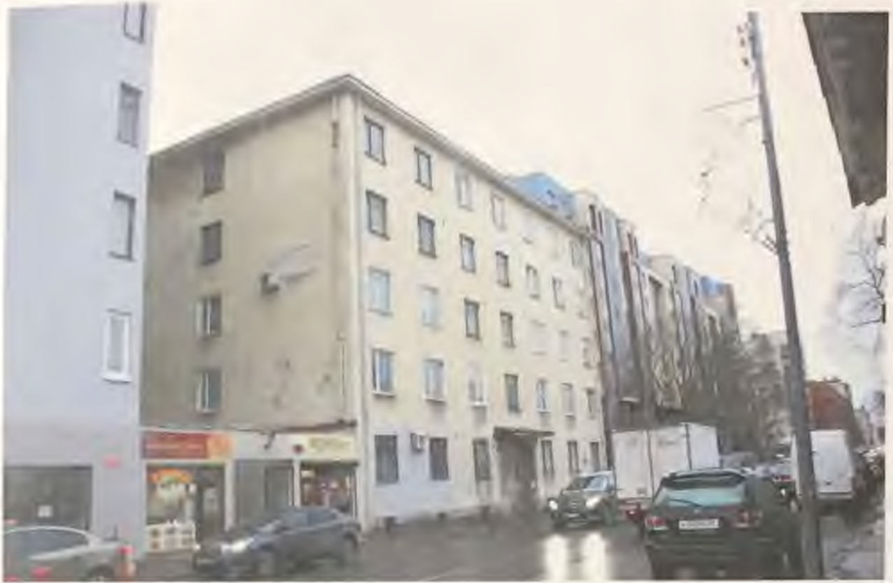
Фото 1. Общий вид здания с северо-востока. Автор фото: Маланичева Г.И. 30.11.2016 г.
