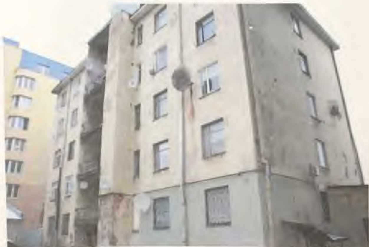
Фото 4. Западный и южный фасады здания. Автор фото: Маланичева Г.И. 30.11.2016 г.
