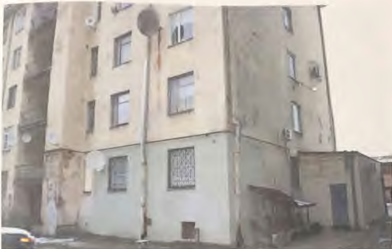
Фото 5. Западный и южный фасады здания. Автор фото: Маланичева Г.И. 30.11.2016 г.
