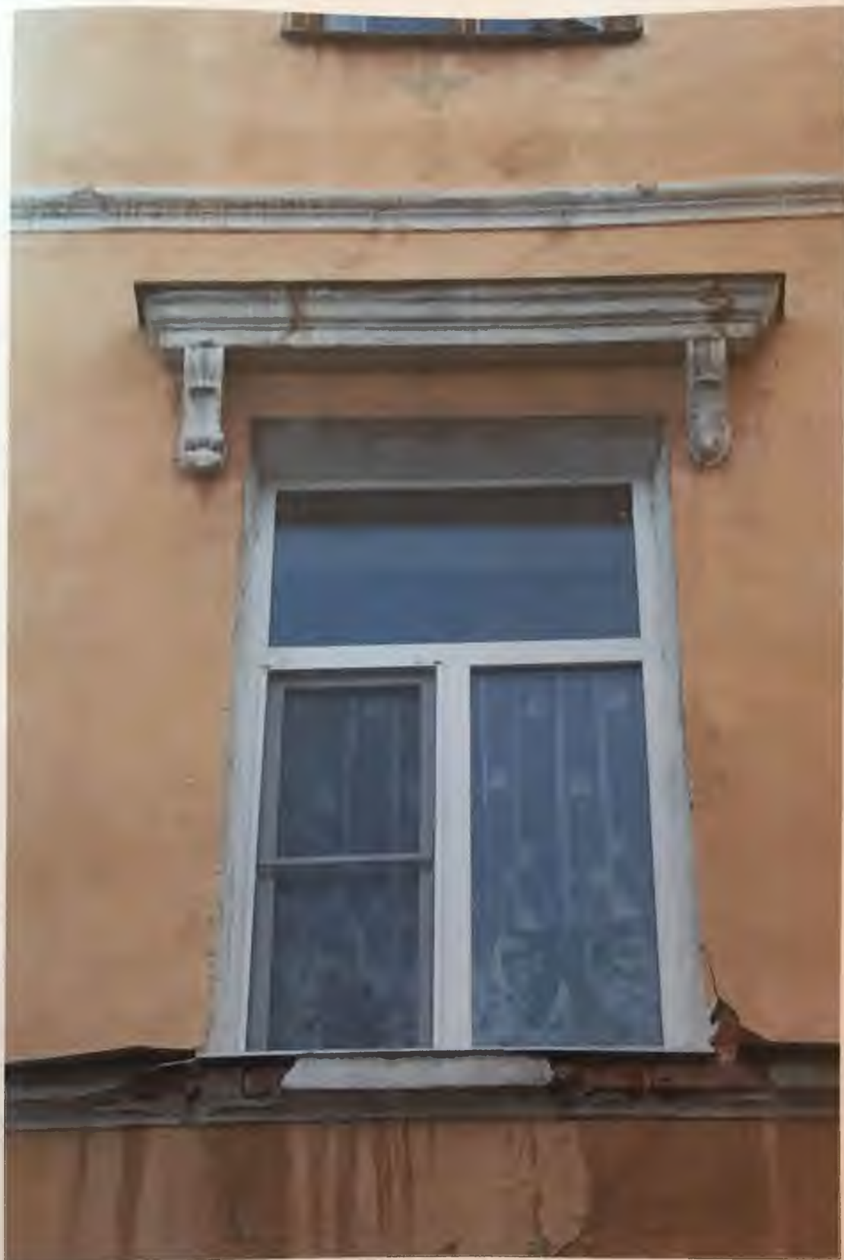
Фото 2.4. Западный фасад здания. Фрагмент. Автор фото: Маланичева Г.И. 30.11.2016 г.
