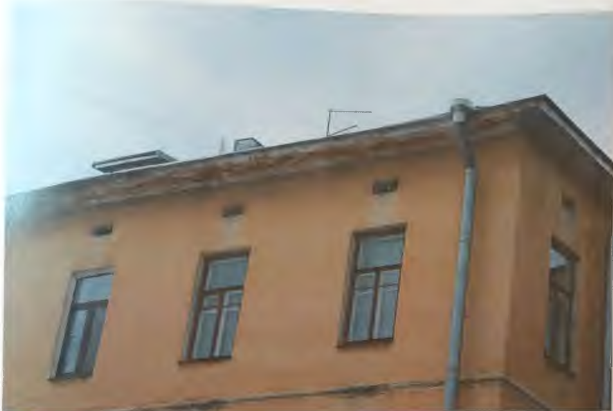
Фото 3.3. Восточный фасад здания. Фрагмент. Автор фото: Маланичева Г.И. 30.11.2016 г.
