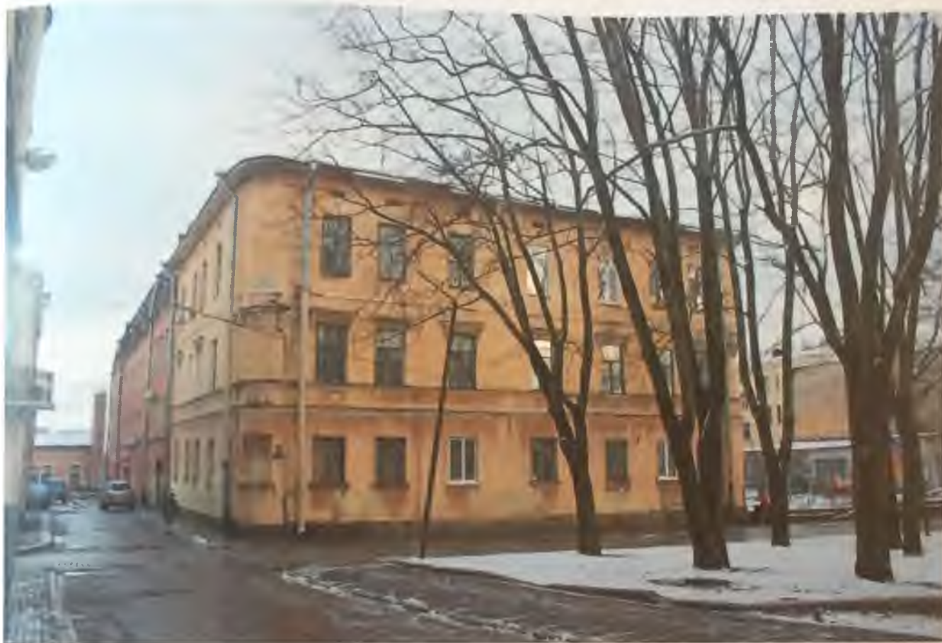
Фото 1. Общий вид здания с юго-запада. Автор фото: Маланичева Г.И. 30.11.2016 г.
