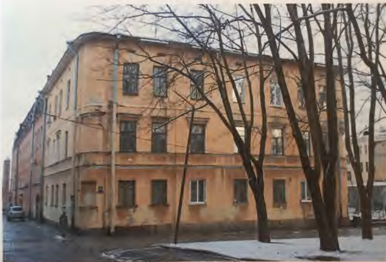
Фото 2. Южный фасад здания. Вид с севера. Автор фото: Маланичева Г.И. 30.11.2016 г.
