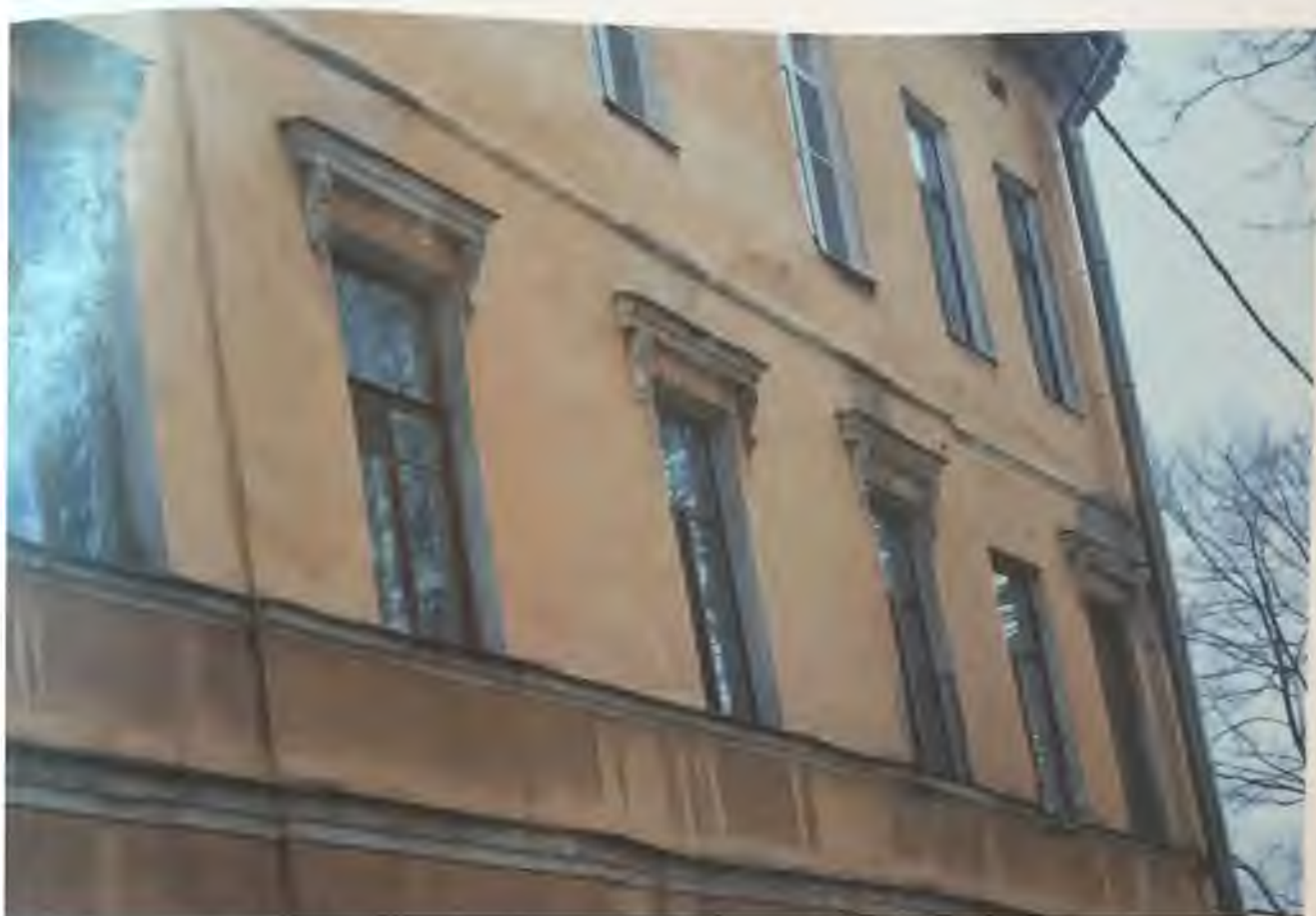
Фото 2.3. Западный фасад здания. Фрагмент. Автор фото: Маланичева Г.И. 30.11.2016 г.
