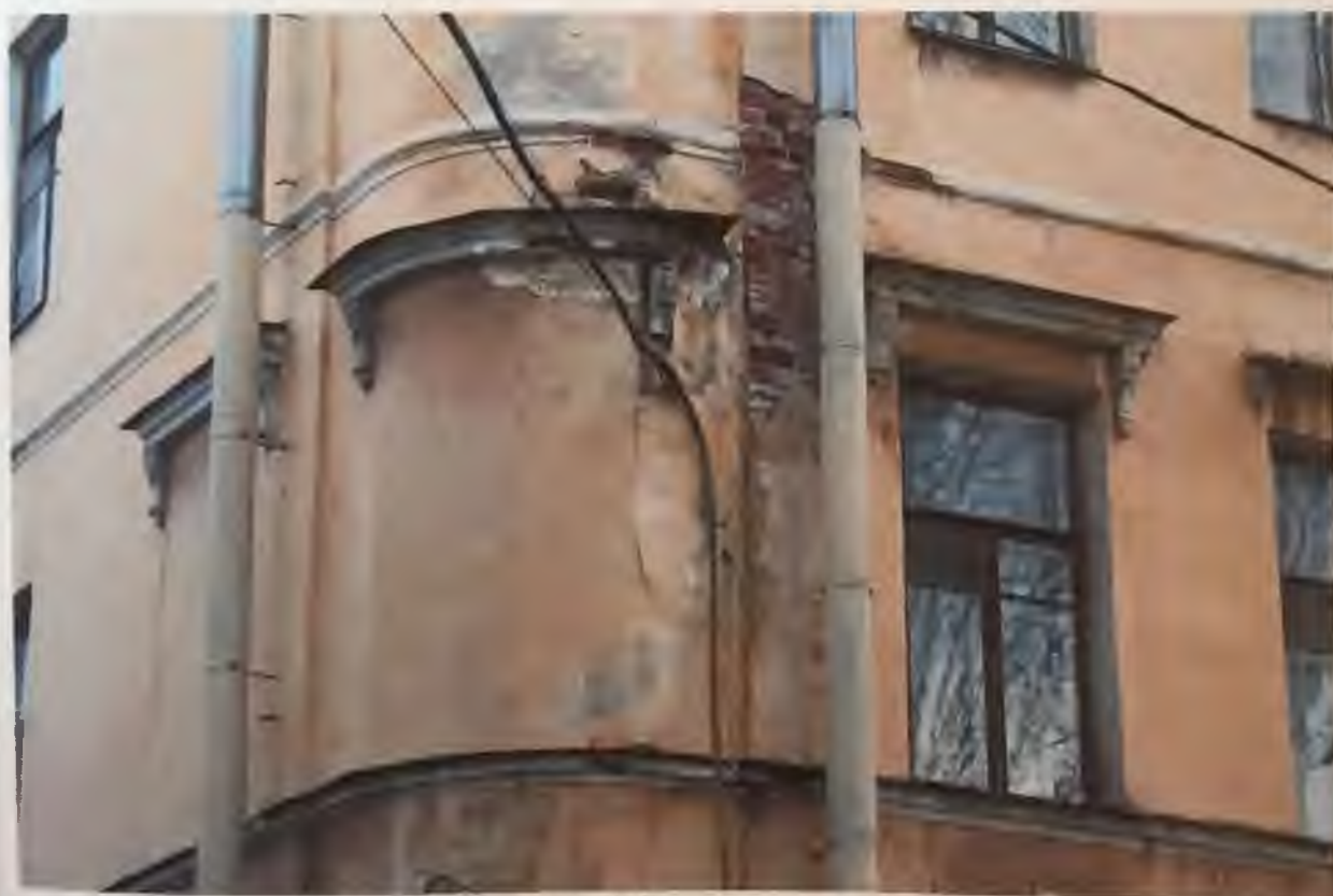
Фото 2.2. Западный фасад здания. Фрагмент. Автор фото: Маланичева Г.И. 30.11.2016 г.
