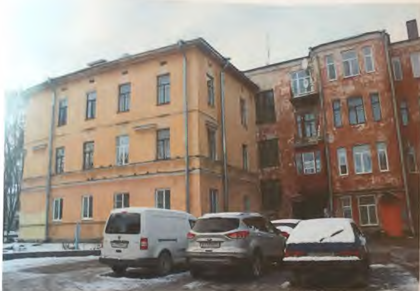
Фото 3. Восточный фасад здания. Общий вид. Автор фото: Маланичева Г.И. 30.11.2016 г.
