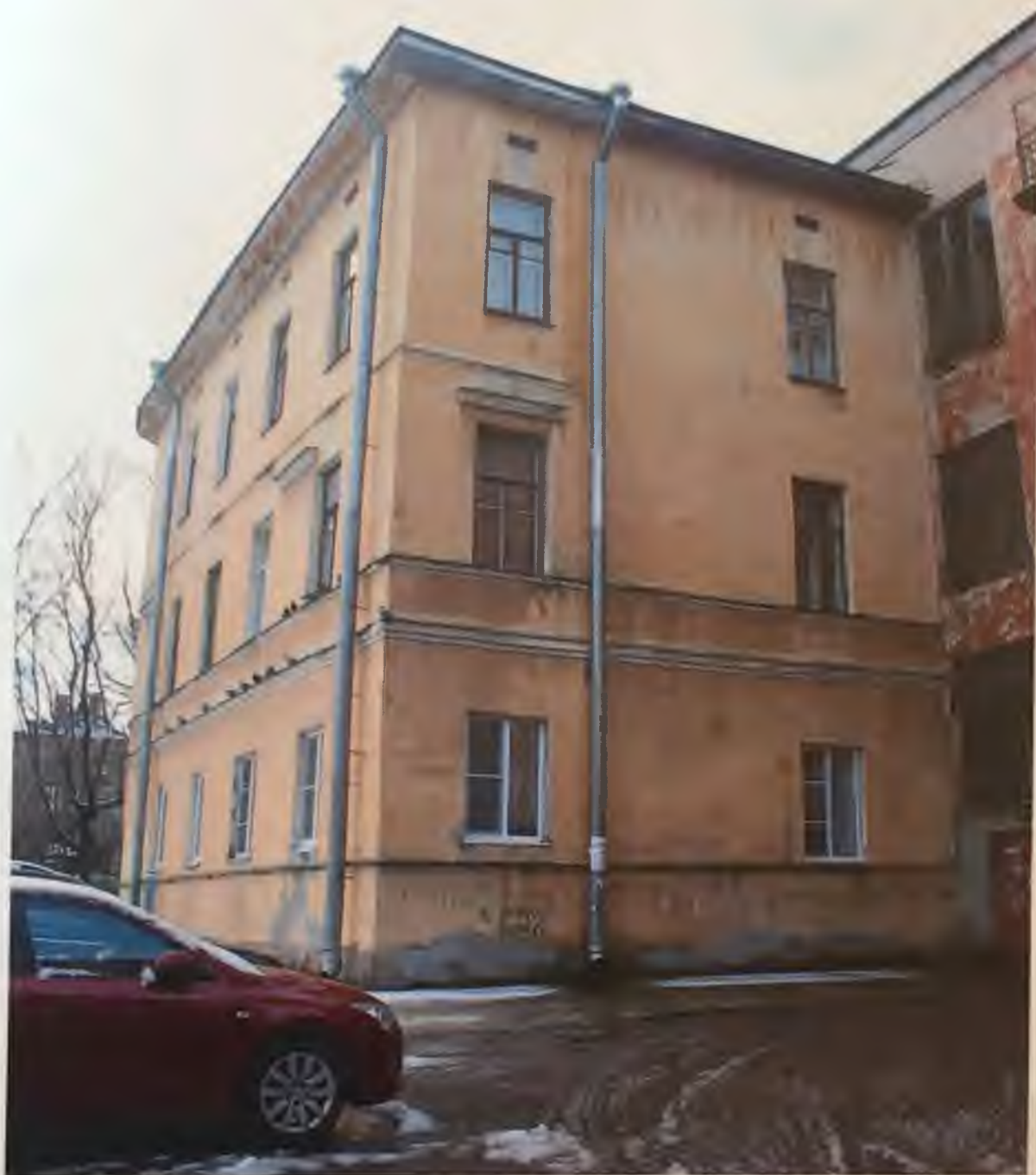
Фото 3.2. Восточный фасад здания. Фрагмент. Автор фото: Маланичева Г.И. 30.11.2016 г.
