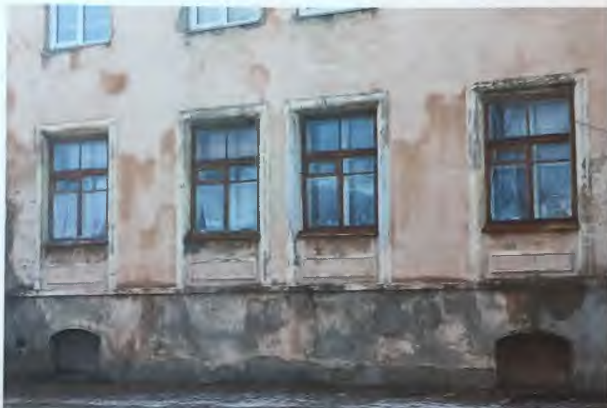
Фото 2.1. Западный фасад здания Фрагмент. Автор фото: Маланичева Г.И. 30.11.2016 г.
