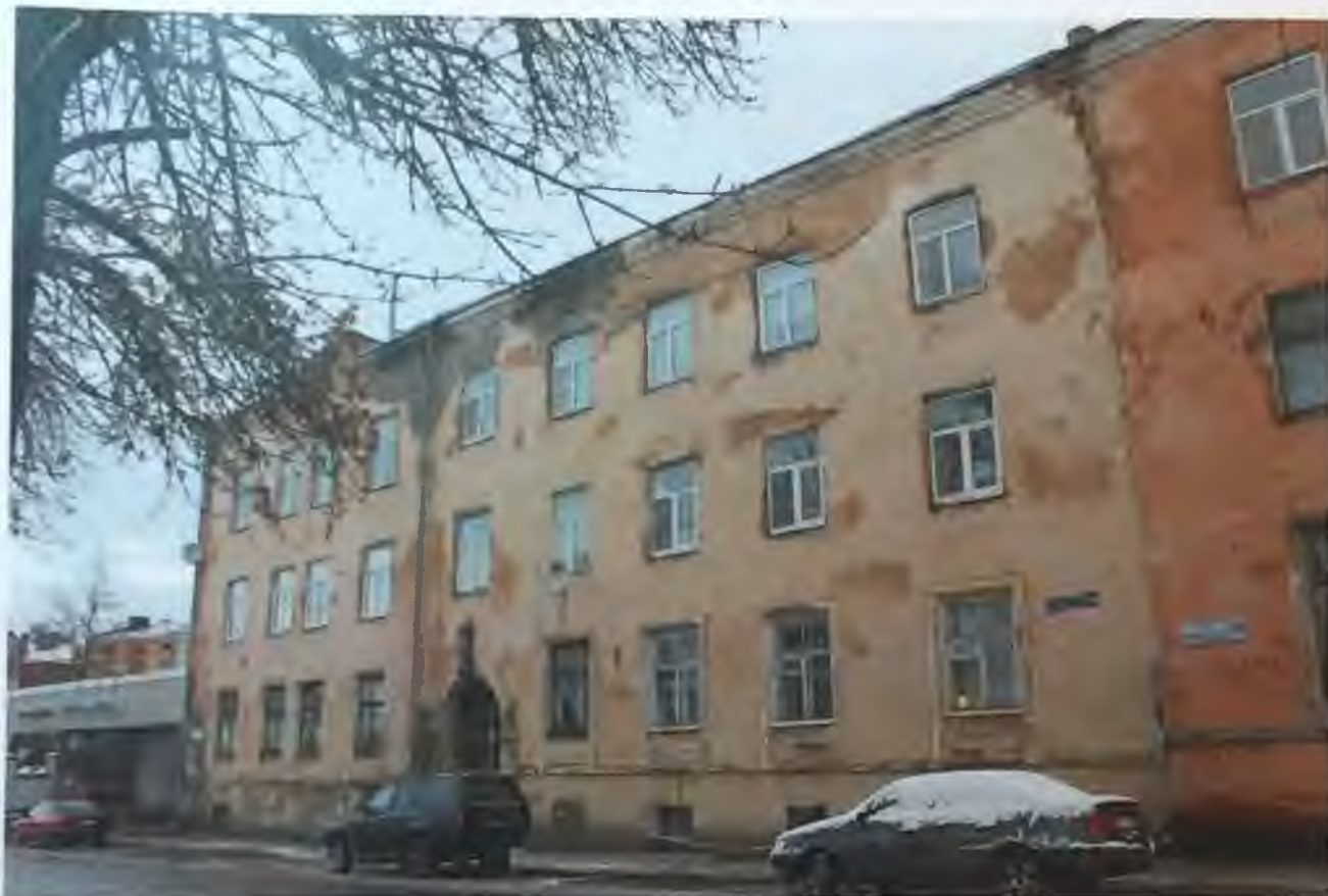
Фото 1. Общий вид здания с юго-востока. Автор фото: Маланичева Г.И. 30.11.2016 г.
