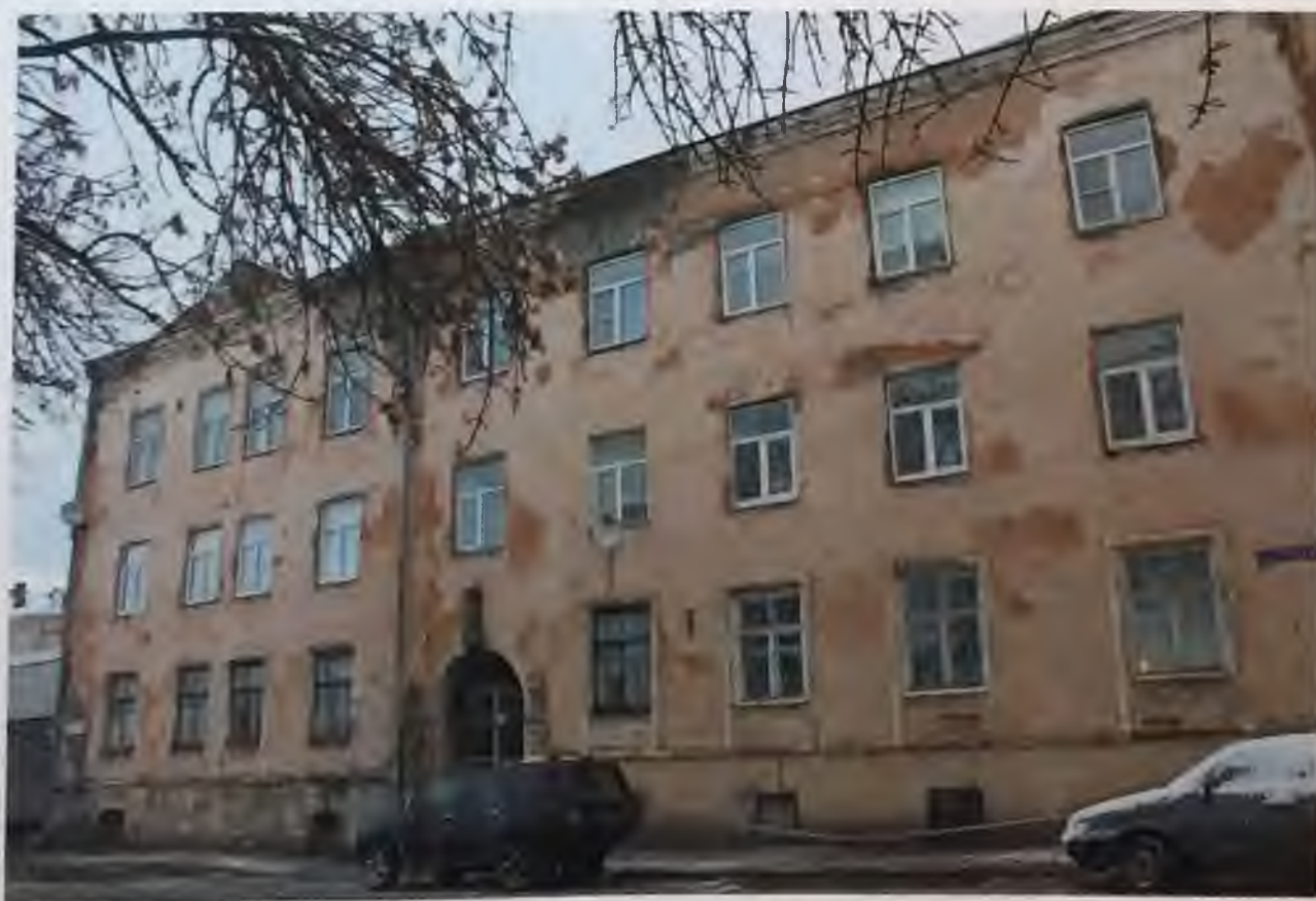
Фото 2. Западный фасад здания. Общий вид. Автор фото: Маланичева Г.И. 30.11.2016 г.
