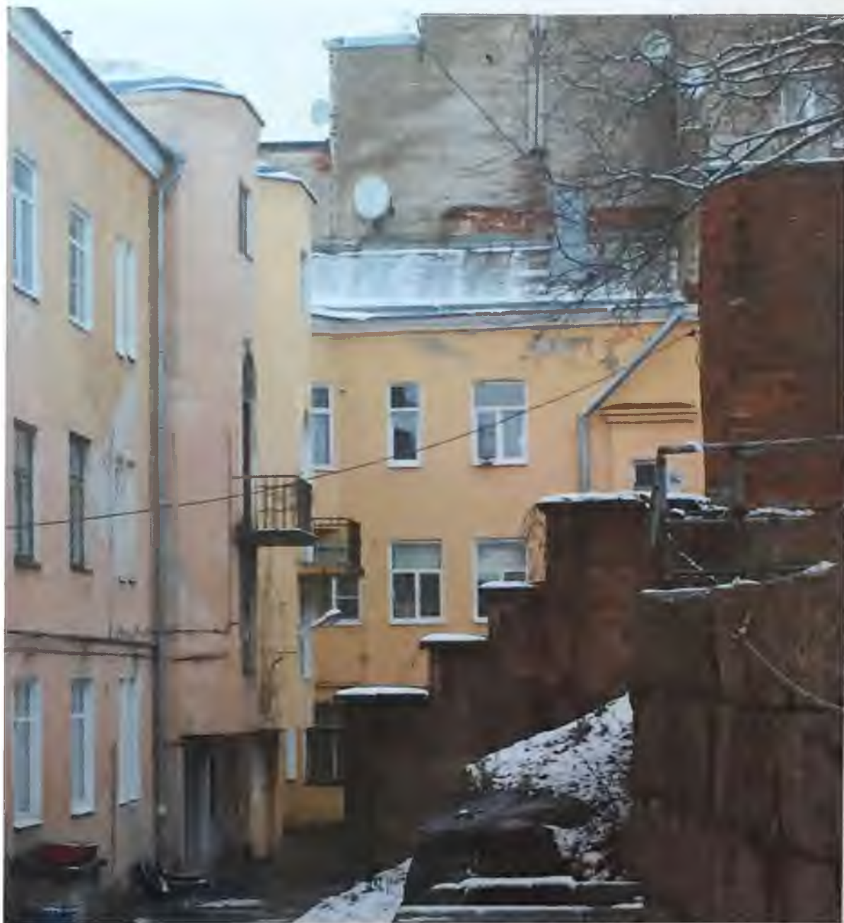
Фото 3. Восточный фасад здания. Фрагмент. Автор фото: Маланичева Г.И. 30.11.2016 г.
