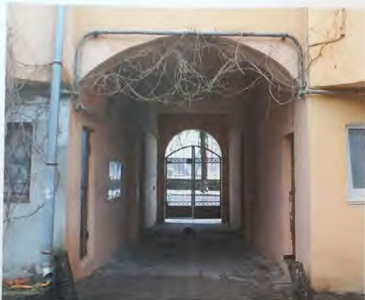
Фото 3.3. Восточный фасад здания. Фрагмент. Автор фото: Маланичева Г.И. 30.11.2016 г.
