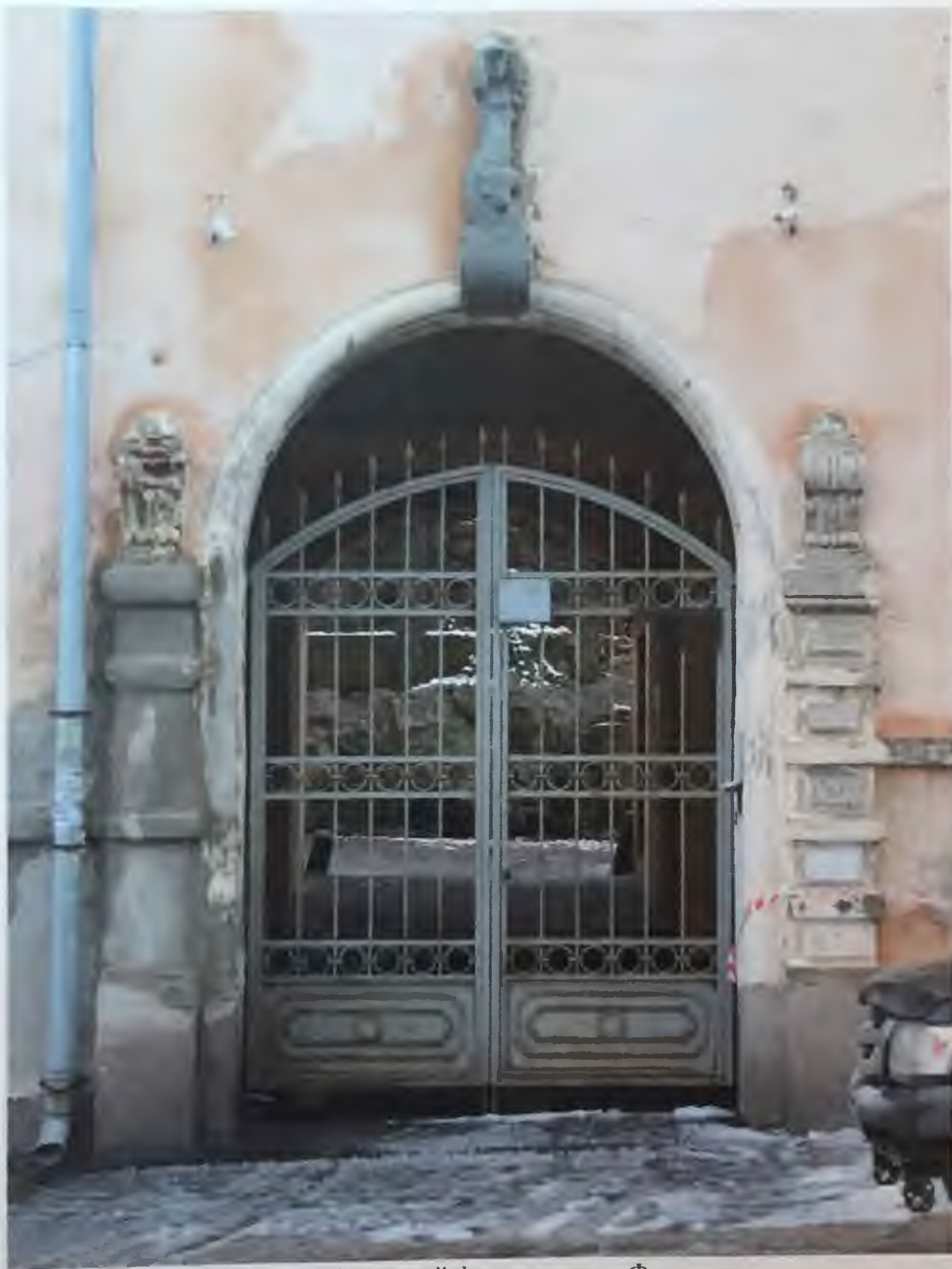
Фото 2.2. Западный фасад здания. Фрагмент. Автор фото: Маланичева Г.И. 30.11.2016 г.
