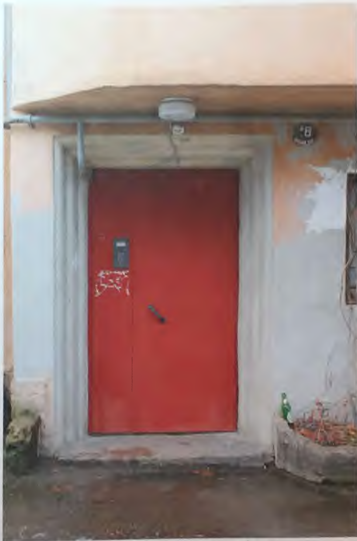
Фото 3.5. Восточний фасад здания. Фрагмент. Автор фото: Маланничева Г.Н. 30.11.2016 г.
