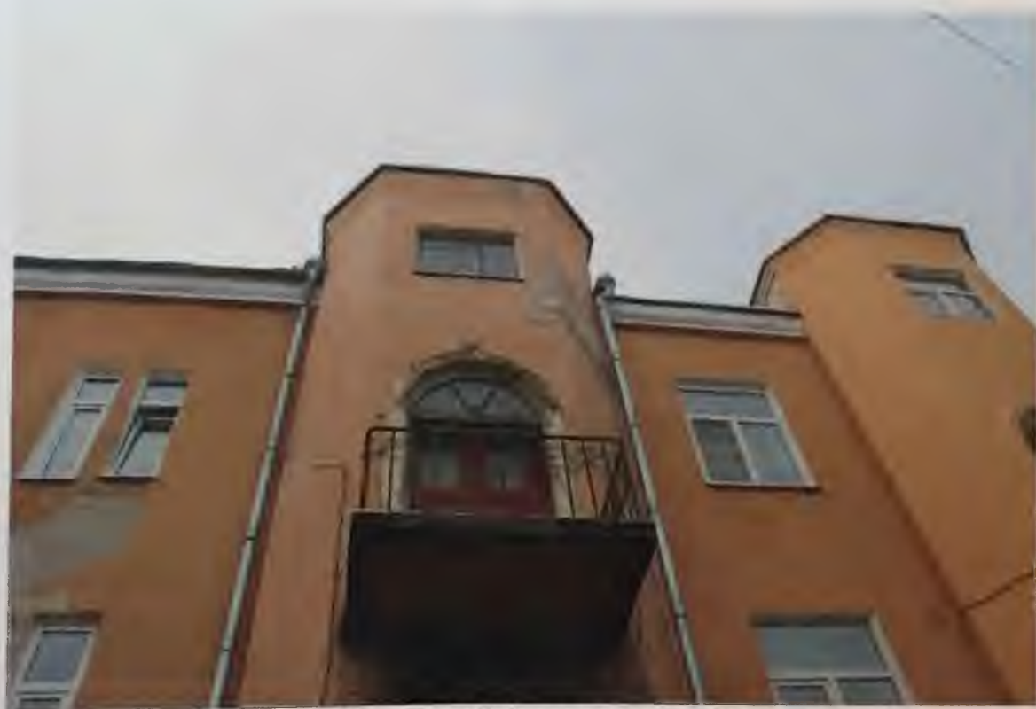
Фото 3.4. Восточный фасад здания. Фрагмент. Автор фото: Маланичева Г.И. 30.11.2016 г.
