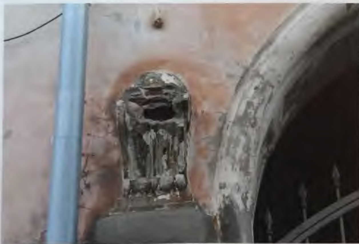
Фото. 2.4. Западный фасад здания. Фрагмент. Автор фото: Маланичева Г.И. 30.11.2016 г.
