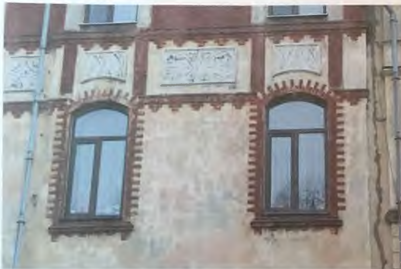
Фото 3.2. Западный фасад здания. Фрагмент. Автор фото: Маланичева Г.И. 30.11.2016 г.
