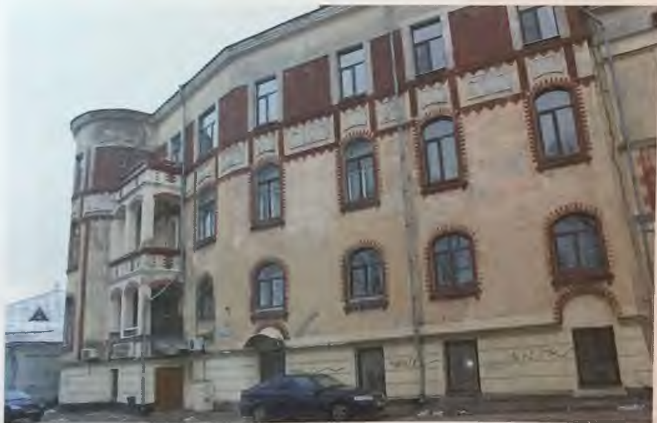
Фото 3. Западный фасад здания. Фрагмент. Автор фото: Маланичева Г.И. 30.11.2016 г.
