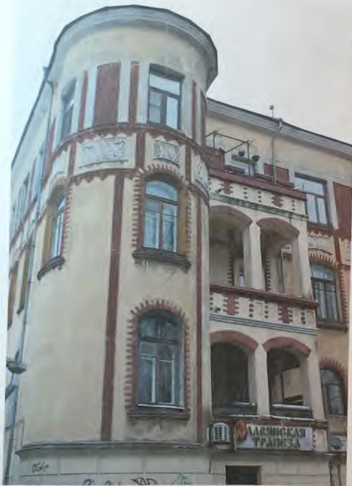
Фото 2.1. Северный и западный фасады здания Автор фото: Маланичева Г.И. 30.11.2016 г.
