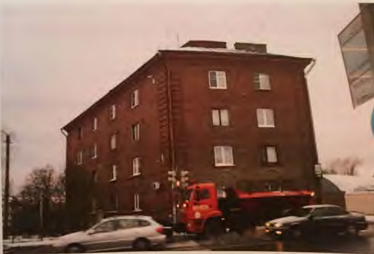
Фото 14. Общий вид здания с северо-востока. Автор фото: Маланичева Г.И. 29.11.2016 г.
