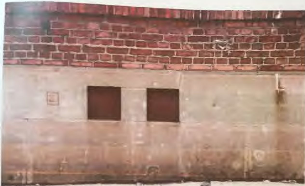
Фото 5.2. Западный фасад здания. Фрагмент Автор фото: Маланичева Г.И. 29.11.2016 г.
