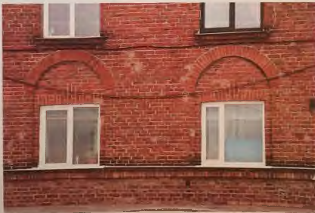
Фото 5.1. Западный фасад здания. Фрагмент Автор фото: Маланичева Г.И. 29.11.2016 г.
