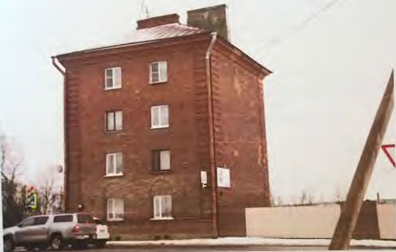
Фото 15. Общий вид здания с северо-востока. Автор фото: Маланичева Г.И. 29.11.2016 г.
