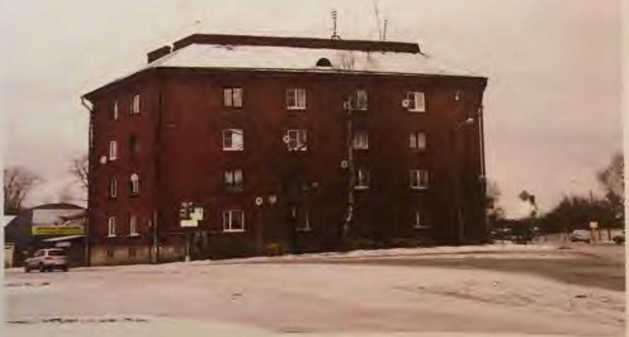
Фото 2. Юго-восточный фасад здания. Автор фото: Маланичева Г.И. 29.11.2016 г.
