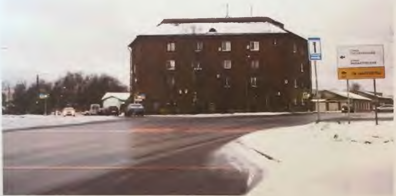
Фото 1. Общий вид здания с юго-востока. Автор фото: Маланичева Г.И. 29.11.2016 г.
