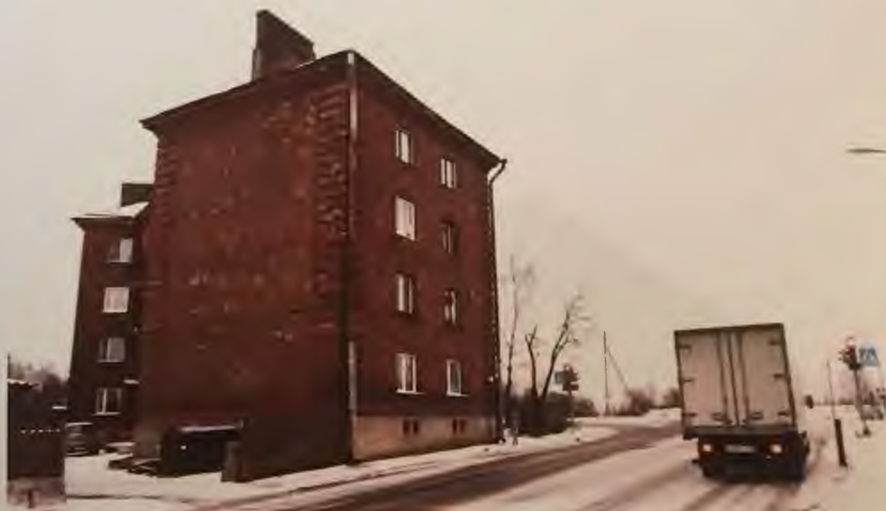
Фото 6. Западный и юго-западный фасады здания. Автор фото: Маланичева Г.И. 29.11.2016 г.
