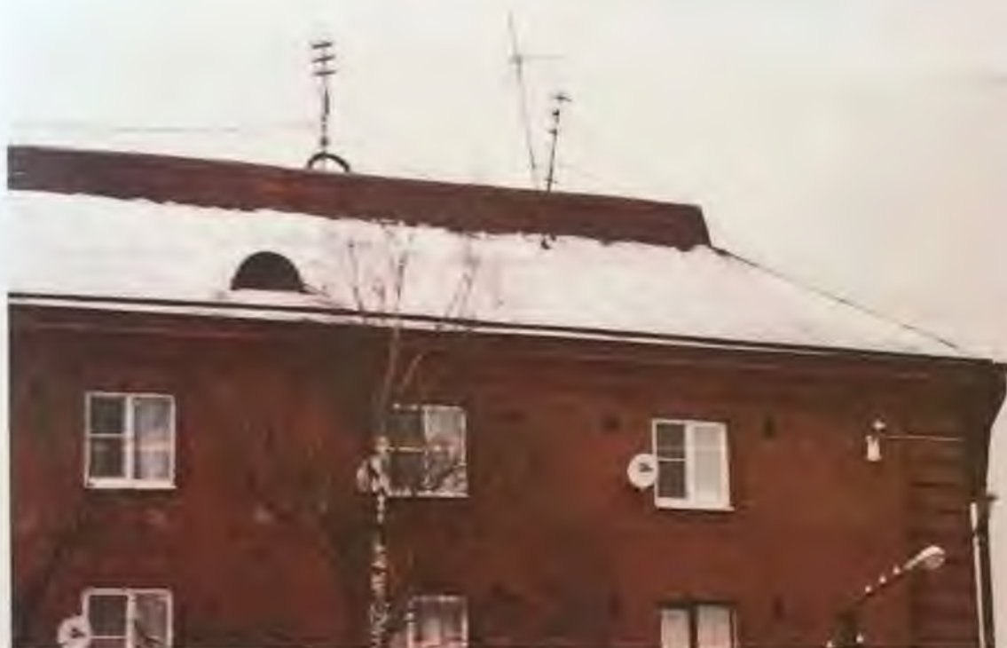
Фото 2.1. Юго-восточный фасад здания. Фрагмент. Автор фото: Маланичева Г.И. 29.11.2016 г.
