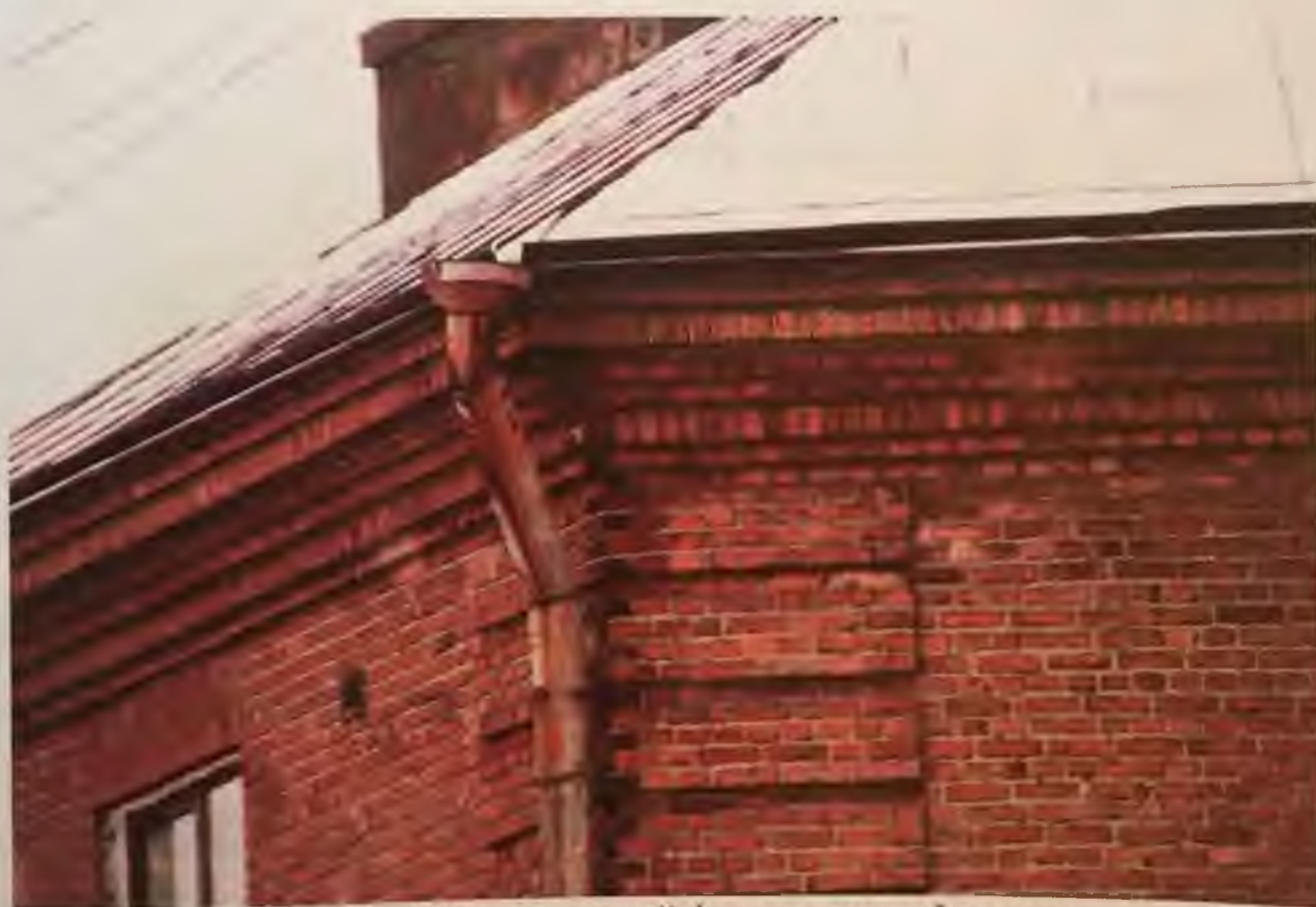
Фото 2.2. Юго-восточный фасад здания. Фрагмент. Автор фото: Маланичева Г.И. 29.11.2016 г.
