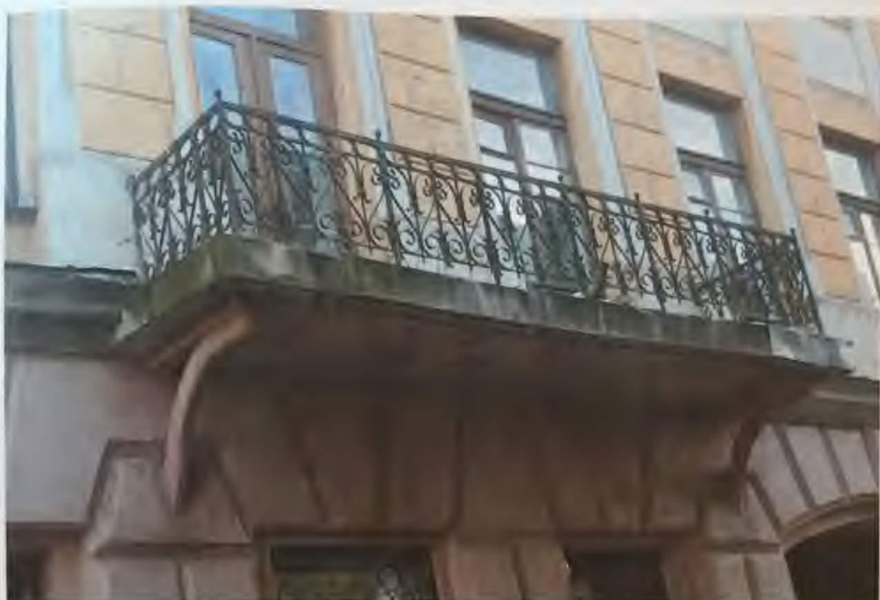
Фото 3.1. Восточный фасад здания. Фрагмент Автор фото: Маланичева Г.И. 30.11.2016 г.
