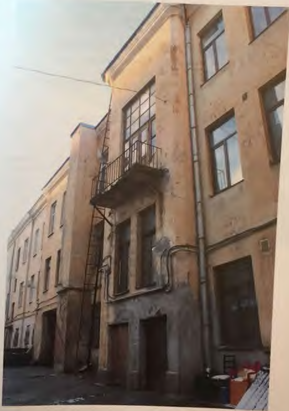
Фото 4.5. Западный фасад здания. Фрагмент. Автор фото: Маланичева Г.И. 30.11.2016 г
