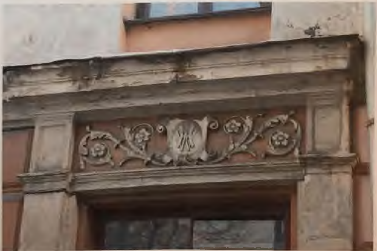
Фото 2.3. Восточный фасад здания. Фрагмент Автор фото: Маланичева Г.И. 30.11.2016 г.
