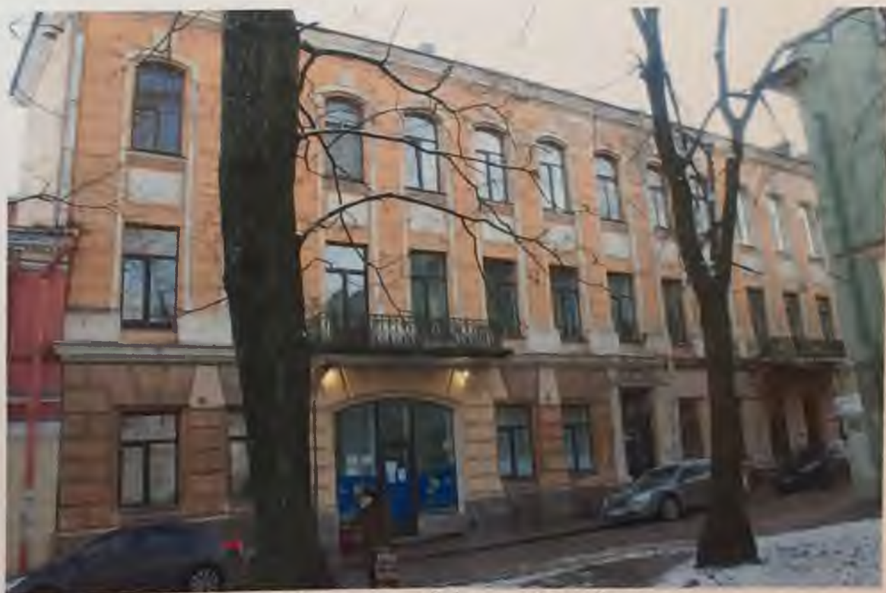
Фото 2. Восточный фасад. Общий вид. Автор фото: Маланичева Г.И. 30.11.2016 г.
