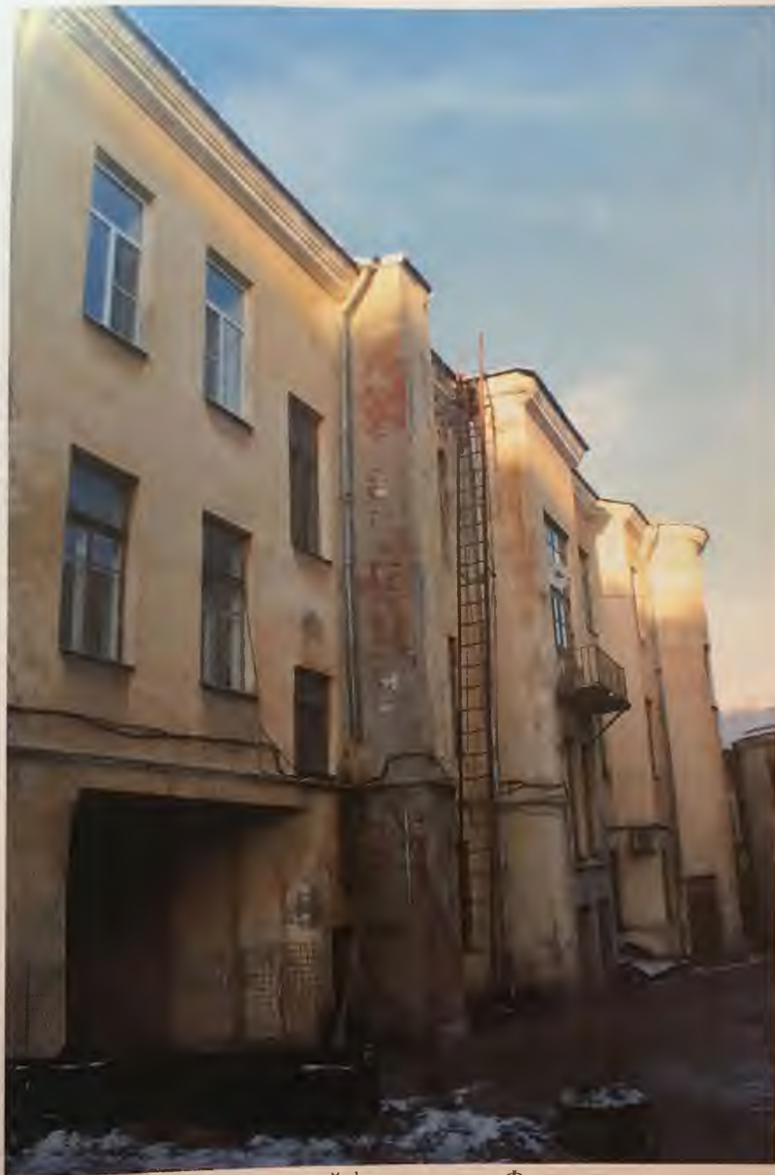
Фото 4. Западный фасад здания. Фрагмент. Автор фото: Маланичева Г.И. 30.11.2016 г.
