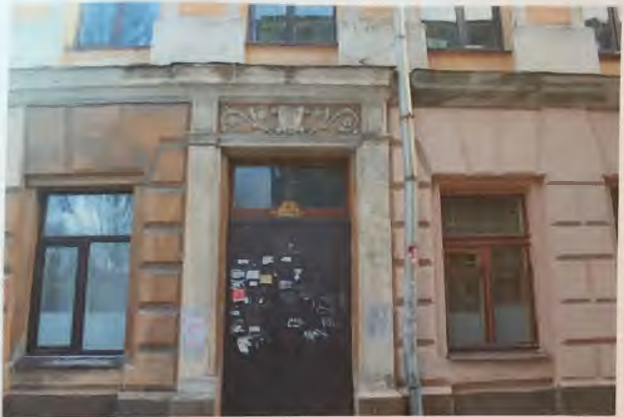
Фото 2.2. Восточный фасад здания. Фрагмент Автор фото: Маланичева Г.И. 30.11.2016 г.
