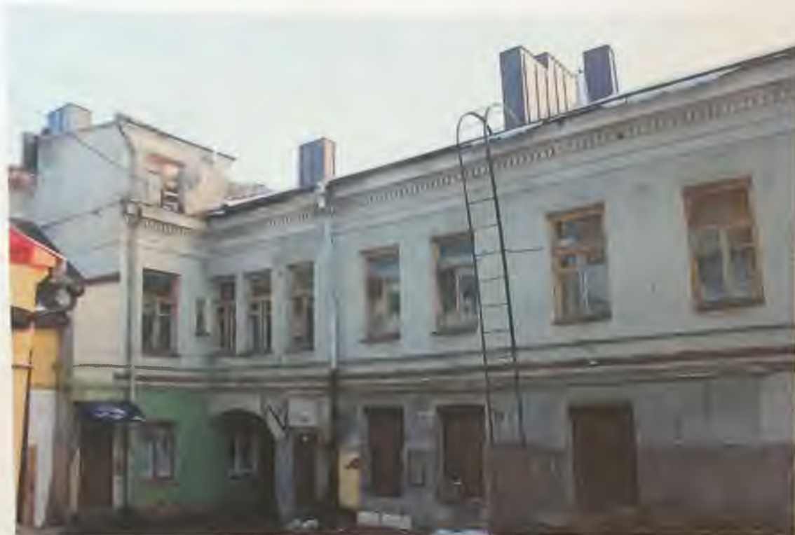
Фото 4.1. Западный фасад здания. Фрагмент. Автор фото: Маланичева Г.И. 30.11.2016 г.
