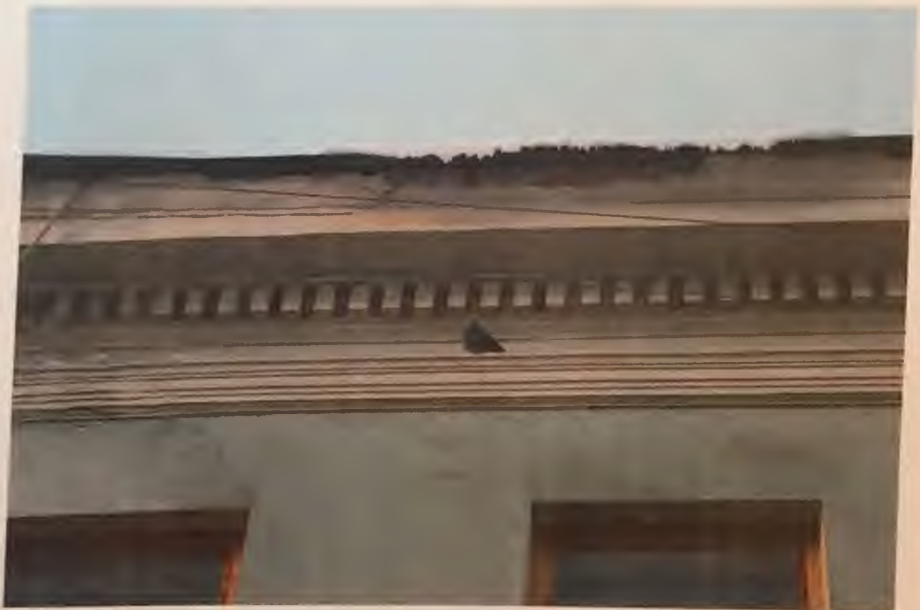
Фото 2.4. Восточный фасад здания. Фрагмент Автор фото: Маланичева Г.И. 30.11.2016 г.
