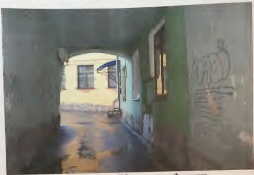
Фото 3.1. Восточный фасад здания. Фрагмент. Автор фото: Маланичева Г.И. 30.11.2016 г.
