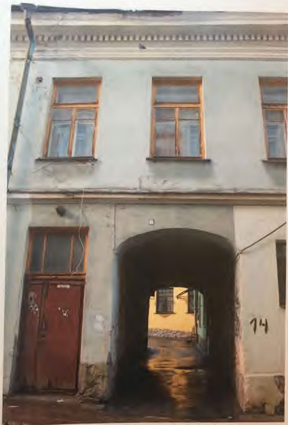
Фото 3. Восточный фасад здания. Фрагмент. Автор фото: Маланичева Г.И. 30.11.2016 г.
