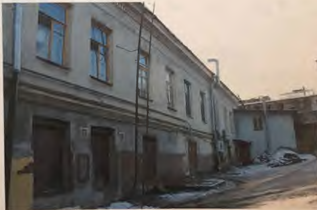
Фото 4.2. Западный фасад здания. Фрагмент. Автор фото: Маланичева Г.И. 30.11.2016 г.
