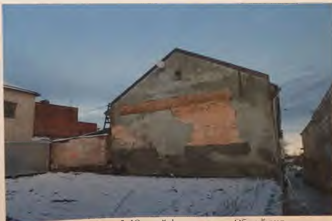
Фото 5. Южный фасад здания. Общий вид. Автор фото: Маланичева Г.И. 30.11.2016 г.
