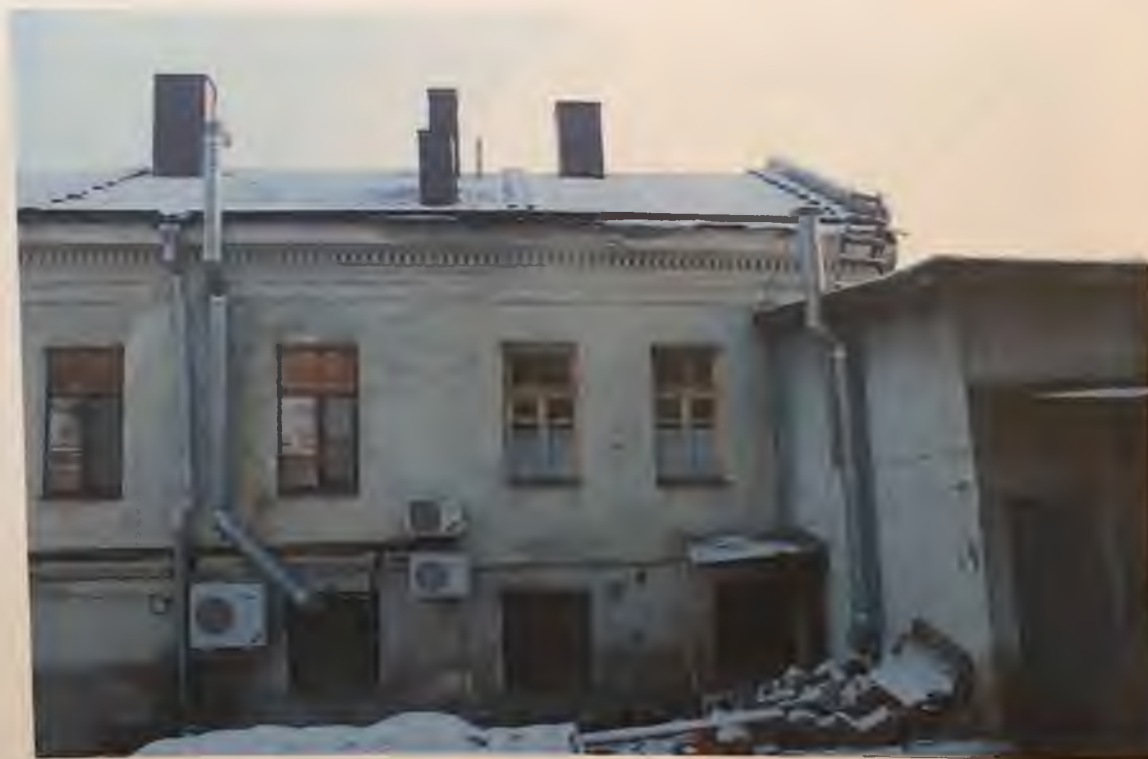
Фото 4.4. Западный фасад здания. Фрагмент. Автор фото: Маланичева Г.И. 30.11.2016 г.
