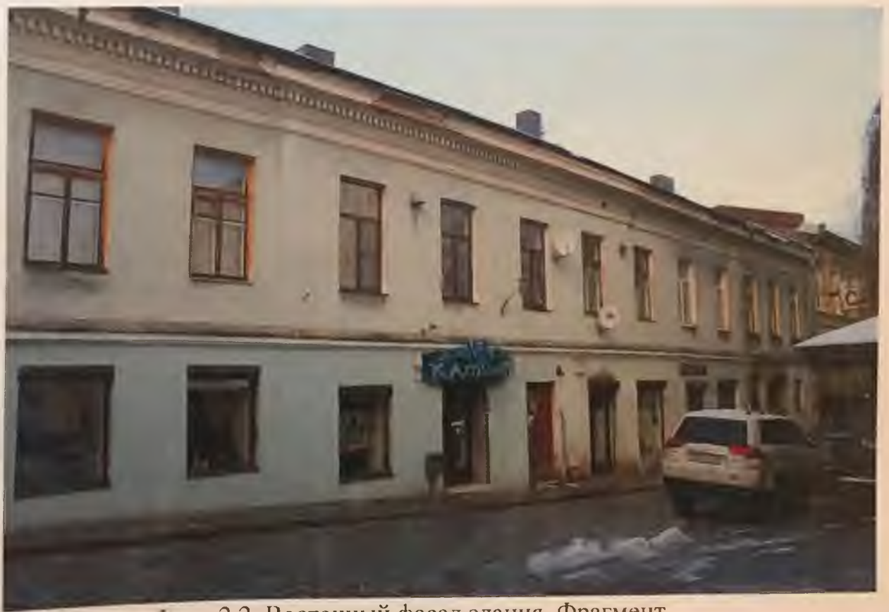
Фото 2.2. Восточный фасад здания. Фрагмент Автор фото: Маланичева Г.И. 30.11.2016 г.
