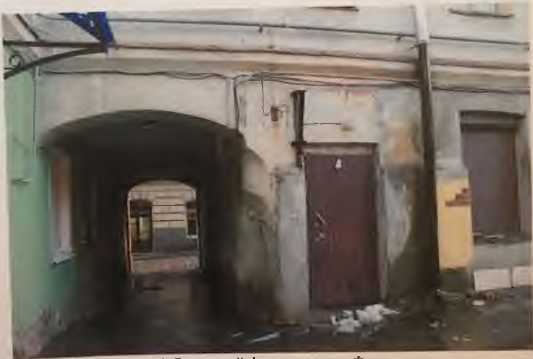
Фото 4. Западный фасад здания. Фрагмент. Автор фото: Маланичева Г.И. 30.11.2016 г.
