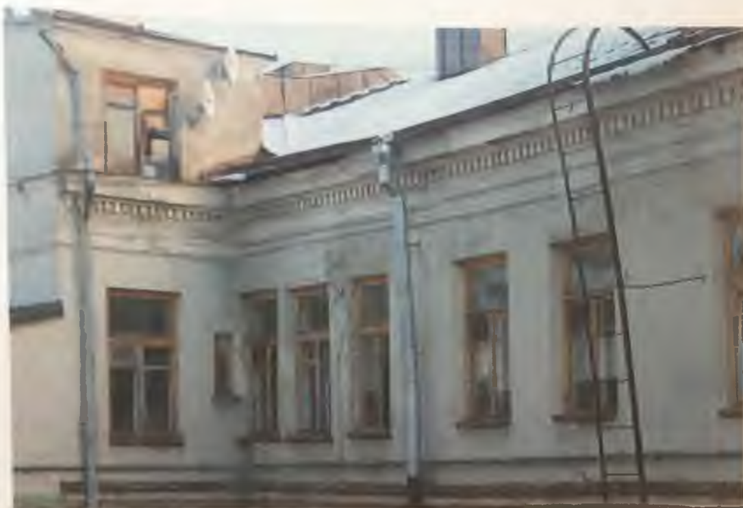
Фото 4.5. Западный фасад здания. Фрагмент. Автор фото: Маланичева Г.И. 30.11.2016 г.
