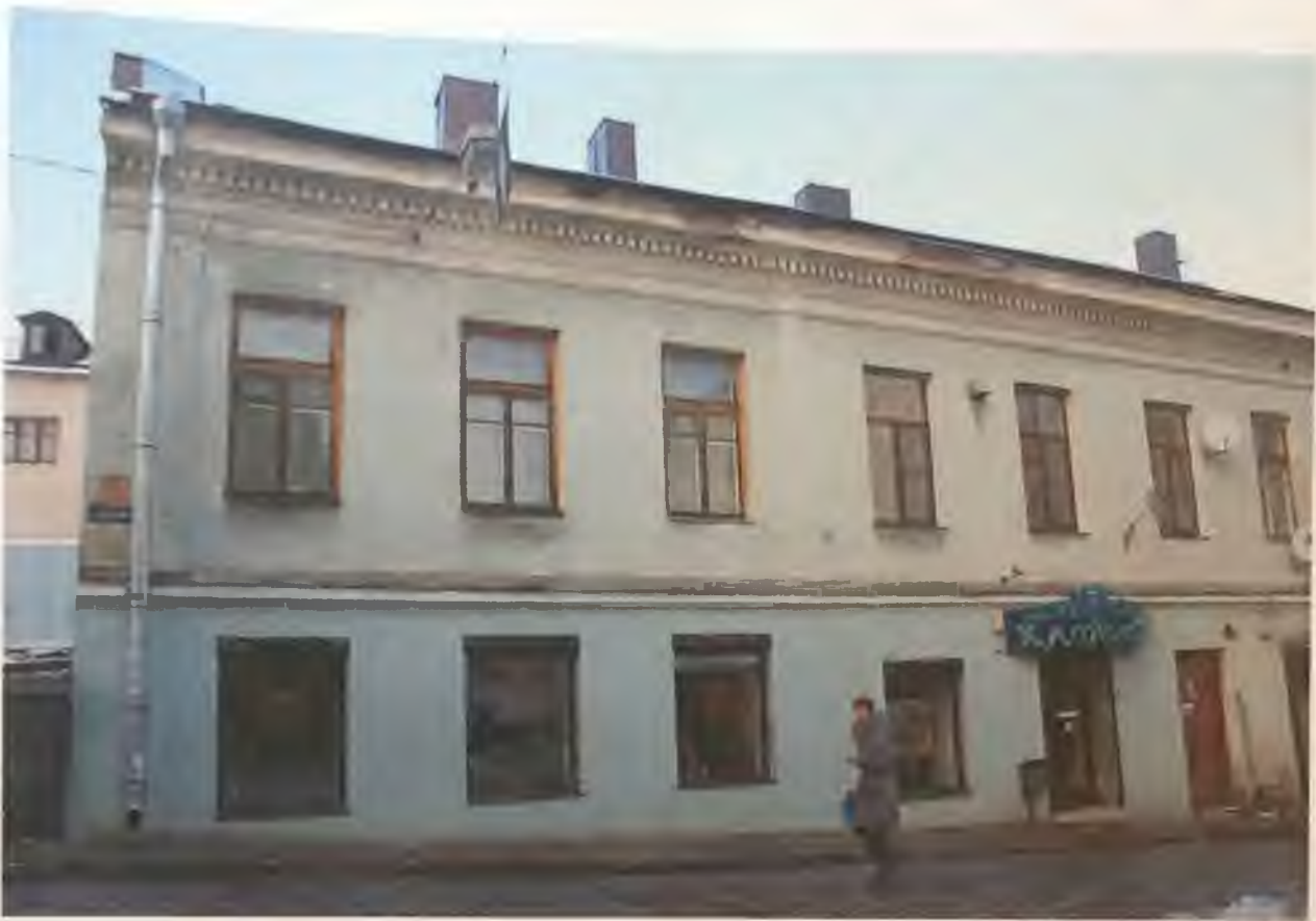
Фото 2.1. Восточный фасад здания. Фрагмент. Автор фото: Маланичева Г.И. 30.11.2016 г.
