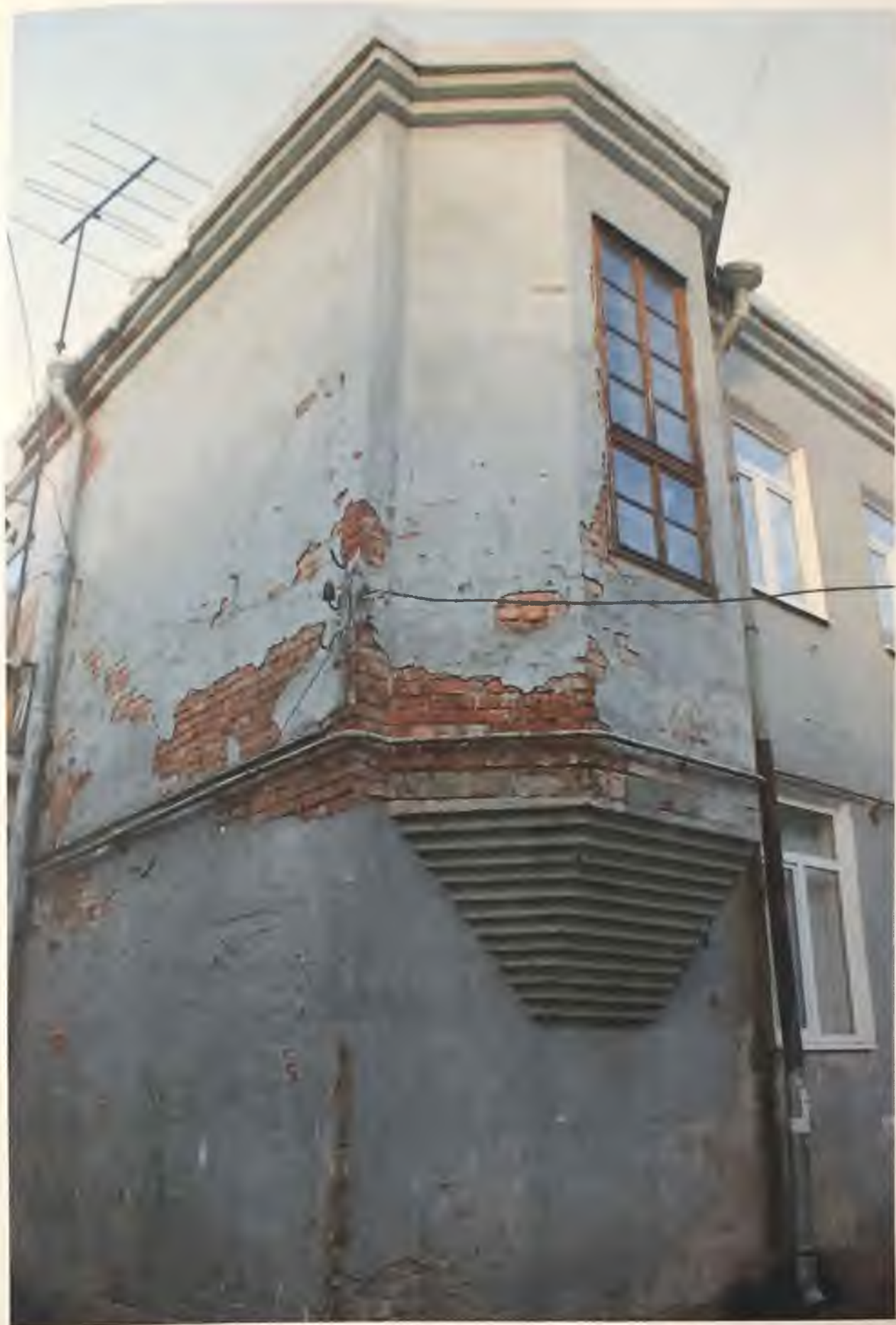
Фото 4.4. Восточный фасад здания. Фрагмент. Автор фото: Маланичева Г.И. 30.11.2016 г.
