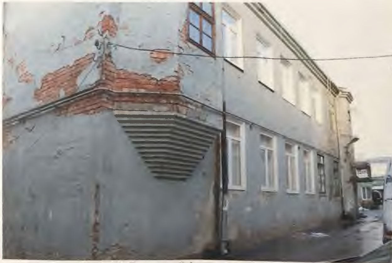
Фото 4.1. Восточный фасад здания. Фрагмент. Автор фото: Маланичева Г.И. 30.11.2016 г.
