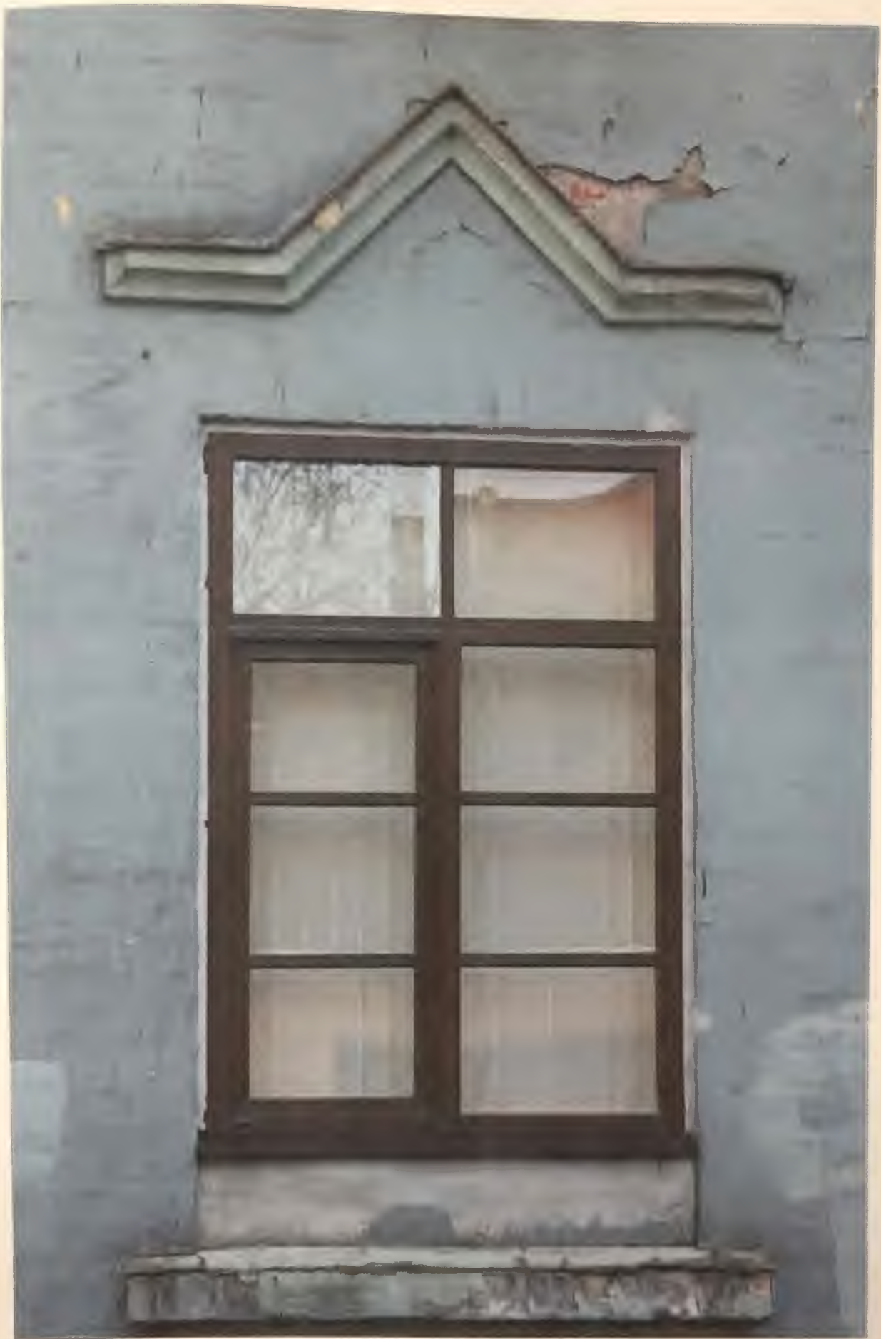
Фото 3.1. Западный фасад здания. Фрагмент. Автор фото: Маланичева Г.И. 30.11.2016 г.
