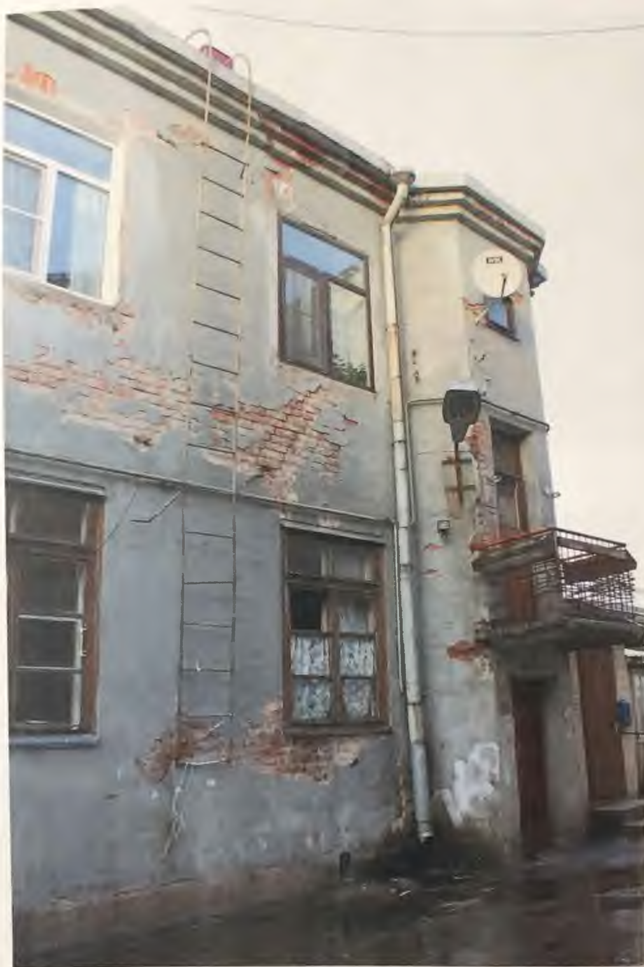
Фото 4.5. Востонный фасад здания. Фрагмент. Автор фото: Маланичева Г.И. 30.11.2016 г.
