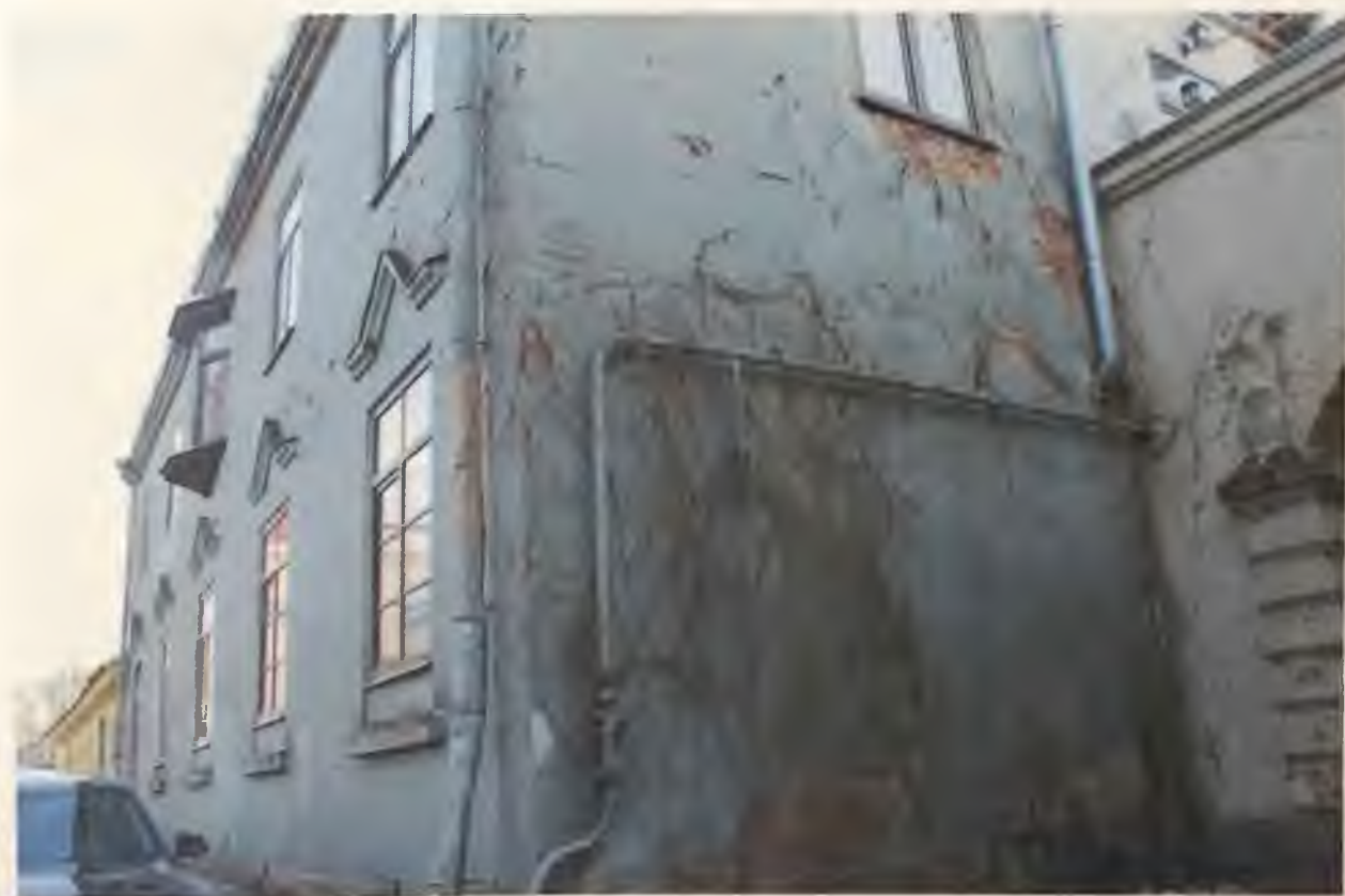
Фото 2. Южный и западный фасады здания. Фрагмент. Автор фото: Маланичева Г.И. 30.11.2016 г.
