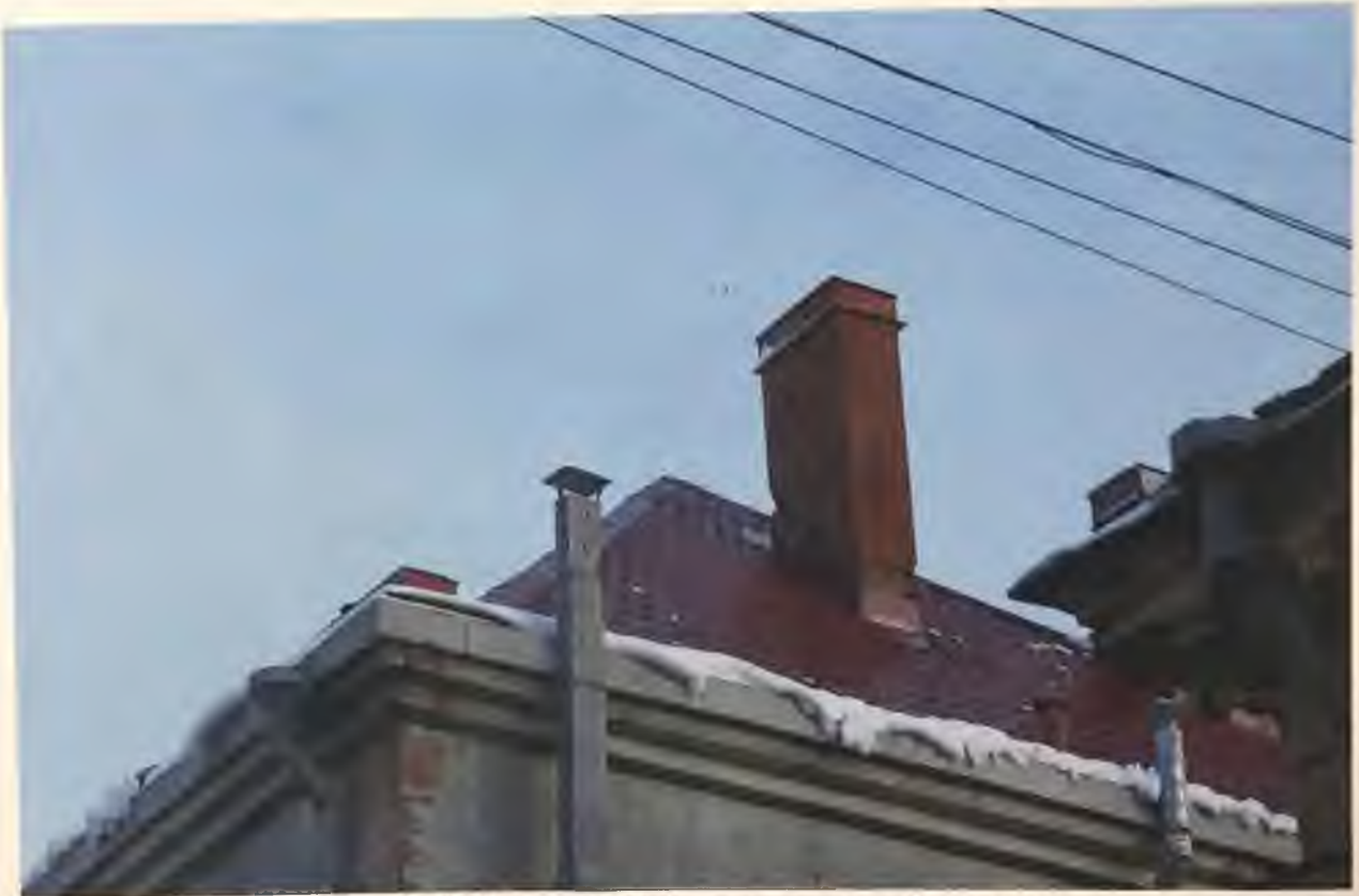
Фото 5.1. Северный фасад здания. Фрагмент. Автор фото: Маланичева Г.И. 30.11.2016 г.
