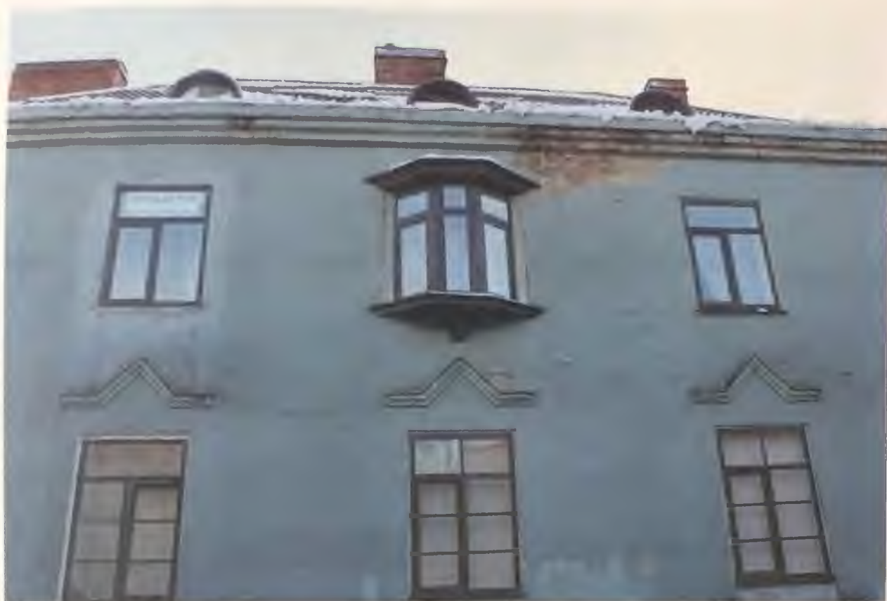
Фото 3. Западный фасад здания. Фрагмент. Автор фото: Маланичева Г.И. 30.11.2016 г.
