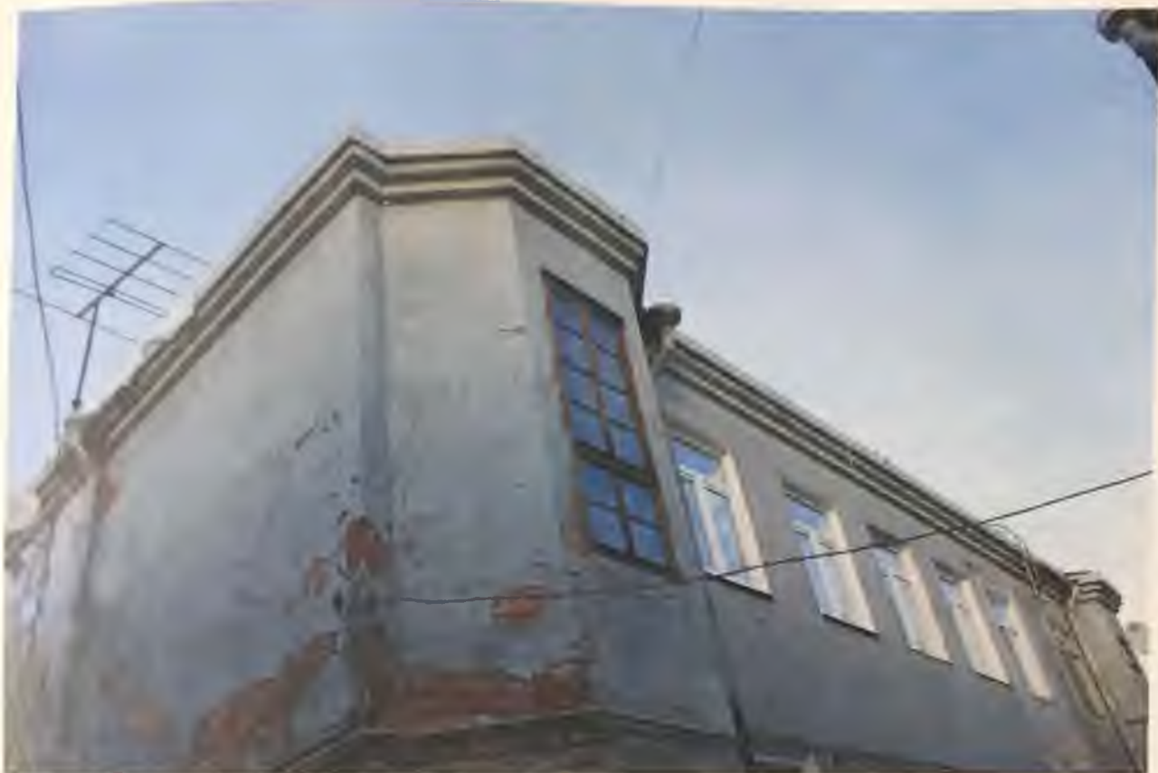
Фото 4.2. Восточный фасад здания. Фрагмент. Автор фото: Маланичева Г.И. 30.11.2016 г.
