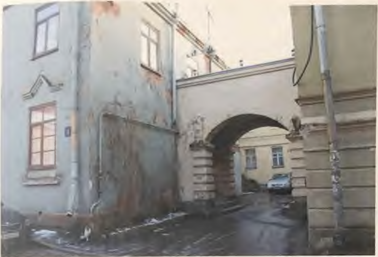
Фото 2.1. Южный и западный фасады здания. Фрагмент. Автор фото: Маланичева Г.И. 30.11.2016 г.
