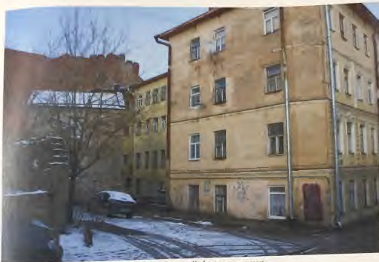
Фото 19. Южный фасад здания. Автор фото: Маланичева Г.И. 30.11.2016 г.
