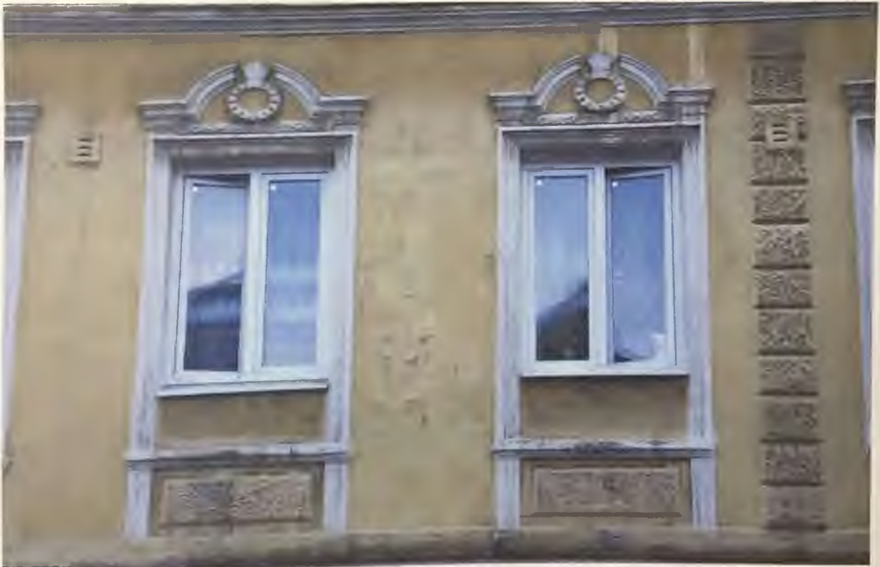
Фото 9.1. Северный фасад здания. Фрагмент Автор фото: Маланичева Г.И. 30.11.2016 г.
