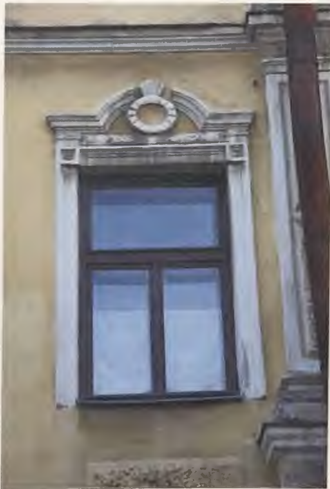
Фото 9.7. Северный фасад здания. Фрагмент Автор фото: Маланичева Г.И. 30.11.2016 г.
