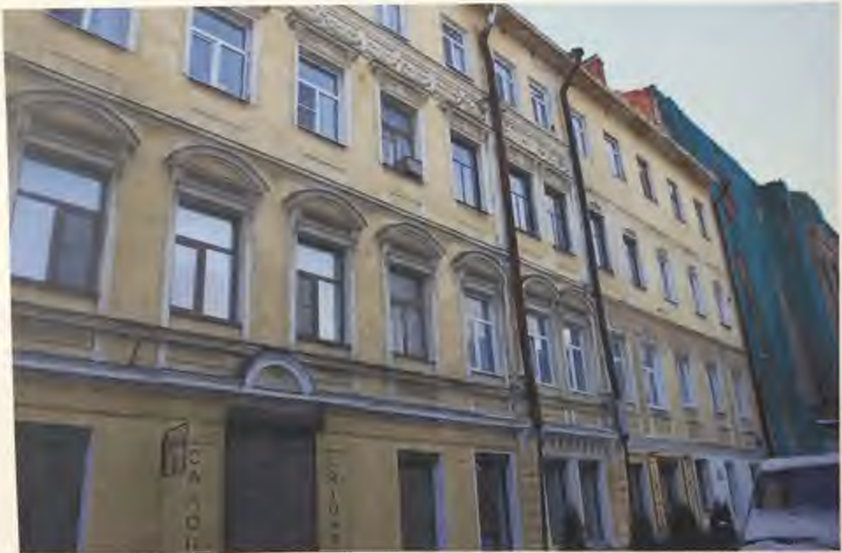
Фото 8. Северный фасад здания. Фрагмент Автор фото: Маланичева Г.И. 30.11.2016 г.
