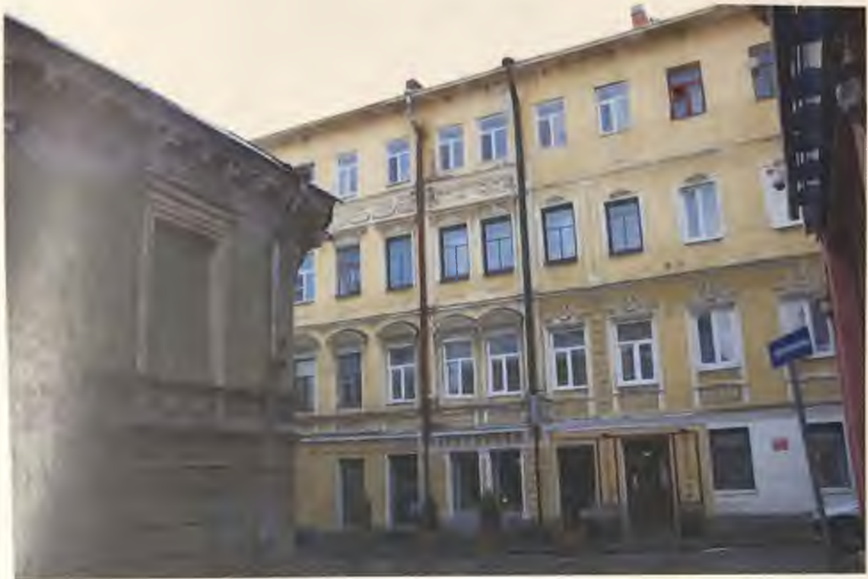
Фото 7. Северный фасад здания. Фрагмент Автор фото: Маланичева Г.И. 30.11.2016 г.
