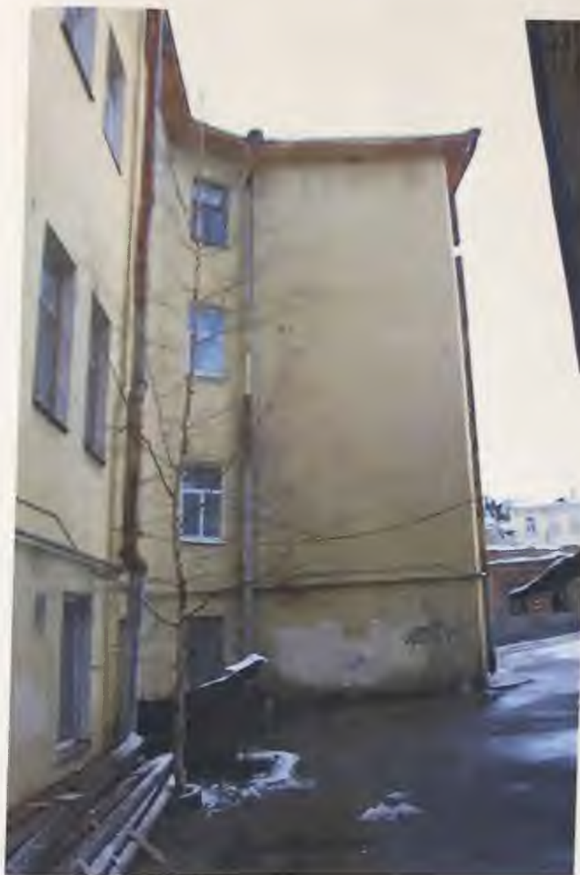
Фото 23. Южный фасад здания. Автор фото: Маланичева Г.И. 30.11.2016 г.
