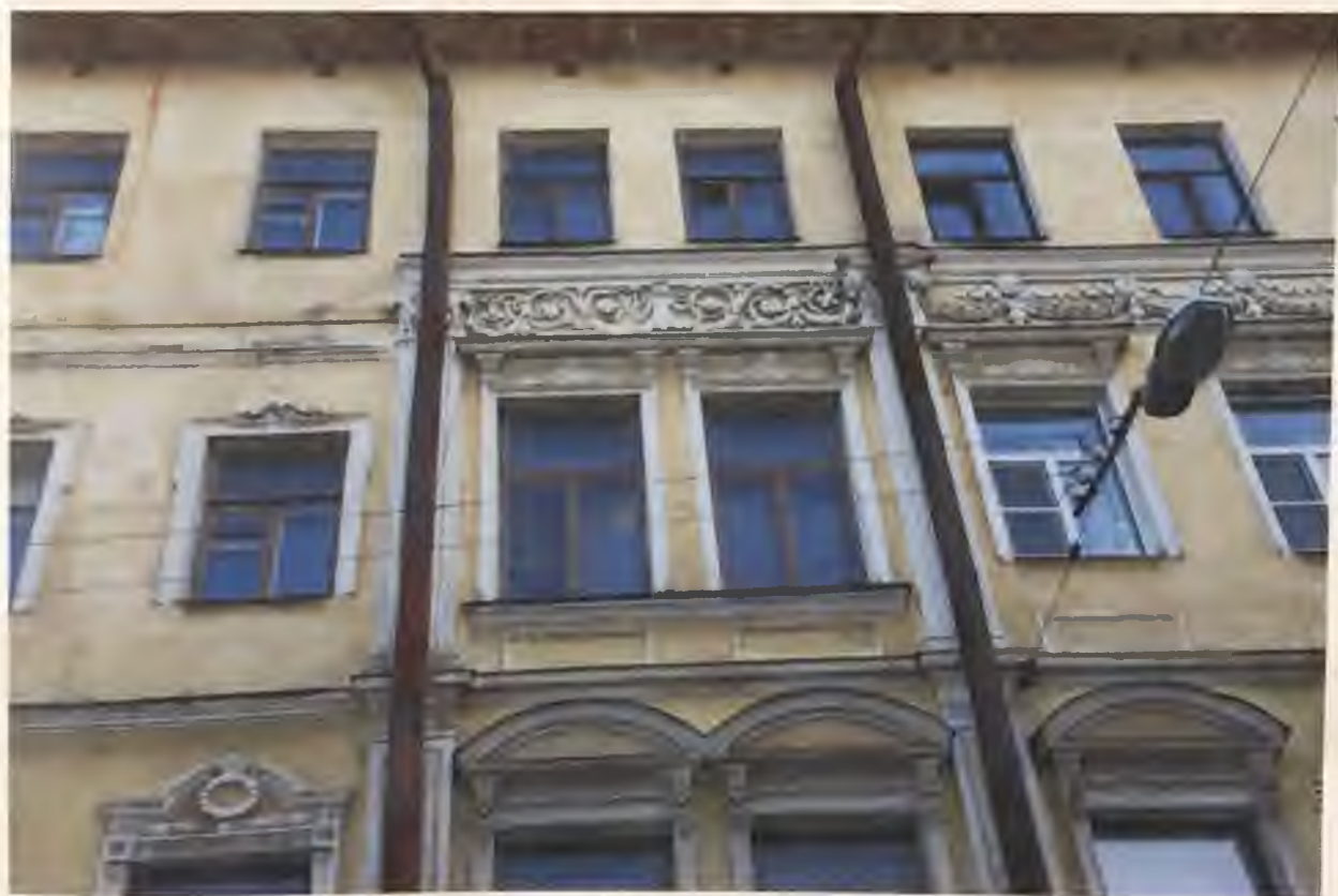
Фото 11. Северный фасад здания. Фрагмент Автор фото: Маланичева Г.И. 30.11.2016 г.
