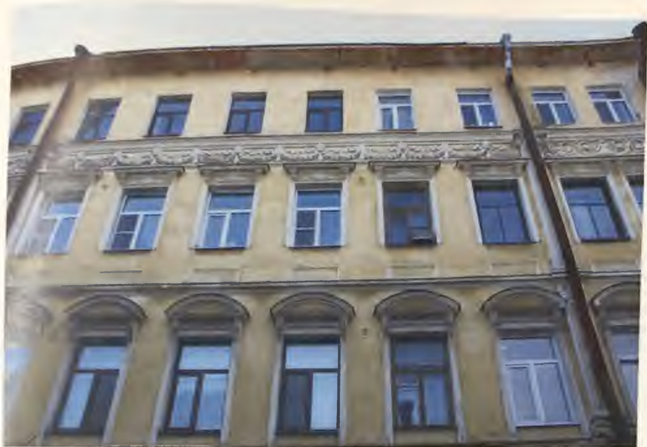
Фото 10. Северный фасад здания. Фрагмент Автор фото: Маланичева Г.И. 30.11.2016 г.
