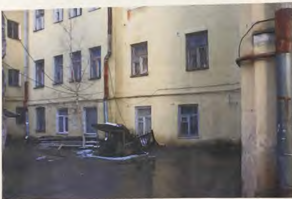
Фото 22. Южный фасад здания. Автор фото: Маланичева Г.И. 30.11.2016 г.
