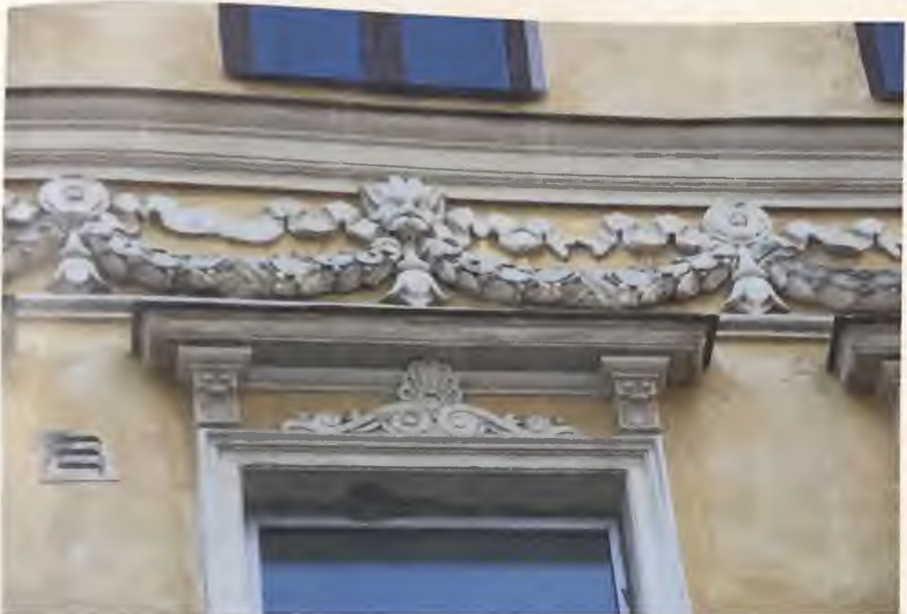
Фото 9.4. Северный фасад здания. Фрагмент Автор фото: Маланичева Г.И. 30.11.2016 г.
