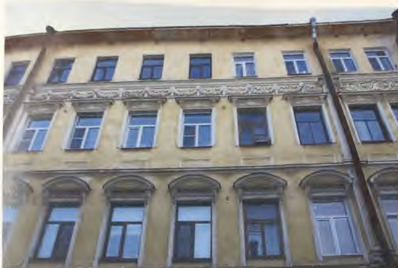
Фото 10. Северный фасад здания. Фрагмент Автор фото: Маланичева Г.И. 30.11.2016 г.
