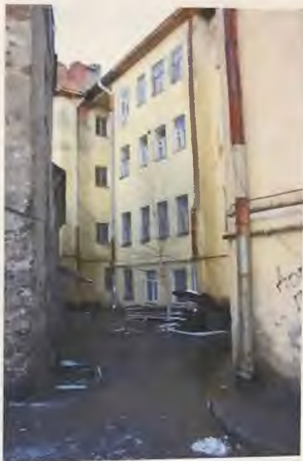
Фото 21. Южный фасад здания. Автор фото: Маланичева Г.И. 30.11.2016 г.
