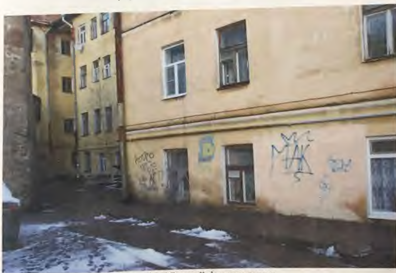
Фото 20. Южный фасад здания. Автор фото: Маланичева Г.И. 30.11.2016 г.
