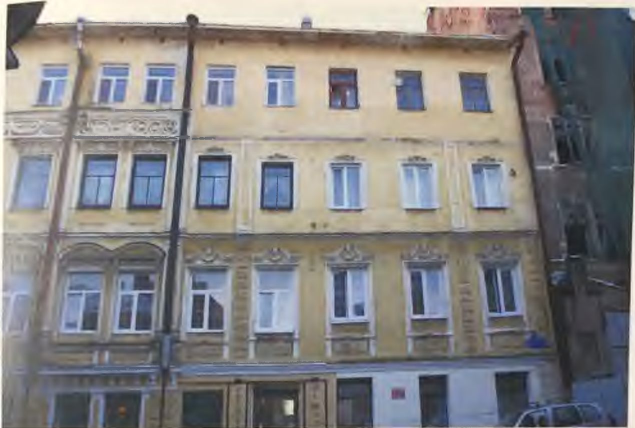
Фото 5. Северный фасад здания. Фрагмент Автор фото: Маланичева Г.И. 30.11.2016 г.
