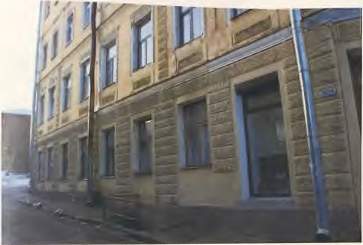
Фото 17. Восточный фасад здания. Автор фото: Маланичева Г.И. 30.11.2016 г.
