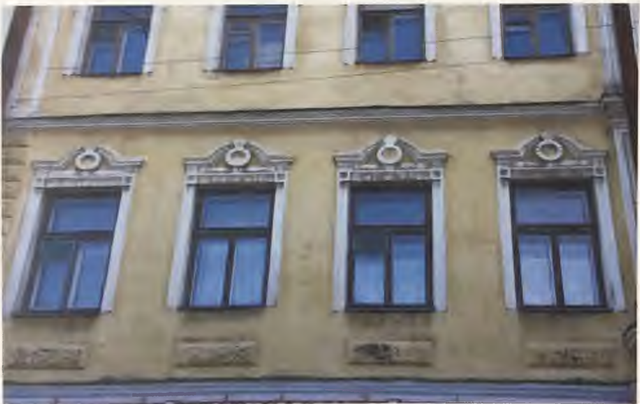
Фото 9.5. Северный фасад здания. Фрагмент Автор фото: Маланичева Г.И. 30.11.2016 г.
