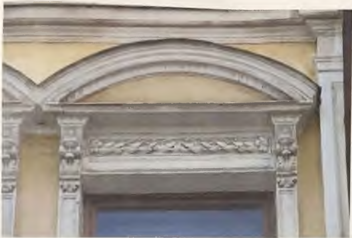
Фото 9.6. Северный фасад здания. Фрагмент Автор фото: Маланичева Г.И. 30.11.2016 г.
