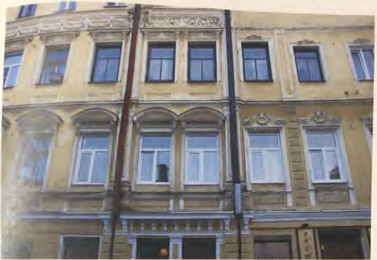
Фото 9. Северный фасад здания. Фрагмент Автор фото: Маланичева Г.И. 30.11.2016 г.
