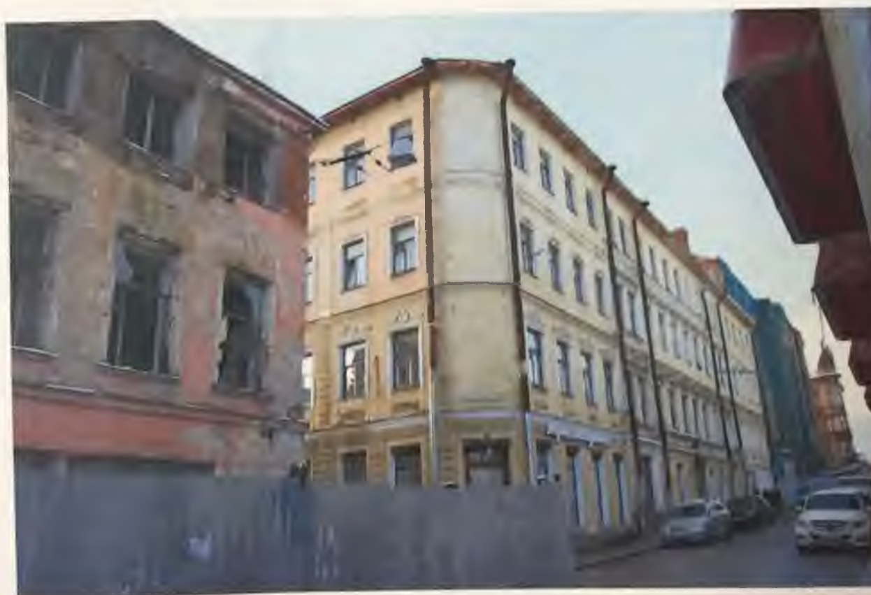
Фото 2. Общий вид здания с северо-востока. Автор фото: Маланичева Г.И. 30.11.2016 г.
