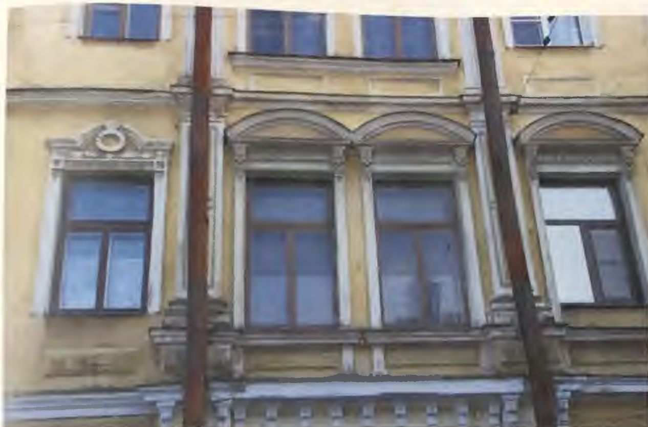
Фото 11.1. Северный фасад здания. Фрагмент Автор фото: Маланичева Г.И. 30.11.2016 г.
