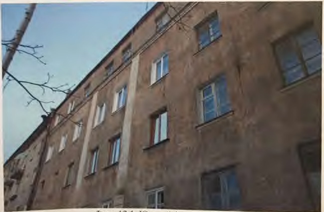
Фото 12.1. Южный фасад здания. Автор фото: Маланичева Г.И. 30.11.2016 г.
