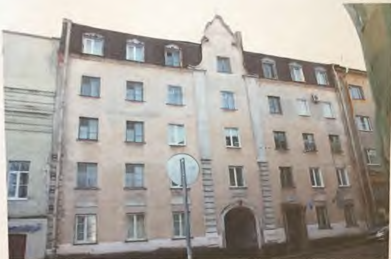
Фото 3. Главный северный фасад здания. Автор фото: Маланичева Г.И. 30.11.2016 г.
