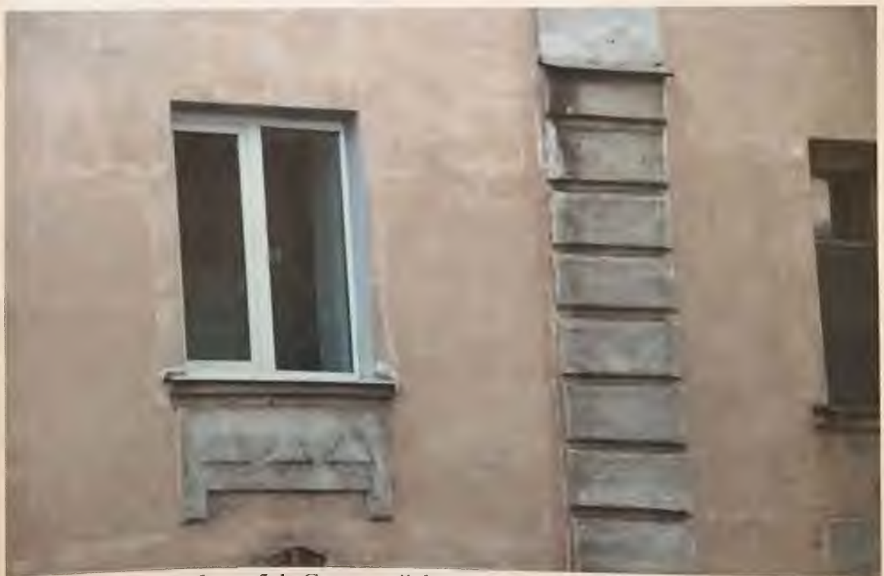
Фото 5.1. Северный фасад здания. Фрагмент. Автор фото: Маланичева Г.И. 30.11.2016 г.
