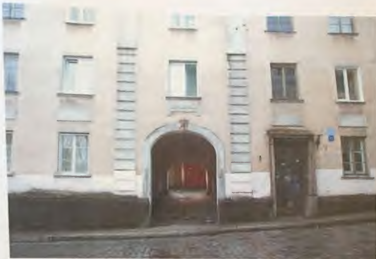
Фото 6. Северный фасад здания. Проездная арка. Автор фото: Маланичева Г.И. 30.11.2016 г.
