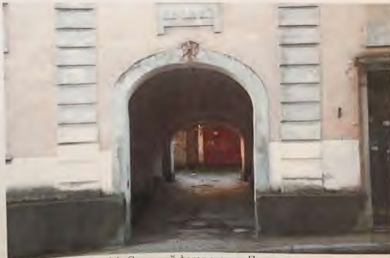
Фото 6.1. Северный фасад здания. Проездная арка. Автор фото: Маланичева Г.И. 30.11.2016 г.
