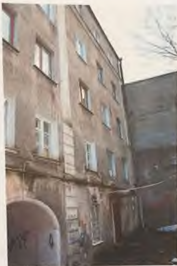
Фото 10. Южный фасад здания. Автор фото: Маланичева Г.И. 30.11.2016 г.
