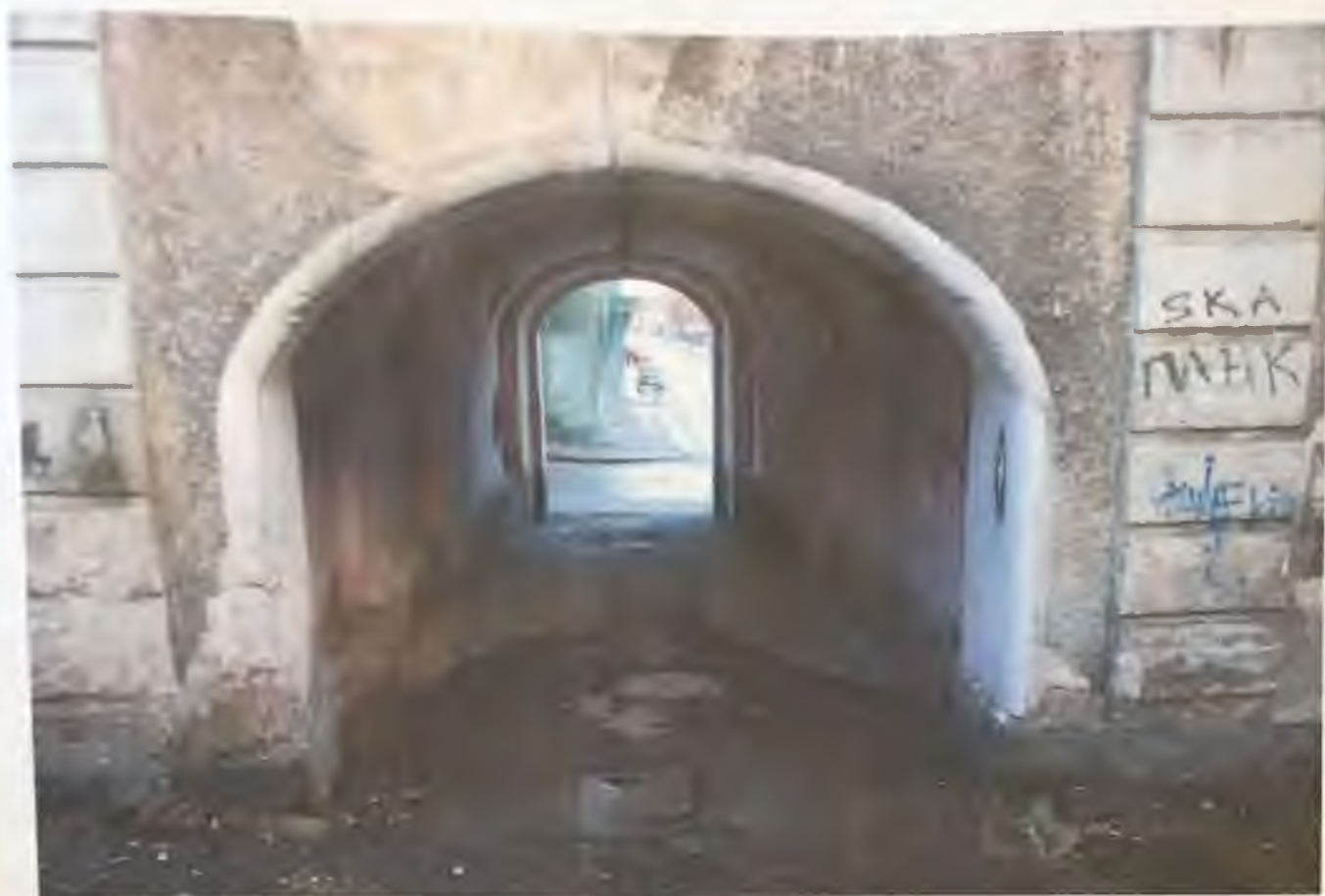
Фото 13. Южный фасад здания. Автор фото: Маланичева Г.И. 30.11.2016 г.
