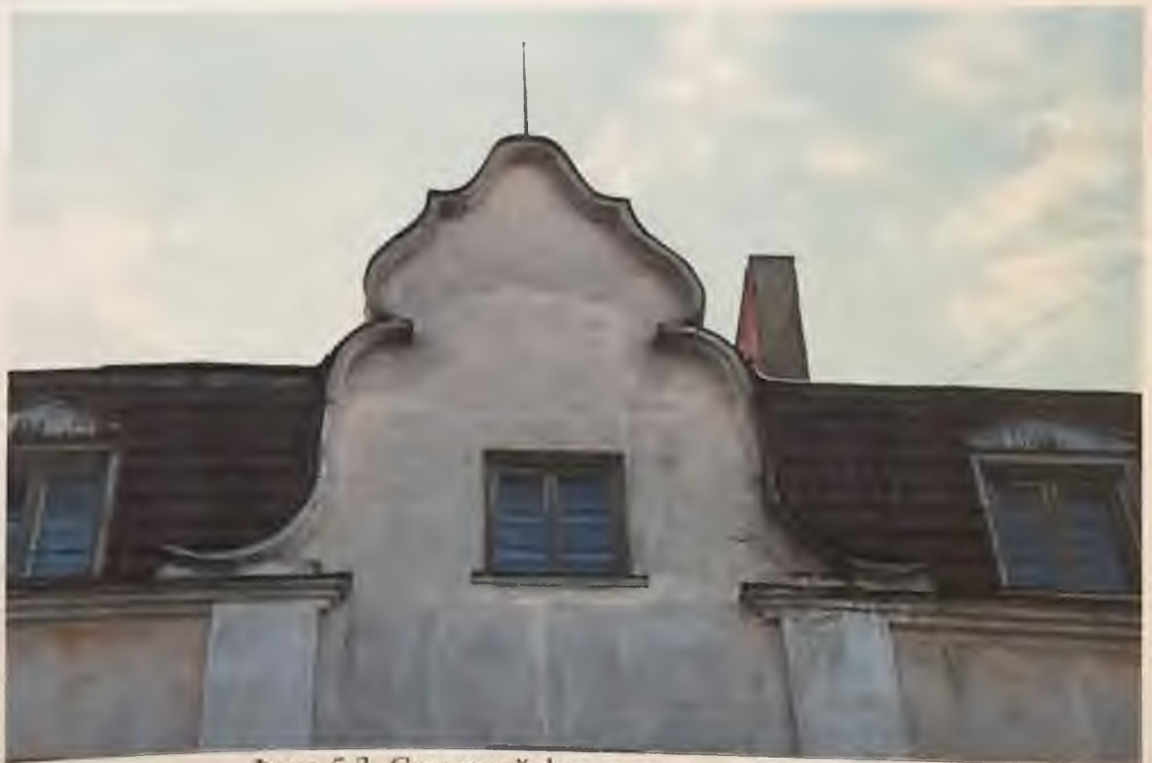
Фото 5.3. Северный фасад здания. Фрагмент. Автор фото: Маланичева Г.И. 30.11.2016 г.
