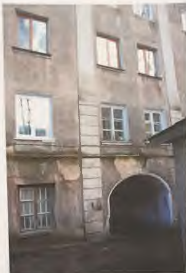
Фото 8. Южный фасад здания. Автор фото: Маланичева Г.И. 30.11.2016 г.
