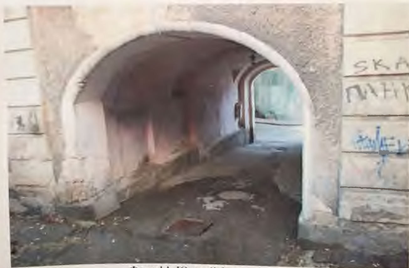
Фото 14. Южный фасад здания. Автор фото: Маланичева Г.И. 30.11.2016 г.
