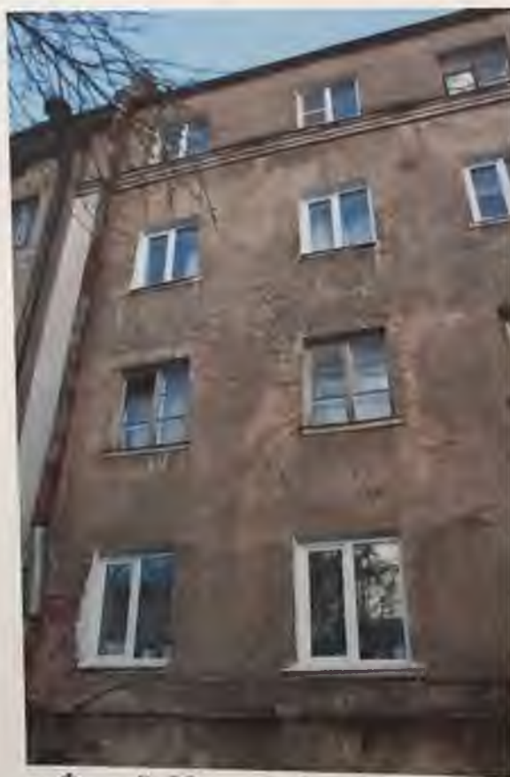
Фото 9. Южный фасад здания. Автор фото: Маланичева Г.И. 30.11.2016 г.
