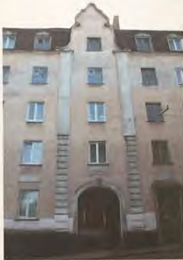
Фото 5. Северный фасад здания. Автор фото: Маланичева Г.И. 30.11.2016 г.
