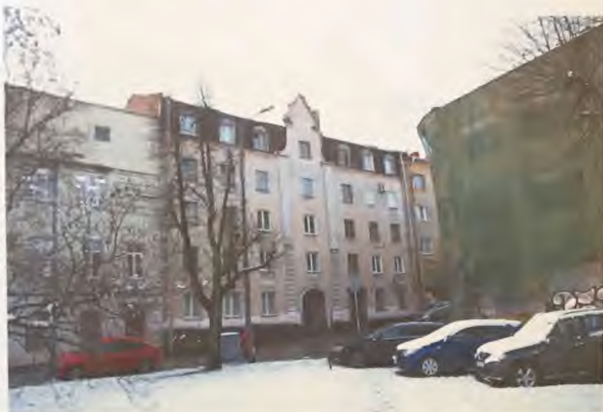
Фото 1. Общий вид здания с северо-востока. Автор фото: Маланичева Г.И. 30.11.2016 г.
