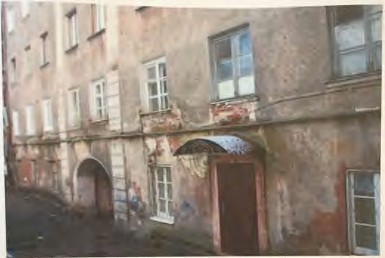
Фото 12. Южный фасад здания. Автор фото: Маланичева Г.И. 30.11.2016 г.
