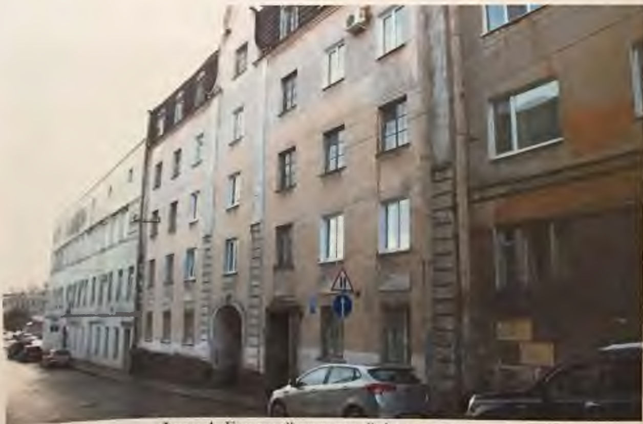
Фото 4. Главный северный фасад здания. Автор фото: Маланичева Г.И. 30.11.2016 г.
