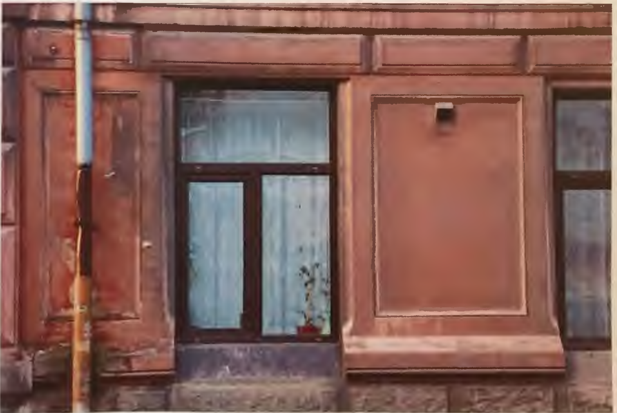
Фото 5.5. Фрагмент восточного фасада здания. Автор фото: Маланичева Г.И. 30.11.2016 г.
