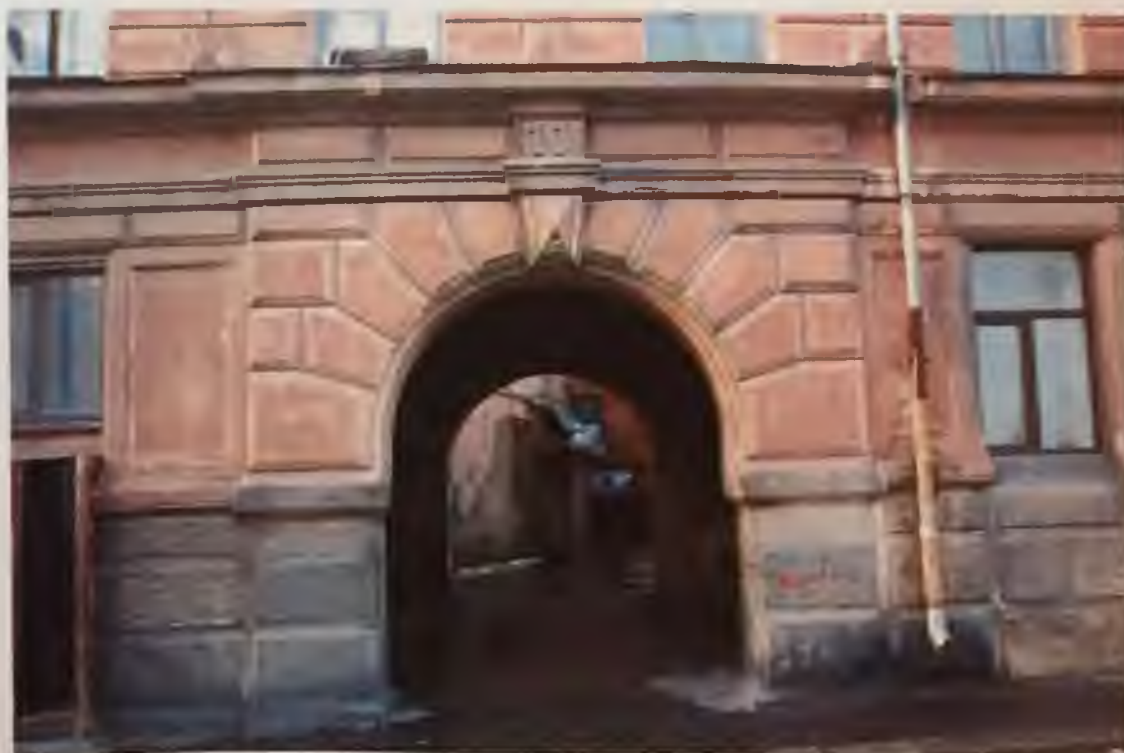
Фото 7. Фрагмент восточного фасада здания. Арка. Автор фото: Маланичева Г.И. 30.11.2016 г.
