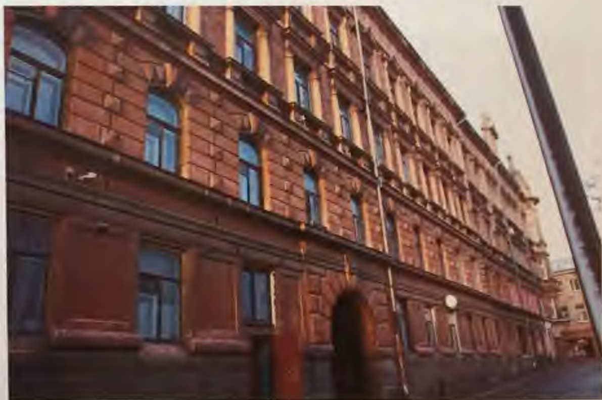
Фото 8. Фрагмент восточного фасада здания. Автор фото: Маланичева Г.И. 30.11.2016 г.
