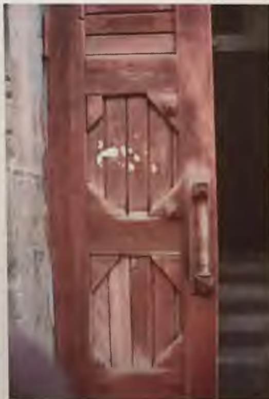
Фото 6.1. Фрагмент восточного фасада здания. Вход. Автор фото: Маланичева Г.И. 30.11.2016 г.
