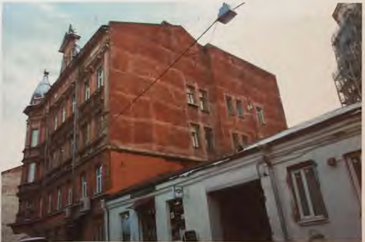
Фото 15. Вид на здание с северо-запада. Автор фото: Маланичева Г.И. 30.11.2016 г.
