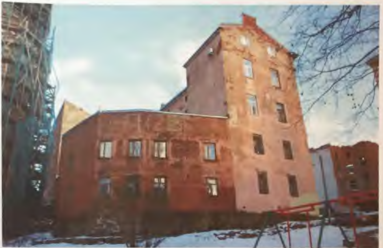
Фото 18. Южный фасад здания. Автор фото: Маланичева Г.И. 30.11.2016 г.
