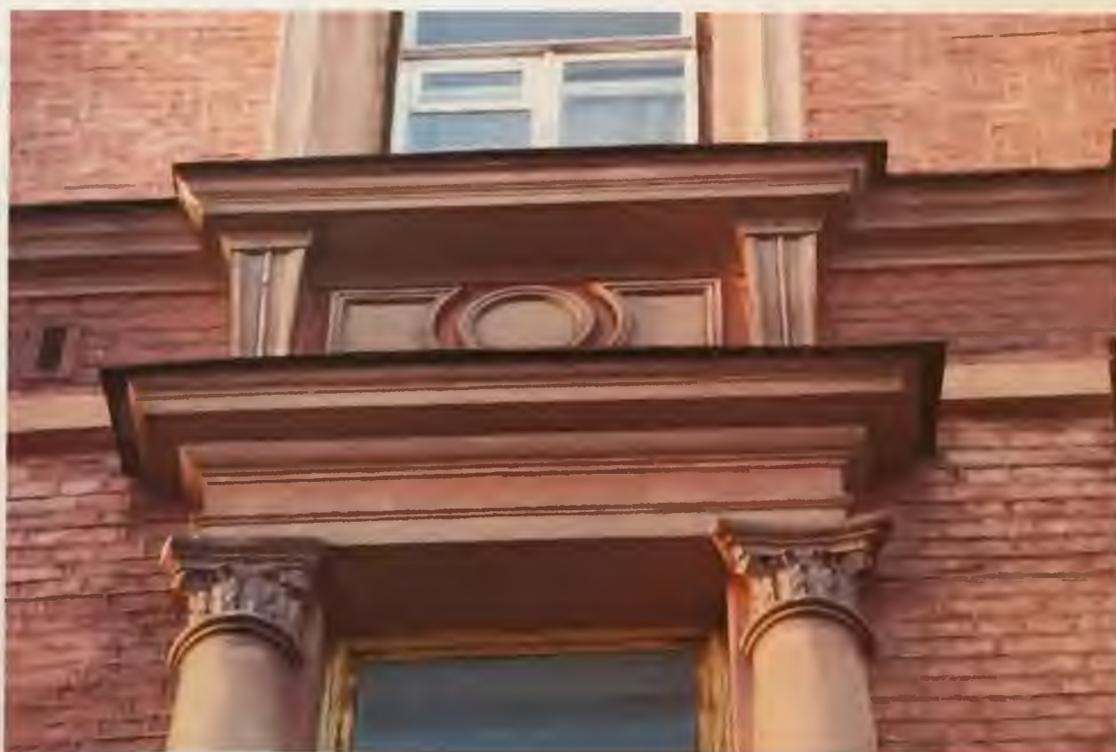
Фото 5.3. Фрагмент восточного фасада здания. Автор фото: Маланичева Г.И. 30.11.2016 г.
