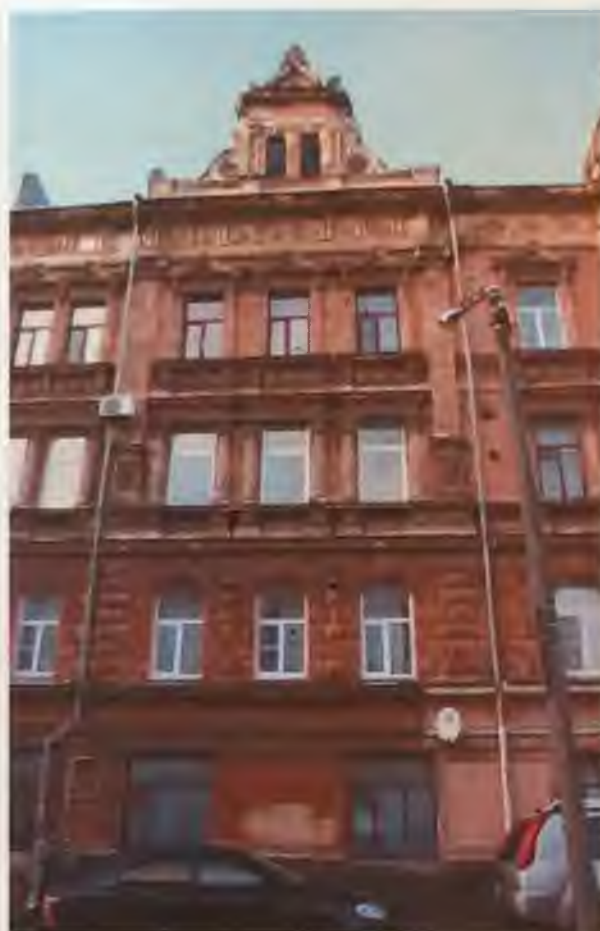
Фото 3. Фрагмент восточного фасада здания. Автор фото: Маланичева Г.И. 30.11.2016 г.
