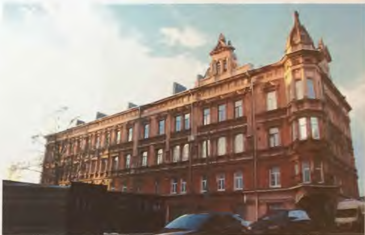
Фото 1. Общий вид здания с юго-востока. Автор фото: Маланичева Г.И. 30.11.2016 г.
