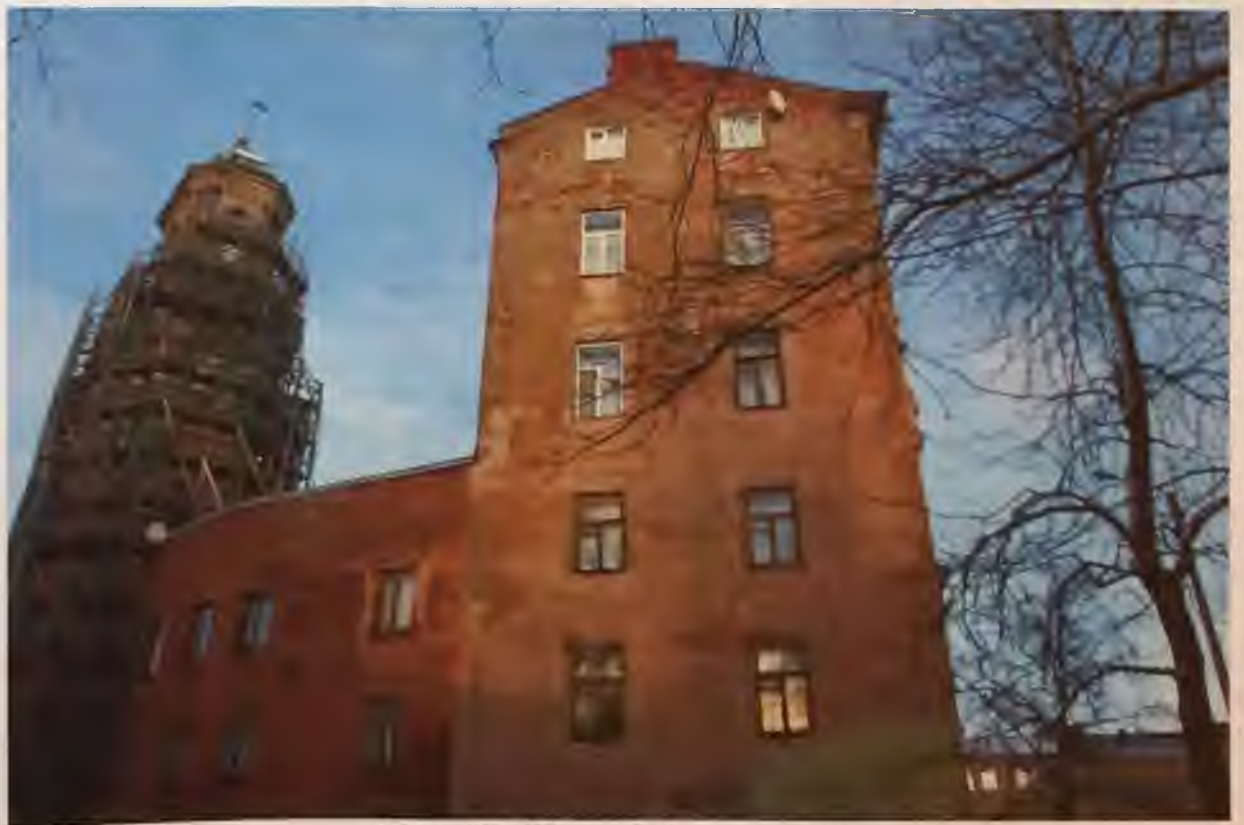
Фото 19. Южный фасад здания. Автор фото: Маланичева Г.И. 30.11.2016 г.
