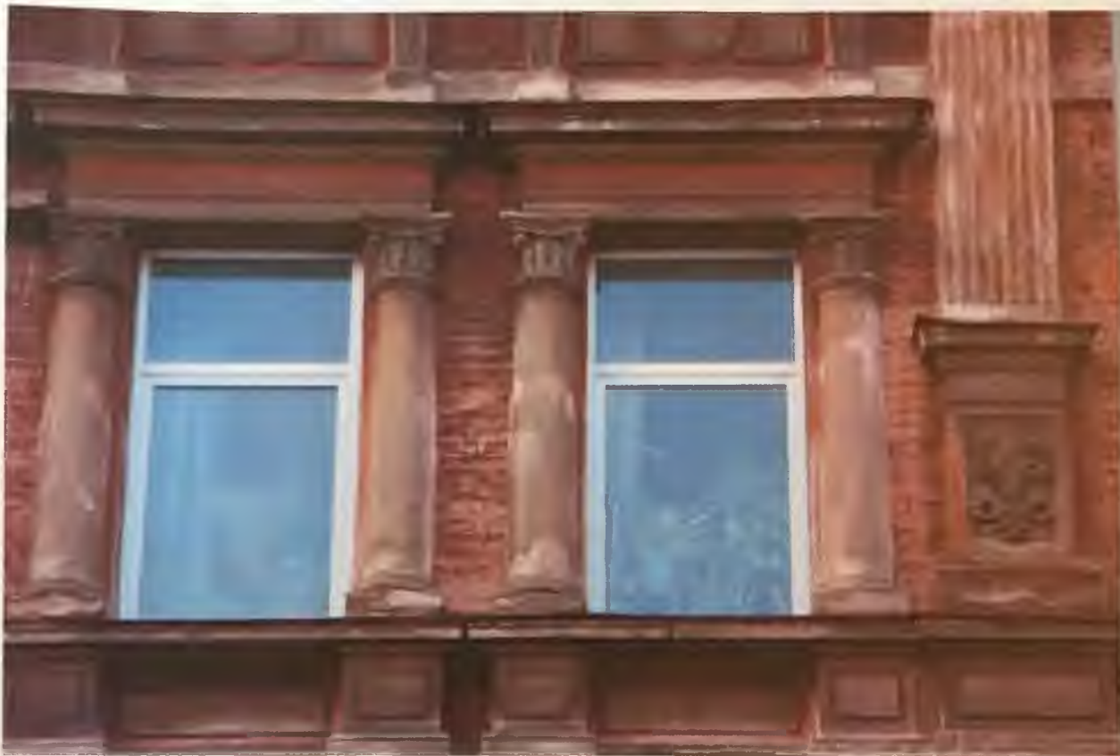
Фото 5.6. Фрагмент восточного фасада здания. Автор фото: Маланичева Г.И. 30.11.2016 г.
