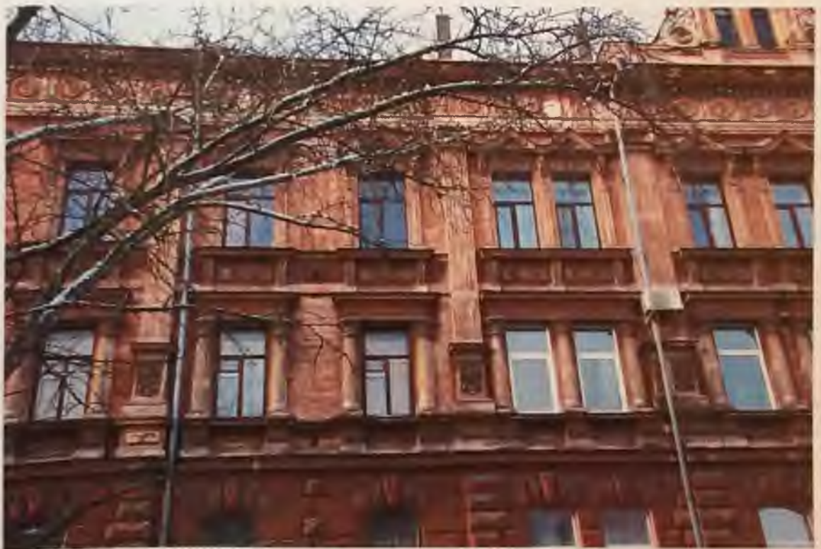
Фото 5.1. Фрагмент восточного фасада здания. Автор фото: Маланичева Г.И. 30.11.2016 г.
