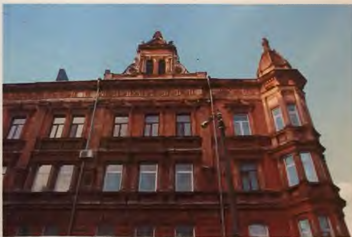
Фото 4. Фрагмент восточного фасада здания. Автор фото: Маланичева Г.И. 30.11.2016 г.
