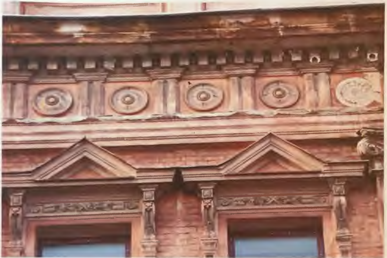
Фото 5.4. Фрагмент восточного фасада здания. Автор фото: Маланичева Г.И. 30.11.2016 г.
