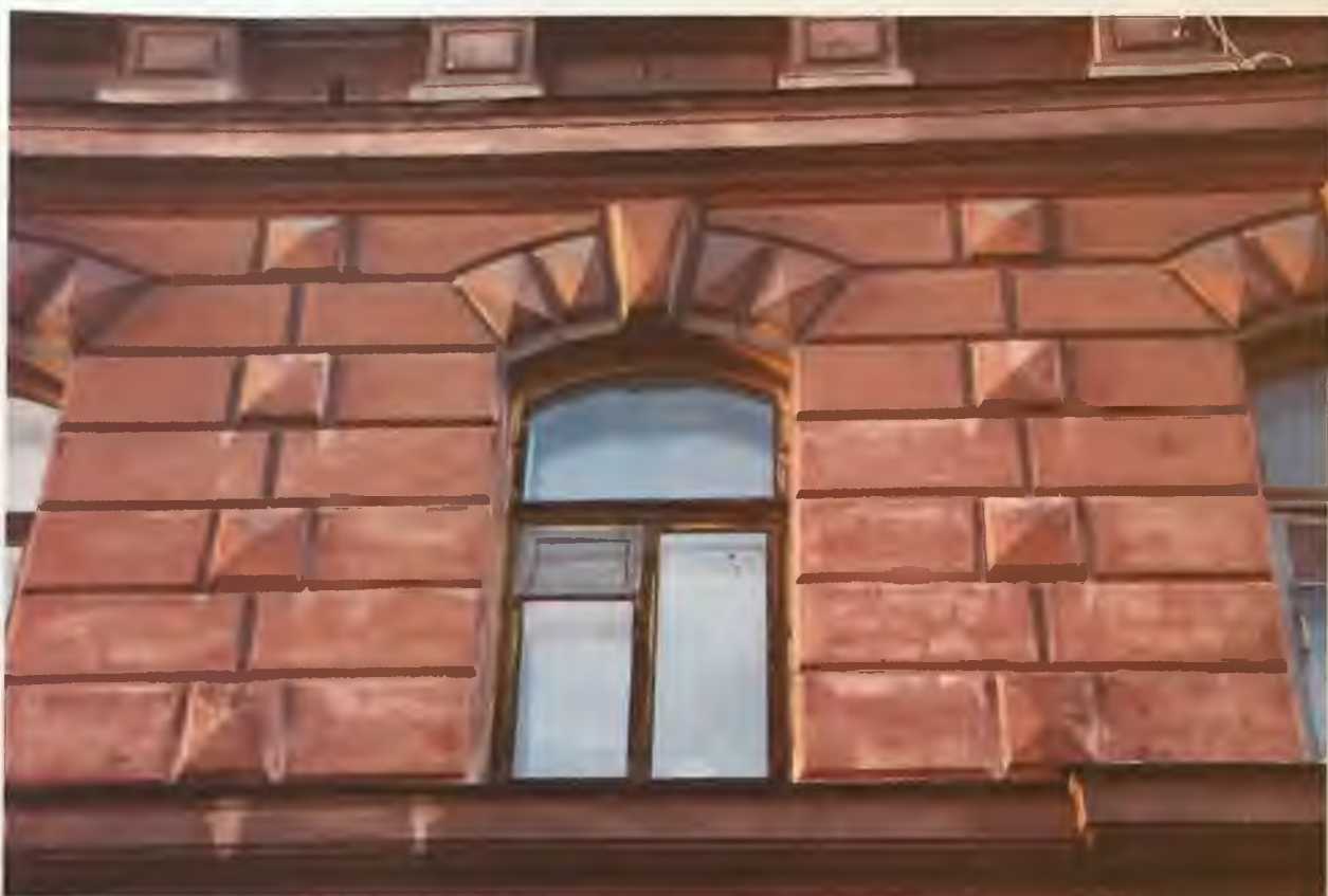
Фото 5.2. Фрагмент восточного фасада здания. Автор фото: Маланичева Г.И. 30.11.2016 г.
