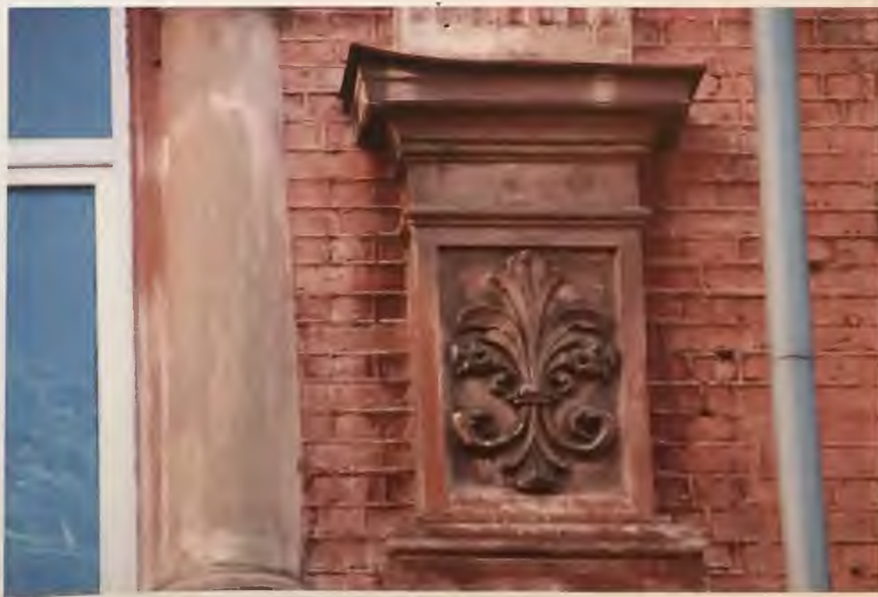
Фото 5.7. Фрагмент восточного фасада здания. Автор фото: Маланичева Г.И. 30.11.2016 г.
