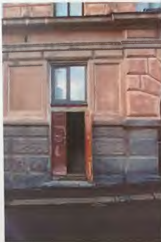
Фото 6. Фрагмент восточного фасада здания. Вход. Автор фото: Маланичева Г.И. 30.11.2016 г.
