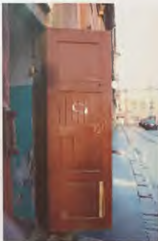
Фото 6.2. Фрагмент восточного фасада здания. Вход. Автор фото: Маланичева Г.И. 30.11.2016 г.
