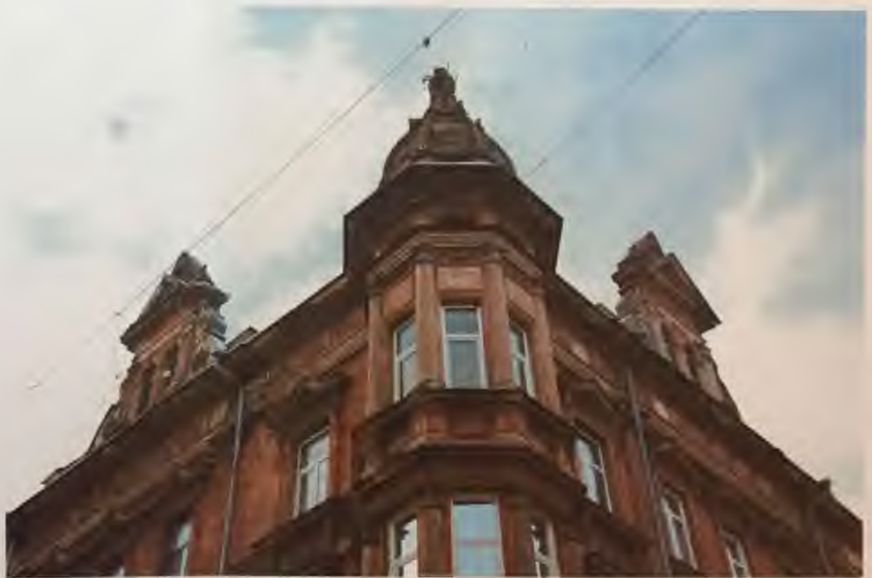
Фото 10.1. Вид на здание с угла улиц Крепостная и Новой Заставы. Фрагмент.
