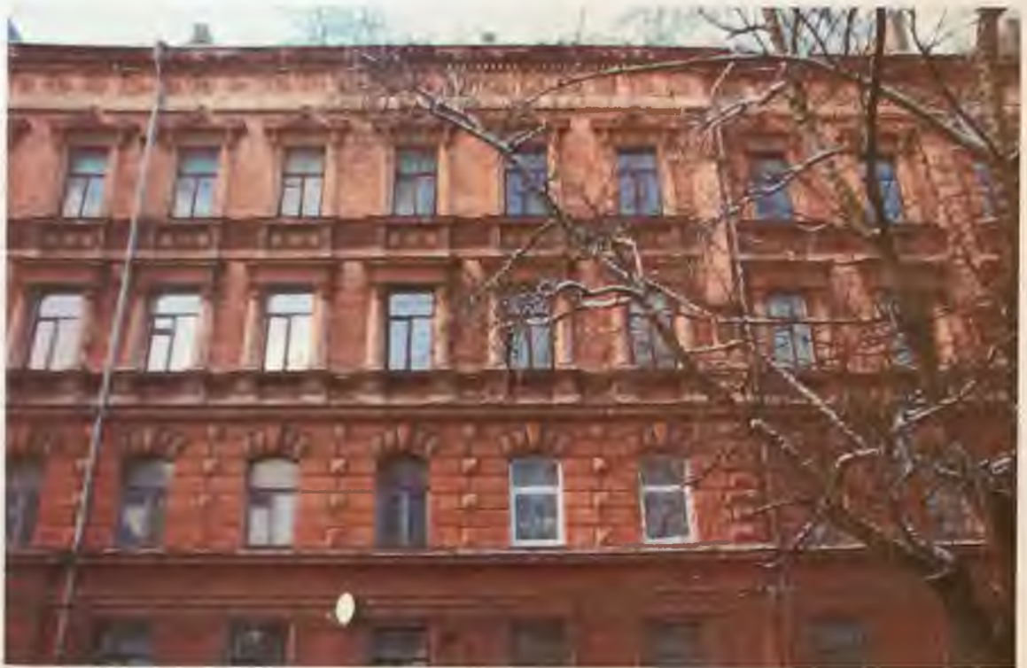
Фото 5. Фрагмент восточного фасада здания. Автор фото: Маланичева Г.И. 30.11.2016 г.
