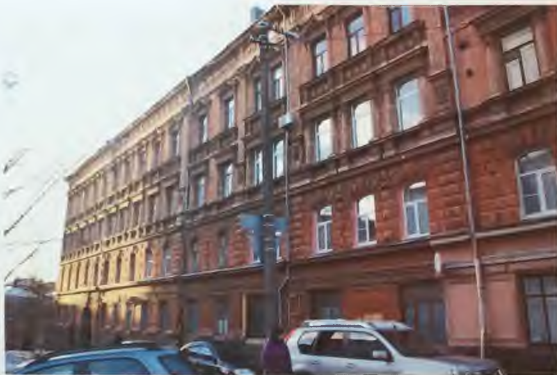
Фото 11. Фрагмент восточного фасада здания. Автор фото: Маланичева Г.И. 30.11.2016 г.
