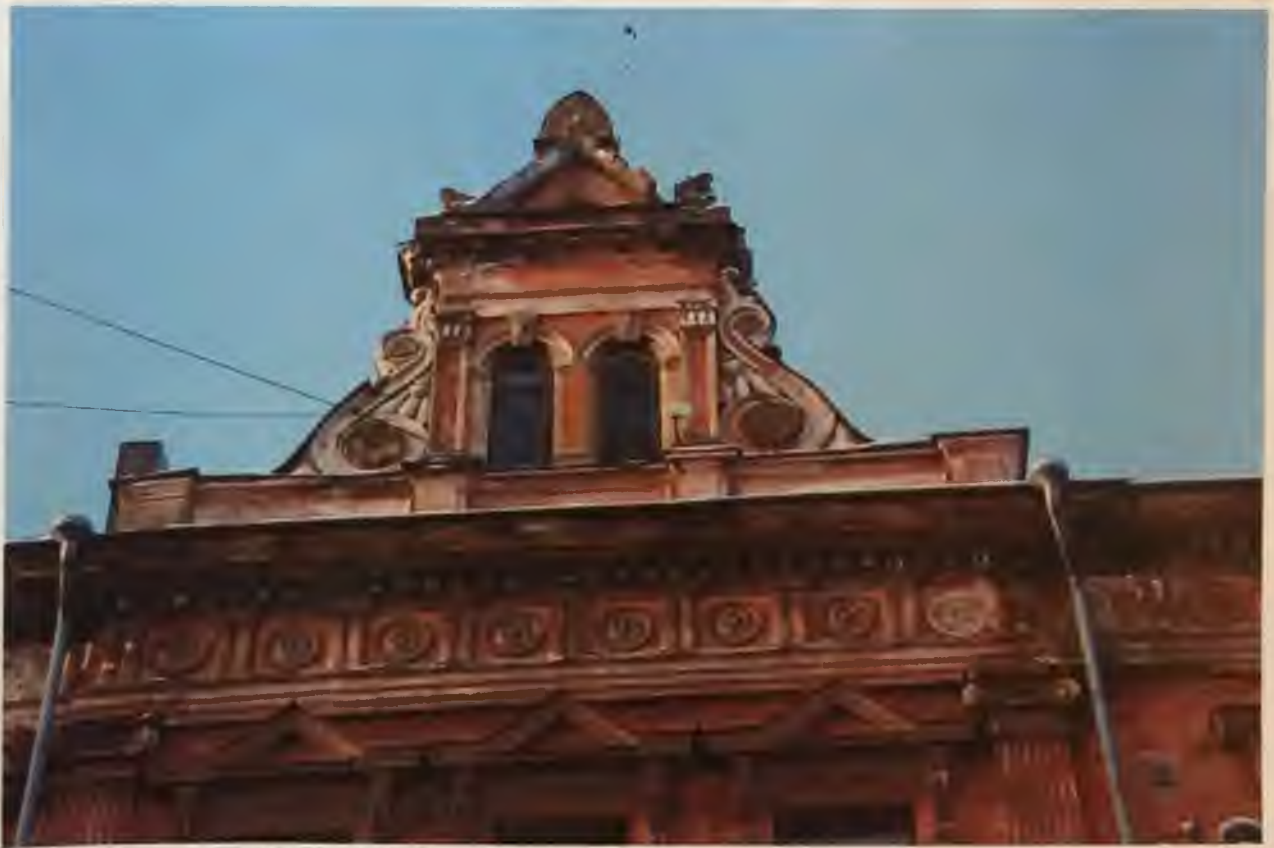
Фото 4.2. Фрагмент восточного фасада здания. Автор фото: Маланичева Г.И. 30.11.2016 г.
