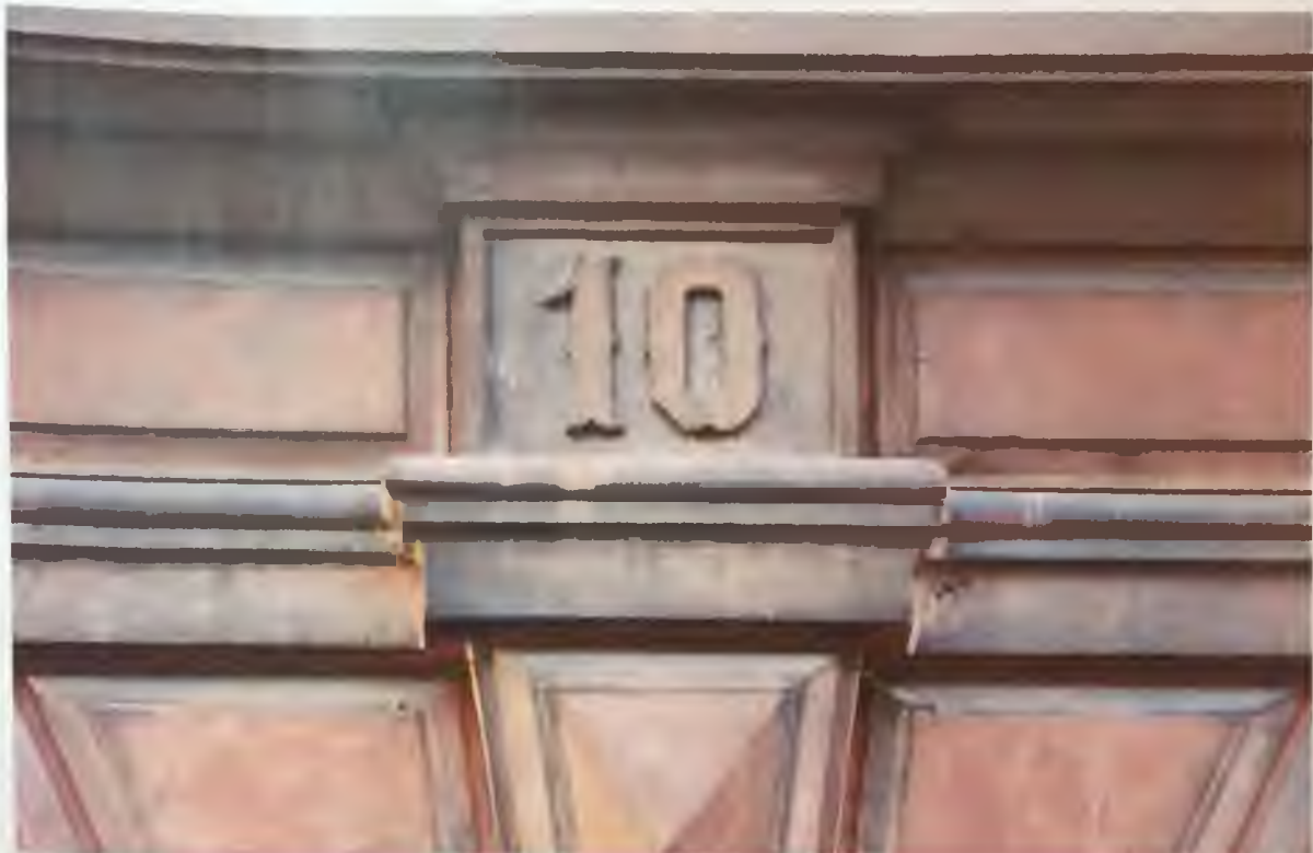
Фото 7.1. Фрагмент восточного фасада здания. Декоративное оформление арки. Автор фото: Маланичева Г.И. 30.11.2016 г.
