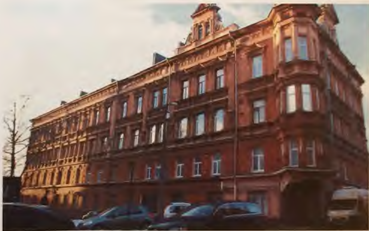
Фото 2. Восточный фасад здания Автор фото: Маланичева Г.И. 30.11.2016 г.
