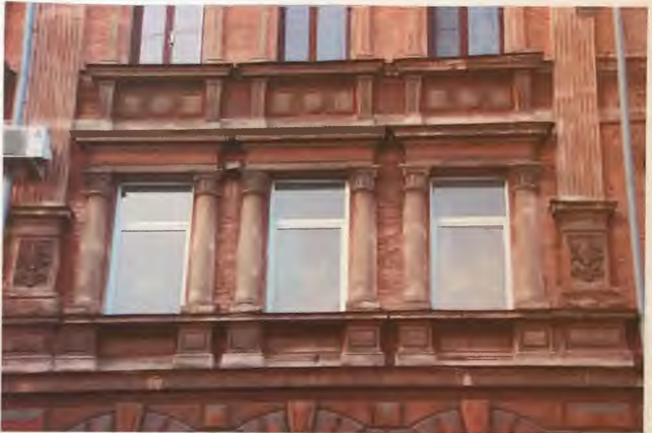
Фото 4.1. Фрагмент восточного фасада здания. Автор фото: Маланичева Г.И. 30.11.2016 г.
