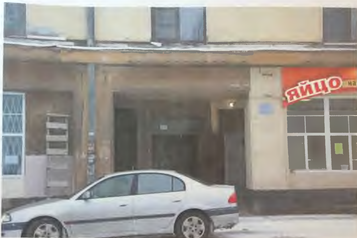
Фото 8.1. Западный фасад здания. Фрагмент. Автор фото: Маланичева Г.И. 30.11.2016 г.
