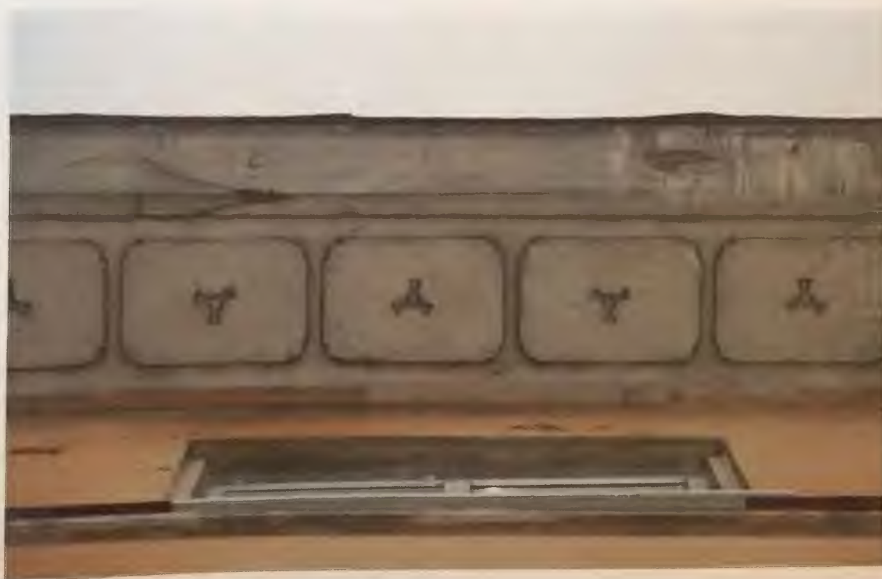
Фото 3.3. Северный фасад здания. Фрагмент. Автор фото: Маланичева Г.И. 30.11.2016 г.
