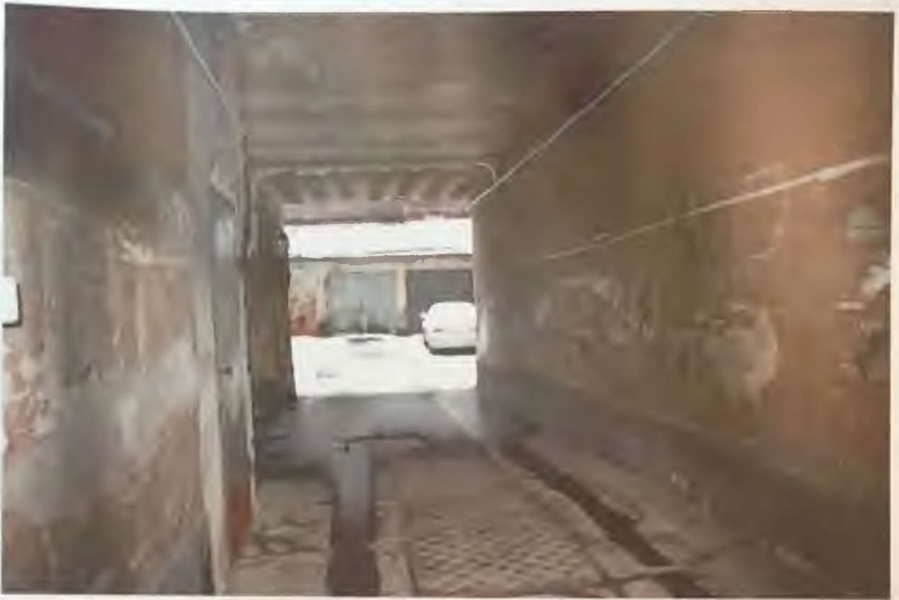
Фото 5.1. Северный фасад здания. Проездная арка. Автор фото: Маланичева Г.И. 30.11.2016 г.
