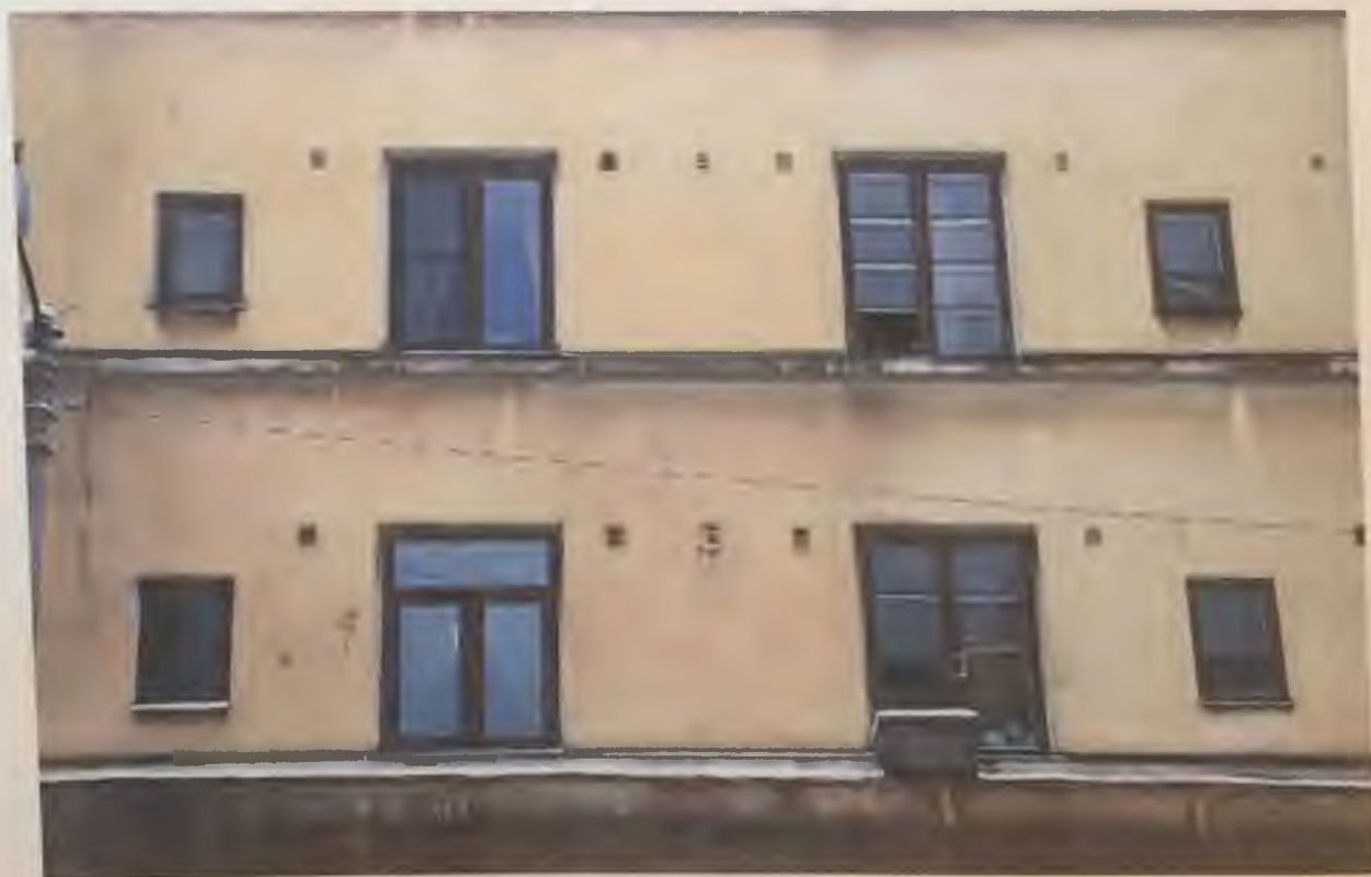
Фото 3.1. Северный фасад здания. Фрагмент. Автор фото: Маланичева Г.И. 30.11.2016 г.
