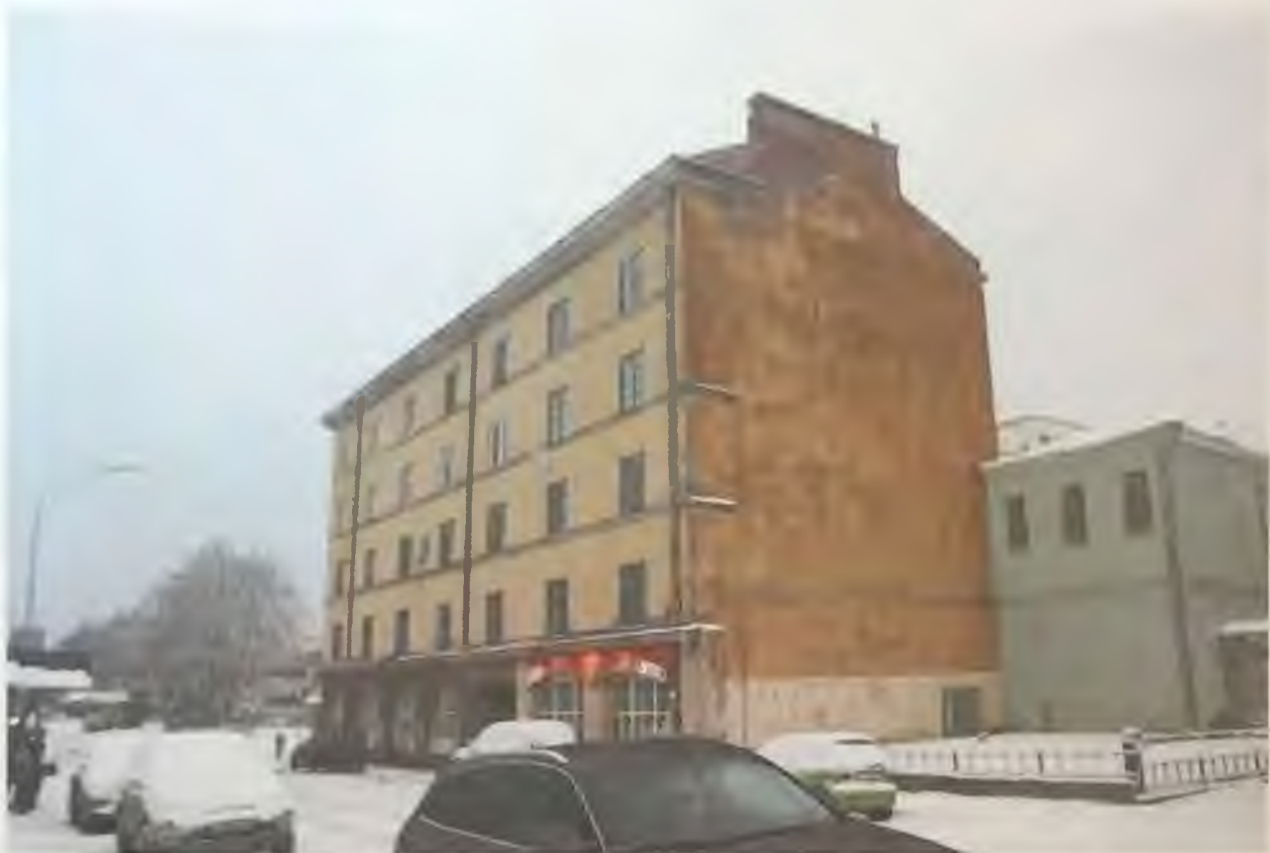
Фото 10. Общий вид здания с юго-запада. Автор фото: Маланичева Г.И. 30.11.2016 г.
