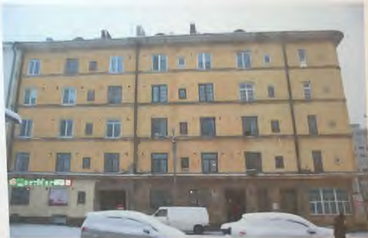
Фото 3. Северный фасад здания. Автор фото: Маланичева Г.И. 30.11.2016 г.
