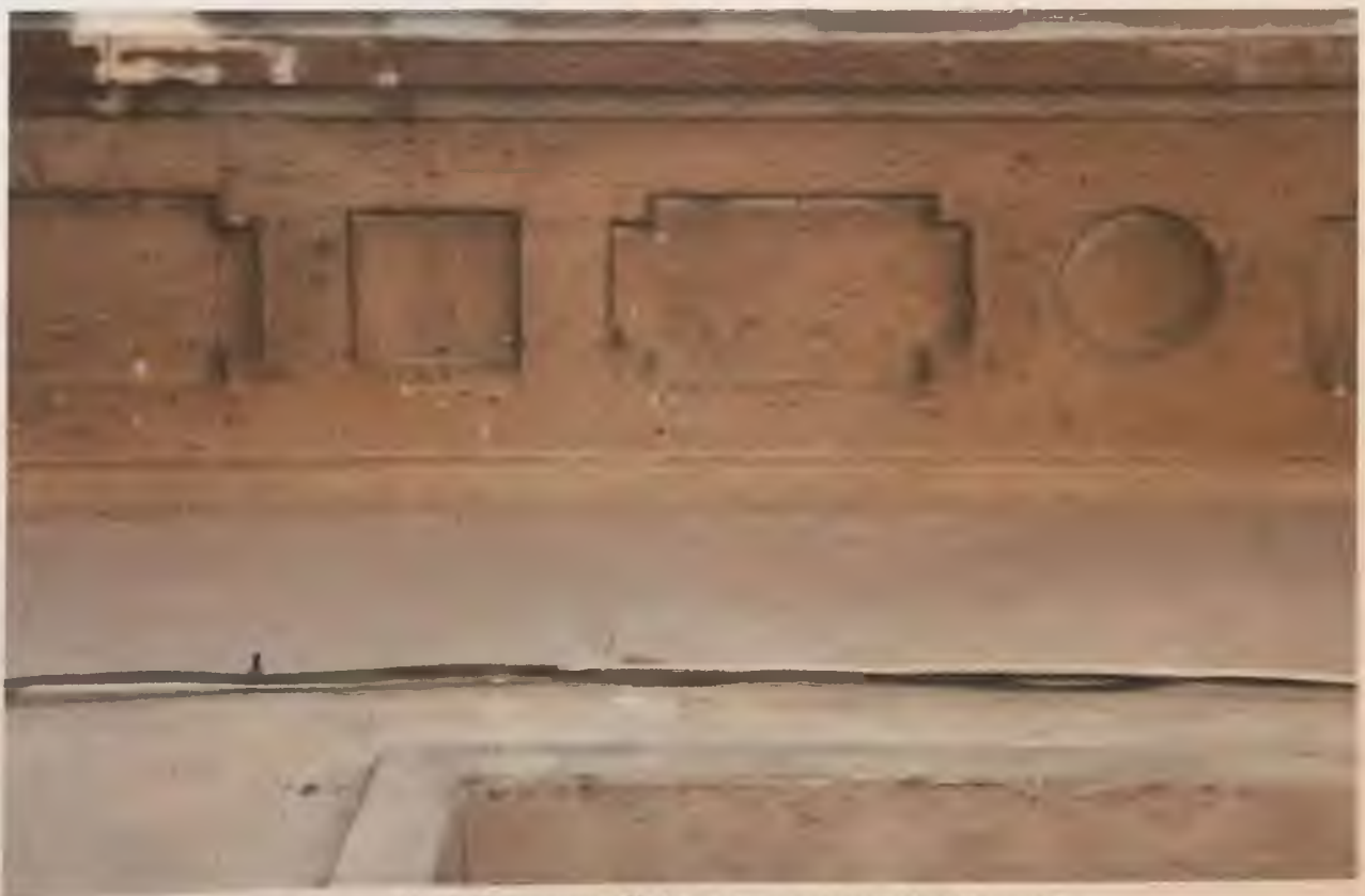
Фото 3.5. Северный фасад здания. Фрагмент. Автор фото: Маланичева Г.И. 30.11.2016 г.
