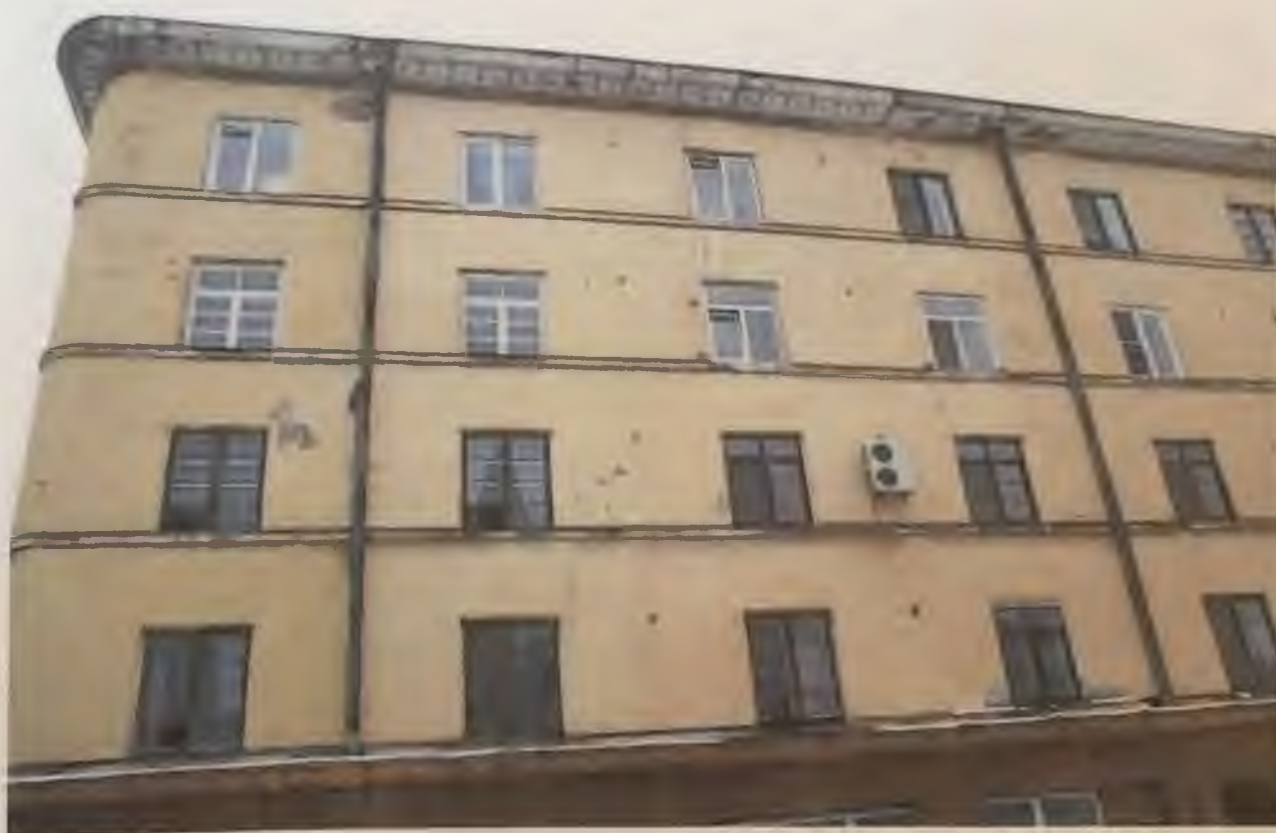
Фото 9. Западный фасад здания. Фрагмент. Автор фото: Маланичева Г.И. 30.11.2016 г.
