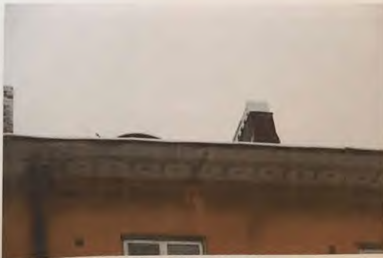
Фото 3.7. Северный фасад здания. Фрагмент. Автор фото: Маланичева Г.И. 30.11.2016 г.
