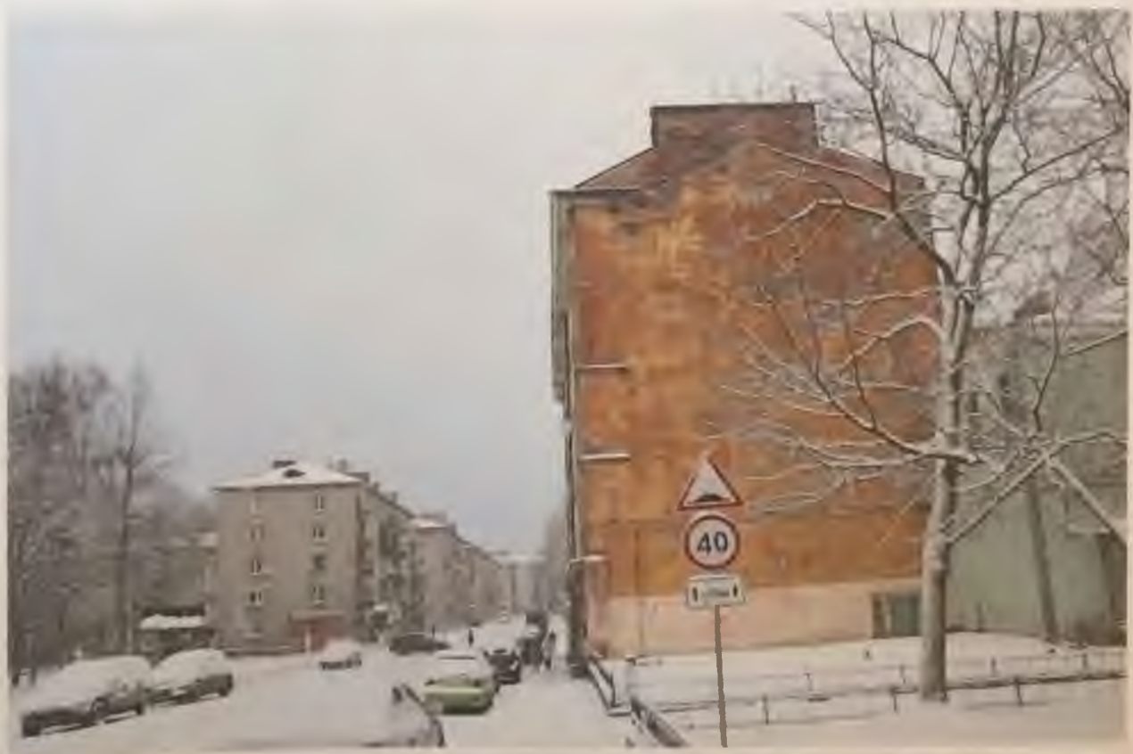
Фото 11. Южный фасад здания. Автор фото: Маланичева Г.И. 30.11.2016 г.
