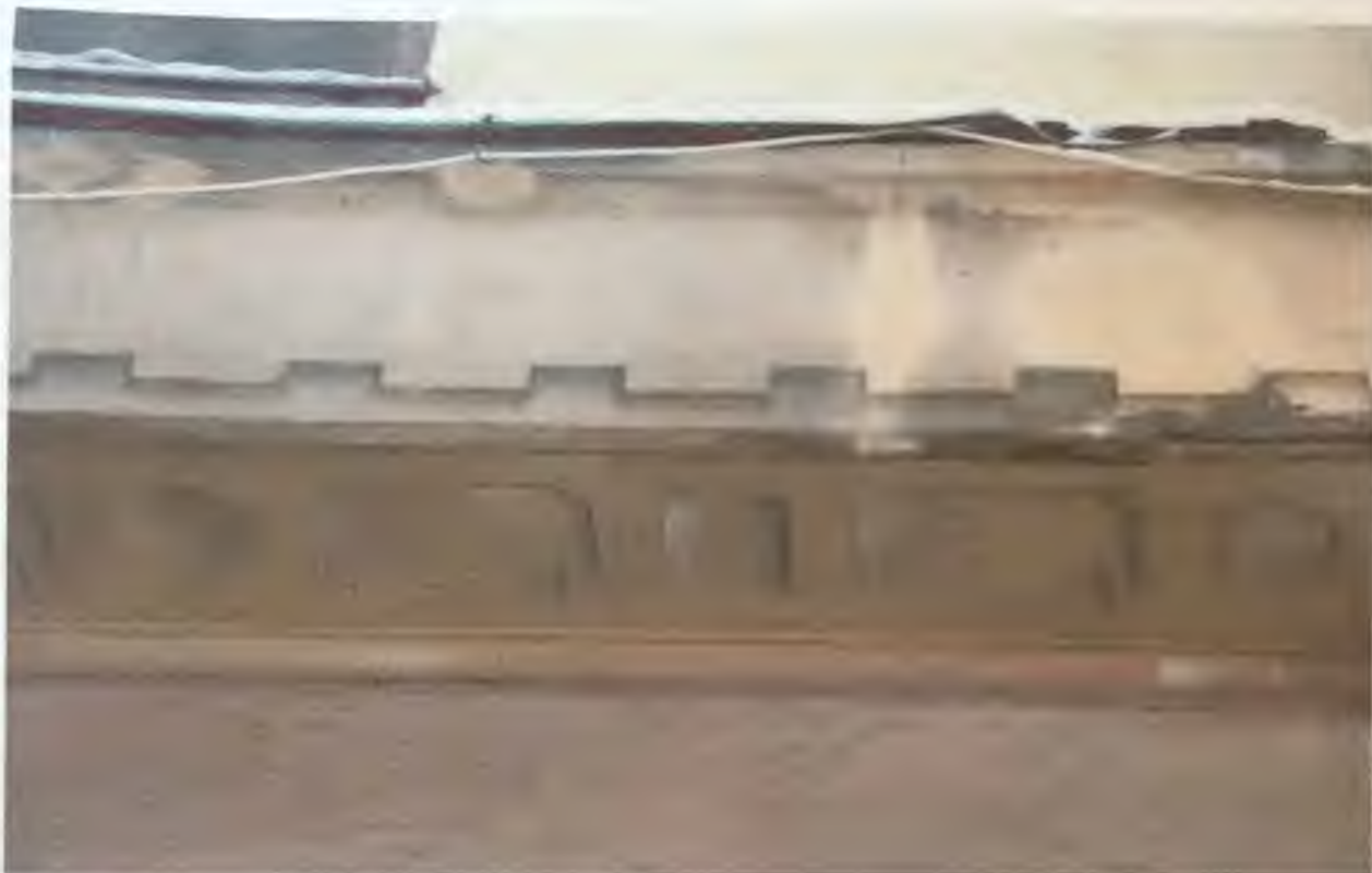
Фото 3.6. Северный фасад здания. Фрагмент. Автор фото: Маланичева Г.И. 30.11.2016 г.
