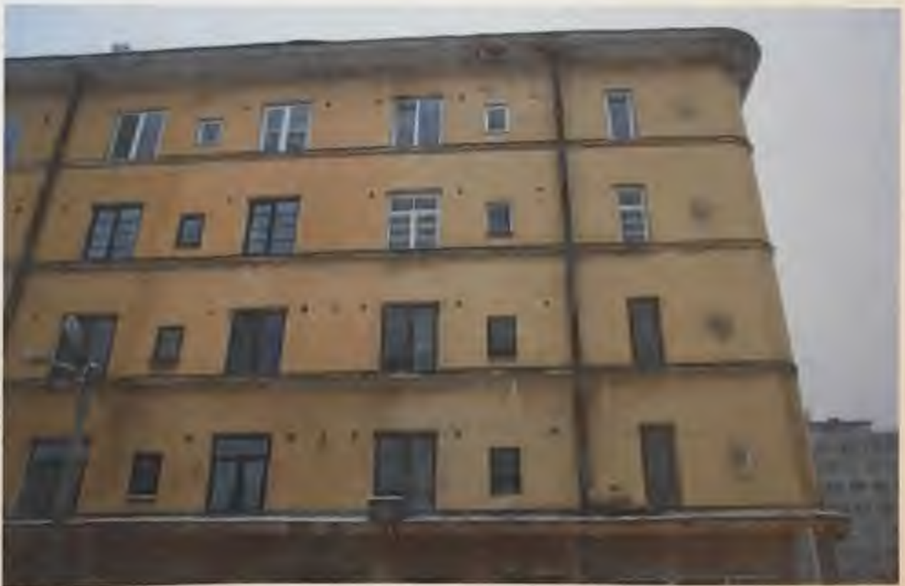
Фото 6. Северный фасад здания. Фрагмент. Автор фото: Маланичева Г.И. 30.11.2016 г.
