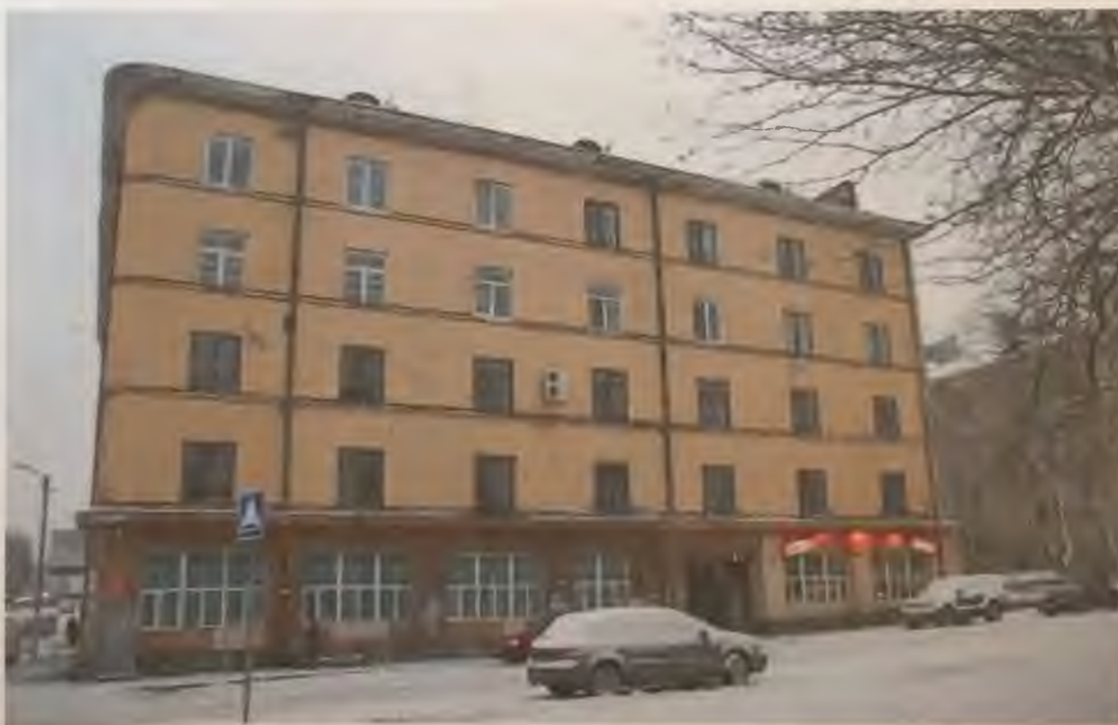
Фото 8. Западный фасад здания. Автор фото: Маланичева Г.И. 30.11.2016 г.
