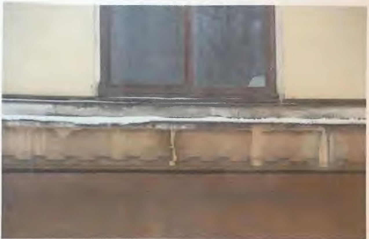
Фото 3.4. Северный фасад здания. Фрагмент. Автор фото: Маланичева Г.И. 30.11.2016 г.
