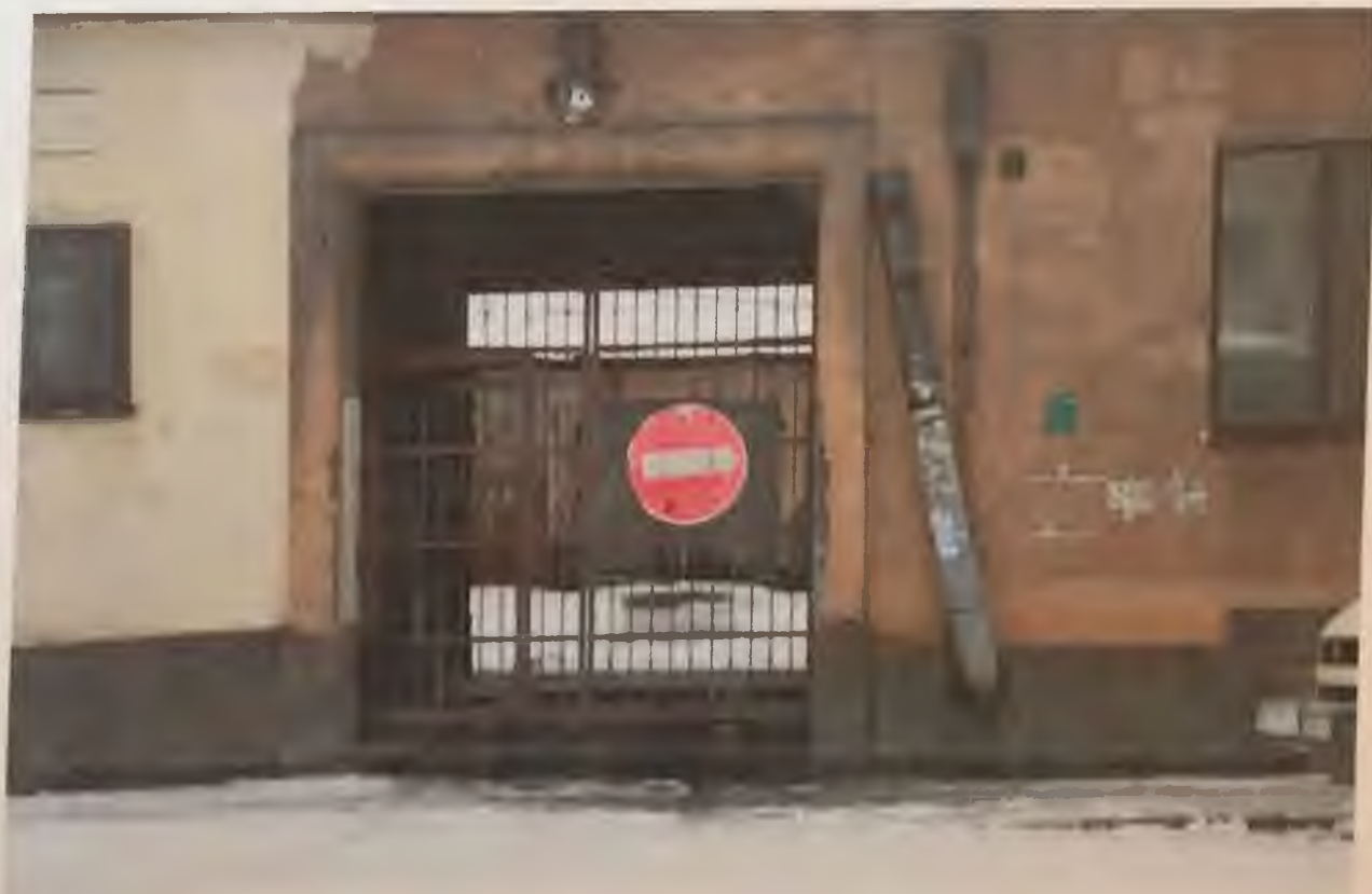
Фото 5. Северный фасад здания. Проездная арка. Автор фото: Маланичева Г.И. 30.11.2016 г.
