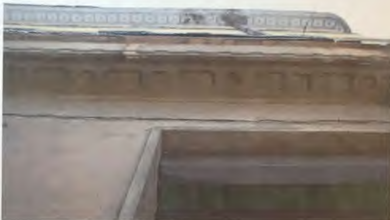
Фото 3.2. Северный фасад здания. Фрагмент. Автор фото: Маланичева Г.И. 30.11.2016 г.
