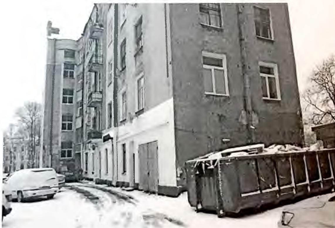
Фото 7. Вид на здание с северо-востока. Автор фото: Маланичева Г.И. 29.11.2016 г.
