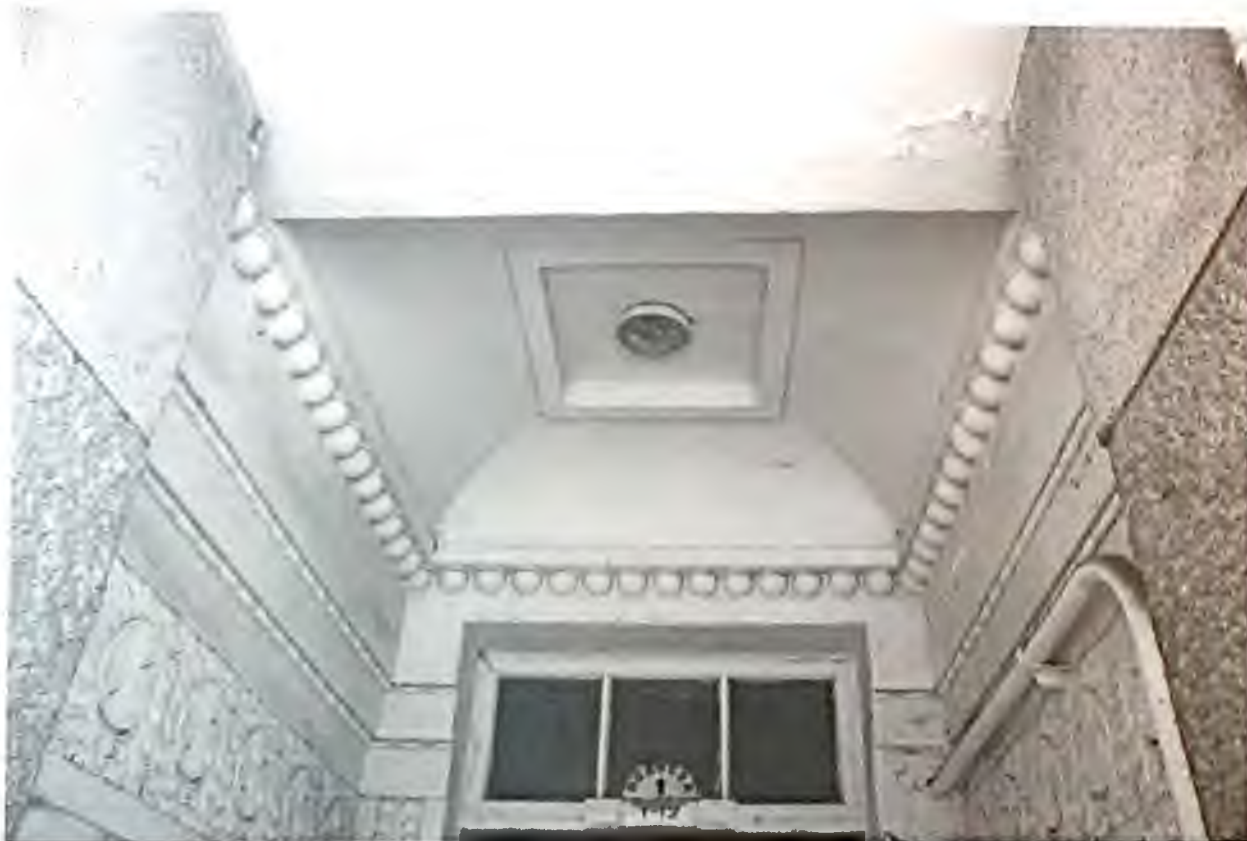
Фото 3.3. Главный фасад здания. Оформление главного входа. Автор фото: Маланичева Г.И. 29.11.2016 г.
