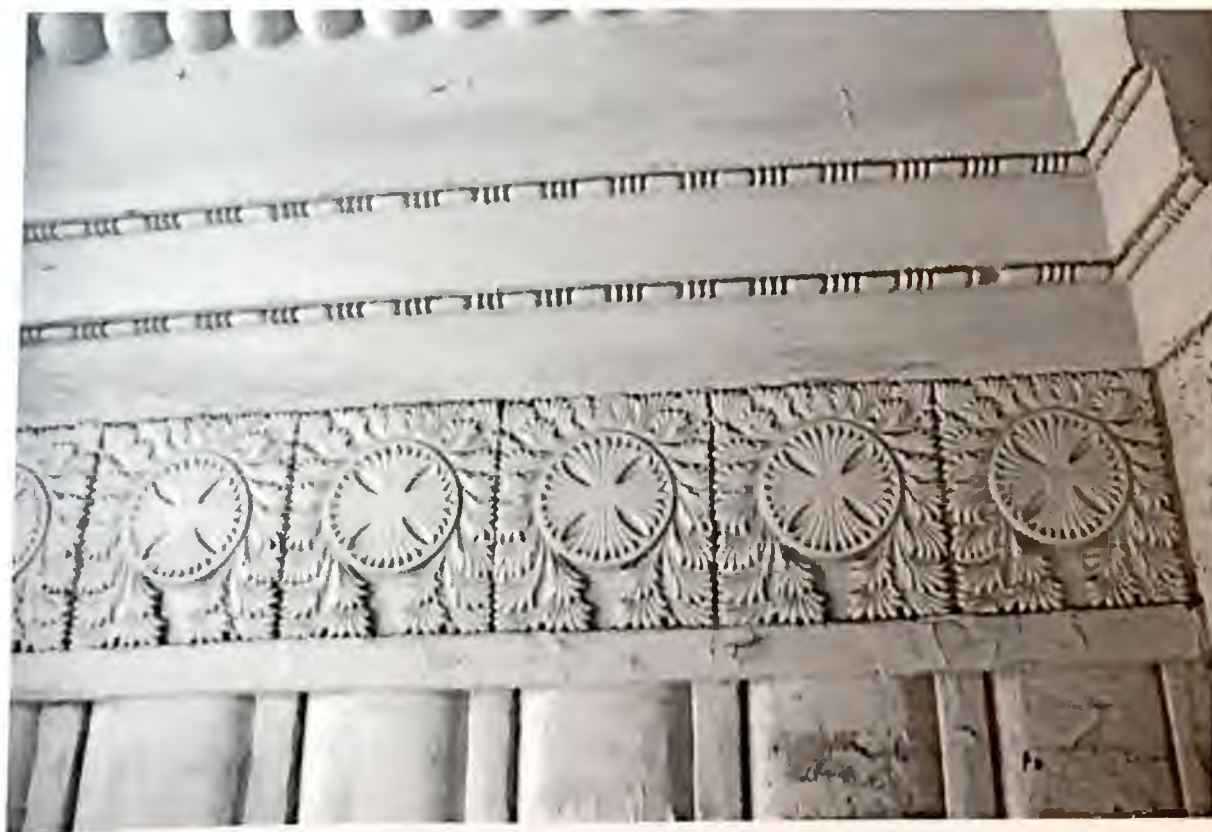
Фото 3.4. Главный фасад здания. Оформление главного входа. Автор фото: Маланичева Г.И. 29.11.2016 г.
