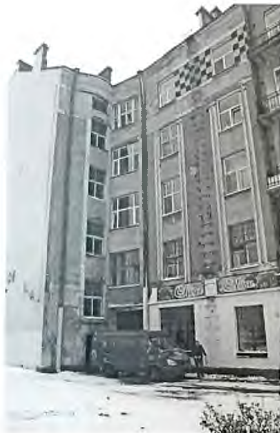
Фото 6. Юго-восточный фасад здания. Автор фото: Маланичева Г.И. 29.11.2016 г.
