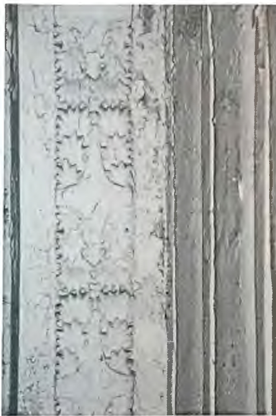
Фото 3.5. Главный фасад здания. Оформление главного входа. Автор фото: Маланичева Г.И. 29.11.2016 г.
