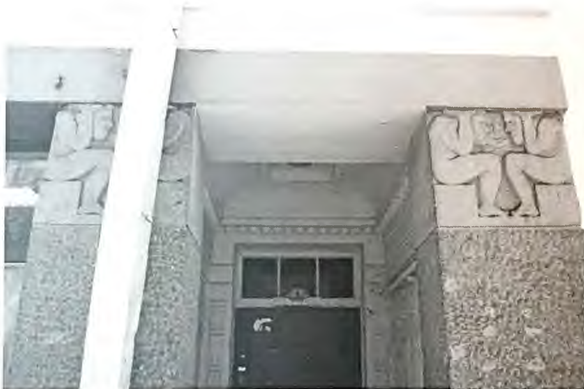
Фото 3.1. Главный фасад здания. Оформление главного входа. Автор фото: Маланичева Г.И. 29.11.2016 г.
