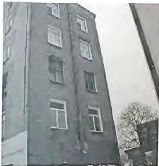
Фото 10. Северо-восточный фасад здания. Автор фото: Маланичева Г.И. 29.11.2016 г
