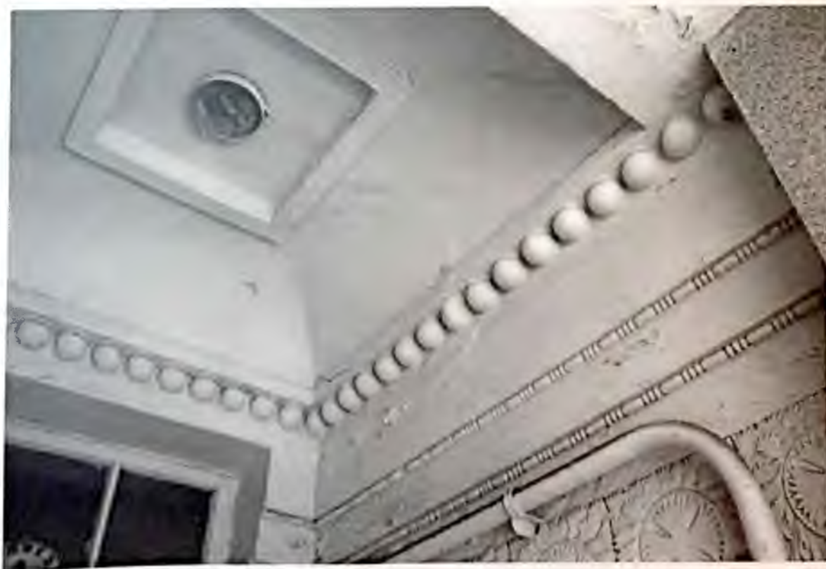
Фото 3.6. Главный фасад здания. Оформление главного входа. Автор фото: Маланичева Г.И. 29.11.2016 г.
