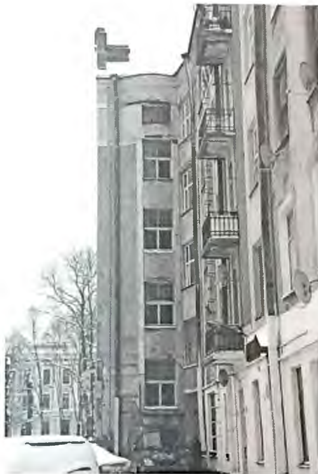
Фото 8. Вид на здание с северо-востока. Автор фото: Маланичева Г.И. 29.11.2016 г.
