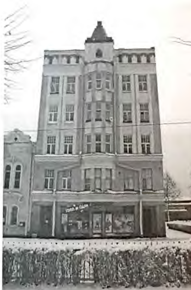
Фото 2. Главный фасад здания. Автор фото: Маланичева Г.И. 29.11.2016 г.
