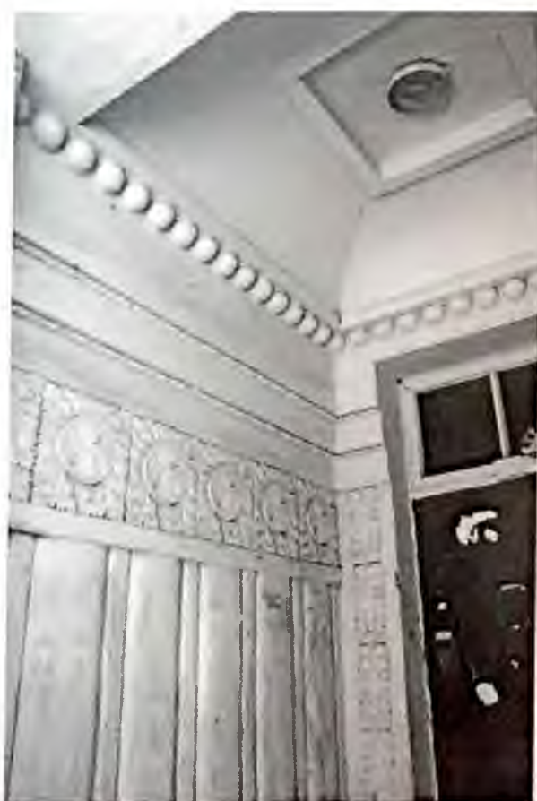
Фото 3.2. Главный фасад здания. Оформление главного входа. Автор фото: Маланичева Г.И. 29.11.2016 г.
