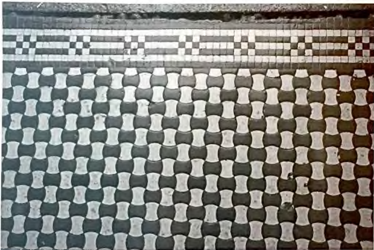
Фото 3.7. Главный фасад здания. Оформление главного входа. Автор фото: Маланичева Г.И. 29.11.2016 г.
