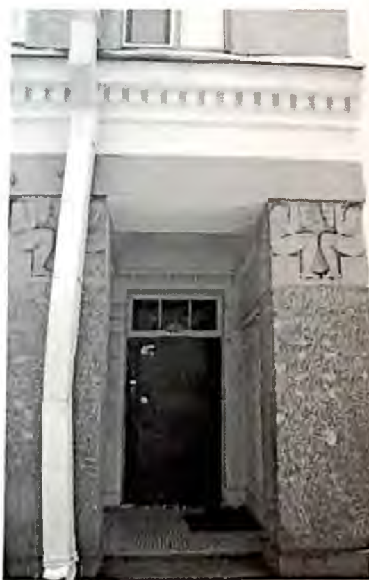
Фото 3. Главный фасад здания. Оформление главного входа. Автор фото: Маланичева Г.И. 29.11.2016 г.
