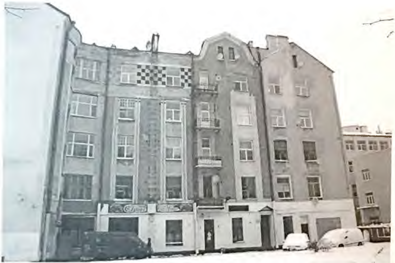
Фото 5. Юго-восточный фасад здания. Автор фото: Маланичева Г.И. 29.11.2016 г.
