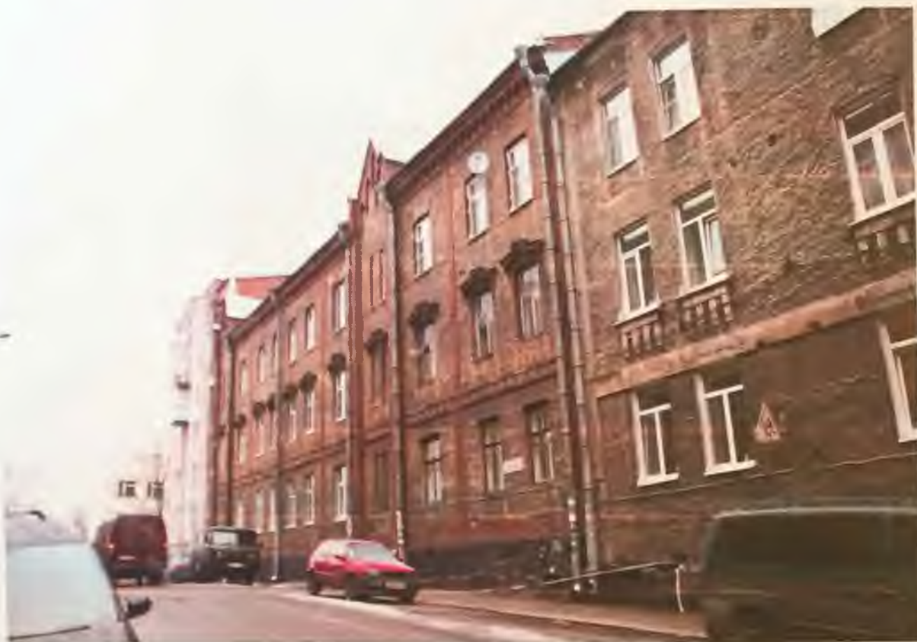
Фото 1. Общий вид здания с юго-востока. Автор фото: Маланичева Г.И. 29.11.2016 г.
