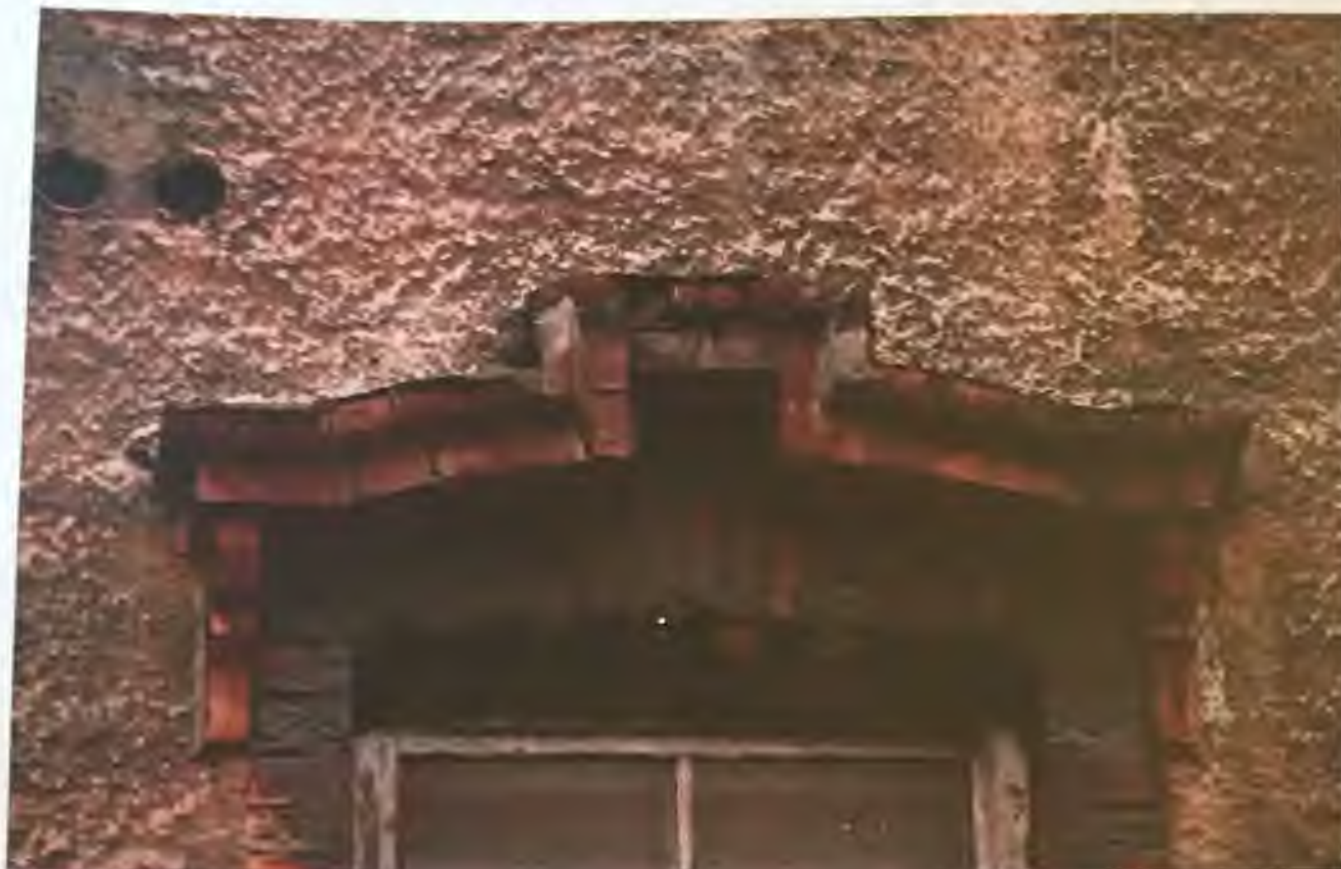
Фото 3.4. Западный фасад здания. Фрагмент. Автор фото: Маланичева Г.И. 29.11.2016 г.
