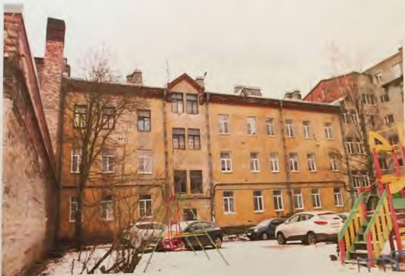
Фото 8. Общий вид здания с северо-востока. Автор фото: Маланичева Г.И. 29.11.2016 г.
