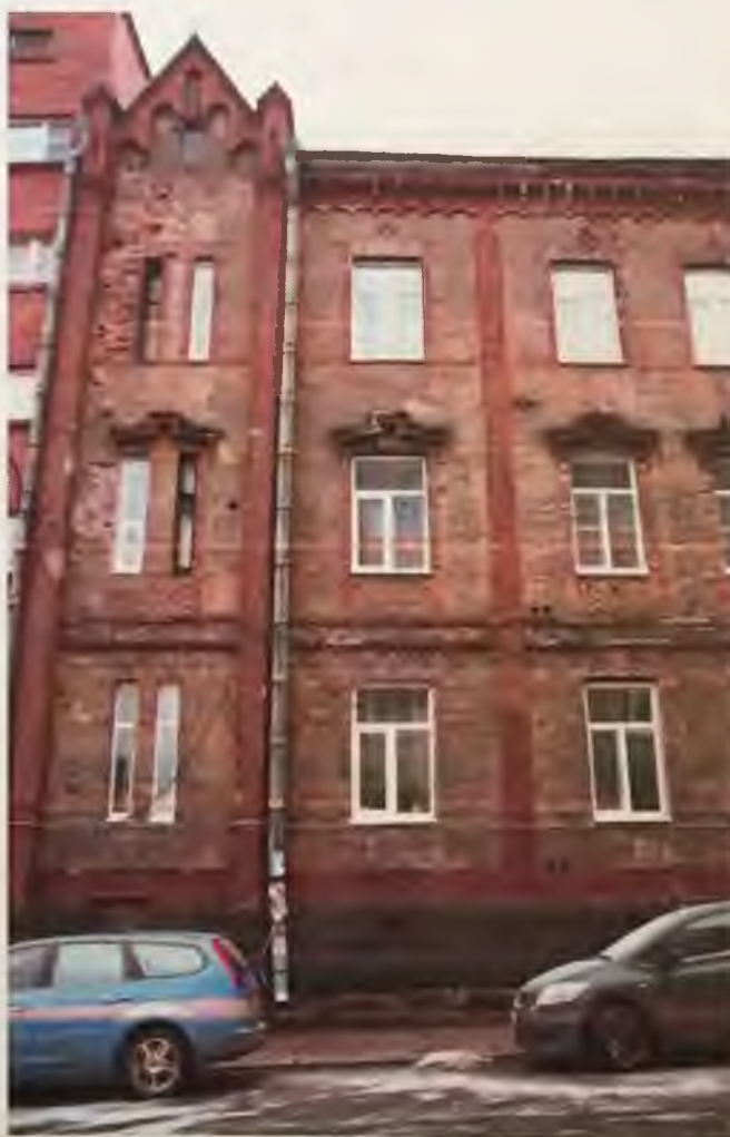
Фото 6. Юго-западный фасад здания. Автор фото: Маланичева Г.И. 29.11.2016 г
