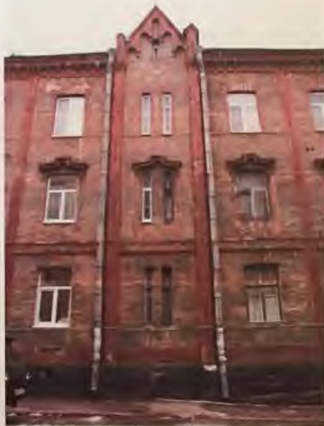
Фото 4. Юго-западный фасад здания. Центральная часть. Автор фото: Маланичева Г.И. 29.11.2016 г.
