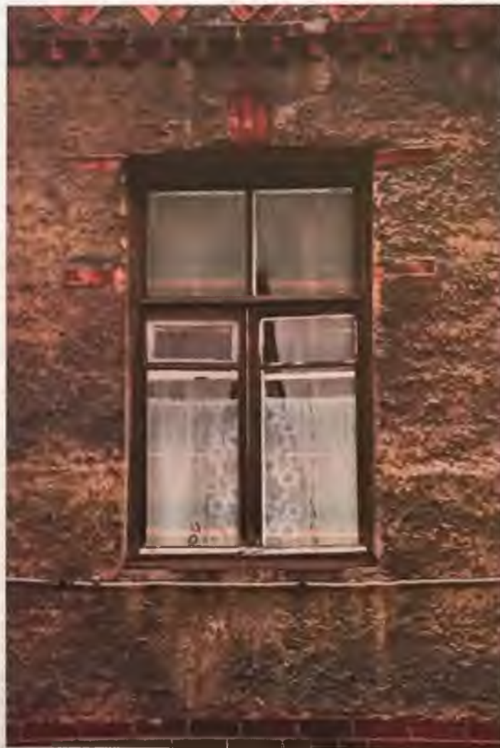
Фото 3.7. Западный фасад здания. Фрагмент. Автор фото: Маланичева Г.И. 29.11.2016 г.
