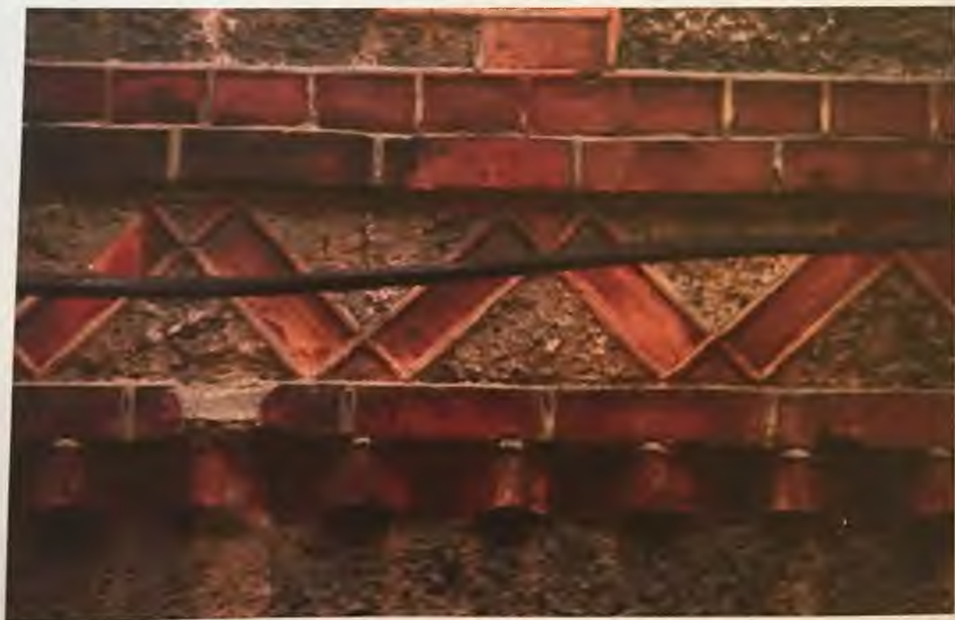
Фото 3.5. Западный фасад здания. Фрагмент. Автор фото: Маланичева Г.И. 29.11.2016 г.
