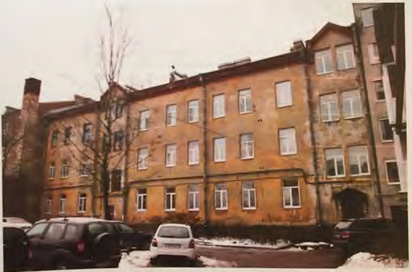
Фото 12. Северо-восточный фасад здания. Автор фото: Маланичева Г.И. 29.11.2016 г.
