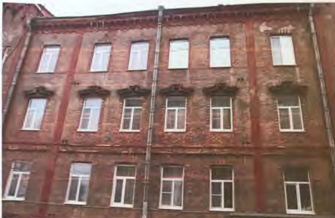
Фото 5. Юго-западный фасад здания. Автор фото: Маланичева Г.И. 29.11.2016 г.
