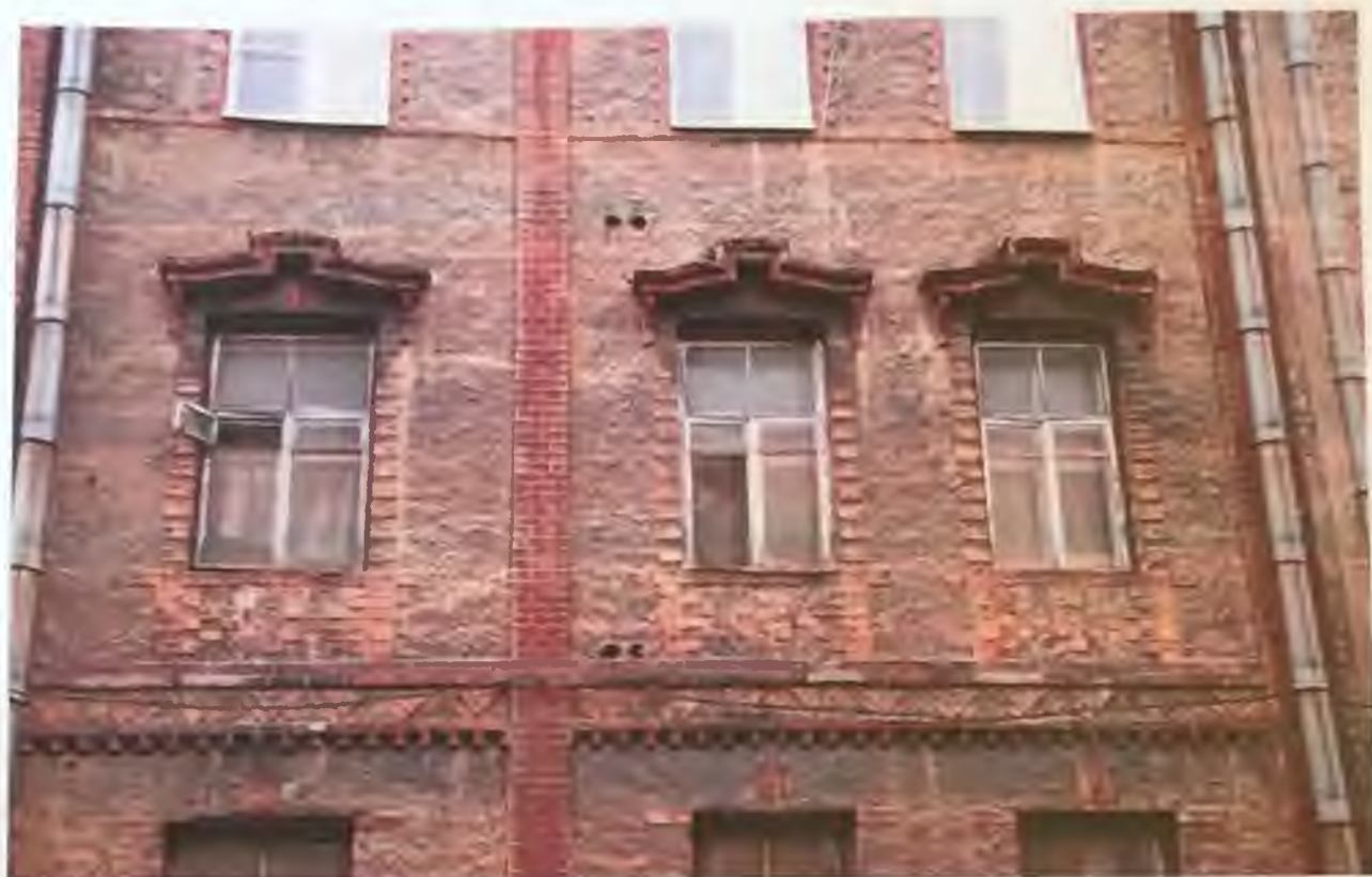
Фото 3.2. Западный фасад здания. Фрагмент. Автор фото: Маланичева Г.И. 29.11.2016 г.
