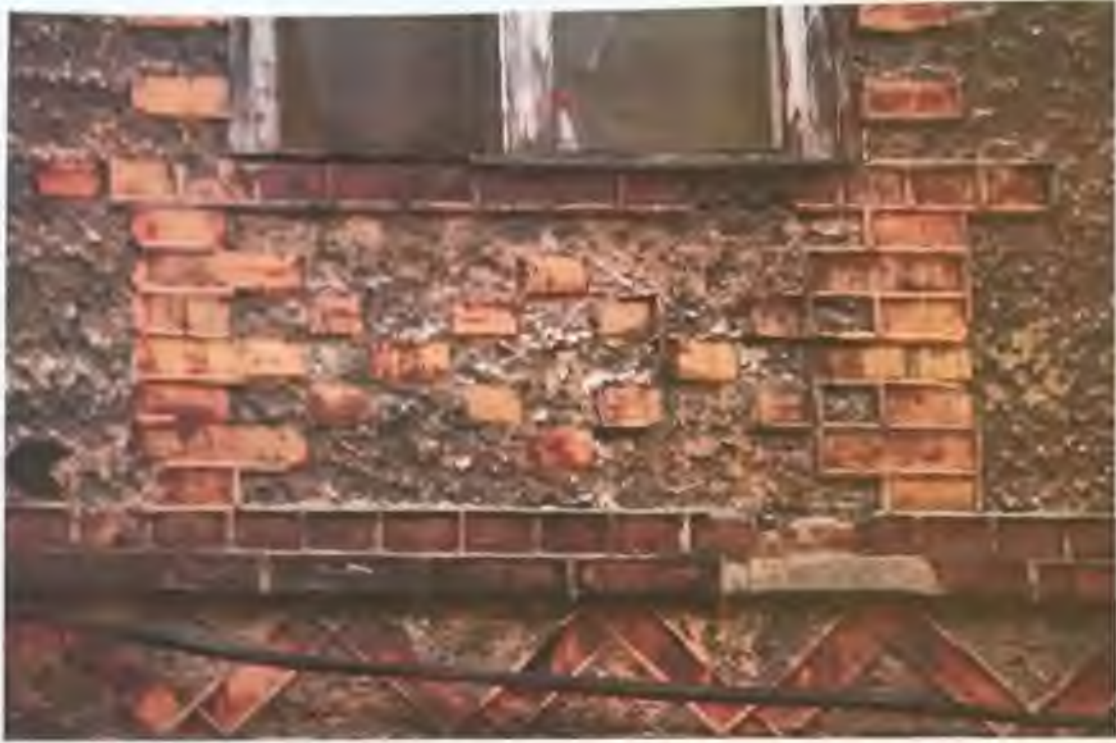
Фото 3.6. Западный фасад здания. Фрагмент. Автор фото: Маланичева Г.И. 29.11.2016 г.
