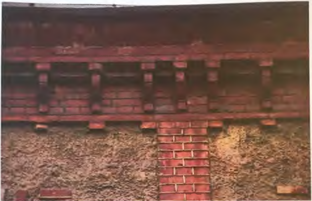
Фото 3.8. Западный фасад здания. Фрагмент. Автор фото: Маланичева Г.И. 29.11.2016 г.
