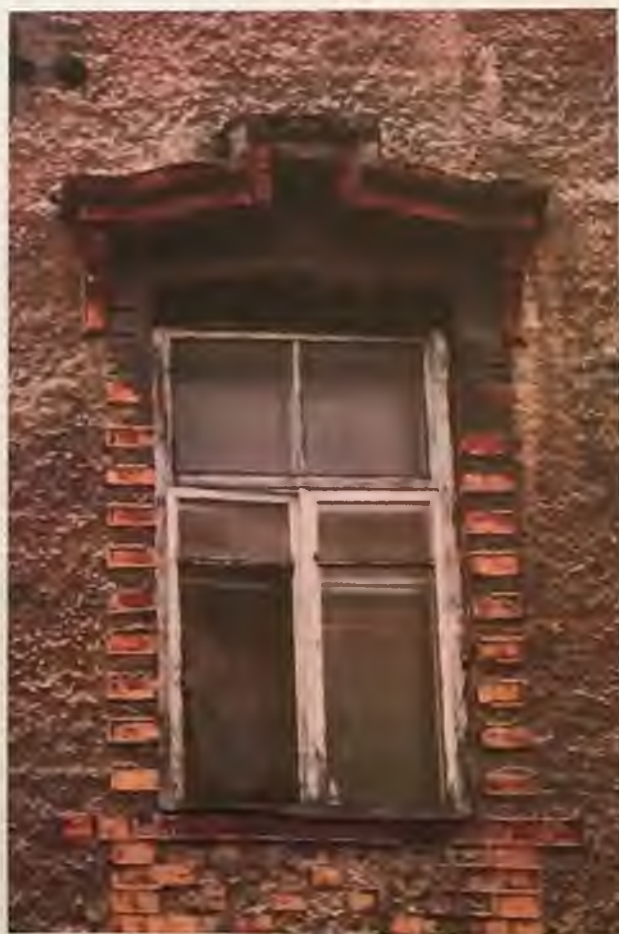
Фото 3.3. Западный фасад здания. Фрагмент. Автор фото: Маланичева Г.И. 29.11.2016 г.
