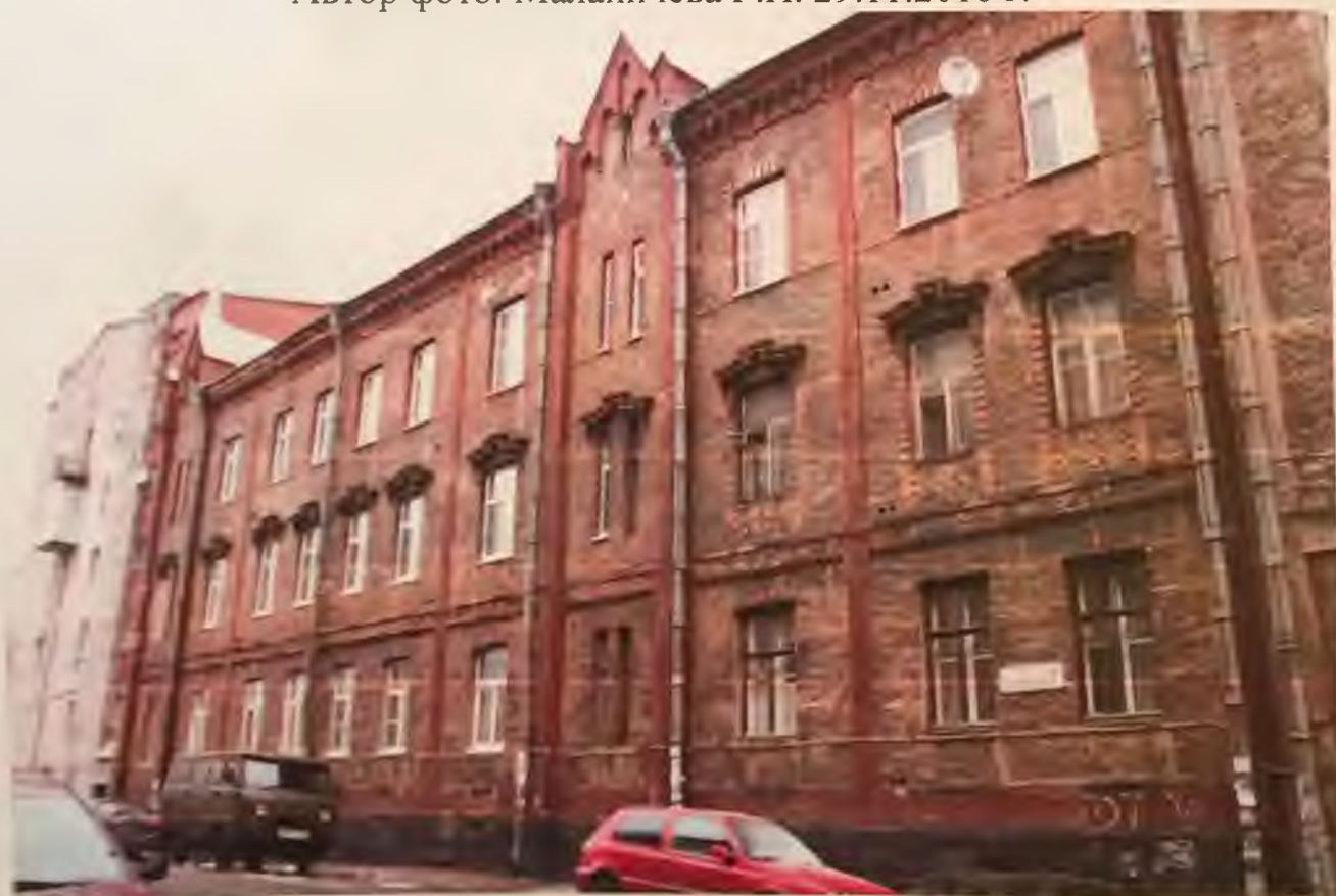
Фото 2. Юго-западный фасад. Автор фото: Маланичева Г.И. 29.11.2016 г.
