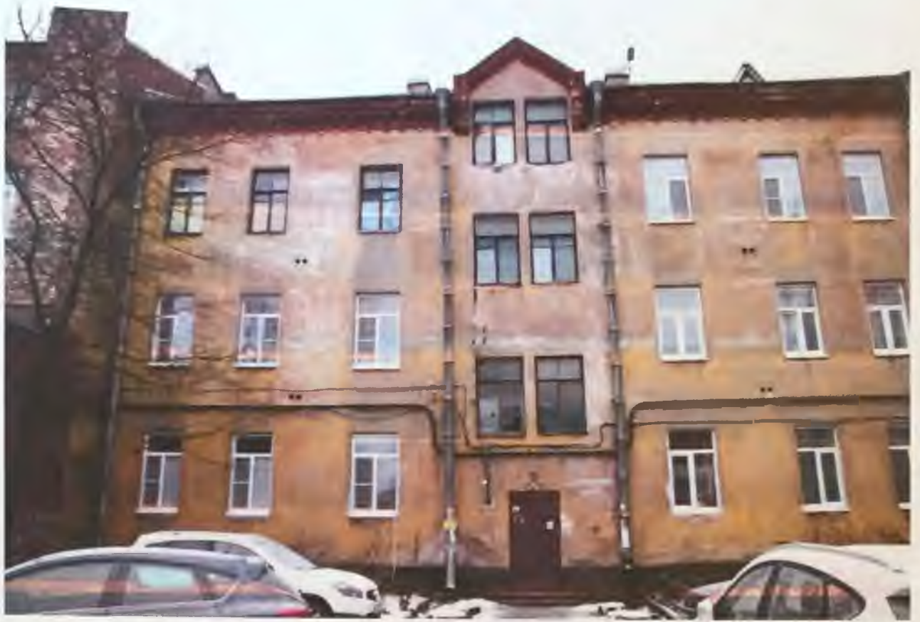
Фото 9. Северо-восточный фасад здания. Автор фото: Маланичева Г.И. 29.11.2016 г.
