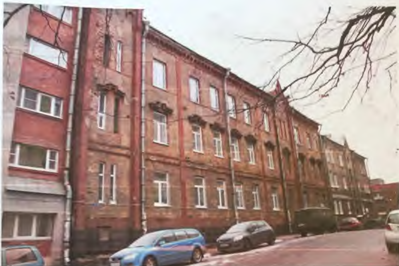
Фото 7. Юго-западный фасад здания. Автор фото: Маланичева Г.И. 29.11.2016 г
