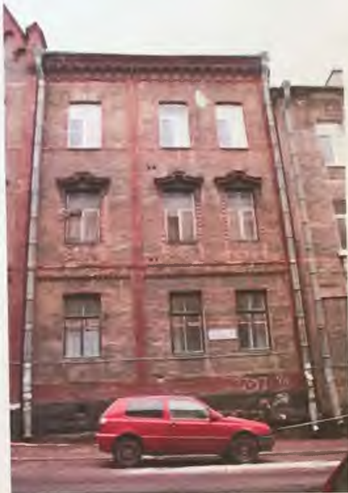
Фото 3. Юго-западный фасад. Автор фото: Маланичева Г.И. 29.11.2016 г.
