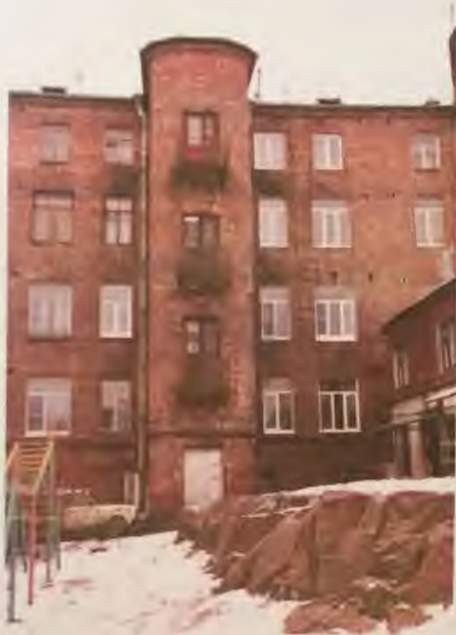
Фото 12. Общий вид здания с северо-востока. Автор фото: Маланичева Г.И. 29.11.2016 г
