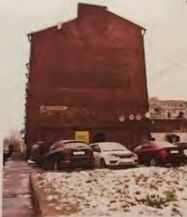
Фото 9. Юго-восточный фасад здания. Автор фото: Маланичева Г.И. 29.11.2016 г.
