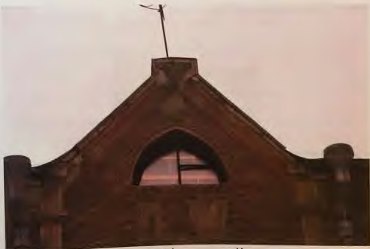
Фото 4.4. Юго-западный фасад здания. Центральная часть. Автор фото: Маланичева Г.И. 29.11.2016 г.
