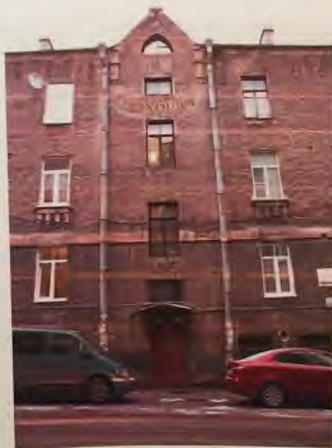
Фото 4. Юго-западный фасад здания. Центральная часть. Автор фото: Маланичева Г.И. 29.11.2016 г.
