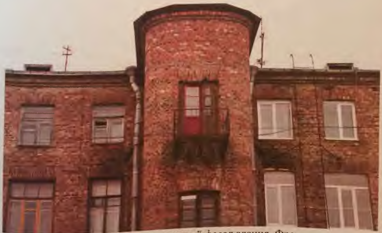
Фото 12.1. Северо-восточный фасад здания. Фрагмент. Автор фото: Маланичева Г.И. 29.11.2016 г.
