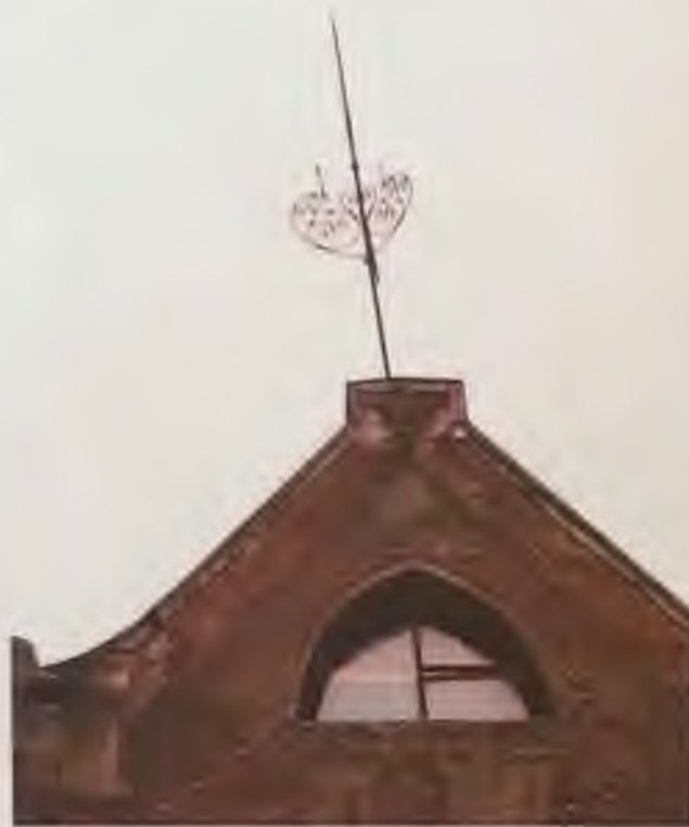
Фото 4.5. Юго-западный фасад здания. Центральная часть. Автор фото: Маланичева Г.И. 29.11.2016 г.
