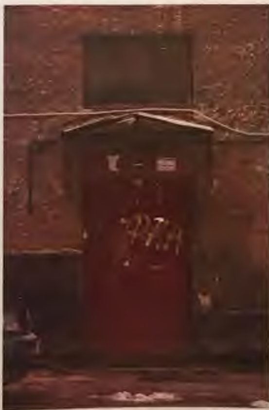
Фото 7. Юго-западный фасад здания. Главный вход. Автор фото: Маланичева Г.И. 29.11.2016 г.
