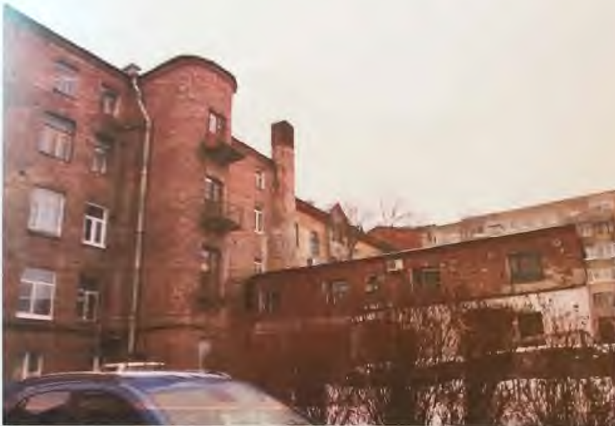
Фото 10. Общий вид здания с северо-востока. Автор фото: Маланичева Г.И. 29.11.2016 г.
