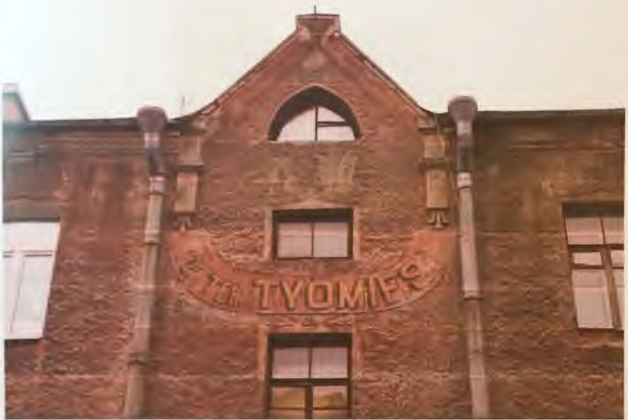
Фото 4.1. Юго-западный фасад здания. Центральная часть. Автор фото: Маланичева Г.И. 29.11.2016 г.
