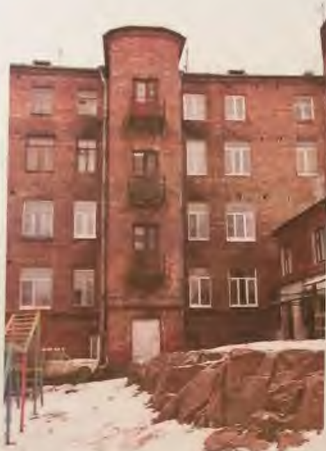
Фото 12. Общий вид здания с северо-востока. Автор фото: Маланичева Г.И. 29.11.2016 г
