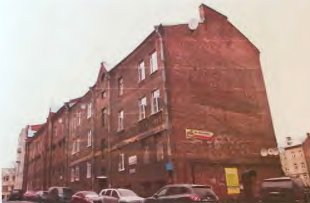
Фото 1. Общий вид здания с юго-востока. Автор фото: Маланичева Г.И. 29.11.2016 г.
