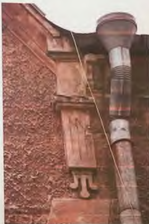
Фото 4.3. Юго-западный фасад здания. Центральная часть. Автор фото: Маланичева Г.И. 29.11.2016 г.
