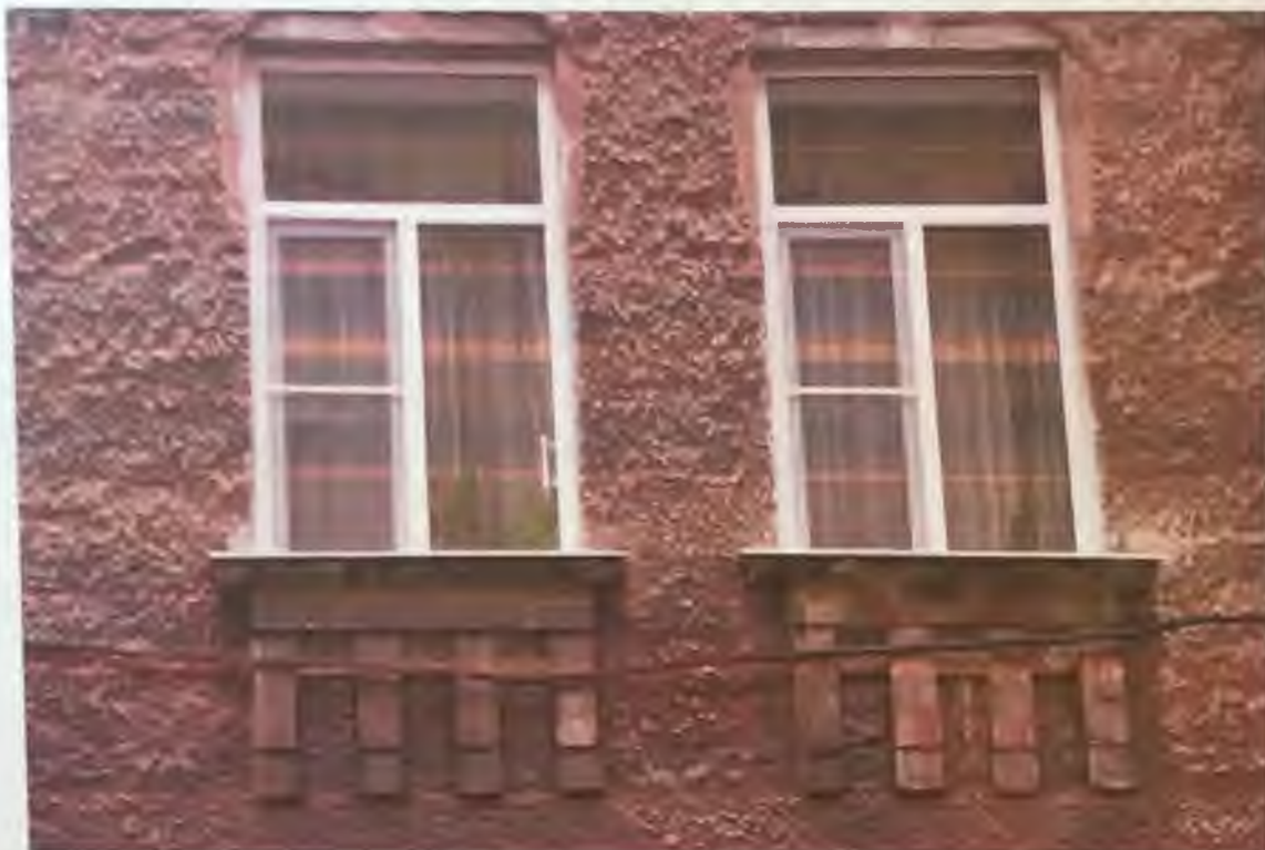
Фото 3.2. Западный фасад здания. Фрагмент. Автор фото: Маланичева Г.И. 29.11.2016 г.
