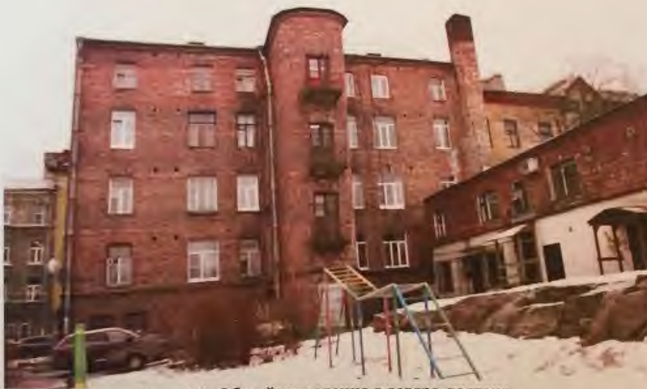
Фото 11. Общий вид здания с северо-востока. Автор фото: Маланичева Г.И. 29.11.2016 г.
