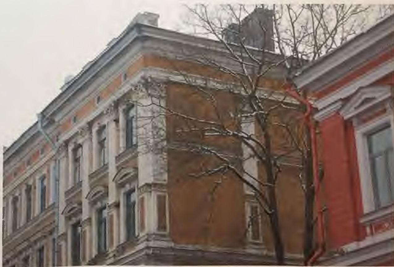
Фото.7.1. Северный фасад здания. Фрагмент. Автор фото: Маланичева Г.И. 30.11.2016 г.
