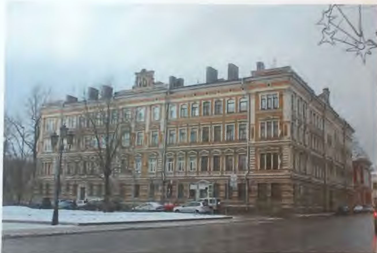
Фото 3. Общий вид здания с юго-востока. Автор фото: Маланичева Г.И. 30.11.2016 г.
