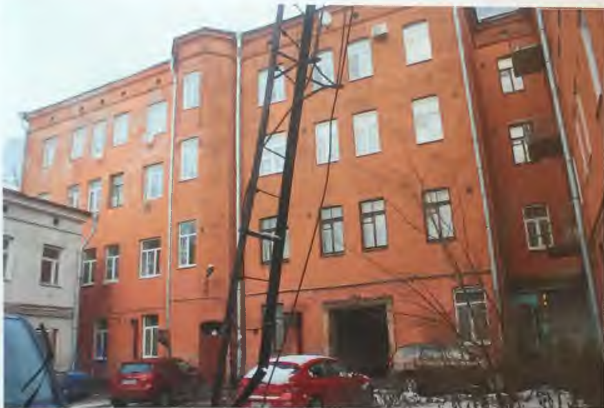
Фото.6.2. Западный фасад здания. Фрагмент. Автор фото: Маланичева Г.И. 30.11.2016 г.
