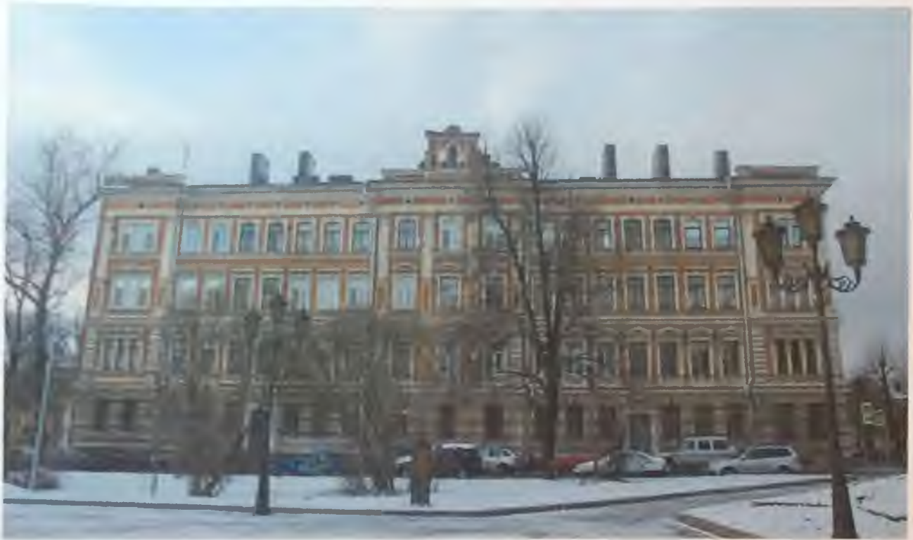
Фото 1. Общй вид здания с юга. Автор фото: Маланичева Г.И. 30.11.2016 г.
