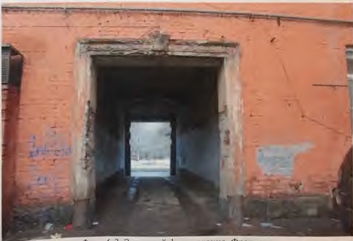
Фото.6.3. Западный фасад здания. Фрагмент. Автор фото: Маланичева Г.И. 30.11.2016 г.
