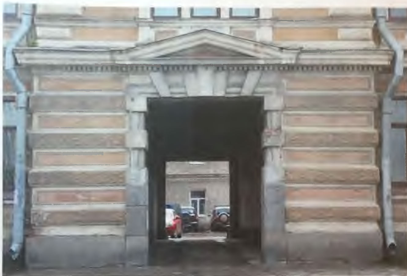
Фото 5.3. Восточный фасад здания. Фрагмент. Автор фото: Маланичева Г.И. 30.11.2016 г.
