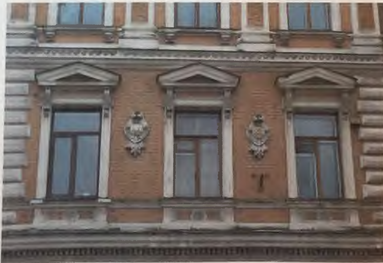
Фото 5.1. Восточный фасад здания. Фрагмент. Автор фото: Маланичева Г.И. 30.11.2016 г.
