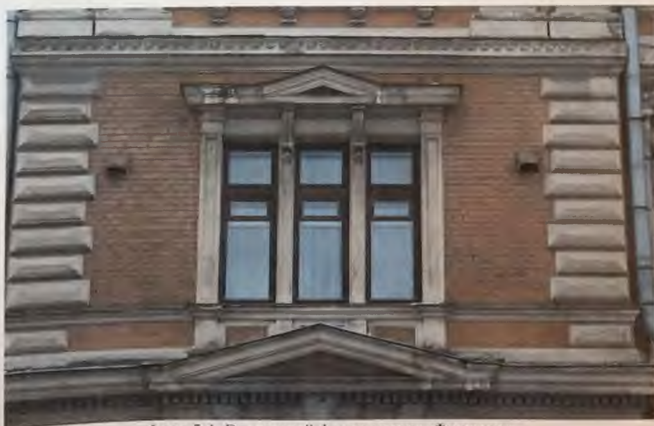
Фото.5.4. Восточный фасад здания. Фрагмент. Автор фото: Маланичева Г.И. 30.11.2016 г.
