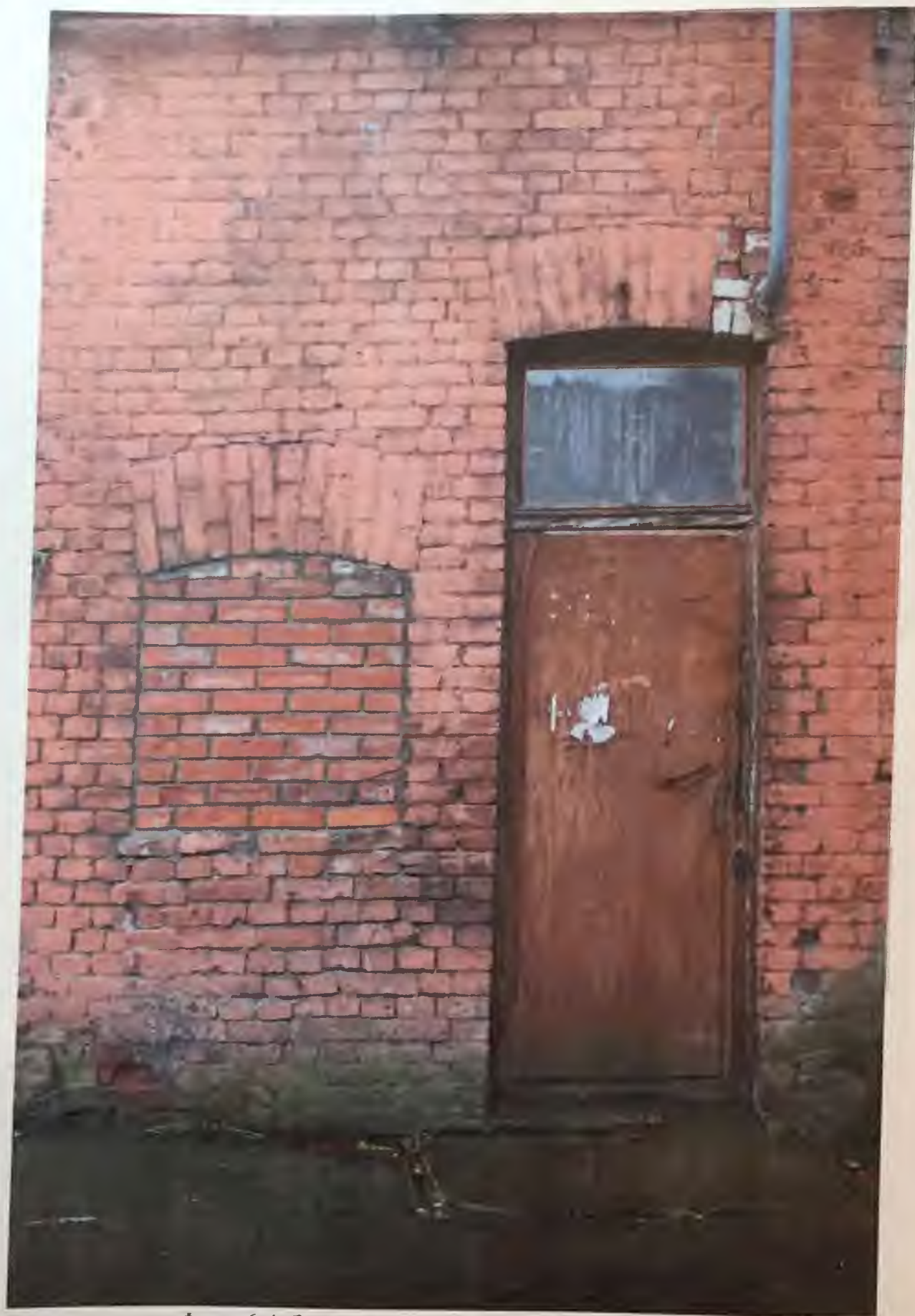
Фото.6.4. Западный фасад здания. Фрагмент. Автор фото: Маланичева Г.И. 30.11.2016 г.
