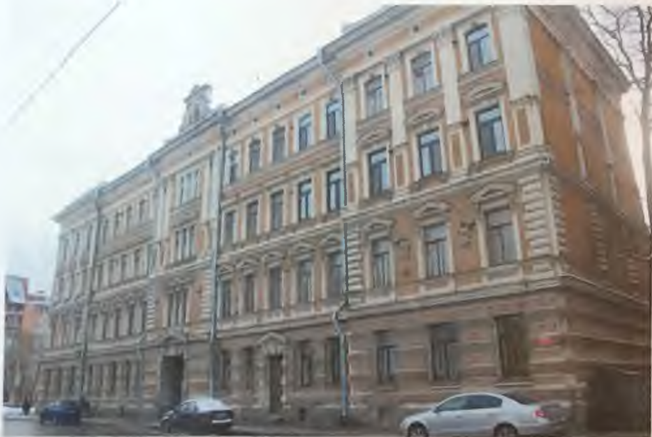
Фото 5. Восточный фасад здания. Вид с севера. Автор фото: Маланичева Г.И. 30.11.2016 г.
