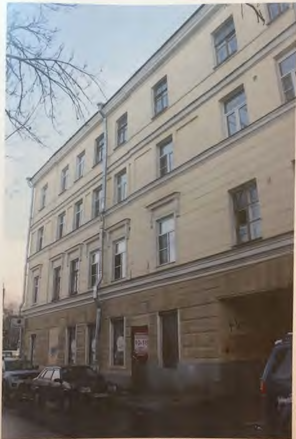
Фото 5. Северный фасад здания. Фрагмент. Автор фото: Маланичева Г.И. 30.11.2016 г.
