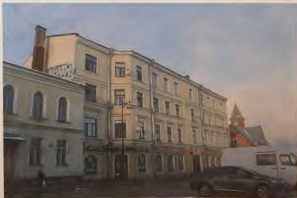
Фото 2. Восточный фасад здания. Вид с юга. Автор фото: Маланичева Г.И. 30.11.2016 г.
