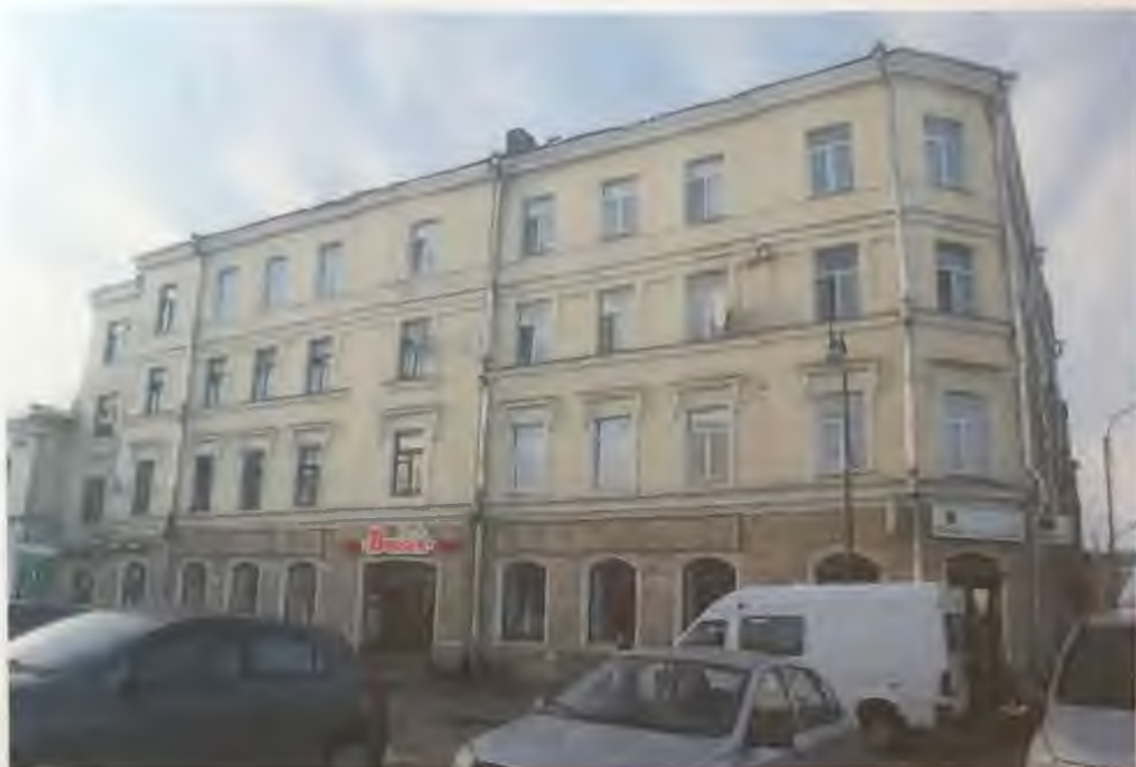
Фото 1. Общий вид здания с востока. Автор фото: Маланичева Г.И. 30.11.2016 г.
