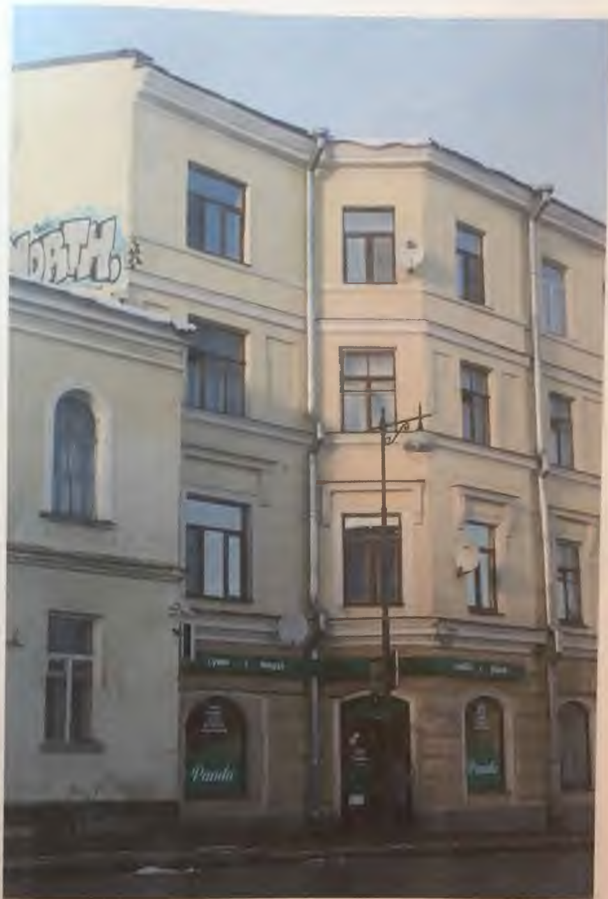
Фото 2.1. Восточный фасад здания. Фрагмент. Автор фото: Маланичева Г.И. 30.11.2016 г.
