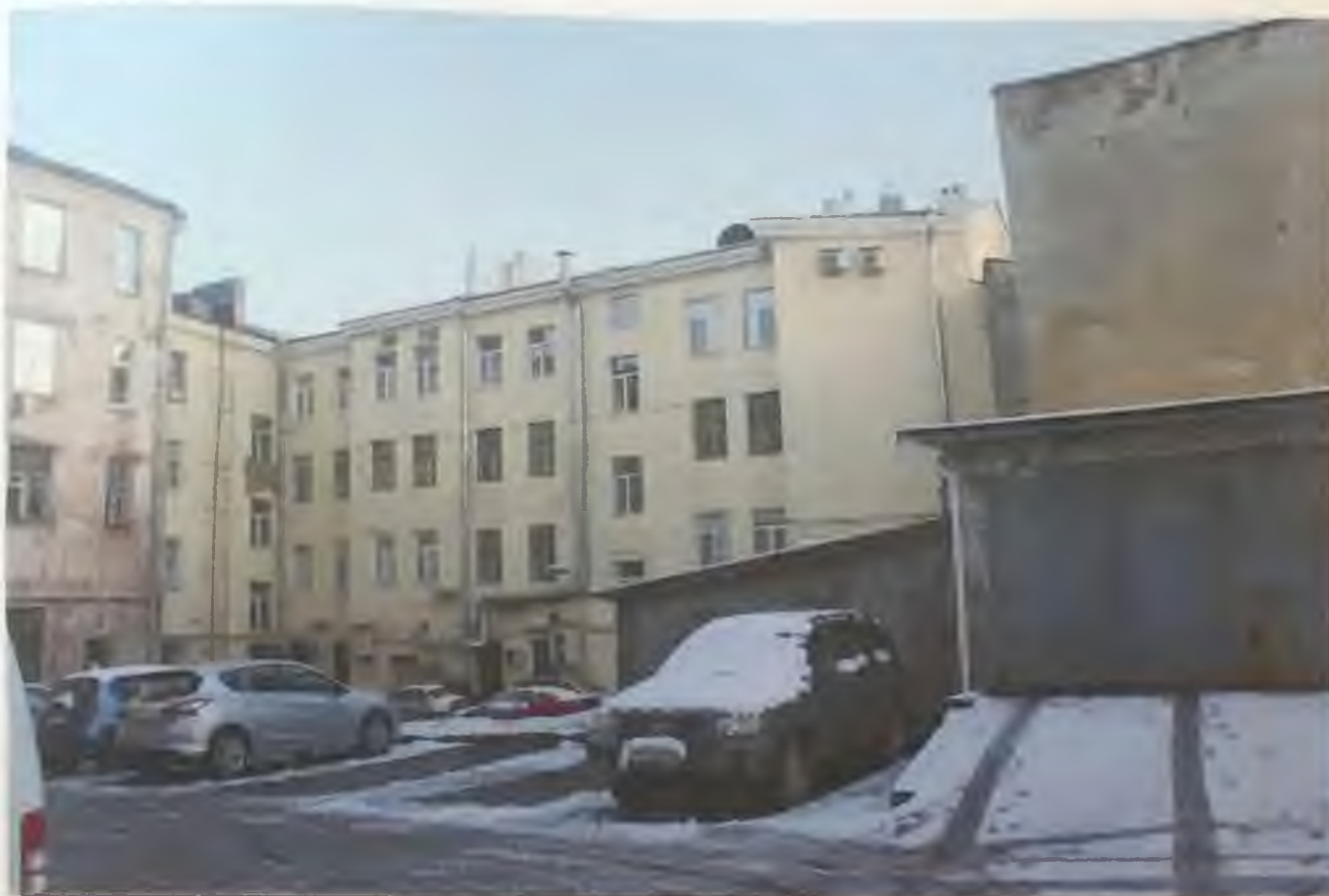
Фото 6. Западный фасад здания. Общий вид. Автор фото: Маланичева Г.И. 30.11.2016 г.
