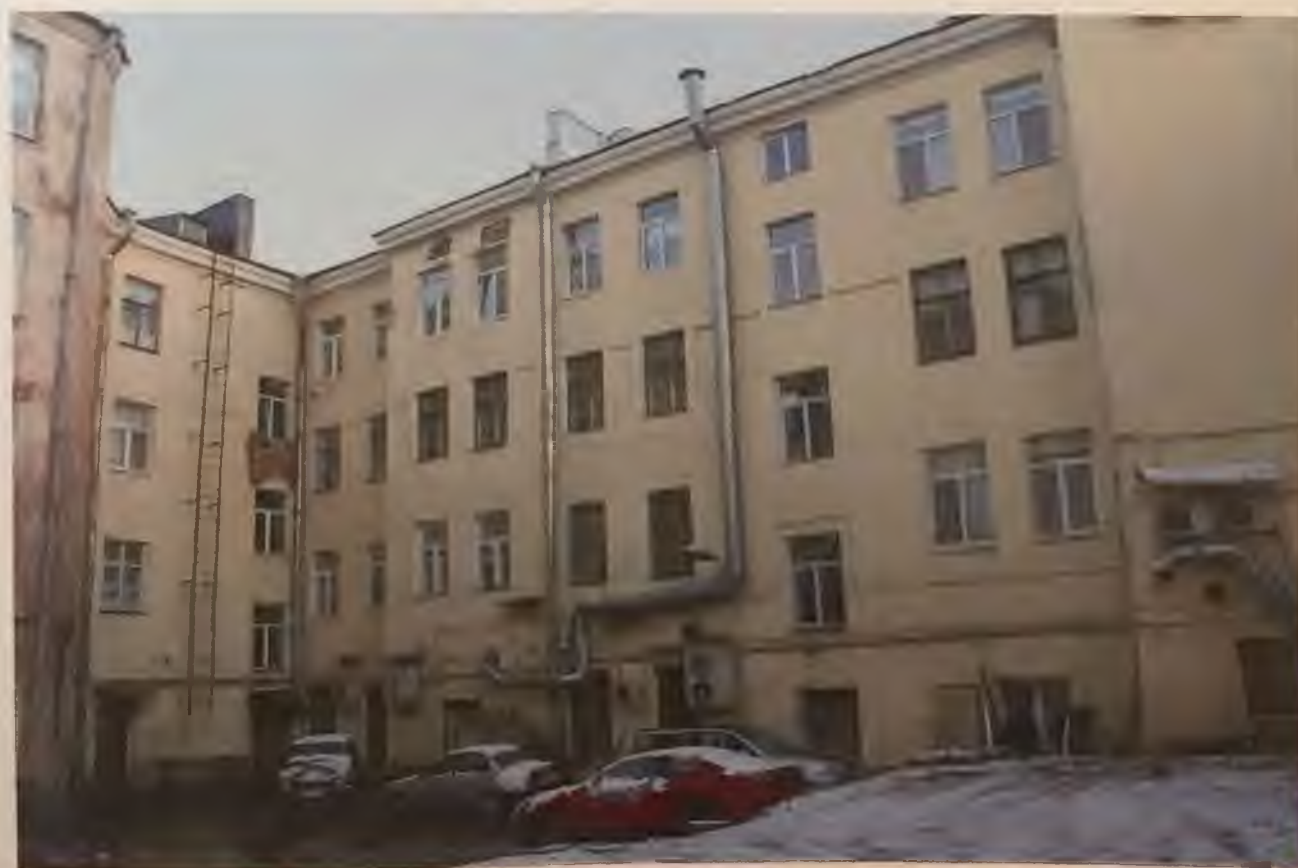
Фото 6.1. Западный фасад здания. Фрагмент. Автор фото: Маланичева Г.И. 30.11.2016 г.
