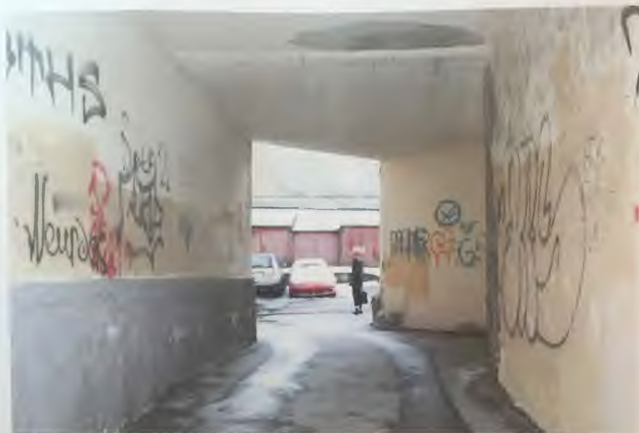
Фото 5.2. Северный фасад здания. Фрагмент. Автор фото: Маланичева Г.И. 30.11.2016 г.
