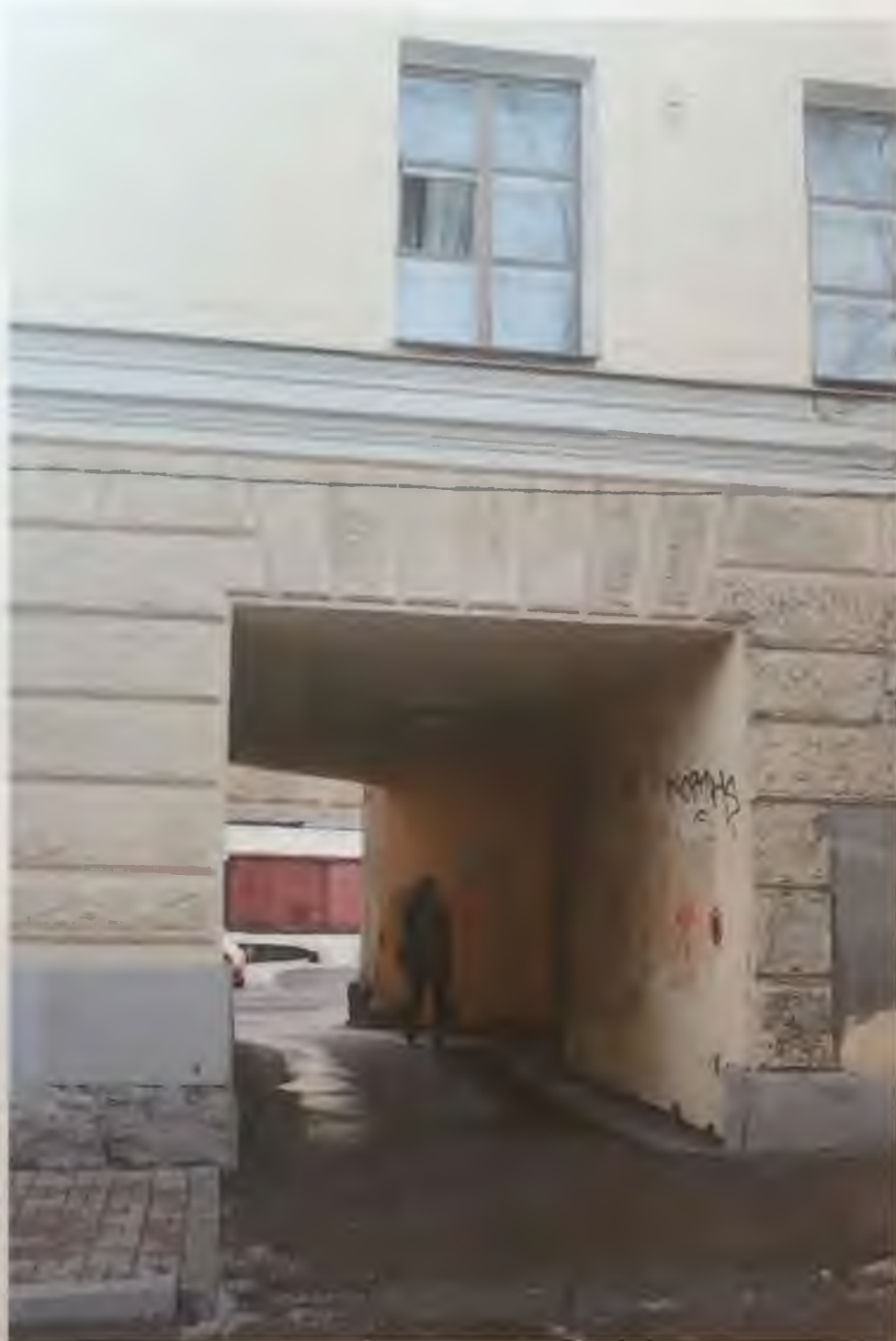
Фото 5.1. Северный фасад здания. Фрагмент. Автор фото: Маланичева Г.И. 30.11.2016 г.
