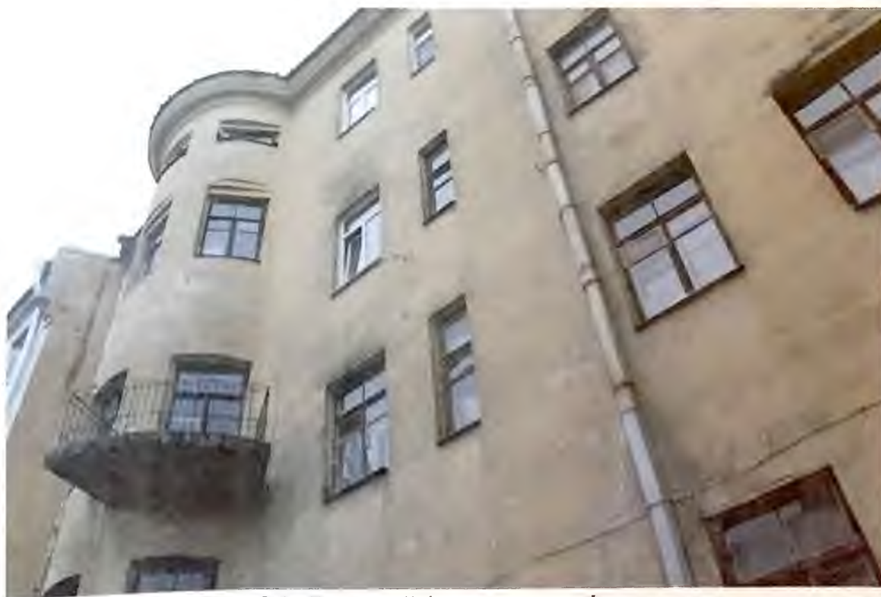
Фото 3.1. Северный фасад здания. Фрагмент. Автор фото: Маланичева Г.И. 30.11.2016 г.
