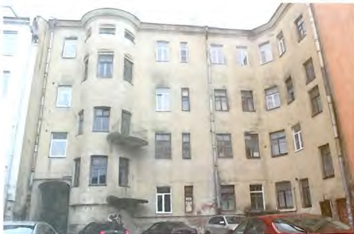
Фото 3. Северный фасад здания. Фрагмент. Автор фото: Маланичева Г.И. 30.11.2016 г.
