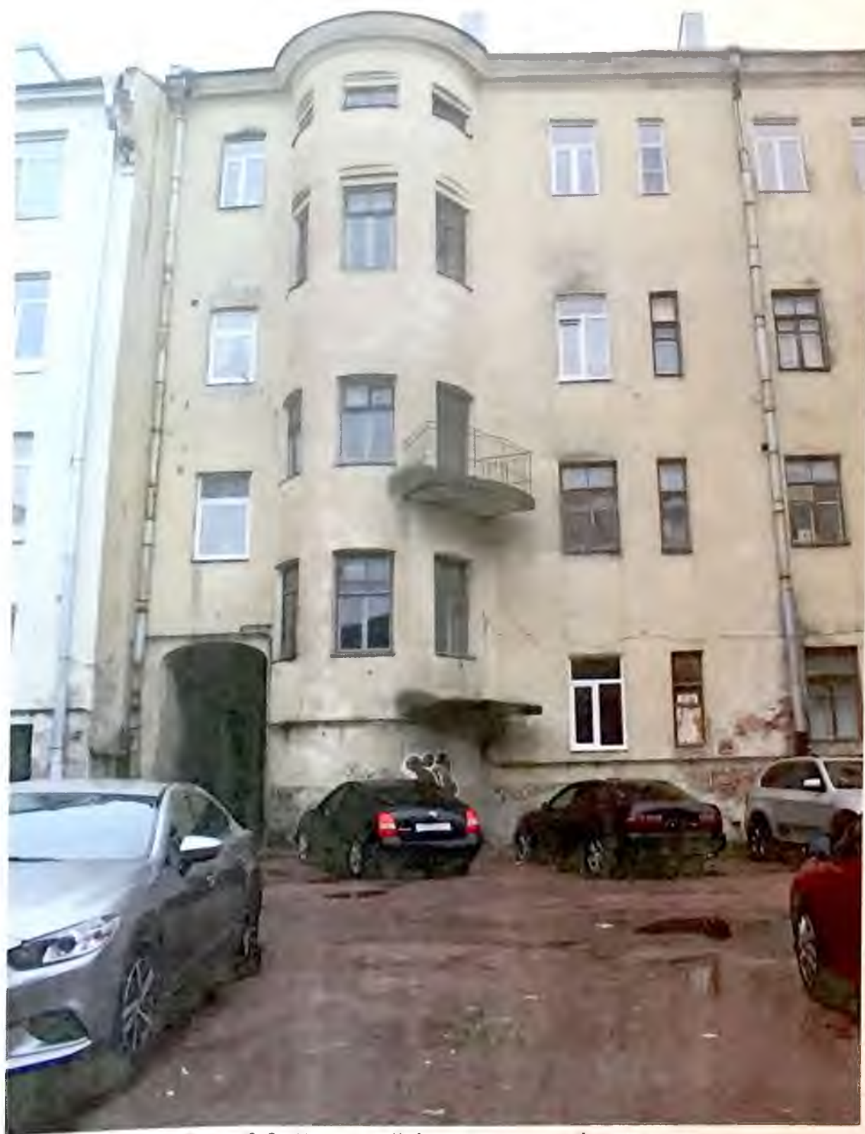
Фото 3.2. Северный фасад здания. Фрагмент. Автор фото: Маланичева Г.И. 30.11.2016 г.
