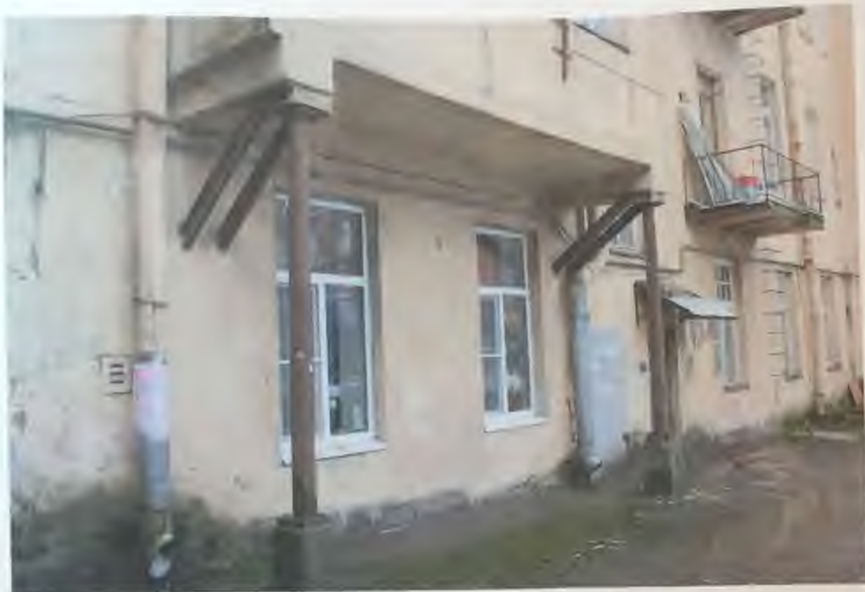
Фото 5.5. Северный фасад здания. Фрагмент. Автор фото: Маланичева Г.И. 30.11.2016 г.
