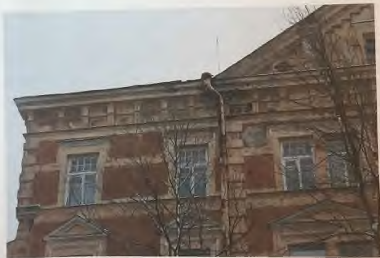
Фото 4.3. Западный фасад здания. Фрагмент. Автор фото: Маланичева Г.И. 30.11.2016 г.
