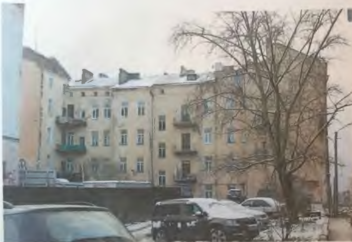
Фото 5. Северный фасад здания. Общий вид. Автор фото: Маланичева Г.И. 30.11.2016 г.
