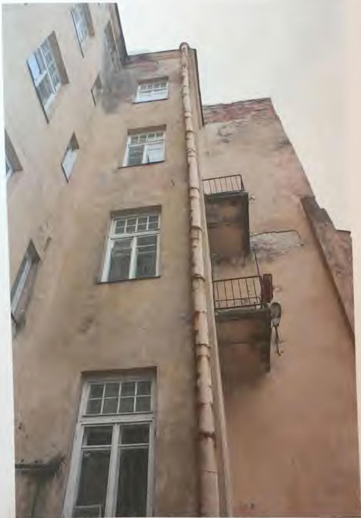
Фото 5.3. Северный фасад здания. Фрагмент. Автор фото: Маланичева Г.И. 30.11.2016 г.
