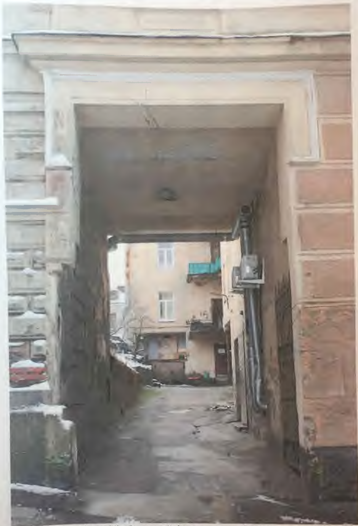
Фото 4.1., Западный фасад здания. Фрагмент. Автор фото: Маланичева Г.И. 30.11.2016 г.
