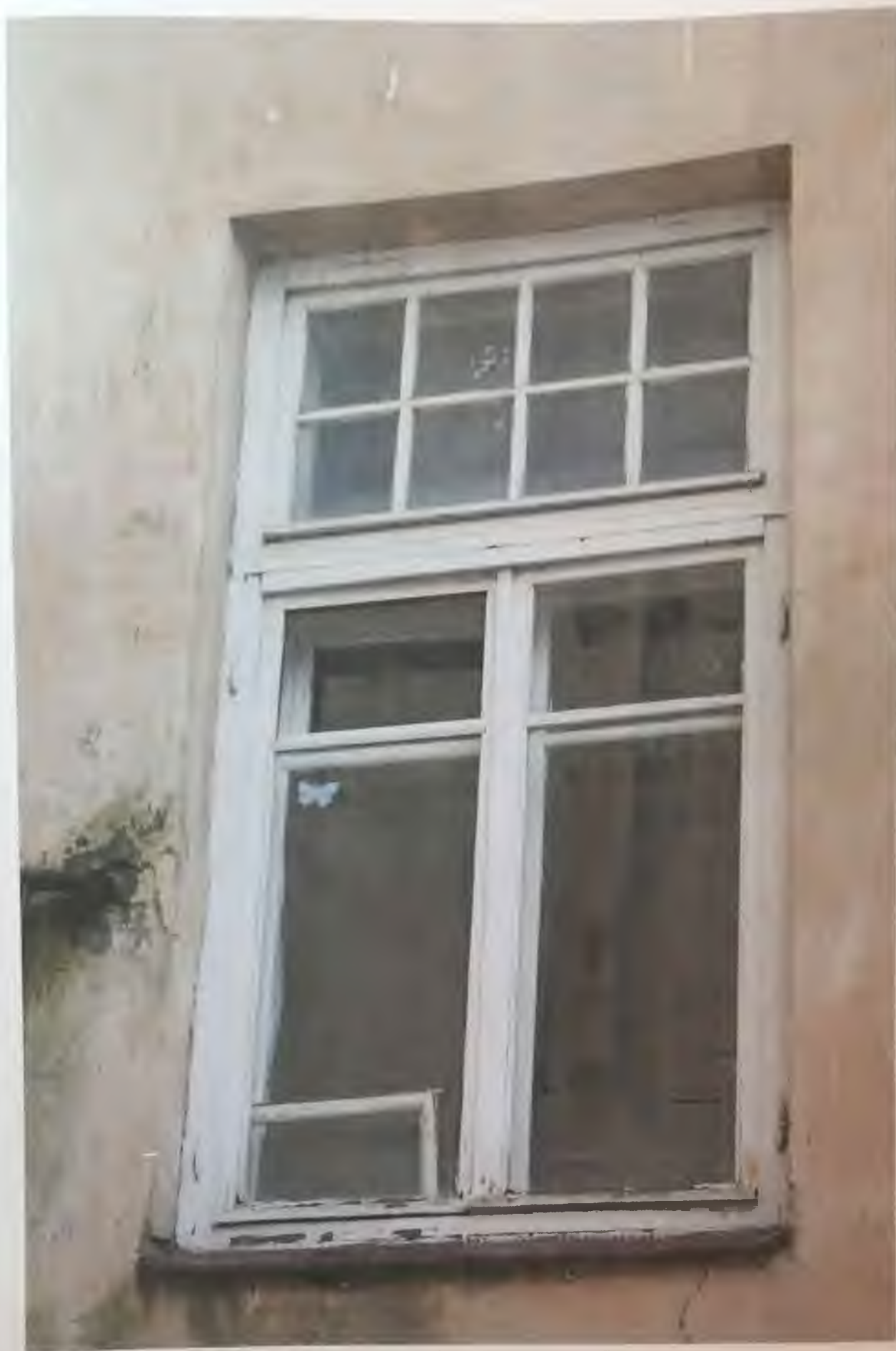
Фото 5.7. Северный фасад здания. Фрагмент. Автор фото: Маланичева Г.И. 30.11.2016 г.
