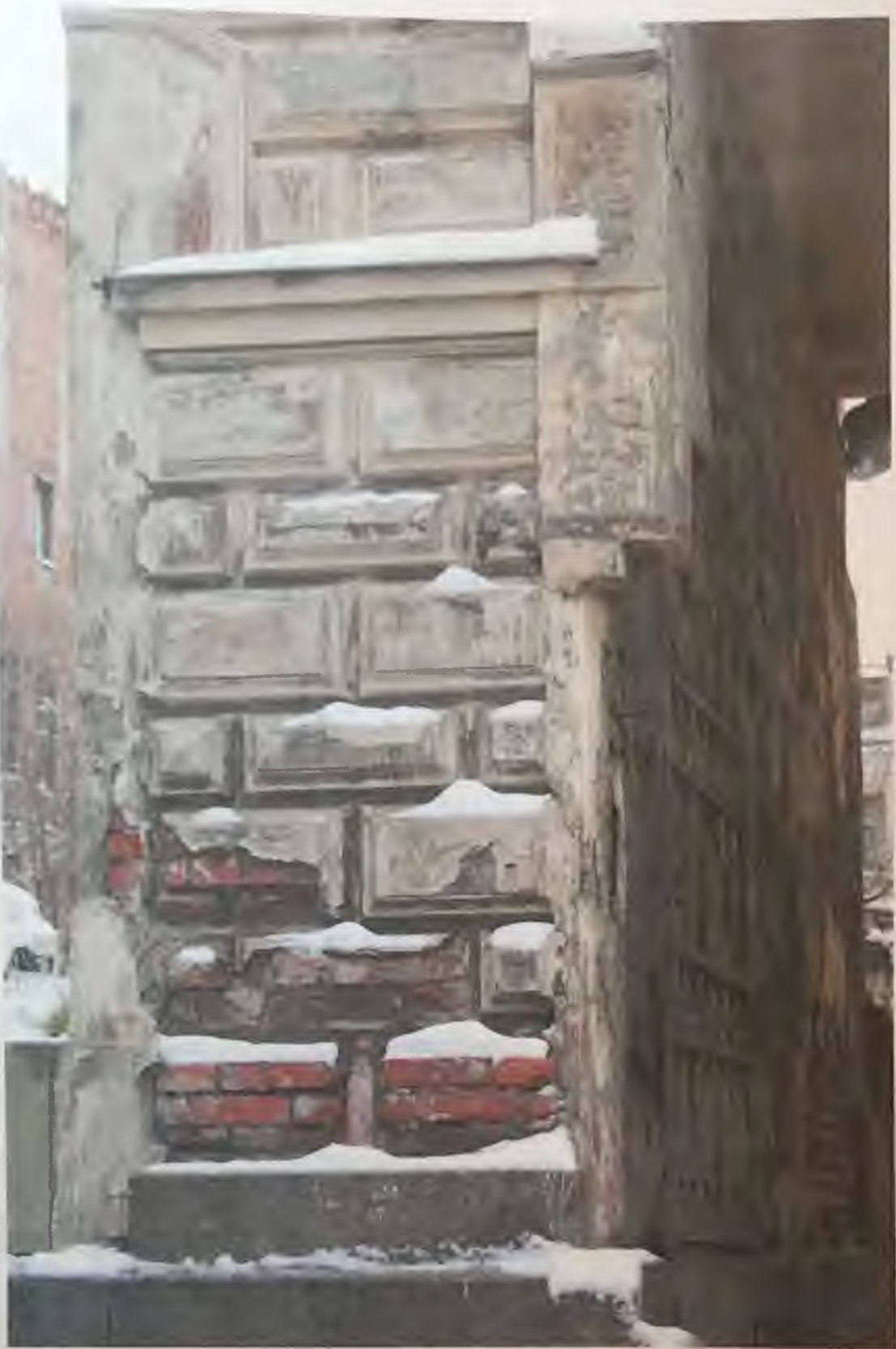
Фото 4.4. Западный фасад здания. Фрагмент. Автор фото: Маланичева Г.И. 30.11.2016 г.
