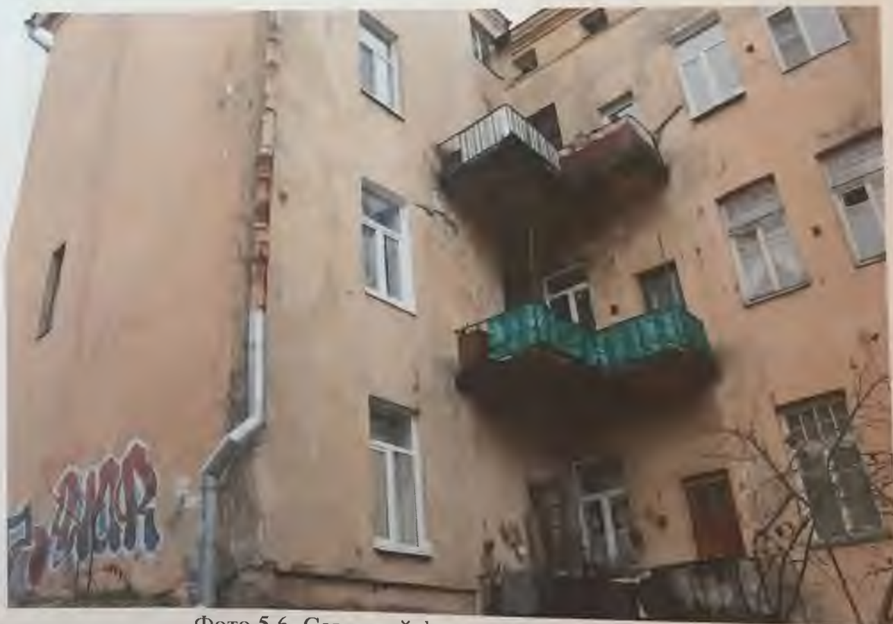
Фото 5.6. Северный фасад здания. Фрагмент. Автор фото: Маланичева Г.И. 30.11.2016 г.
