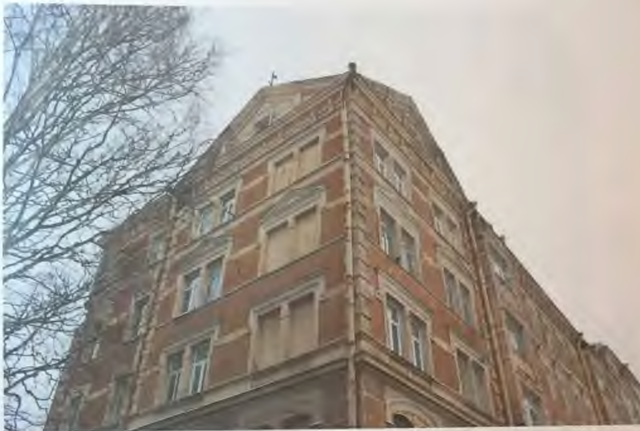
Фото 3.1. Южный и западный фасады здания. Фрагмент. Автор фото: Маланичева Г.И. 30.11.2016 г.
