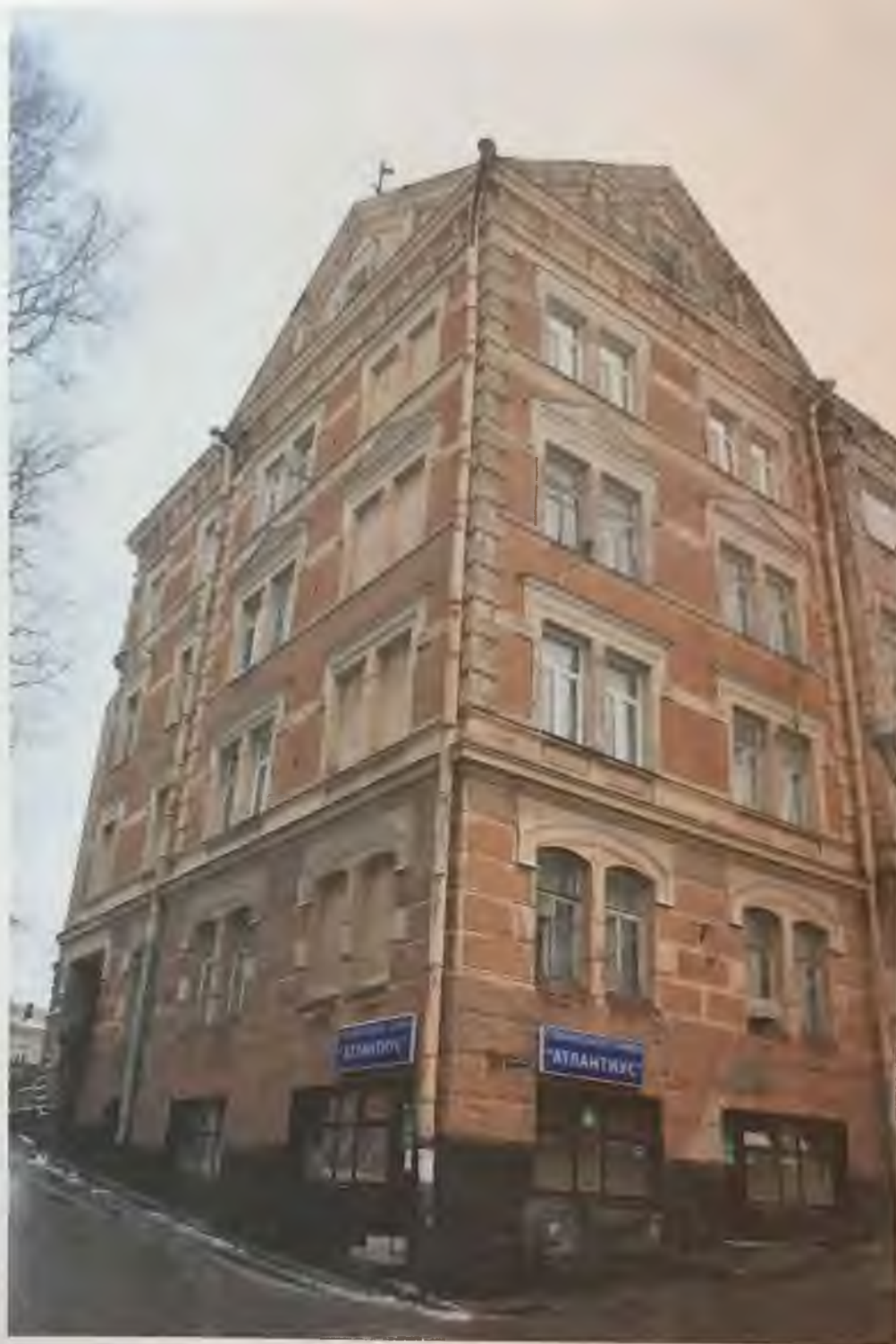
Фото 3. Южный и западный фасады здания. Фрагмент. Автор фото: Маланичева Г.И. 30.11.2016 г.
