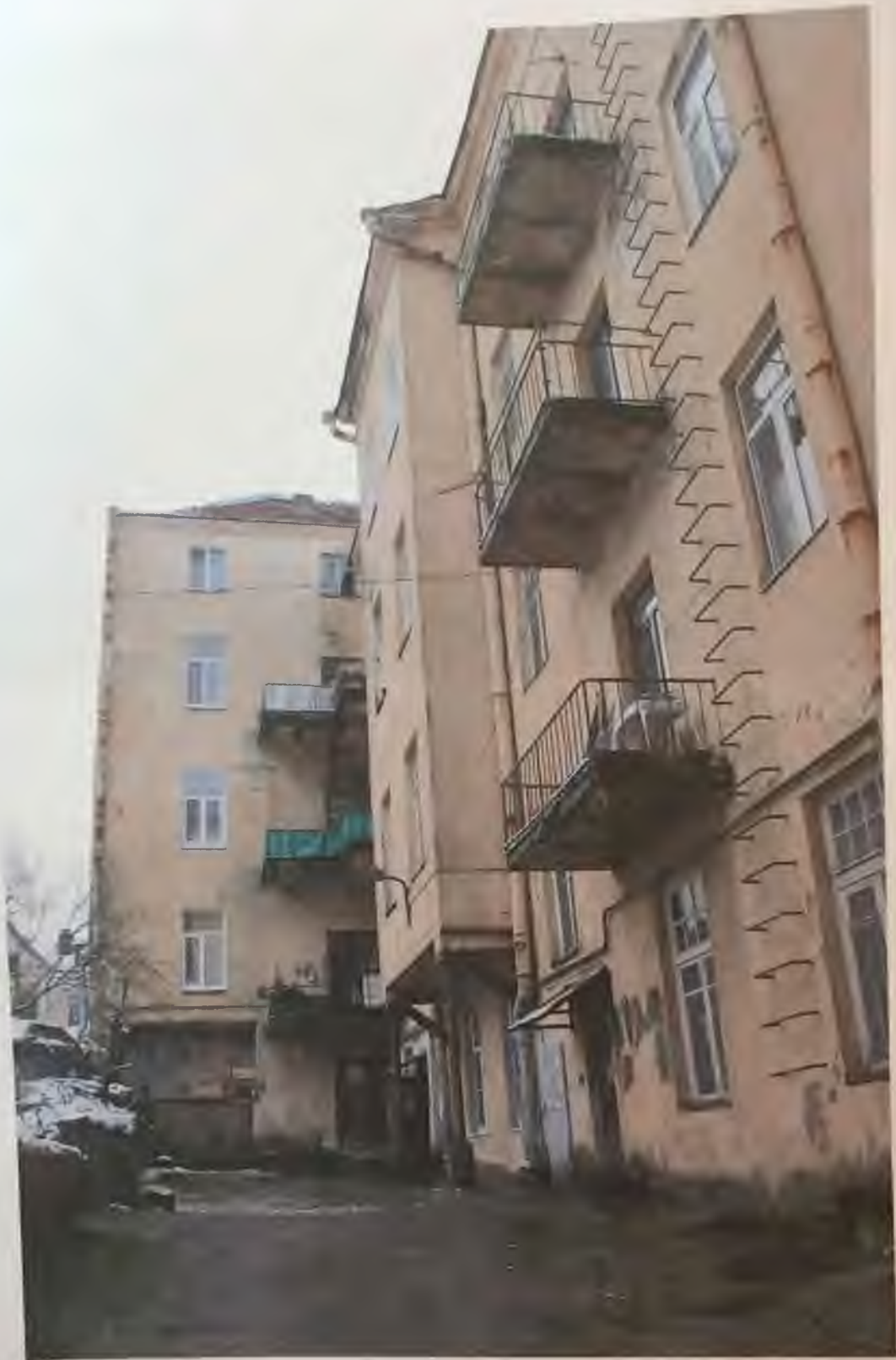
Фото 5.4. Северный фасад здания. Фрагмент. Автор фото: Маланичева Г.И. 30.11.2016 г.
