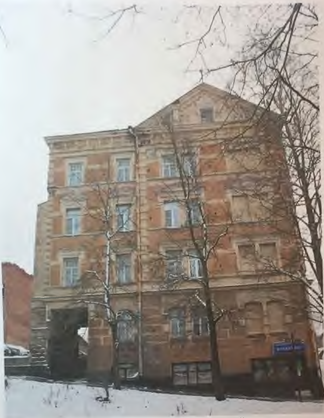
Фото 4. Западный фасад здания. Общий вид. Автор фото: Маланичева Г.И. 30.11.2016 г.
