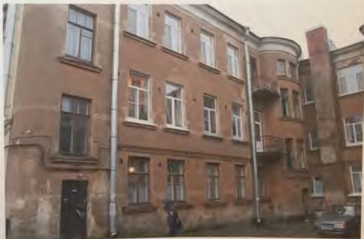
Фото 6. Северный фасад здания. Фрагмент. Автор фото: Маланичева Г.И. 30.11.2016 г.
