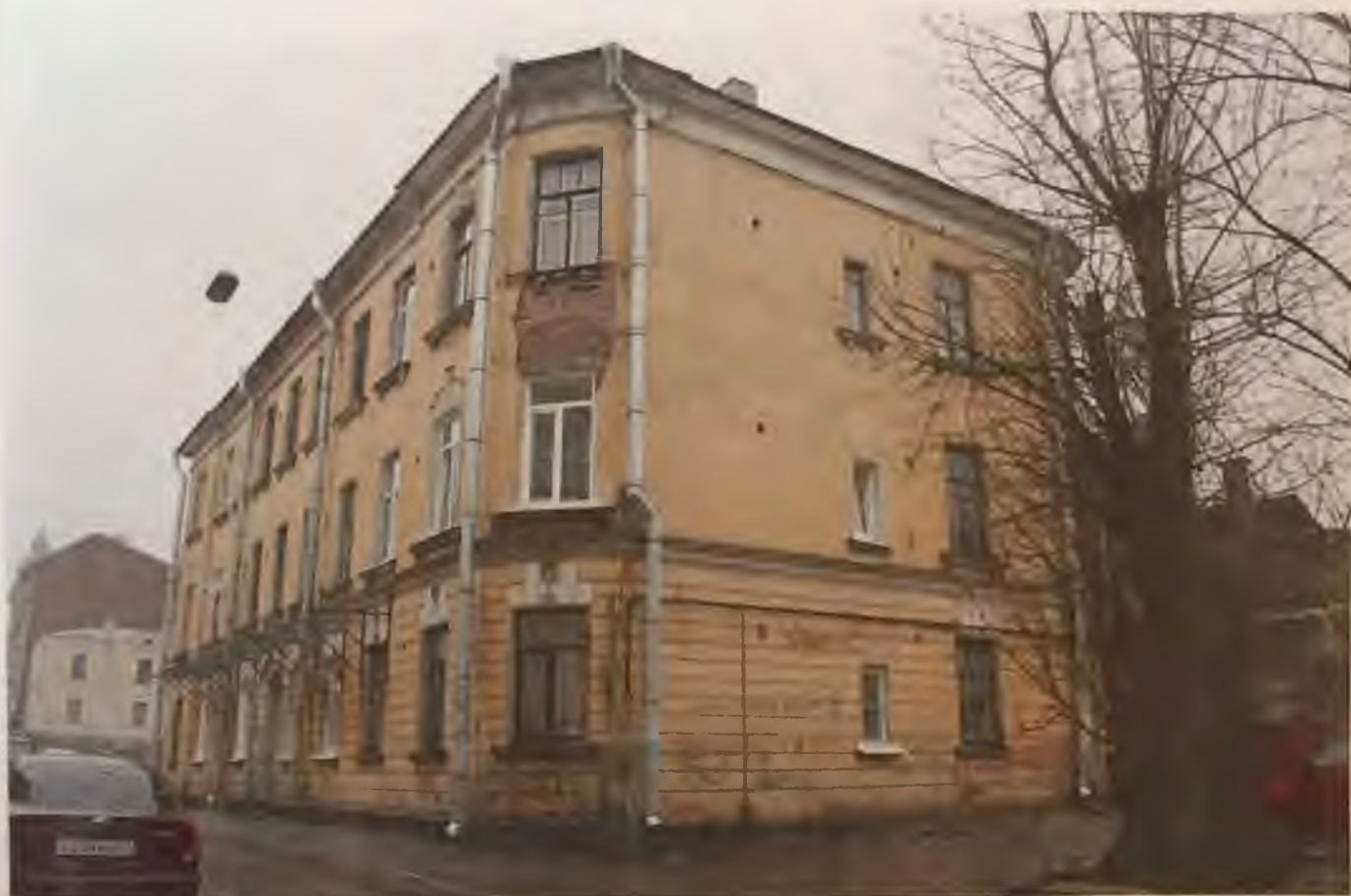
Фото 4. Юго-восточный угол здания. Общий вид. Автор фото: Маланичева Г.И. 30.11.2016 г.
