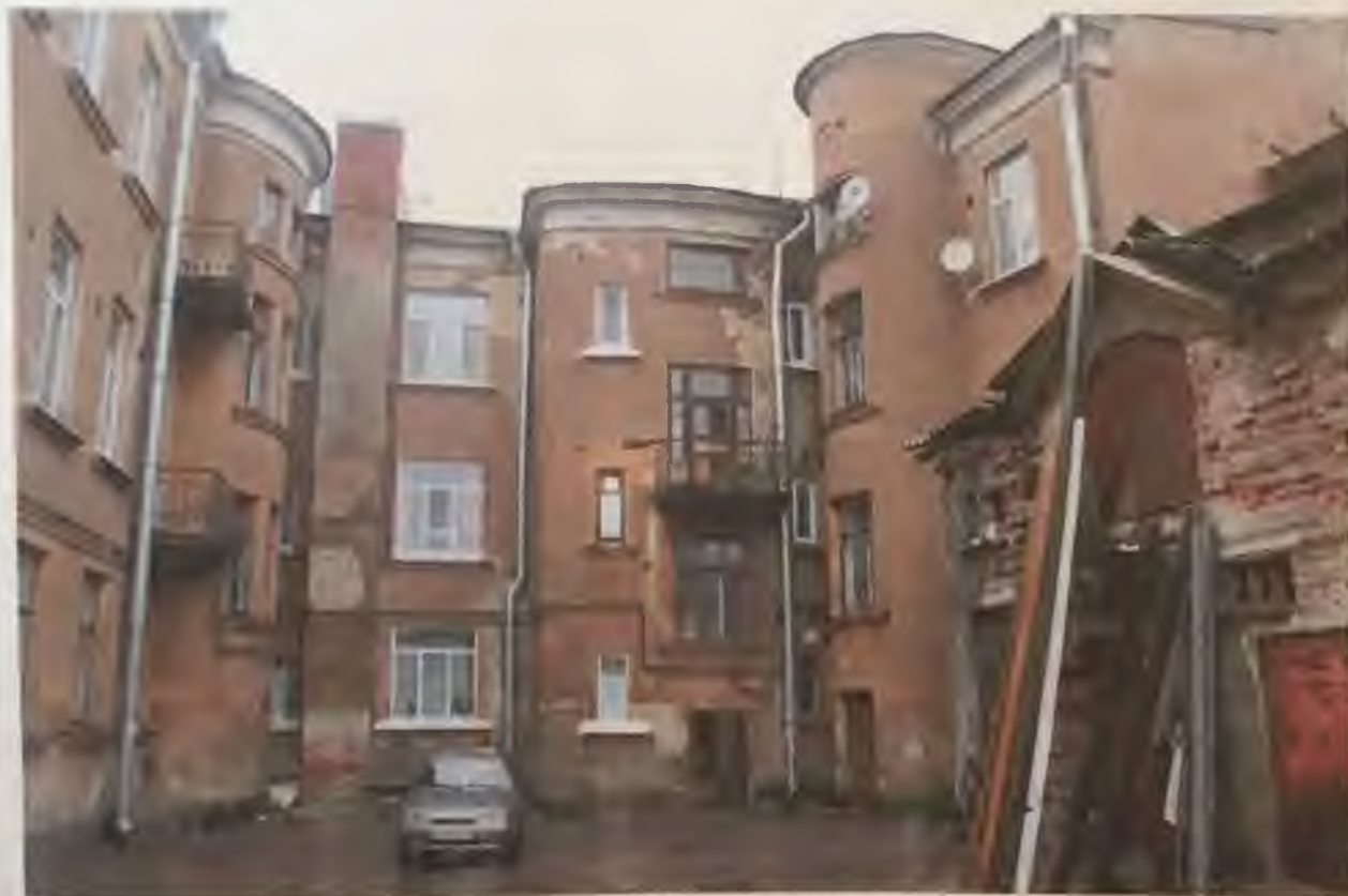
Фото.7. Восточный фасад здания. Фрагмент. Автор фото: Маланичева Г.И. 30.11.2016 г.
