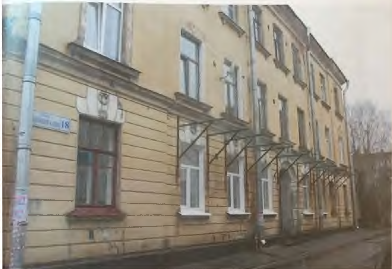
Фото 3. Южный фасад здания. Фрагмент. Автор фото: Маланичева Г.И. 30.11.2016 г.
