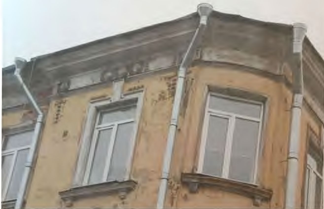
Фото 2.1. Южный фасад здания. Фрагмент. Автор фото: Маланичева Г.И. 30.11.2016 г.
