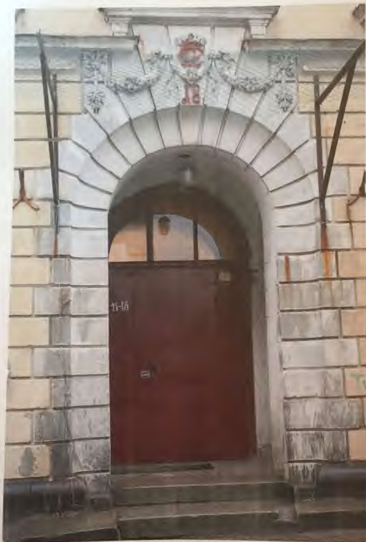
Фото 3.2. Южный фасад здания. Фрагмент. Автор фото: Маланичева Г.И. 30.11.2016 г.
