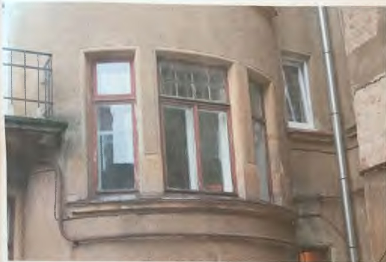
Фото 6.1. Северный фасад здания. Фрагмент. Автор фото: Маланичева Г.И. 30.11.2016 г.
