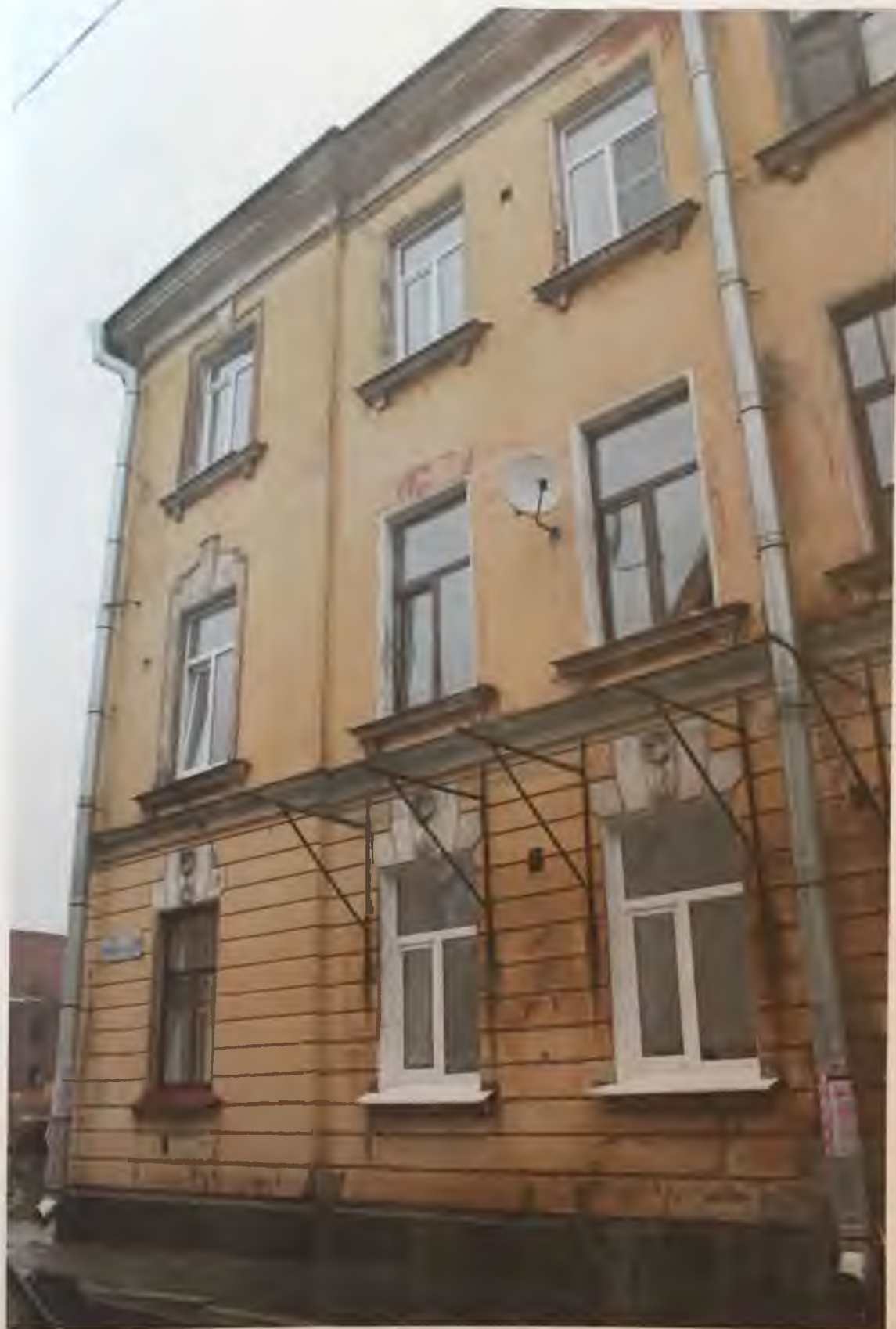
Фото. 3.1. Южный фасад здания. Фрагмент. Автор фото: Маланичева Г.И. 30.11.2016 г.
