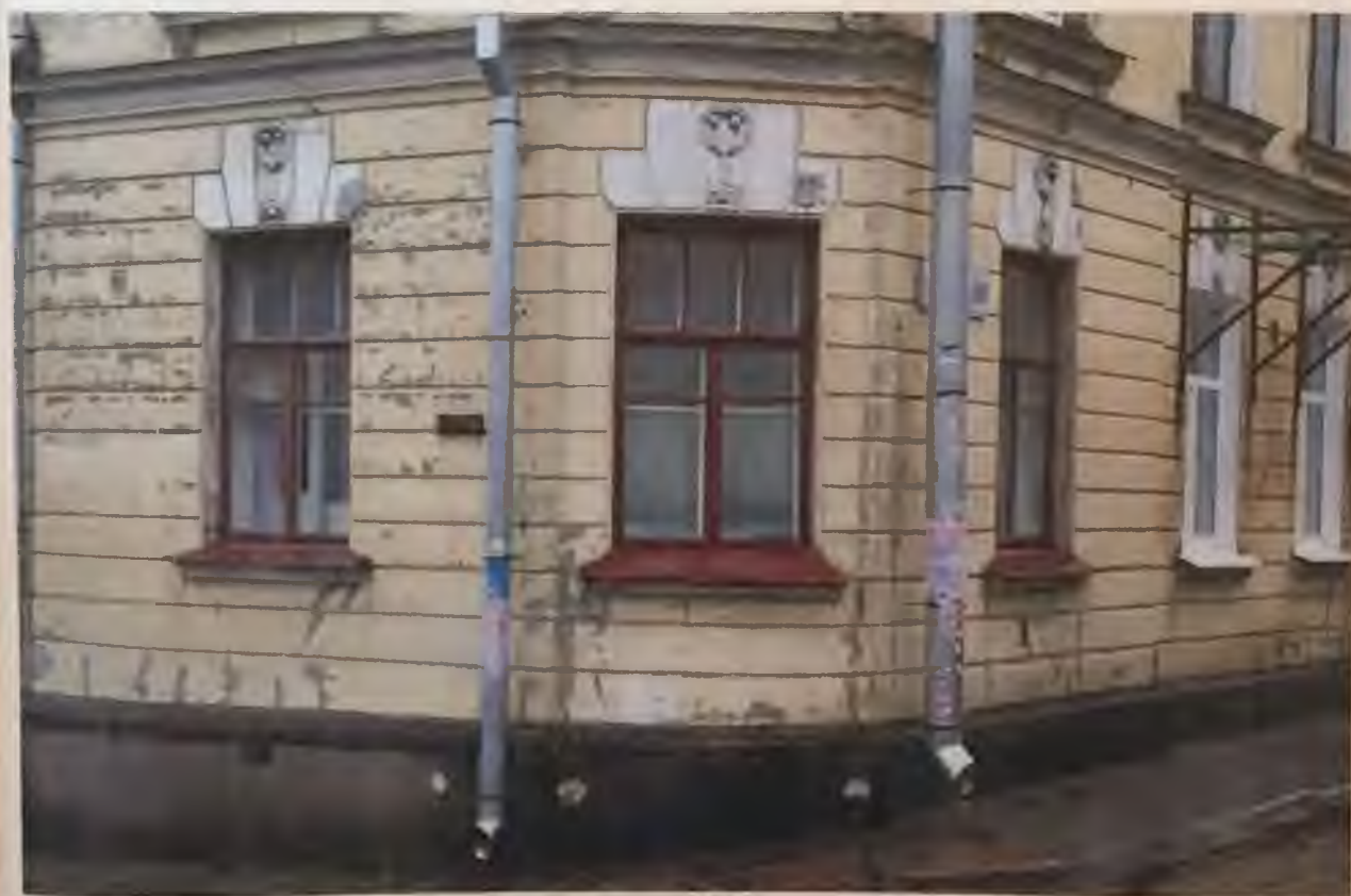
Фото 2.2. Южный и западный фасады здания. Фрагмент. Автор фото: Маланичева Г.И. 30.11.2016 г.
