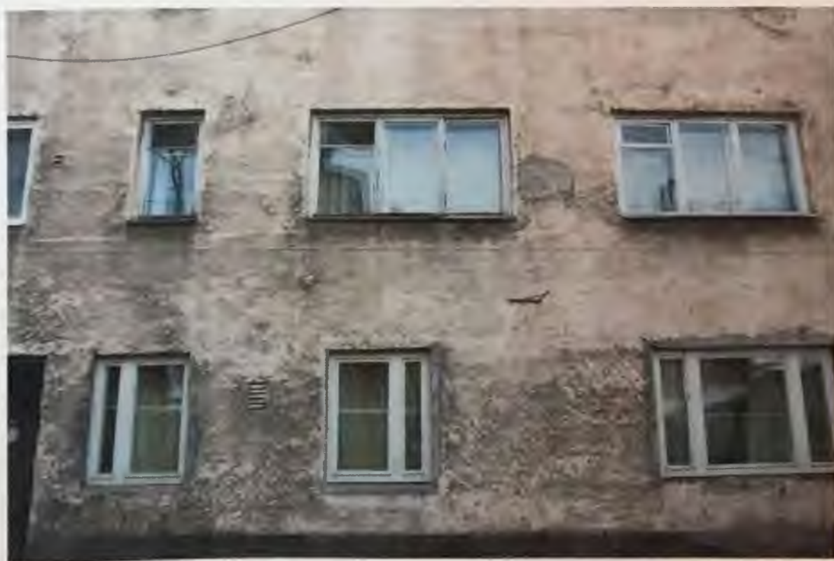
Фото 8.2. Северный фасад здания. Фрагмент. Автор фото: Маланичева Г.И. 30.11.2016 г.
