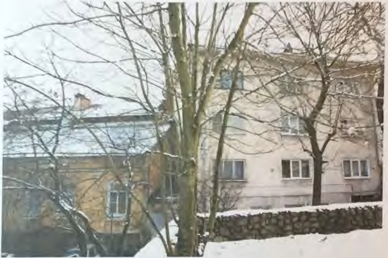
Фото 19. Западный фасад здания. Автор фото: Маланичева Г.И. 30.11.2016 г.
