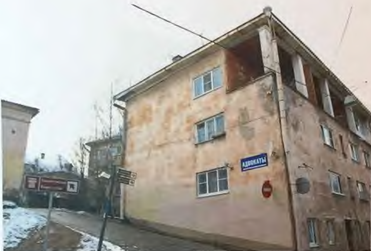
Фото 3. Общий вид здания с востока. Автор фото: Маланичева Г.И. 30.11.2016 г.
