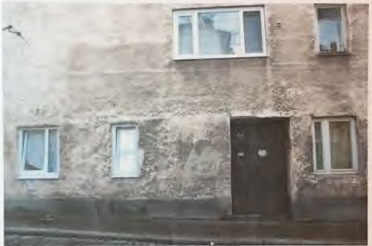
Фото 9. Северный фасад здания. Фрагмент. Автор фото: Маланичева Г.И. 30.11.2016 г.
