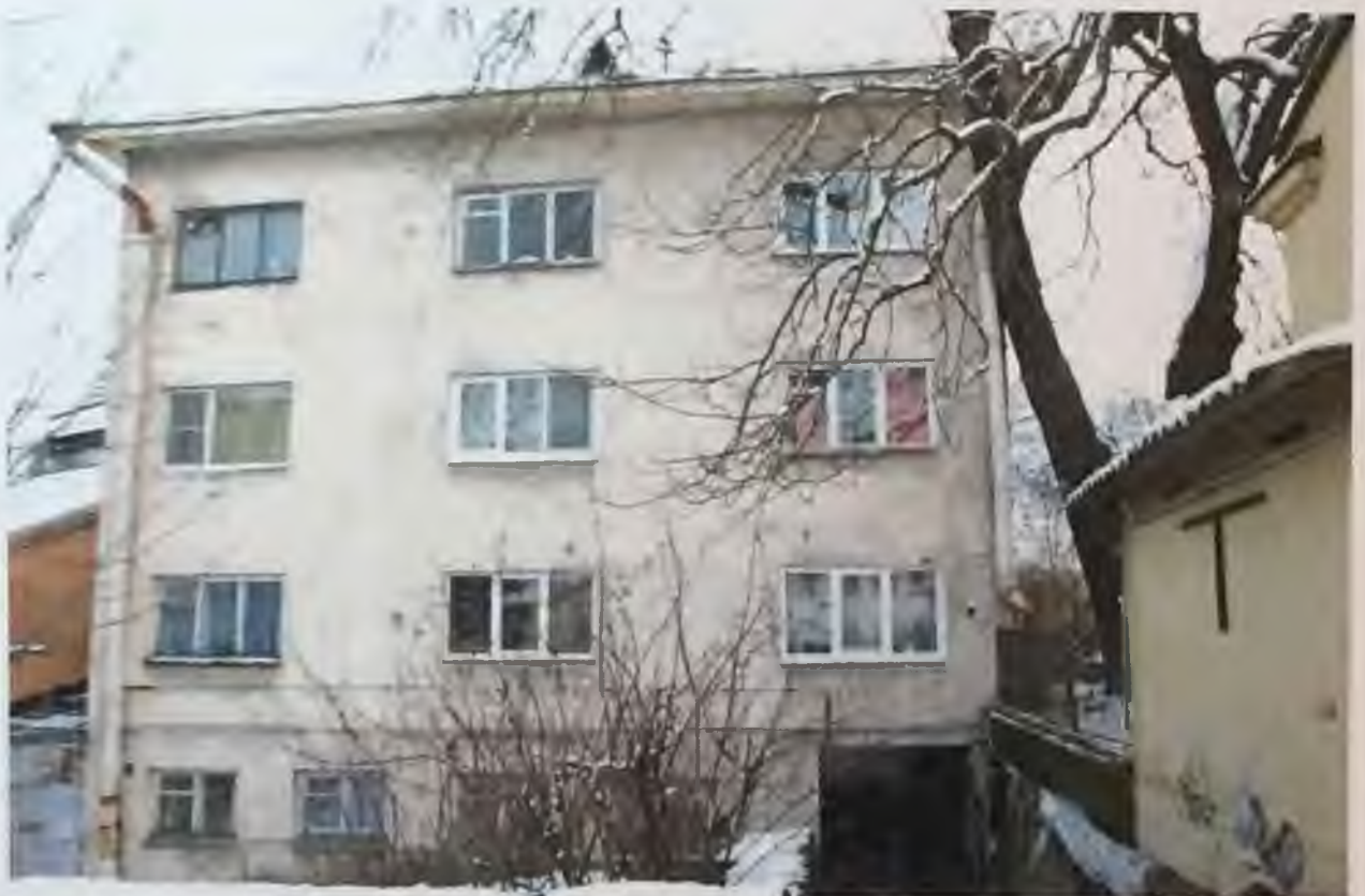
Фото 18. Западный фасад здания. Автор фото: Маланичева Г.И. 30.11.2016 г.
