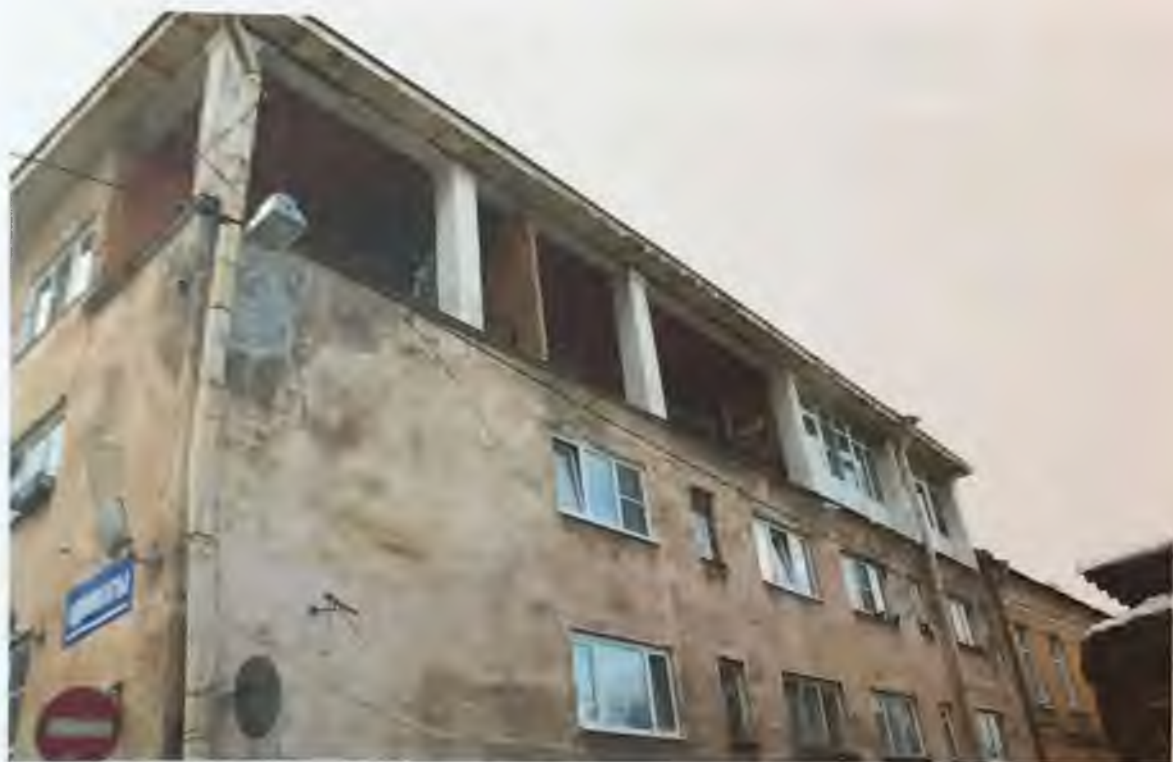
Фото 7. Северный фасад здания. Фрагмент. Автор фото: Маланичева Г.И. 30.11.2016 г.
