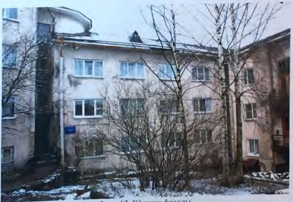
Фото 12. Южные фасады. Автор фото: Маланичева Г.И. 30.11.2016 г.
