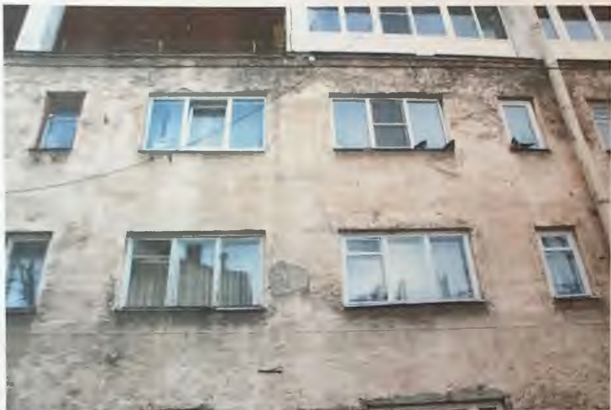
Фото 8.1. Северный фасад здания. Фрагмент. Автор фото: Маланичева Г.И. 30.11.2016 г.
