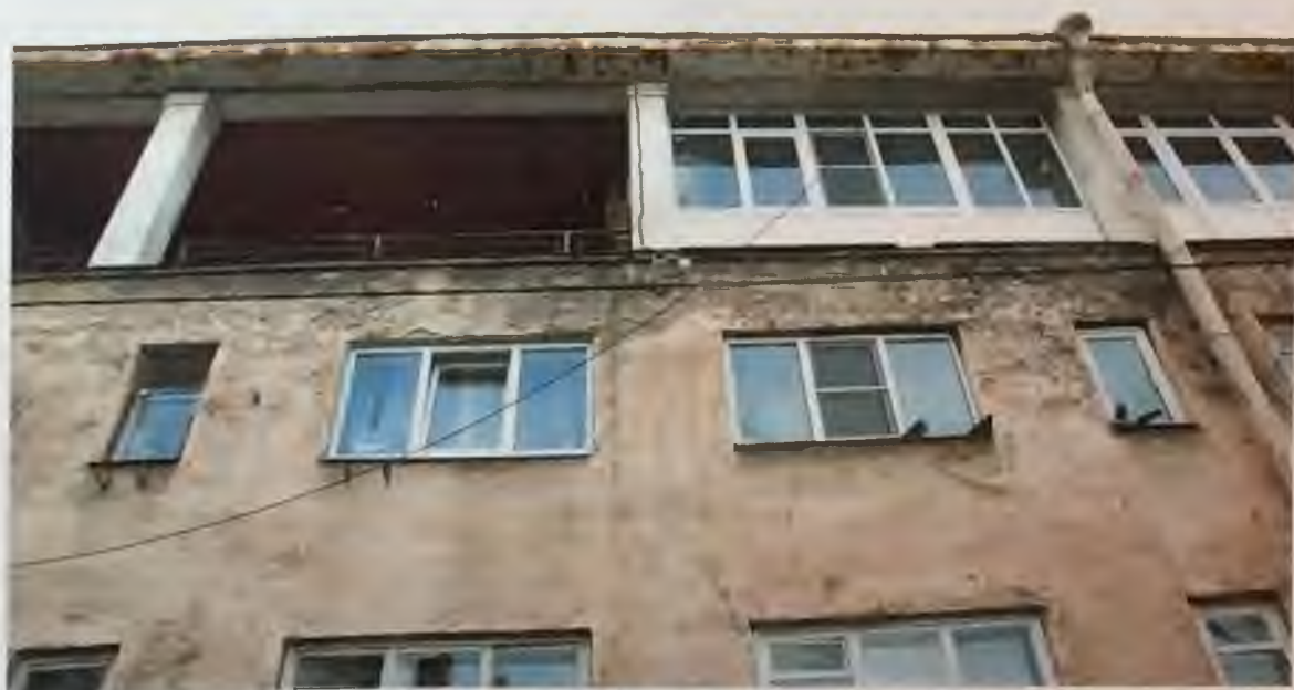
Фото 8. Северный фасад здания. Фрагмент. Автор фото: Маланичева Г.И. 30.11.2016 г.
