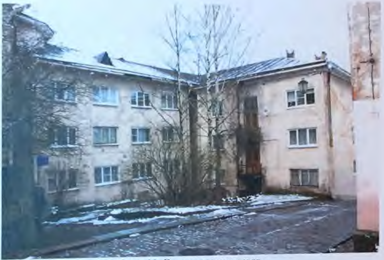
Фото 11. Вид на здание с юга. Автор фото: Маланичева Г.И. 30.11.2016 г.
