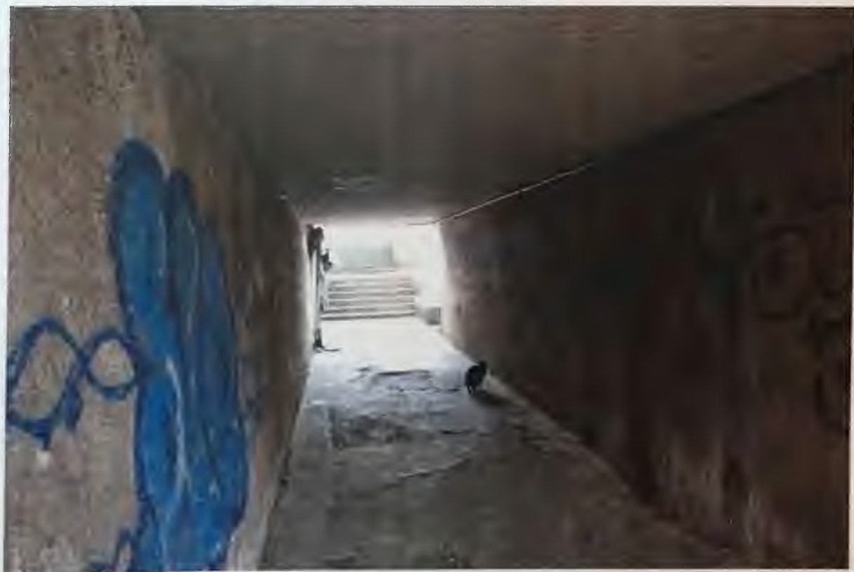
Фото 16. Южный фасад. Проездная арка. Автор фото: Маланичева Г.И. 30.11.2016 г.
