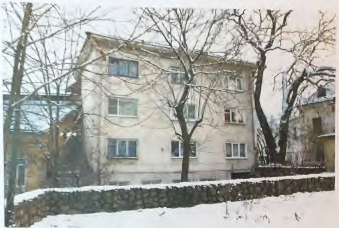
Фото 17. Западный фасад здания. Автор фото: Маланичева Г.И. 30.11.2016 г.
