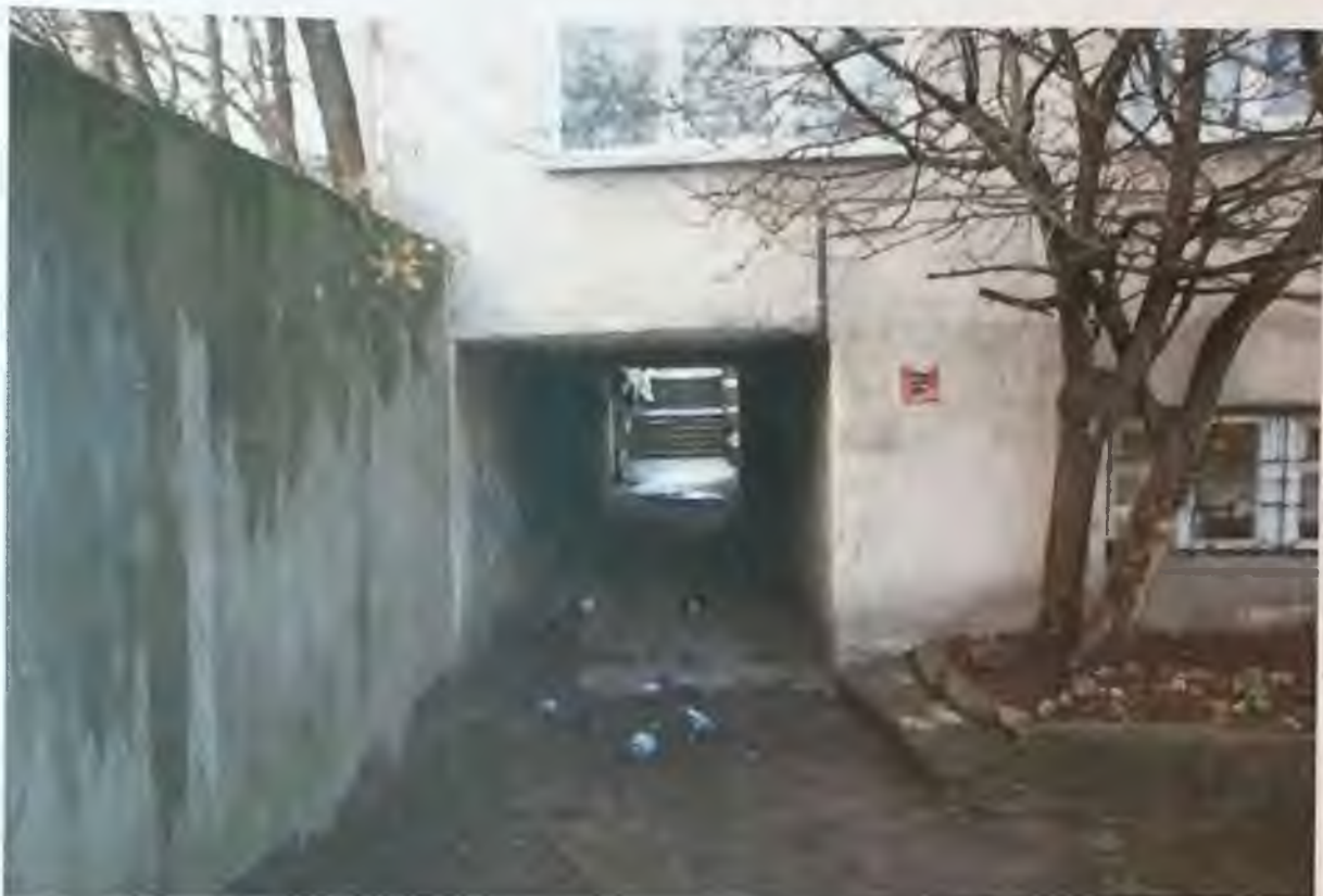
Фото 15. Южный фасад. Проездная арка. Автор фото: Маланичева Г.И. 30.11.2016 г.
