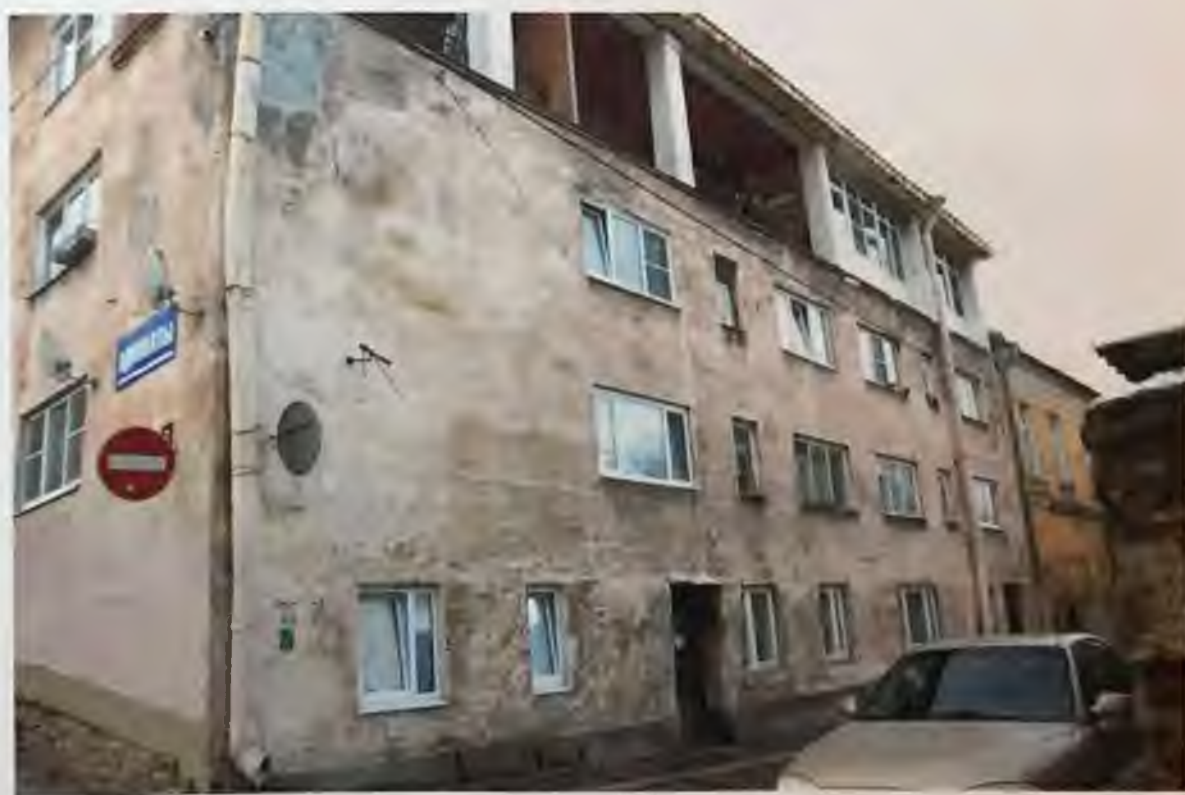
Фото 6. Северный фасад здания. Автор фото: Маланичева Г.И. 30.11.2016 г.
