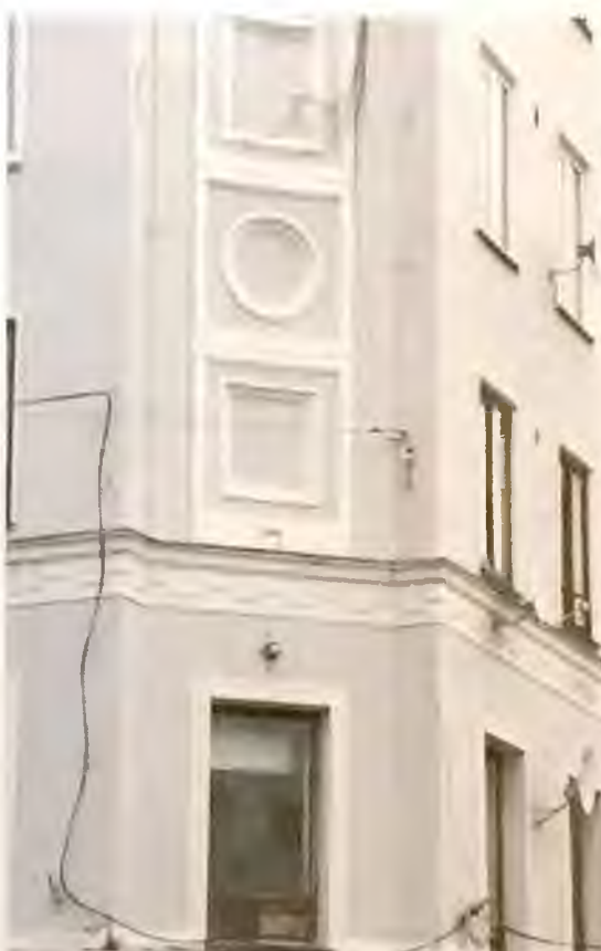
Фото 6.1. Угол здания. Фрагмент.
