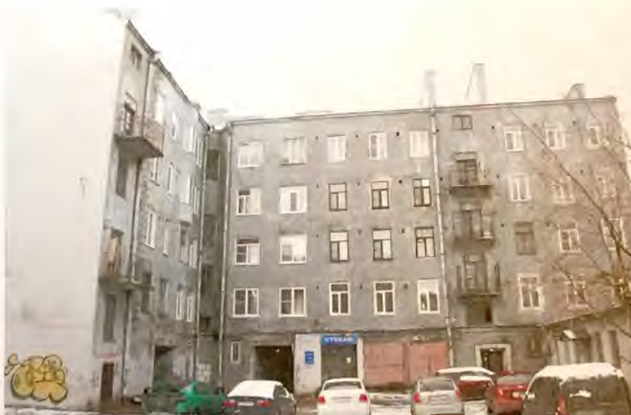
Фото 12. Западный и северный фасады здания. Автор фото: Маланичева Г.И. 30.11.2016 г.
