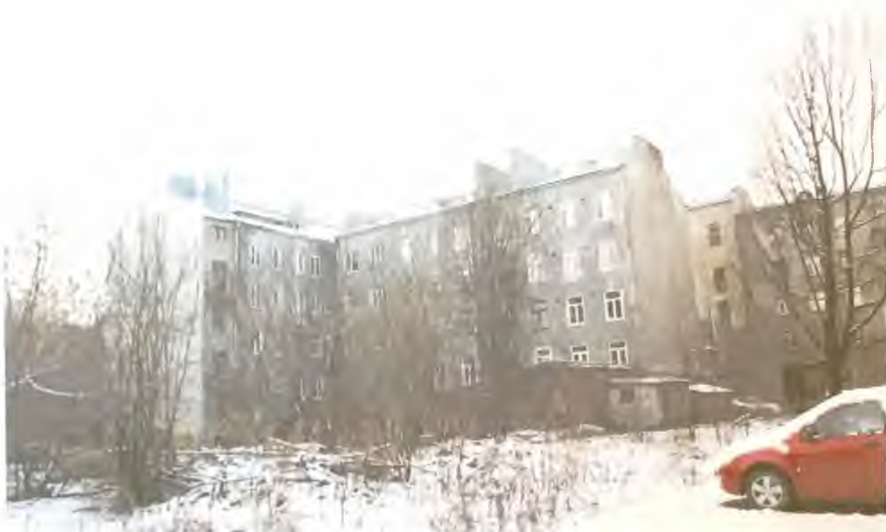
Фото 26. Общий вид здания с северо-востока. Автор фото: Маланичева Г.И. 30.11.2016 г.
