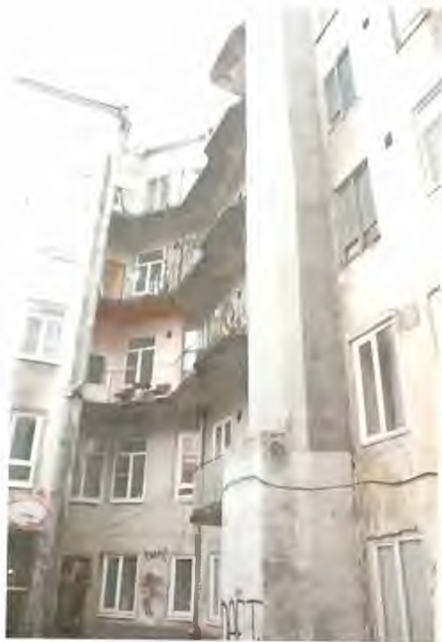
Фото 22. Дворовые фасады здания. Автор фото: Маланичева Г.И. 30.11.2016 г.
