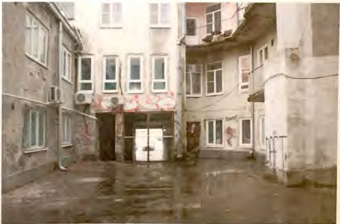
Фото 22. Дворовые фасады здания. Автор фото: Маланичева Г.И. 30.11.2016 г.
