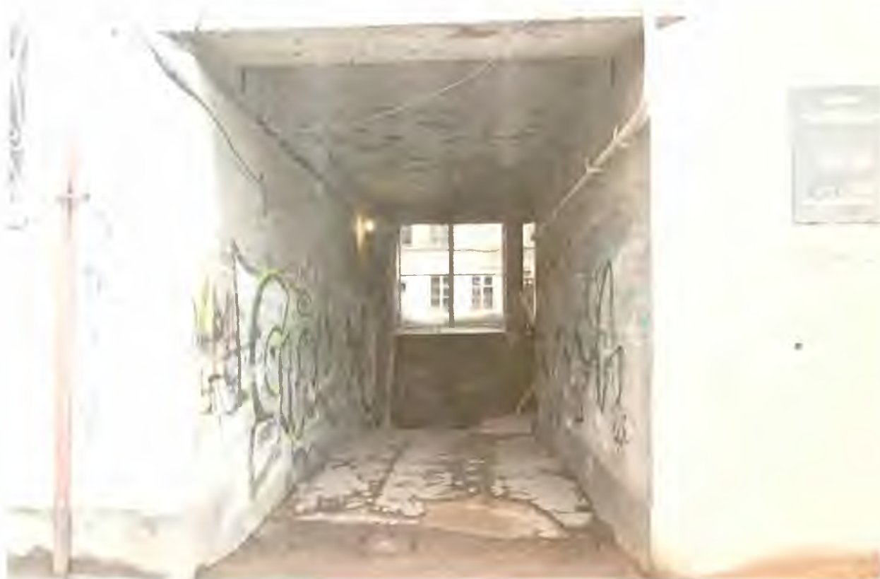
Фото 15. Проездная арка со стороны южного фасада здания. Автор фото: Маланичева Г.И. 30.11.2016 г.
