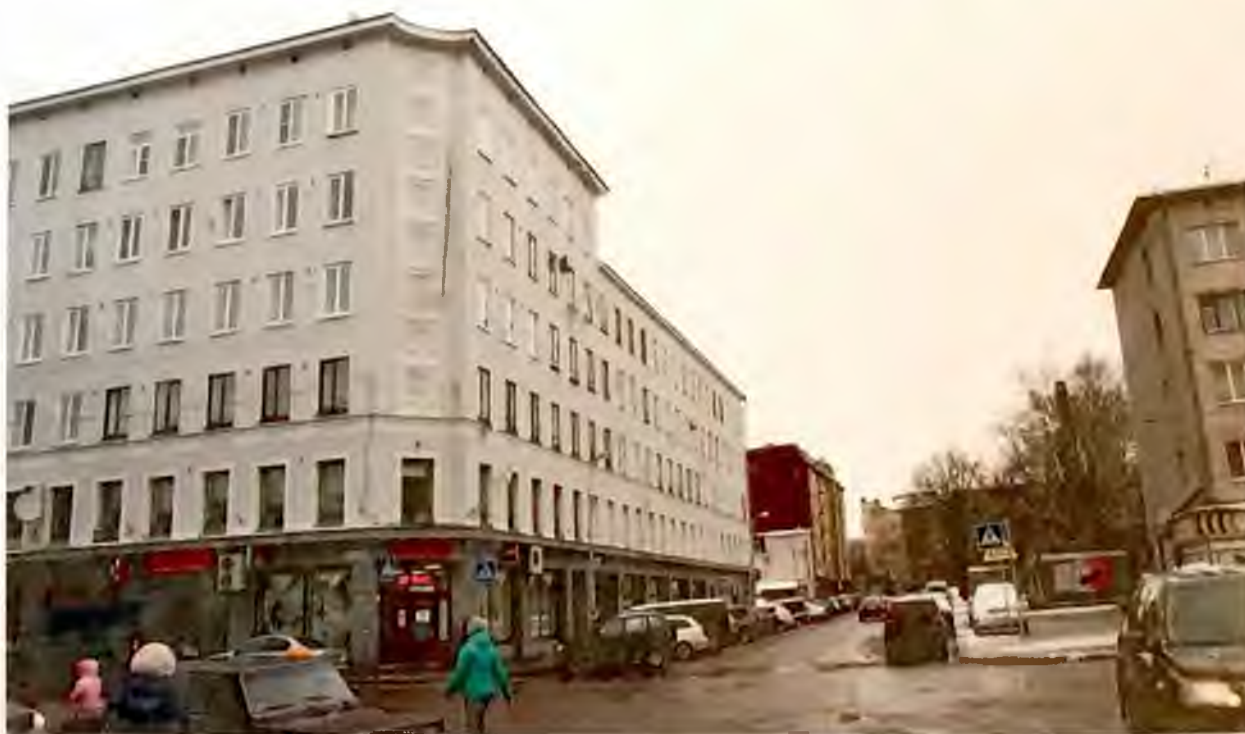
Фото 2. Общий вид здания по улице Пограничная. Автор фото: Маланичева Г.И. 30.11.2016 г.
