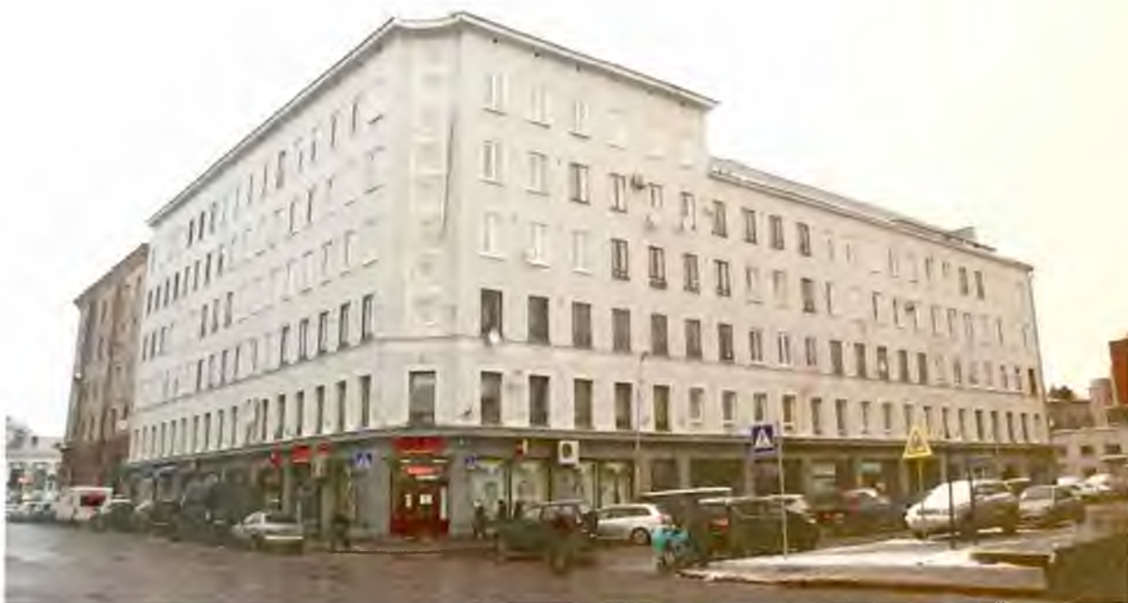
Фото 1. Общий вид здания с угла улиц Вокзальная и Пограничная. Автор фото: Маланичева Г.И. 30.11.2016 г.
