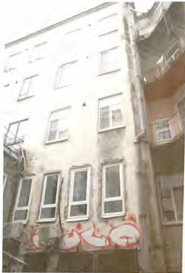
Фото 20. Дворовые фасады здания. Автор фото: Маланичева Г.И. 30.11.2016 г.
