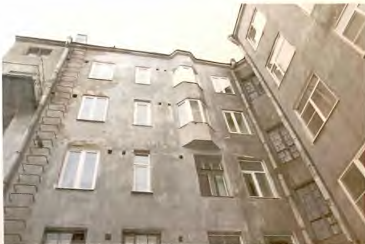
Фото 14. Фрагмент западного фасада здания. Автор фото: Маланичева Г.И. 30.11.2016 г.
