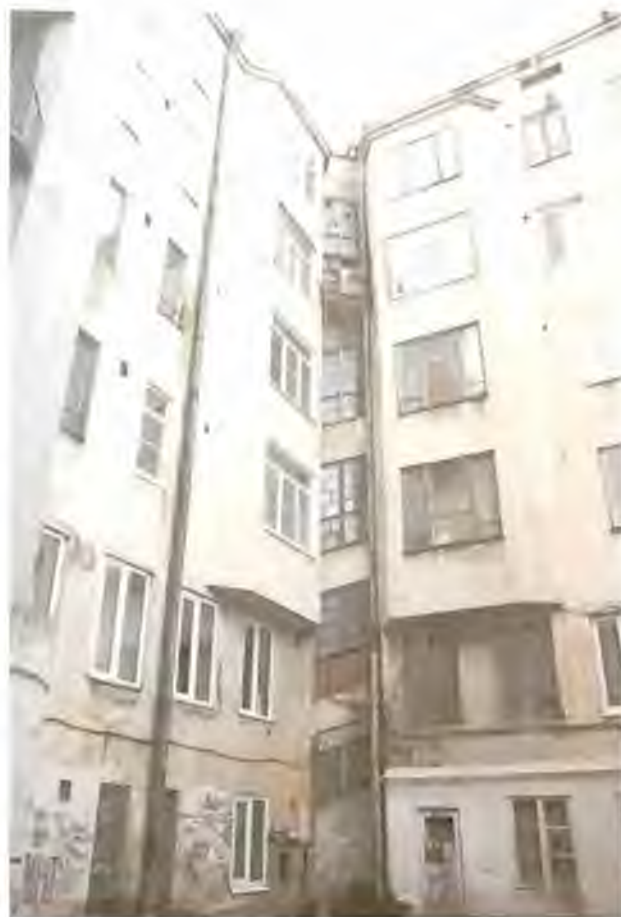
Фото 18. Дворовые фасады здания. Автор фото: Маланичева Г.И. 30.11.2016 г.
