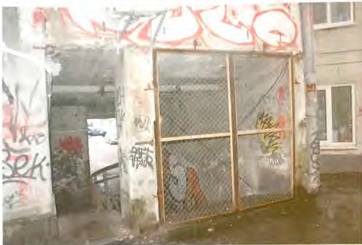
Фото 25. Дворовые фасады здания. Автор фото: Маланичева Г.И. 30.11.2016 г.
