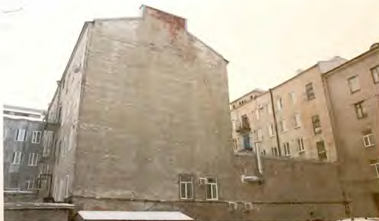
Фото 25. Северный фасад здания. Автор фото: Маланичева Г.И. 30.11.2016 г.
