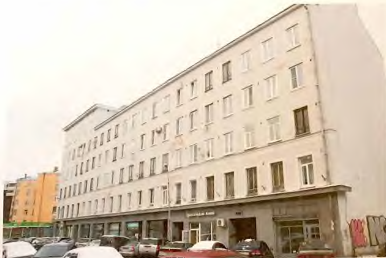
Фото 9. Южный фасад здания по улице Пограничная. Автор фото: Маланичева Г.И. 30.11.2016 г.
