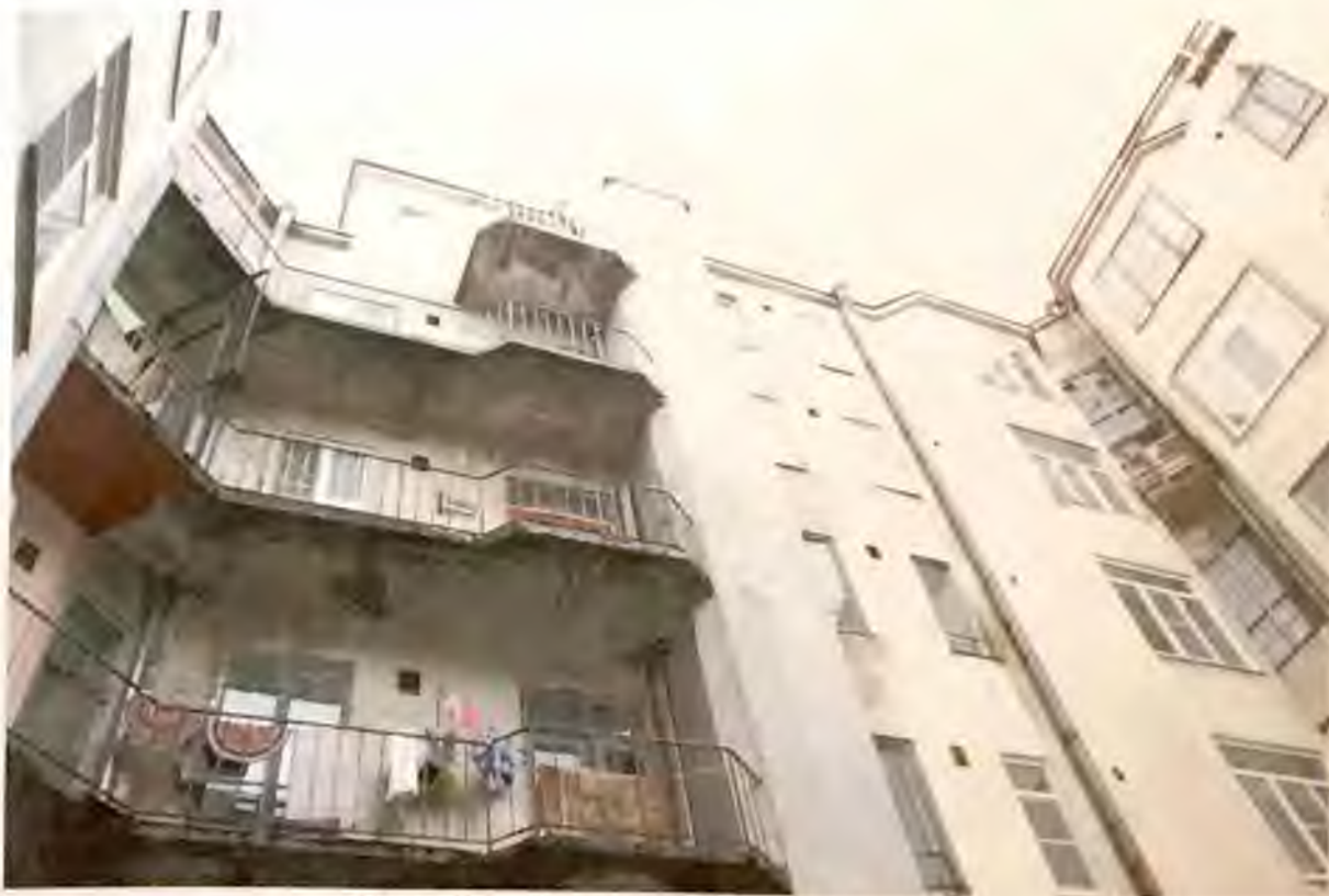
Фото 23. Дворовые фасады здания. Автор фото: Маланичева Г.И. 30.11.2016 г.
