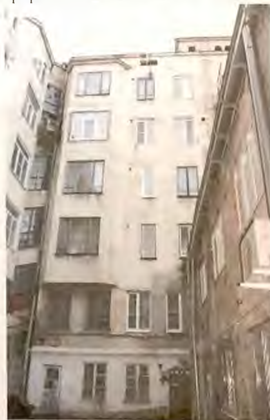
Фото 17. Дворовые фасады здания. Автор фото: Маланичева Г.И. 30.11.2016 г.
