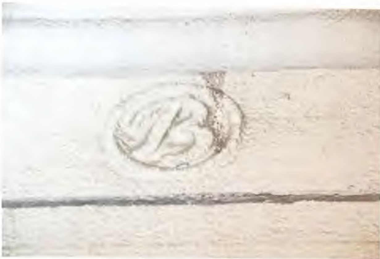
Фото 10.2. Южный фасад здания по улице Пограничная. Вход. Декоративное оформление.
