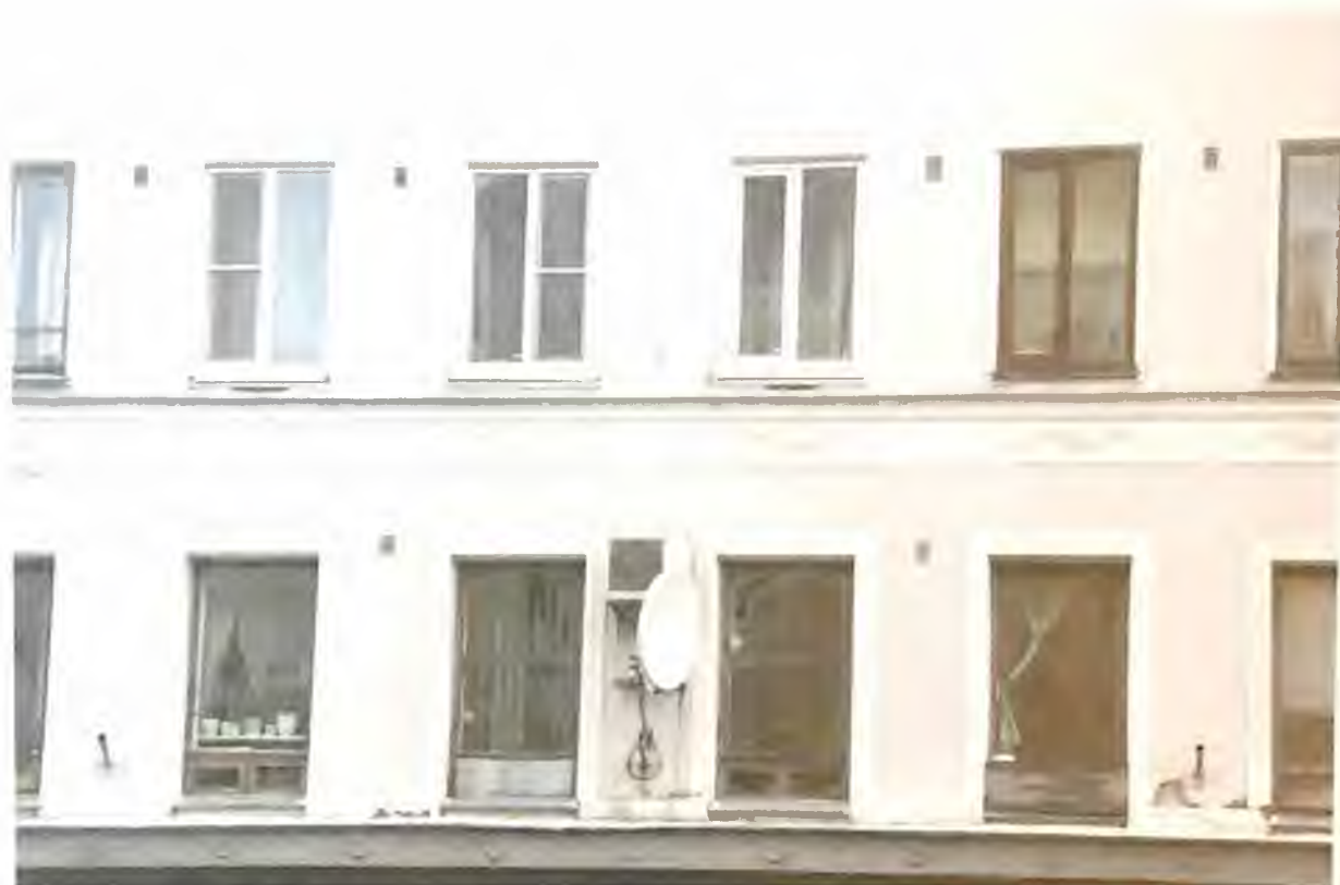
Фото 5.2. Западный фасад здания по улице Вокзальная. Фрагмент. Автор фото: Маланичева Г.И. 30.11.2016 г.
