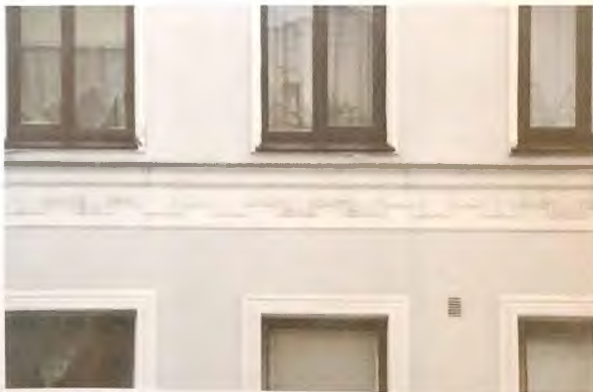
Фото 5.3. Западный фасад здания по улице Вокзальная. Фрагмент. Автор фото: Маланичева Г.И. 30.11.2016 г.
