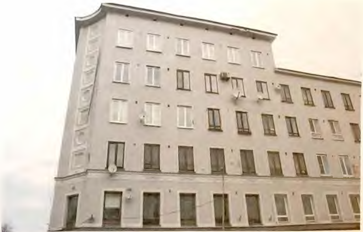
Фото 7. Южный фасад здания по улице Пограничная. Фрагмент. Автор фото: Маланичева Г.И. 30.11.2016 г.
