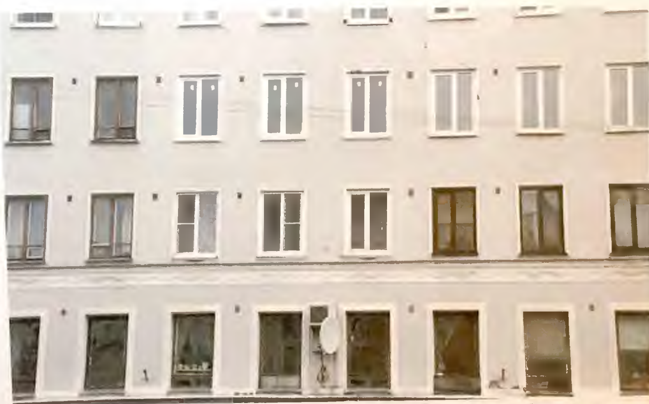
Фото 5.1. Западный фасад здания по улице Вокзальная. Фрагмент. Автор фото: Маланичева Г.И. 30.11.2016 г.
