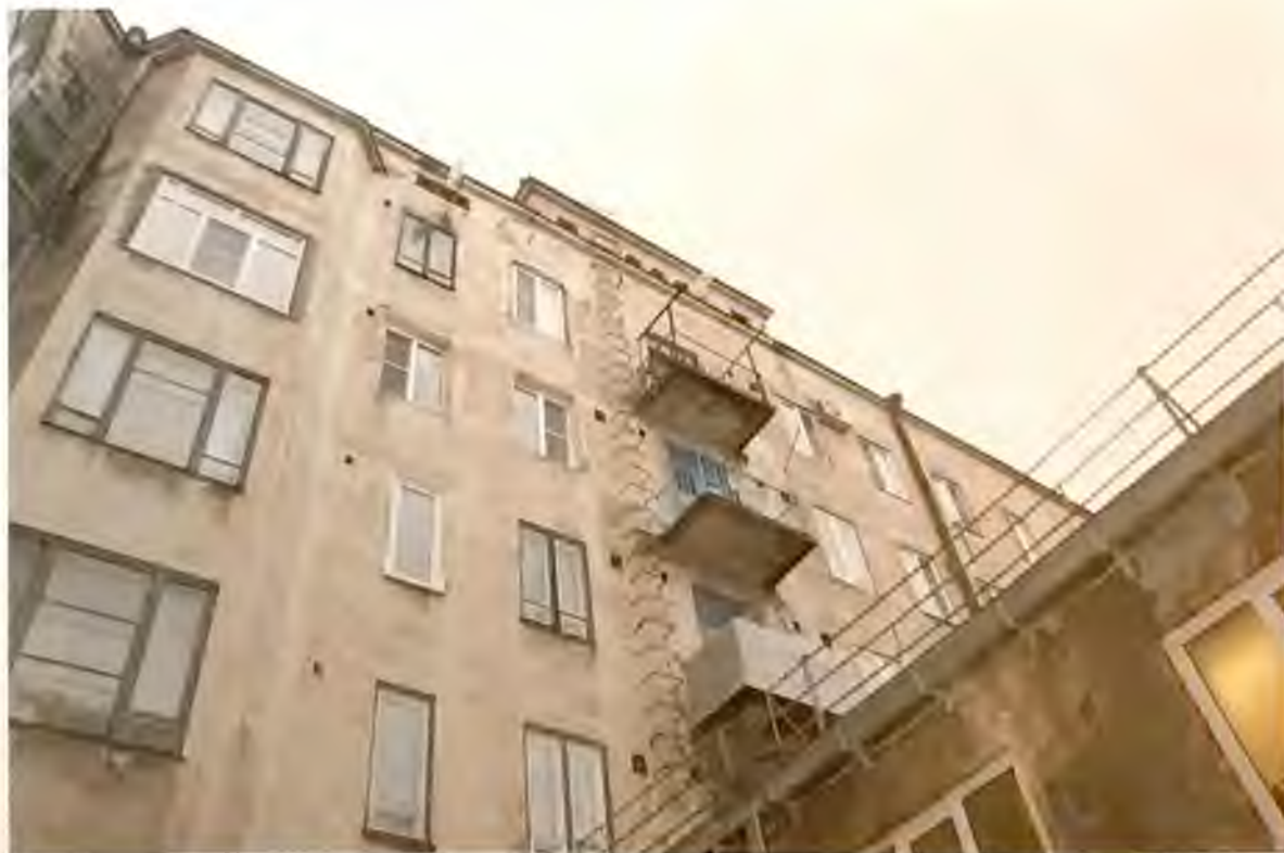
Фото 19. Дворовые фасады здания. Автор фото: Маланичева Г.И. 30.11.2016 г.
